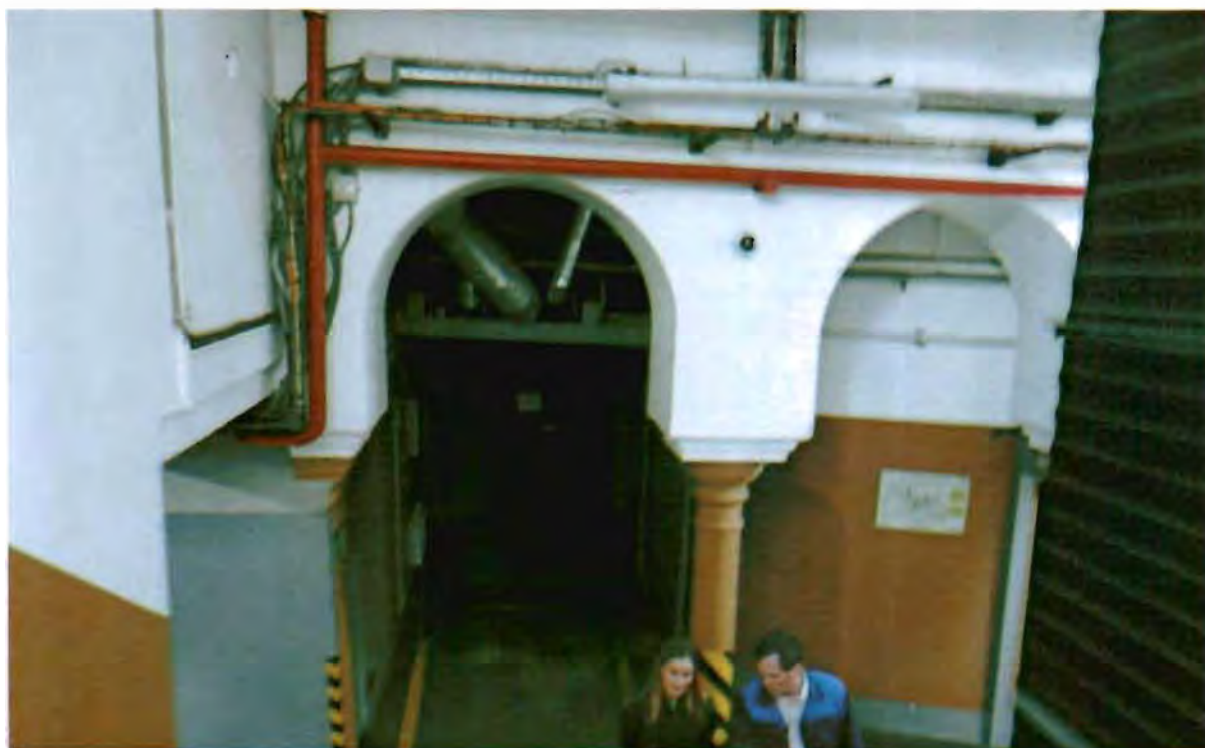
10. Арочное перекрытие центральной части вестибюля (корпус № 2).
