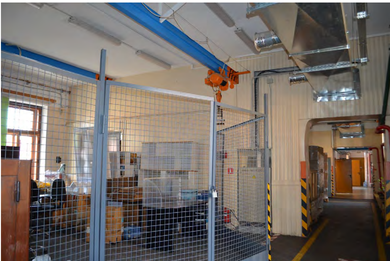
Фото 12. ОКН федерального значения «Монетный двор». Помещение № 220. Общий вид. Съёмка 24.04.2023 г.
