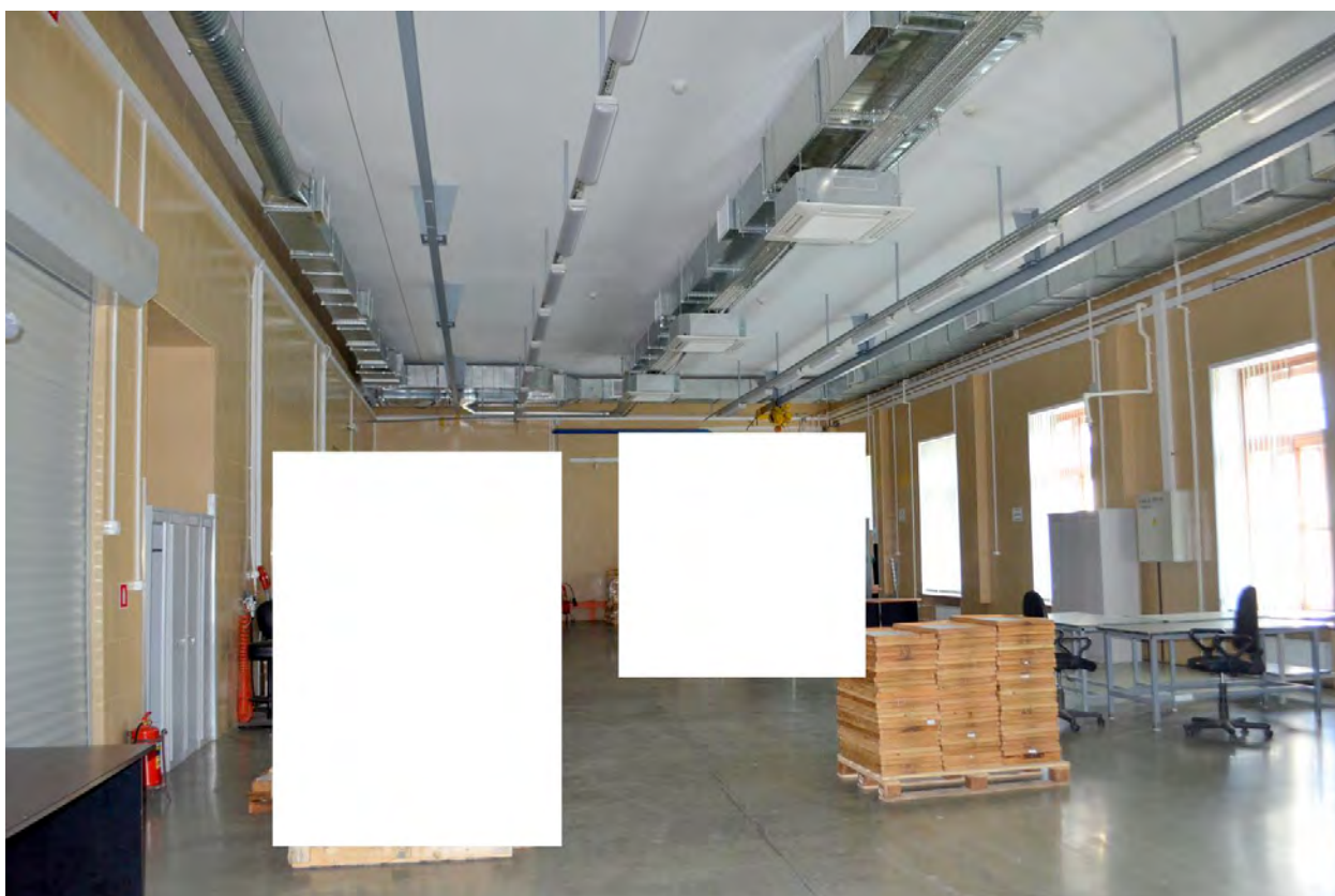
Фото 07. ОКН федерального значения «Монетный двор». Помещение № 218. Общий вид. Съёмка 24.04.2023 г.
