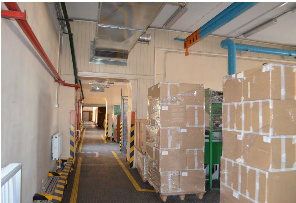
Фото 15. ОКН федерального значения «Монетный двор». Помещение № 221. Общий вид. Съёмка 24.04.2023 г.
