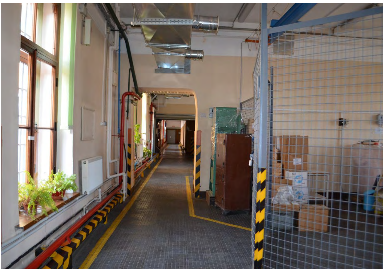
Фото 13. ОКН федерального значения «Монетный двор». Помещение № 220. Общий вид. Съёмка 24.04.2023 г.
