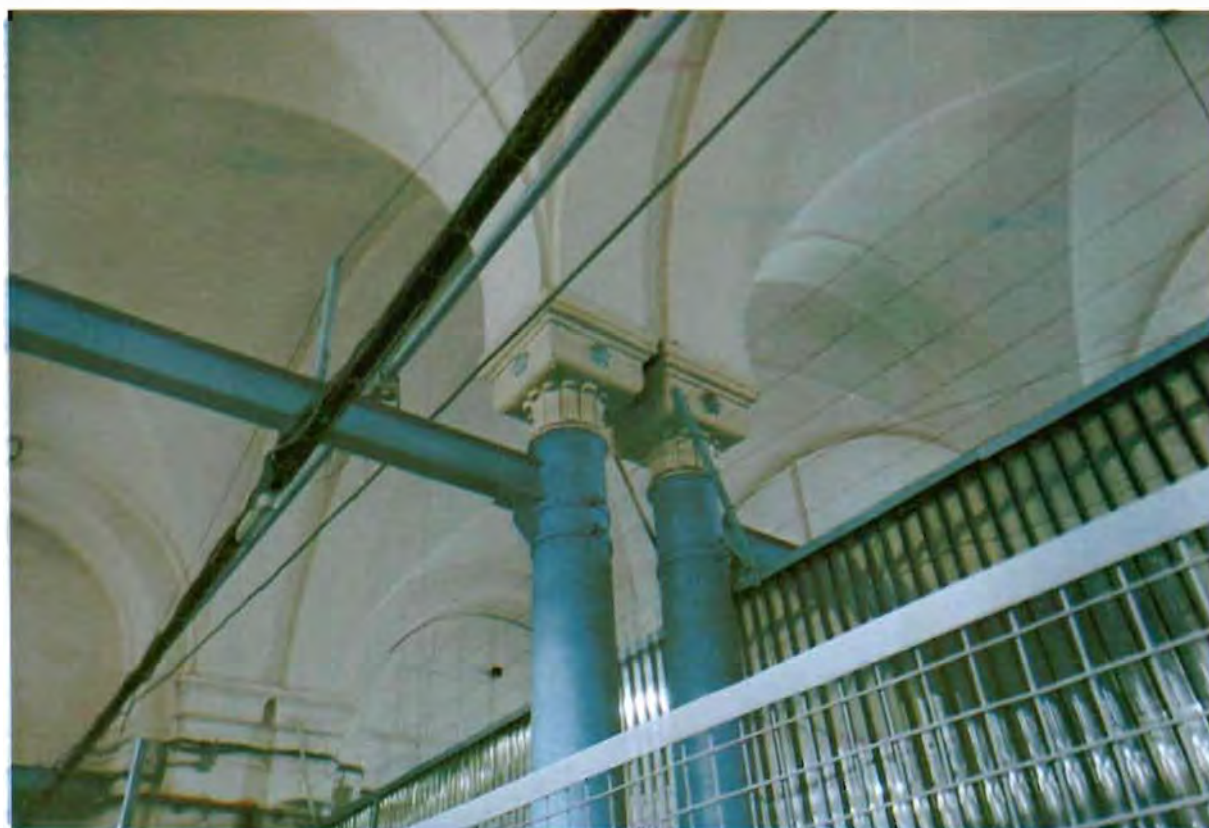
12. Чугунные опорные колонны (корпус № 3).
