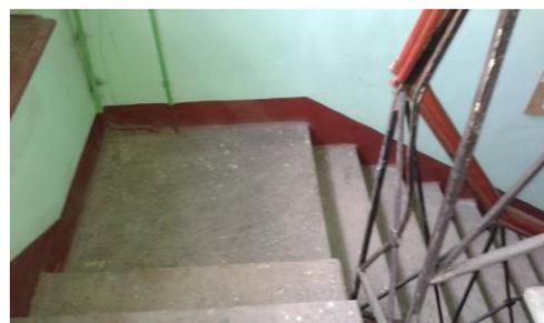
ограждение маршей Л-2-Л-4 – материал (черный металл), техника исполнения (ковка), рисунок (геометрический с мотивом завитков); поручни – материал (дерево), конфигурация (профилированные);
