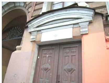
дверные заполнения проемов парадных входов по наб. Макарова (Л-3 и входа в квартиру № 48) – двустворчатые, с глухими филленчатыми створками (филенки разноформатные, сложного рисунка с накладными деталями в виде бриллиантового руста и розеток);
