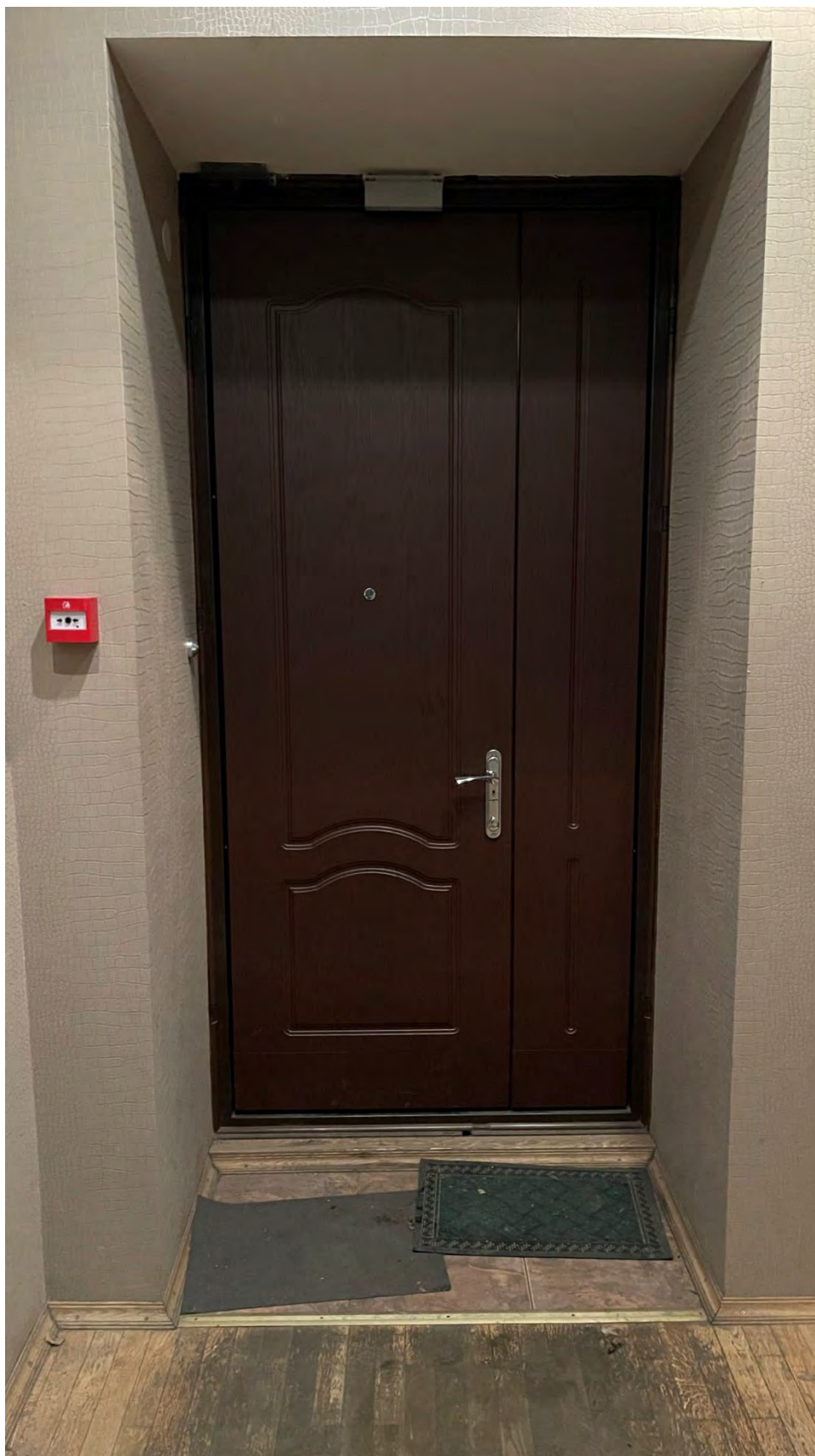
5. Вид на входную дверь в квартире;
