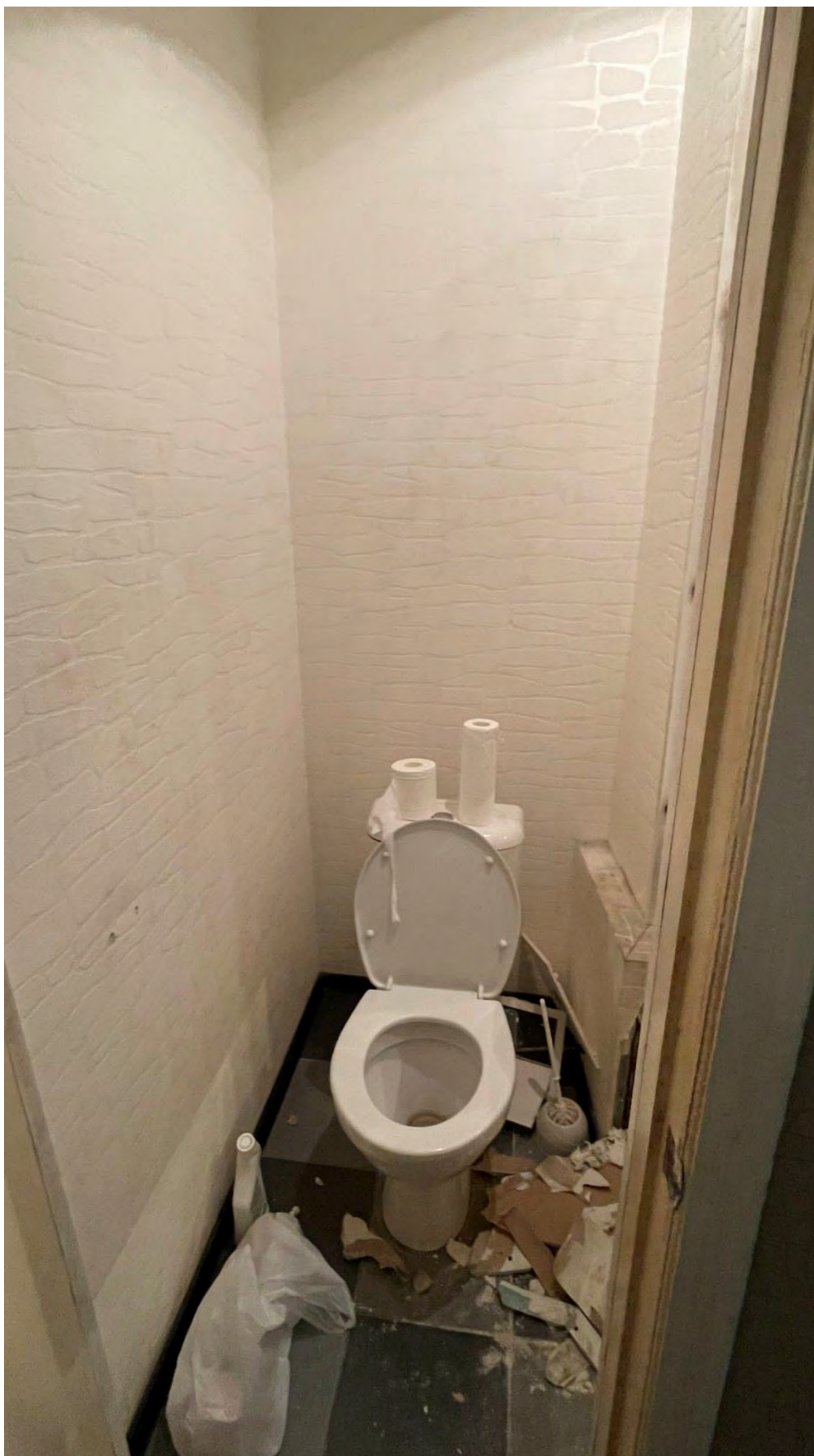
18. Вид на санузел (помещение 10);
