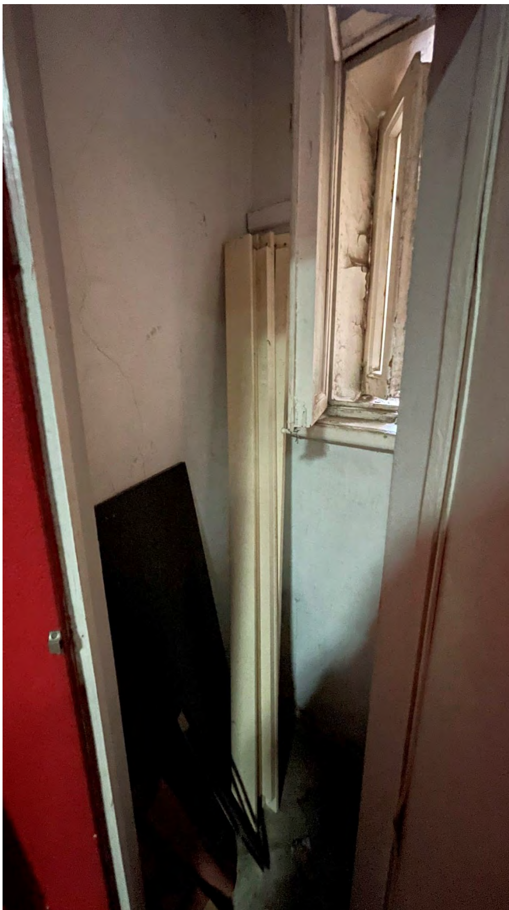
14. Вид на шкаф (помещение 5);
