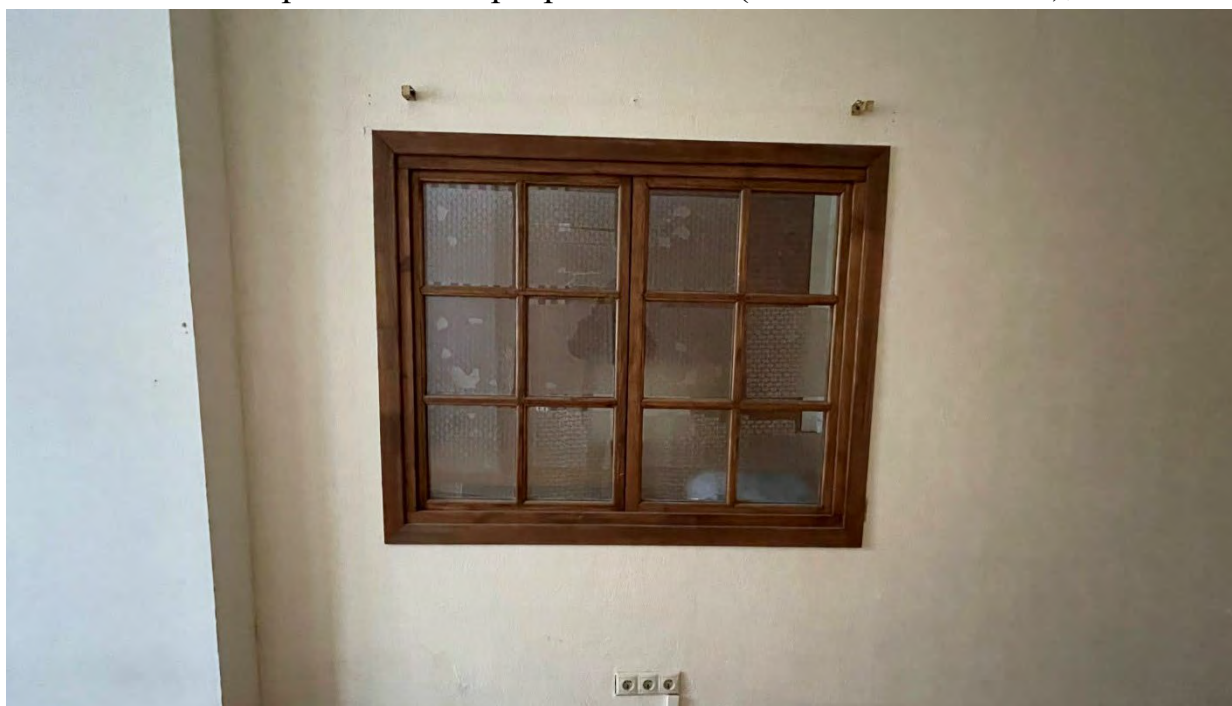
28.Фрагмент интерьера комнаты (помещение 14/19.8);
