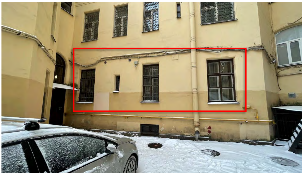
3. Вид на дворовой фасад здания и окна помещения;
