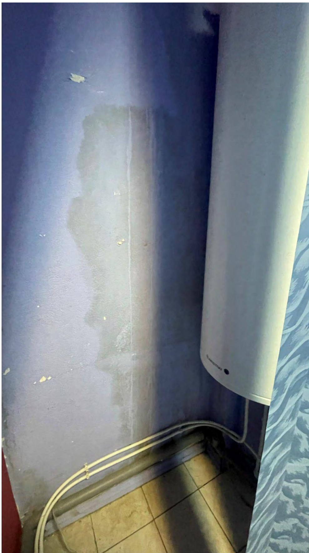
21.Фрагмент интерьера. Помещение 7/7.2;
