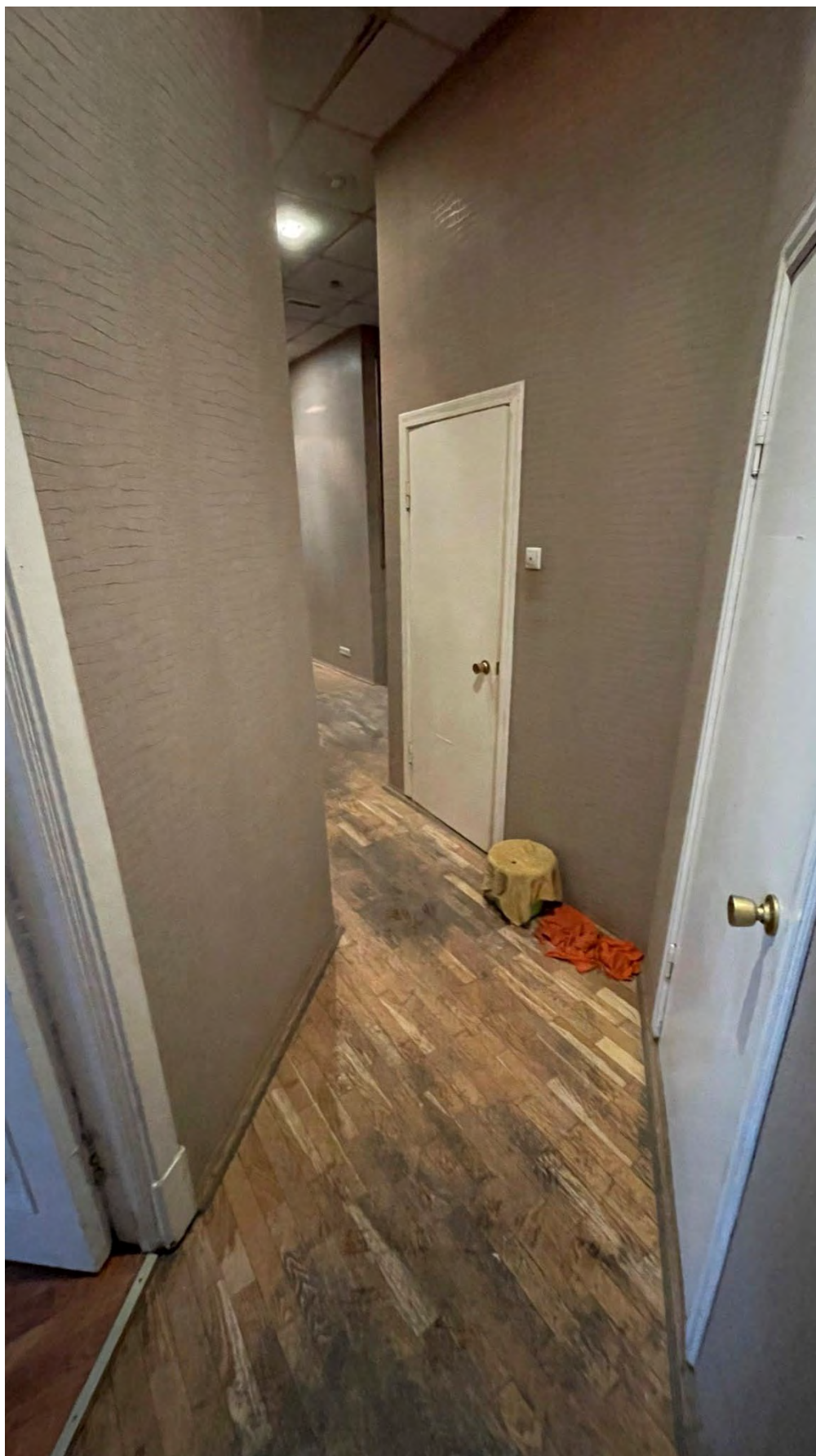
22. Фрагмент интерьера коридора (помещение 12);
