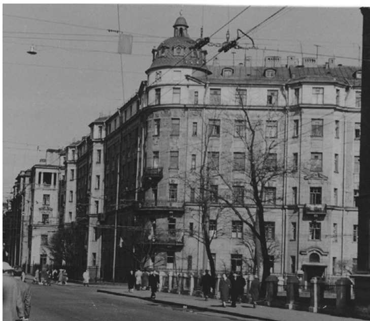
Илл. 18. Общий вид угловой части здания на пересечении Большой Пушкарской и Кронверкской улиц. 1962 г. Фрагмент. Интернет-ресурс https://pastvu.com/p/1330831 .
