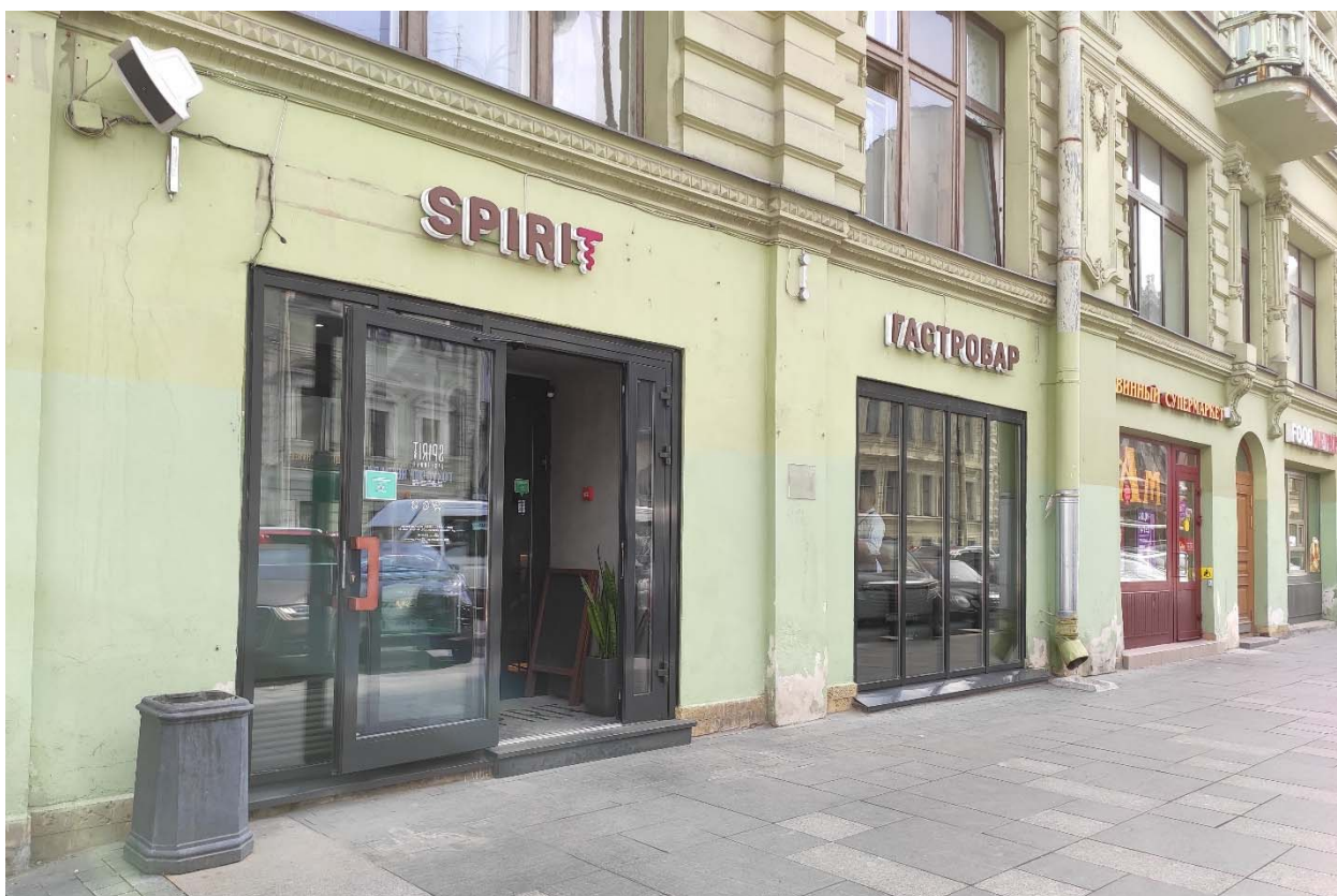
Фото 2. Оконные проемы помещения 1-Н.
