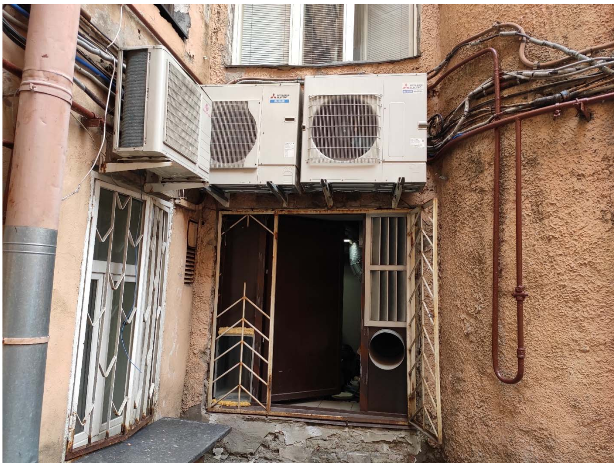
Фото 4. Оконный проем со стороны дворового фасада.
