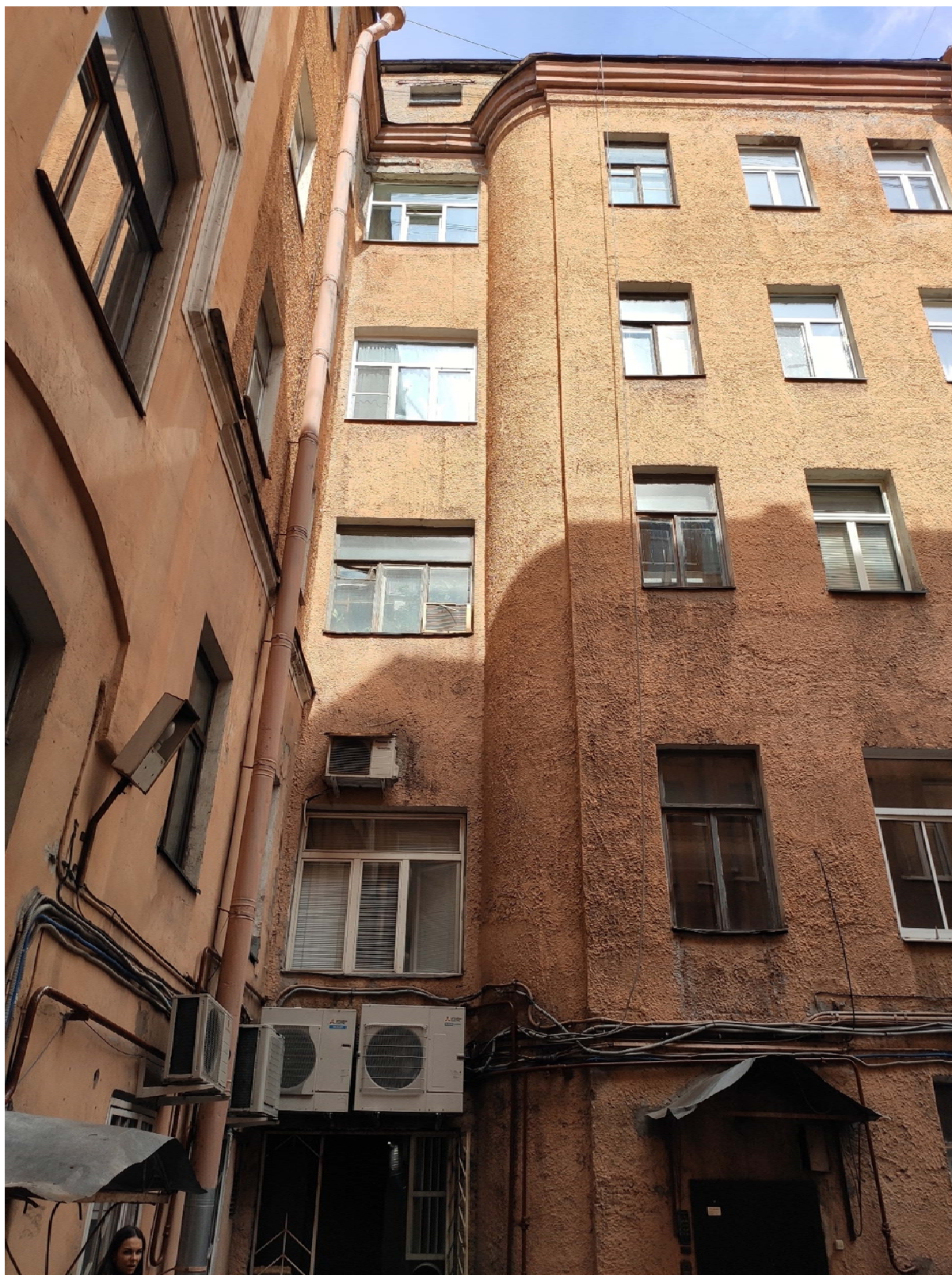
Фото 3. Фрагмент дворового фасада здания.
