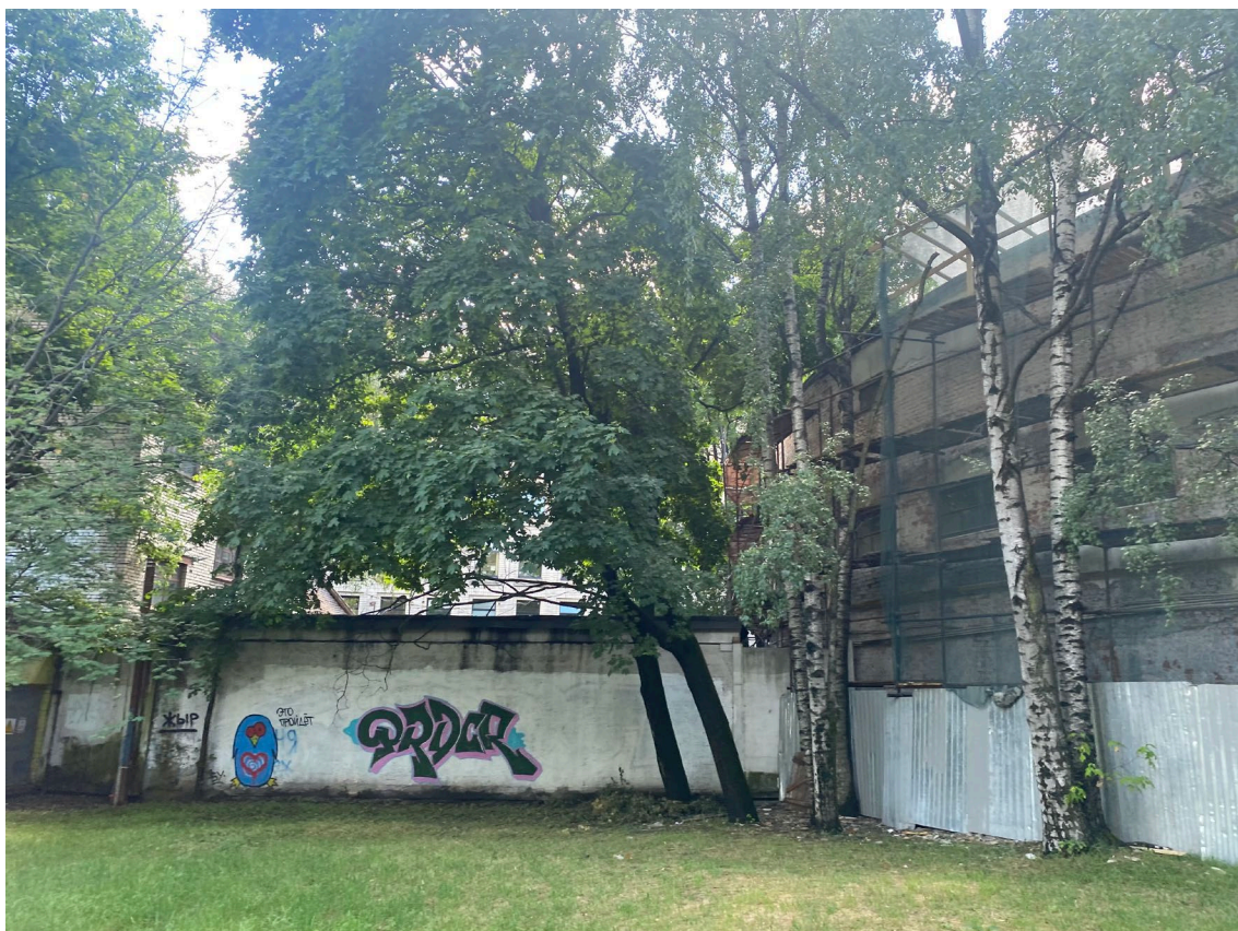
5. Вид с северной стороны на с объект культурного наследия «Круглая баня»
