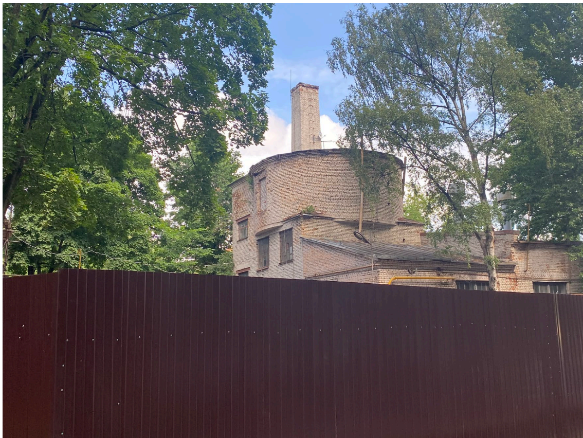
1. Вид на вторую котельную рядом с объектом культурного наследия «Круглая баня».
