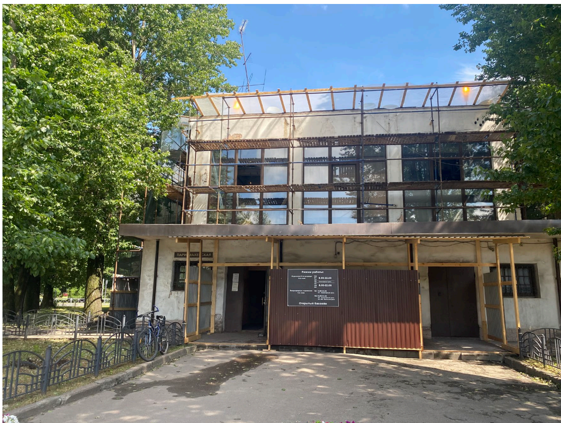
3. Вид с западной стороны на с объект культурного наследия «Круглая баня»
