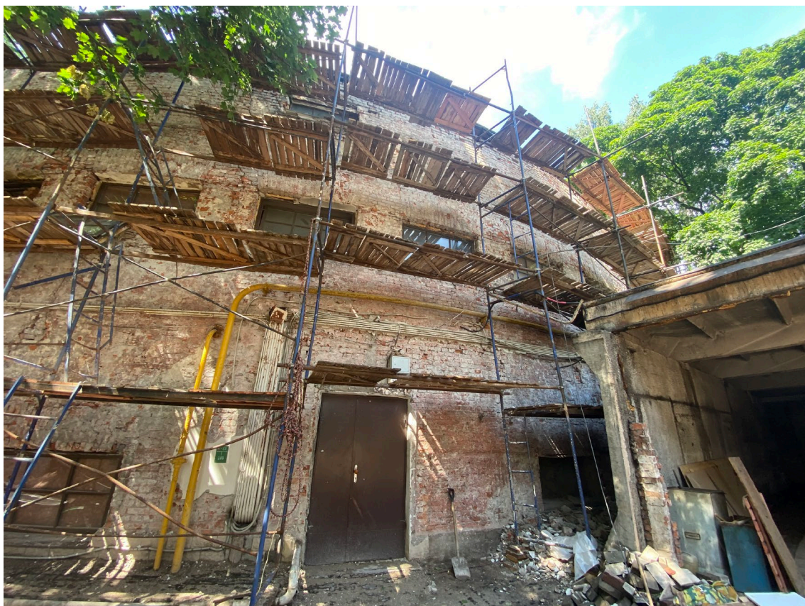
9. Вид с восточной стороны на с объект культурного наследия «Круглая баня»
