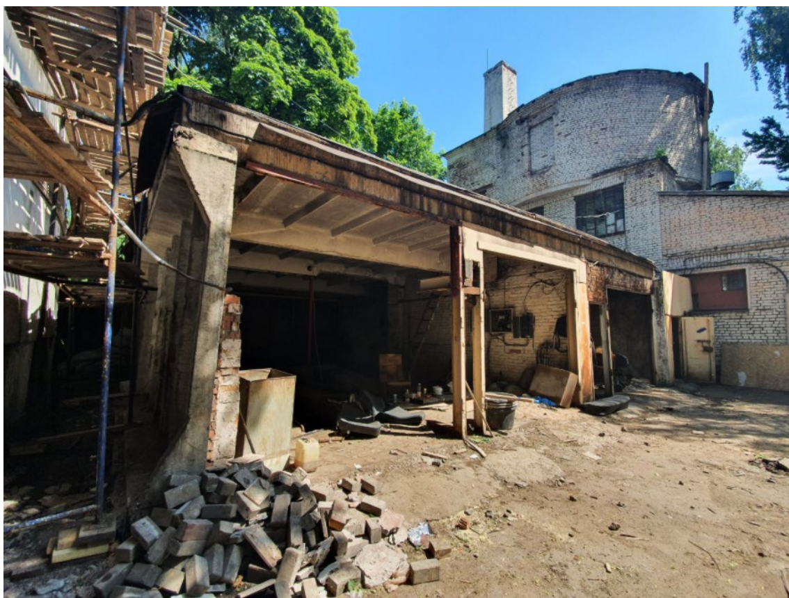
10. Вид на котельную
