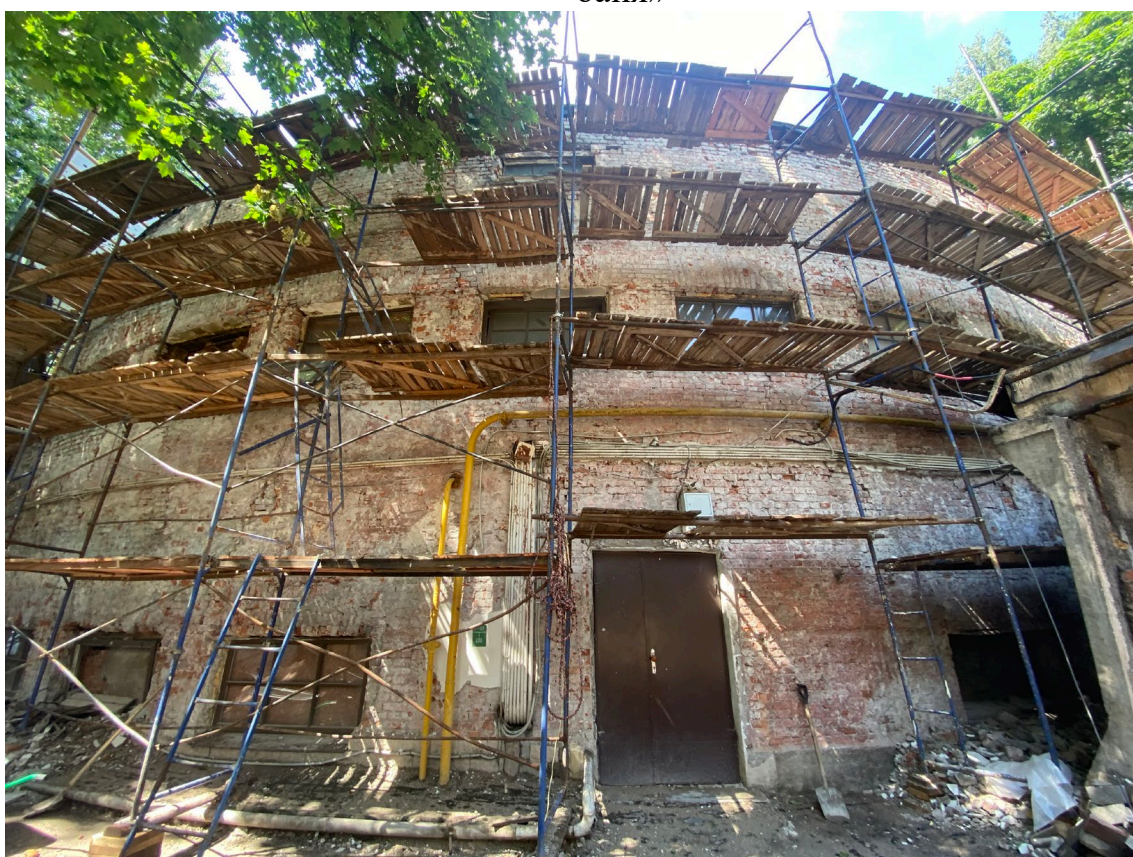
6. Вид с восточной стороны на с объект культурного наследия «Круглая баня»
