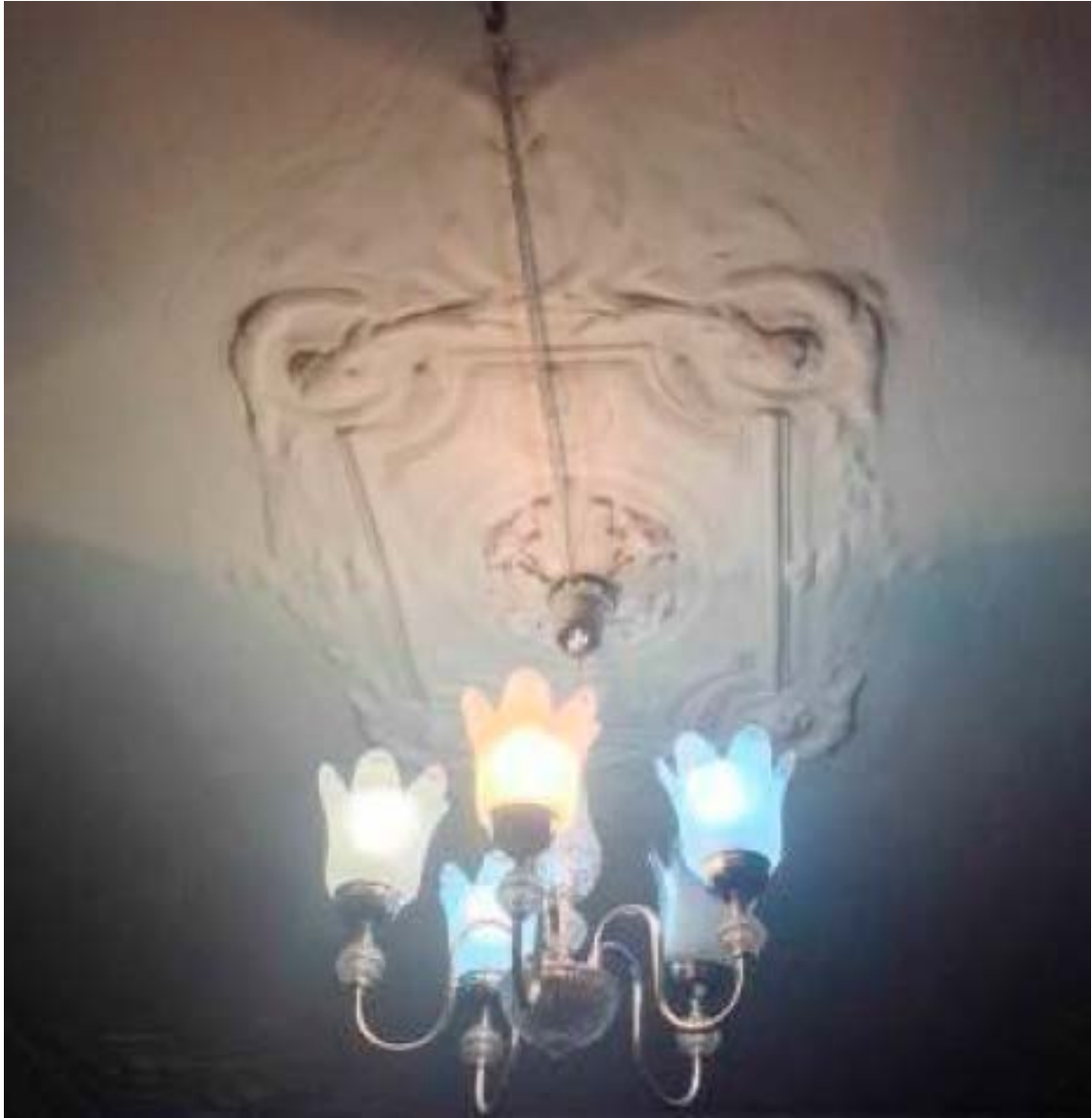
10. Потолочная розетка помещения №2 кв. №2 в уровне 2-го этажа объекта культурного наследия регионального значения «Дом Т.П. Павловой», расположенного по адресу: г. Санкт-Петербург, Конная ул., д. 8, литера А. 05.03.2021.
