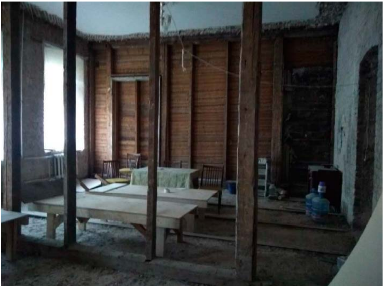
7. Помещения №6 и №9 кв. №50 объекта культурного наследия регионального значения «Жилой дом», расположенного по адресу: г. Санкт-Петербург, Шпалерная ул., д. 34, литера Б. 15.11.2020.
