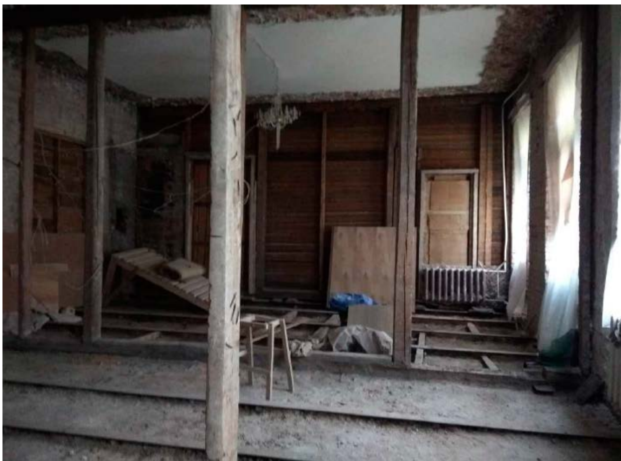
4. Помещения №№1-8 кв. №50 объекта культурного наследия регионального значения «Жилой дом», расположенного по адресу: г. Санкт-Петербург, Шпалерная ул., д. 34, литера Б. 15.11.2020.
