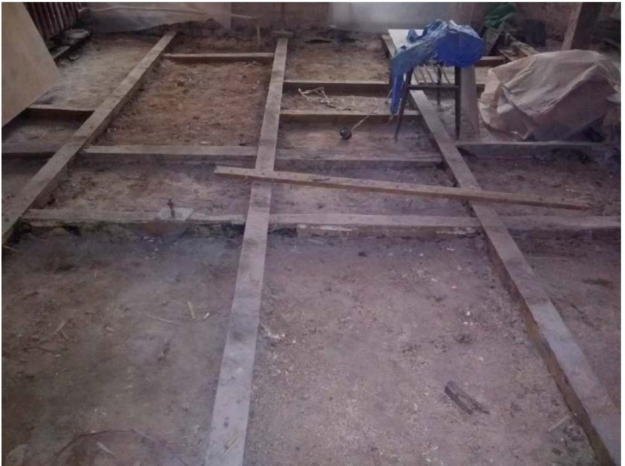
б. Помещения №№1-8 кв. №50 объекта культурного наследия регионального значения «Жилой дом», расположенного по адресу: г. Санкт-Петербург, Шпалерная ул., д. 34, литера Б. 15.11.2020.
