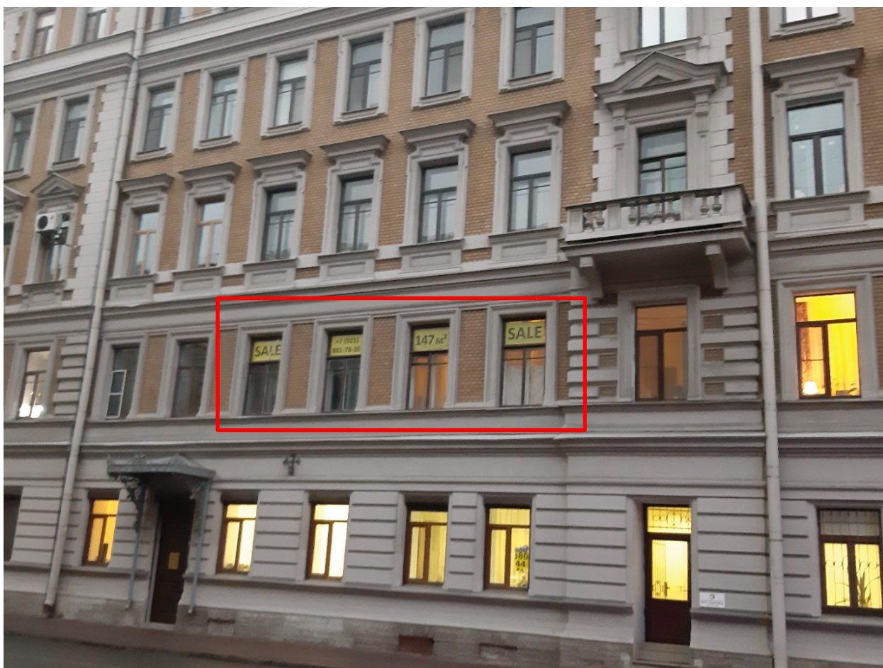
1. Оконные заполнения кв. №50 в уровне 2-го этажа лицевого фасада объекта культурного наследия регионального значения «Жилой дом», расположенного по адресу: г. Санкт-Петербург, Шпалерная ул., д. 34, литера Б, входящего в состав объекта культурного наследия регионального значения «Жилой дом и архив Министерства Императорского двора». 15.11.2020.
