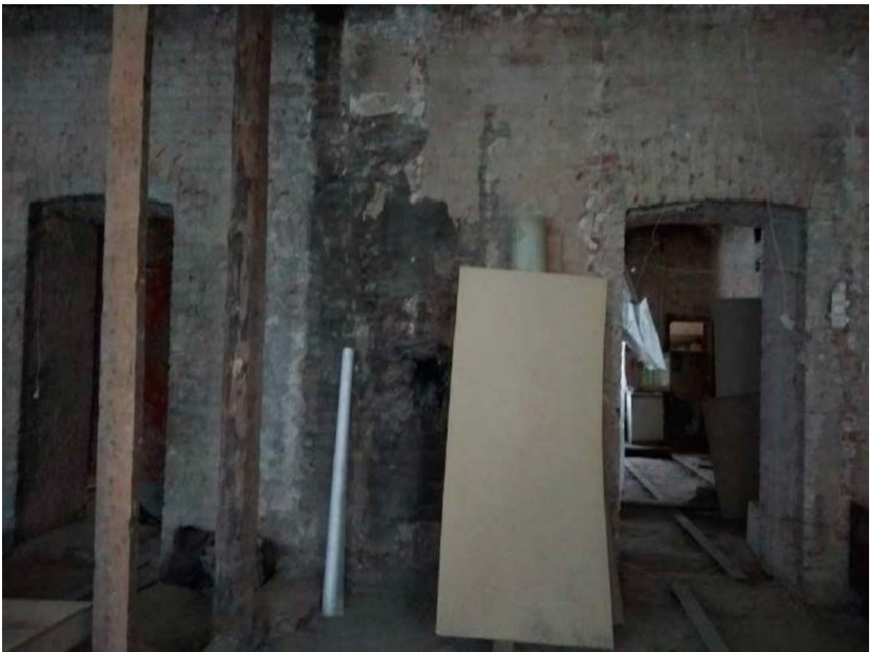
8. Помещения №6 и №9 кв. №50 объекта культурного наследия регионального значения «Жилой дом», расположенного по адресу: г. Санкт-Петербург, Шпалерная ул., д. 34, литера Б. 15.11.2020.
