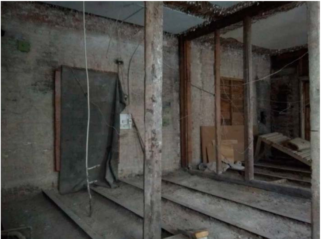
5. Помещения №№1-8 кв. №50 объекта культурного наследия регионального значения «Жилой дом», расположенного по адресу: г. Санкт-Петербург, Шпалерная ул., д. 34, литера Б. 15.11.2020.
