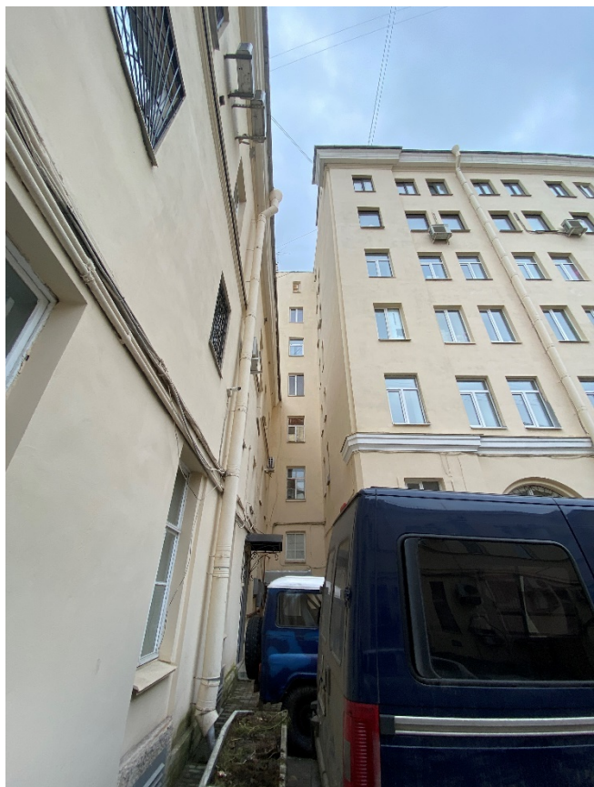
Фото 7. Фрагмент дворовых фасадов. Вид с востока.
