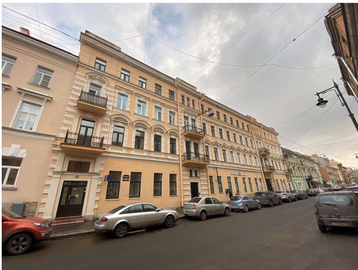
Фото 9. Общий вид фасада лицевого корпуса по Гагаринской улице. Вид с северо-запада.
