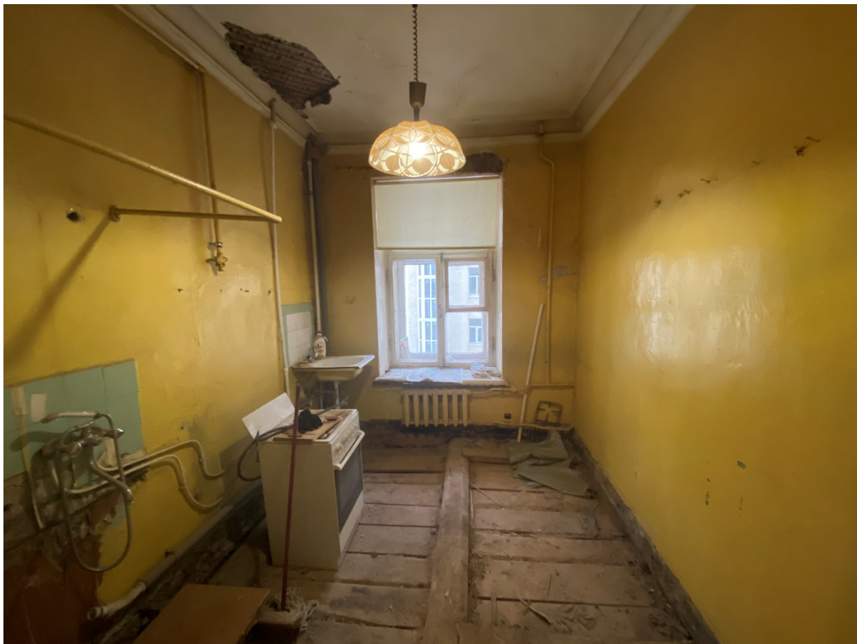
Фото 21. Общий вид помещения № 2. Кухня. Вид с юга.
