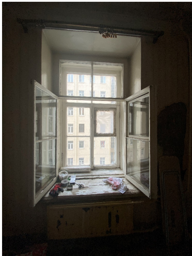
Фото 30. Существующее оконное заполнение в помещении № 5. Вид с юга.
