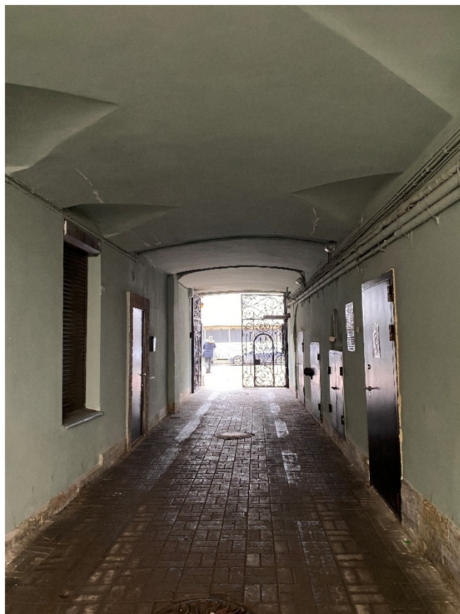
Фото 8. Арка воротного проезда лицевого корпуса по Моховой улице. Вид на арку со стороны дворового пространства.
