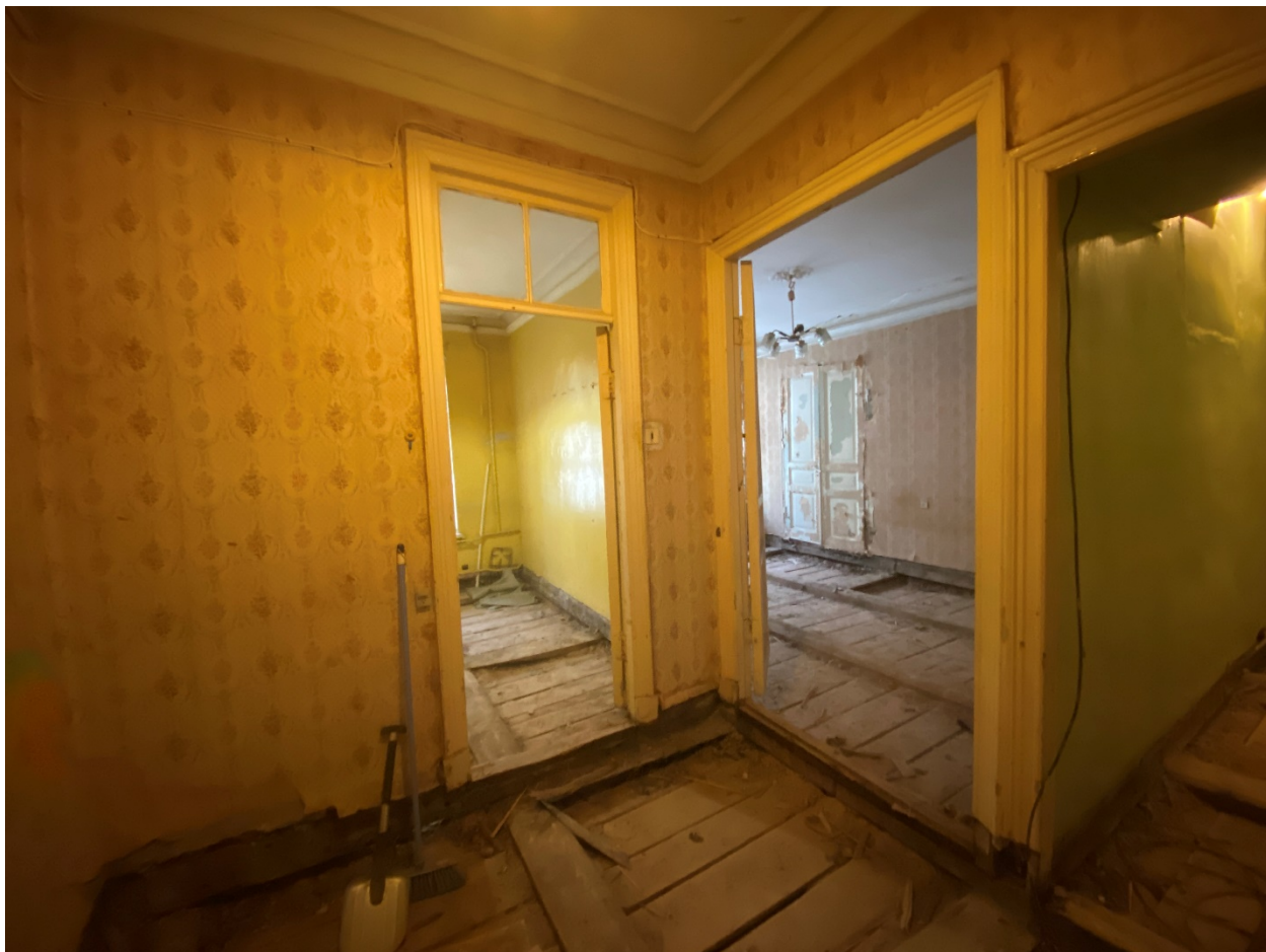
Фото 19. Общий вид помещения № 1. Коридор. Вид с юго-запада.
