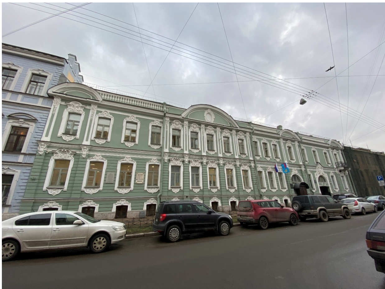
Фото 1. Общий вид лицевого фасада объекта культурного наследия федерального значения «Дом, где в 1857-1891 гг. жил писатель Гончаров И.А.», расположенного по адресу: Санкт-Петербург, Гагаринская улица, дом 14, литера А. Вид по Моховой улице с юго-востока.
