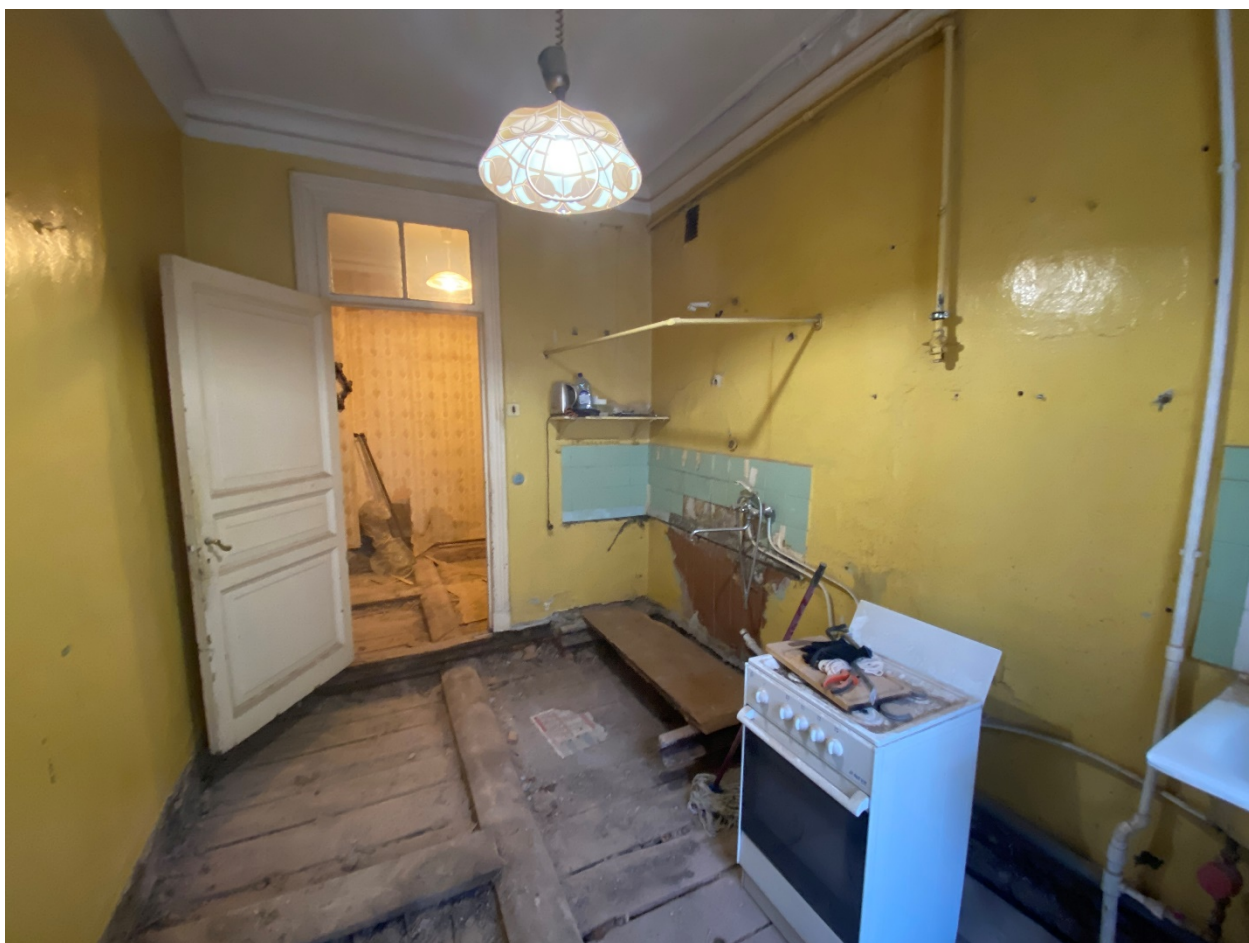
Фото 22. Общий вид помещения № 2. Кухня. Вид с севера.
