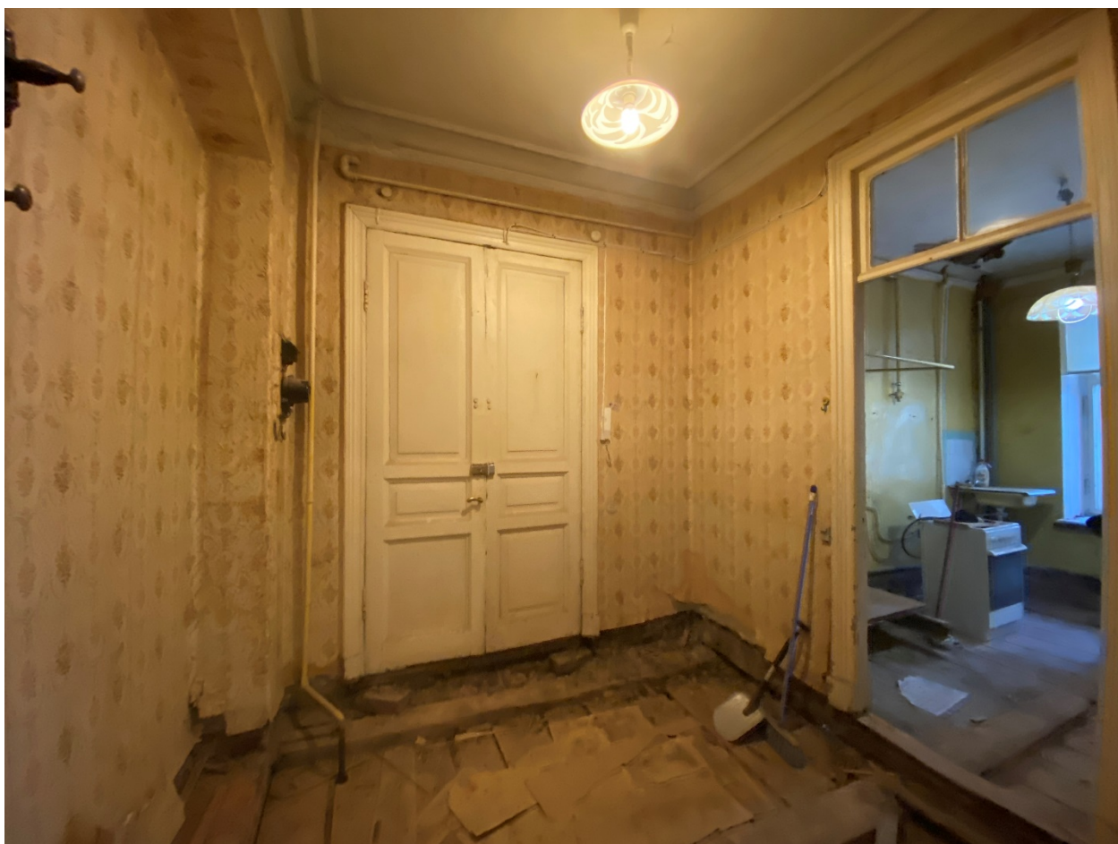
Фото 20. Общий вид помещения № 1. Коридор. Вид с юго-востока.
