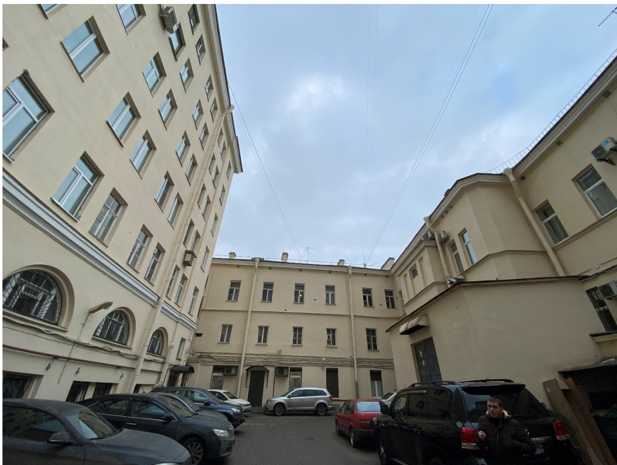
Фото 5. Общий вид северного дворового флигеля. Вид с юга.
