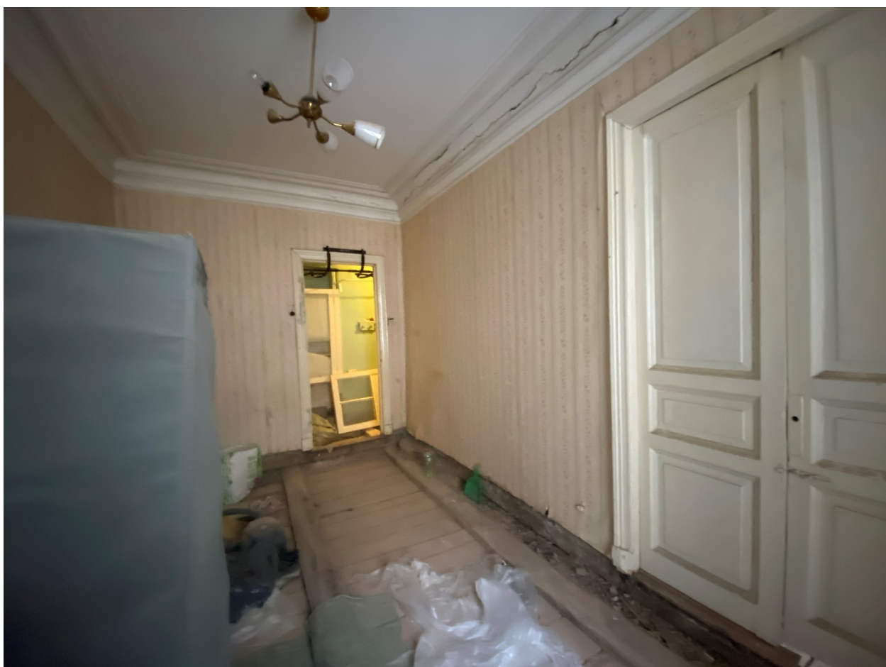
Фото 26. Общий вид помещения № 5. Комната. Вид с севера.
