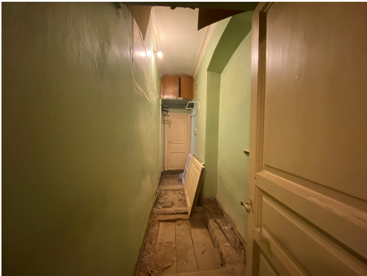
Фото 23. Общий вид помещения № 3. Коридор. Вид с запада.
