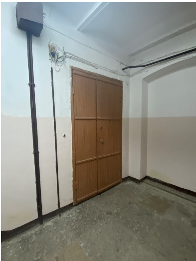
Фото 16. Общий вид входного дверного заполнения в квартиру № 48 со стороны лестничной клетки. Вид с северо-запада.
