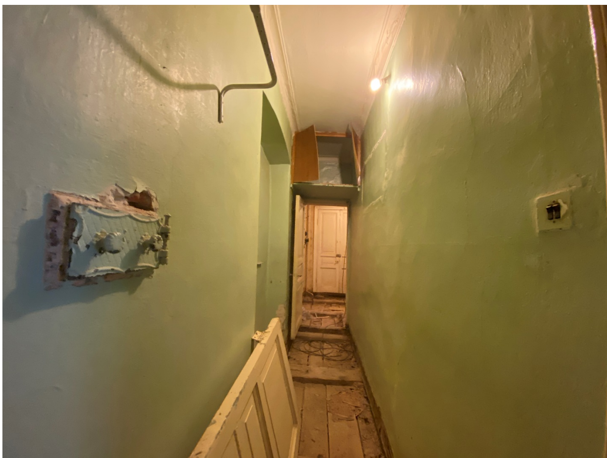
Фото 24. Общий вид помещения № 3. Коридор. Вид с востока.
