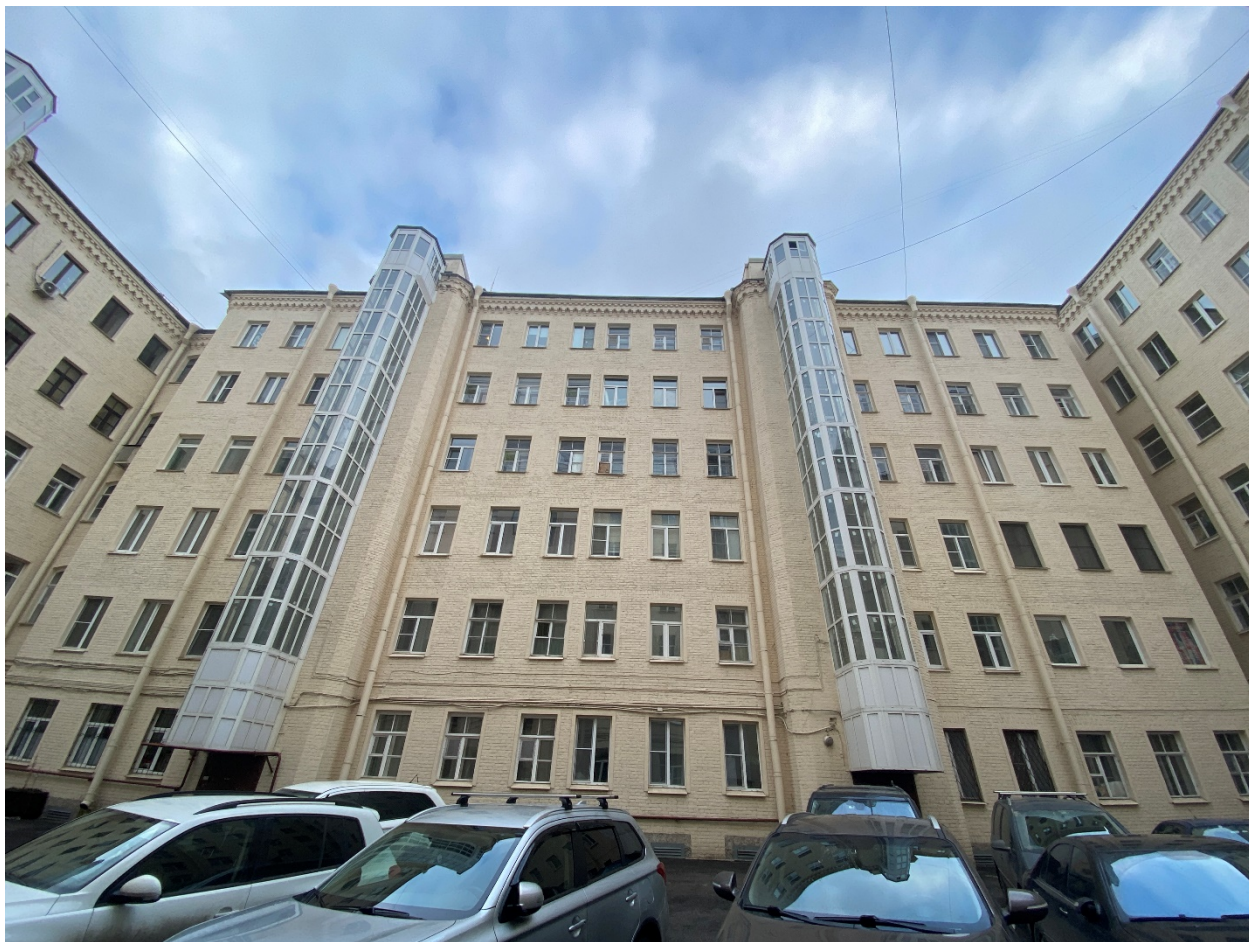
Фото 12. Общий вид северного дворового флигеля. Вид с юга.
