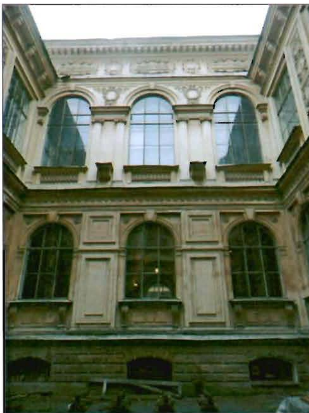
5. Северный внутренний двор. Вид с севера на юг.
