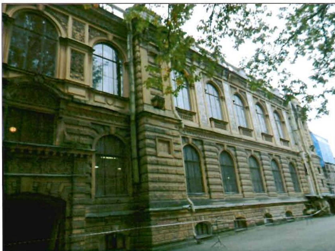
7. Северный дворовый фасад. Общий вид.
