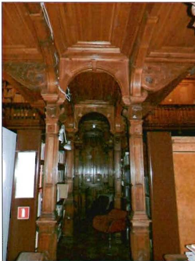
39. Помещение № 1-Н (271). Деревянные колонны.
