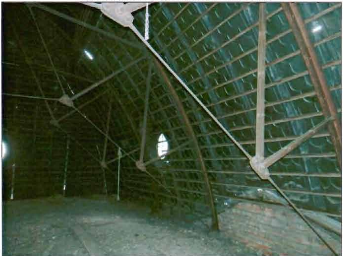
13. Купол над лицевым корпусом. Общий вид на внутренние конструкции купола.
