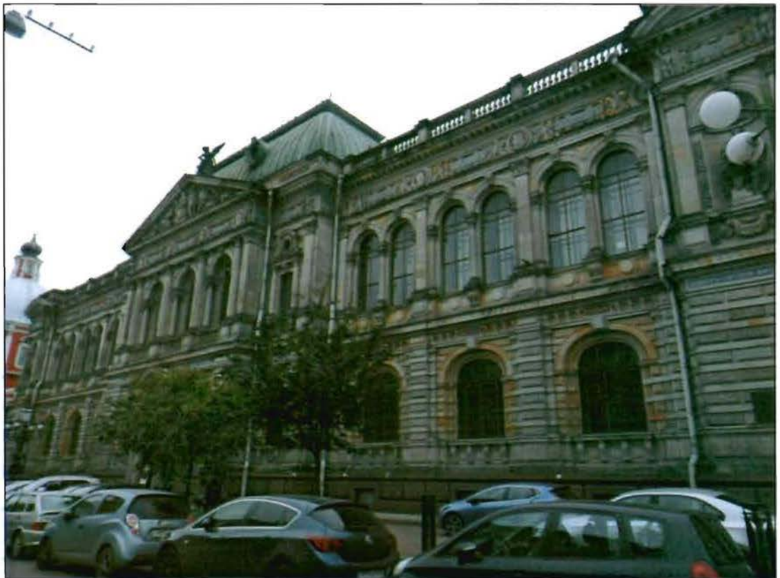
1. Общий вид с северо-востока.
