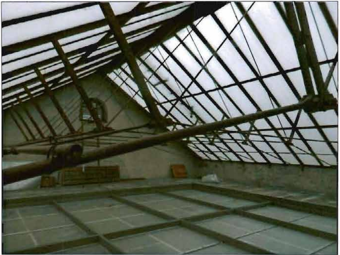
36. Металлические фермы над световым фонарем парадной лестницы.
