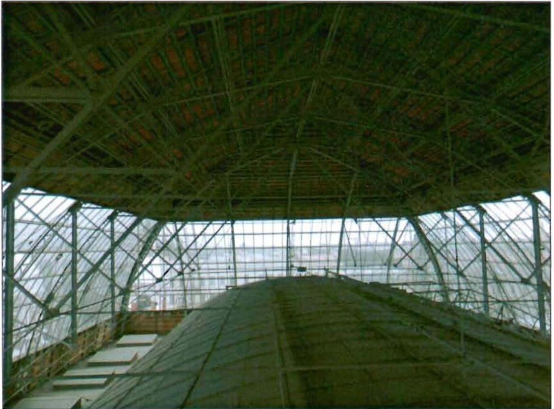
11. Купол над большим выставочный залом. Общий вид на внутренние конструкции купола.
