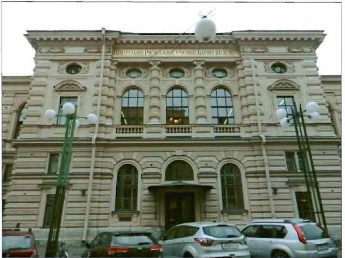
29. Лицевой фасад. Центральный ризалит.
