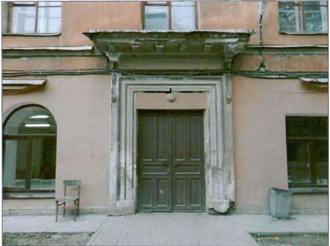
32. Южный дворовый фасад. Фрагмент.
