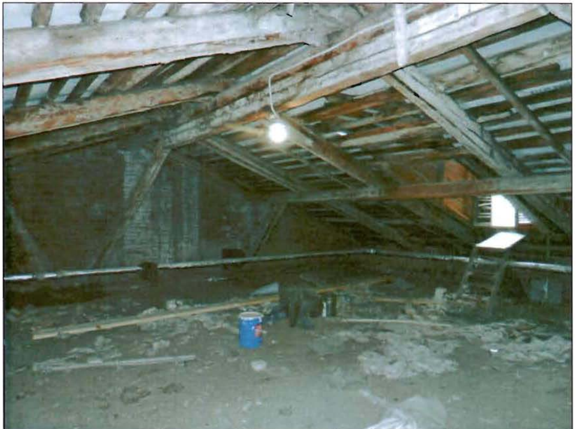
35. Стропильная система. Общий вид.
