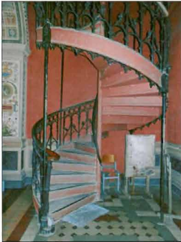
18. Помещение № 1-Н (285). Лестница.
