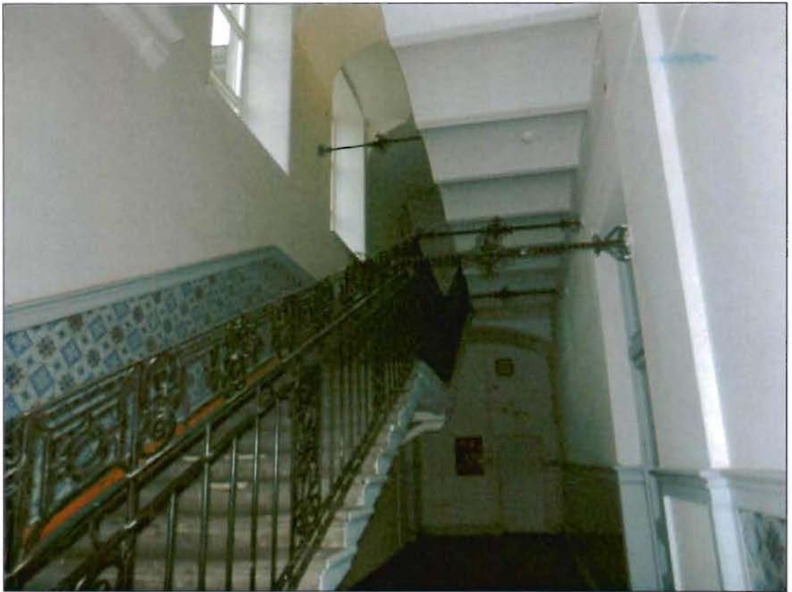
38. Лестница помещения № 1-Н (155). Общий вид.
