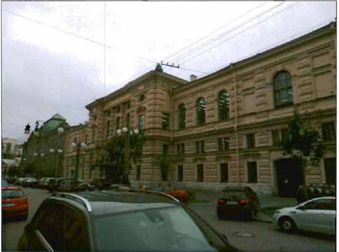
28. Лицевой фасад. Общий вид.
