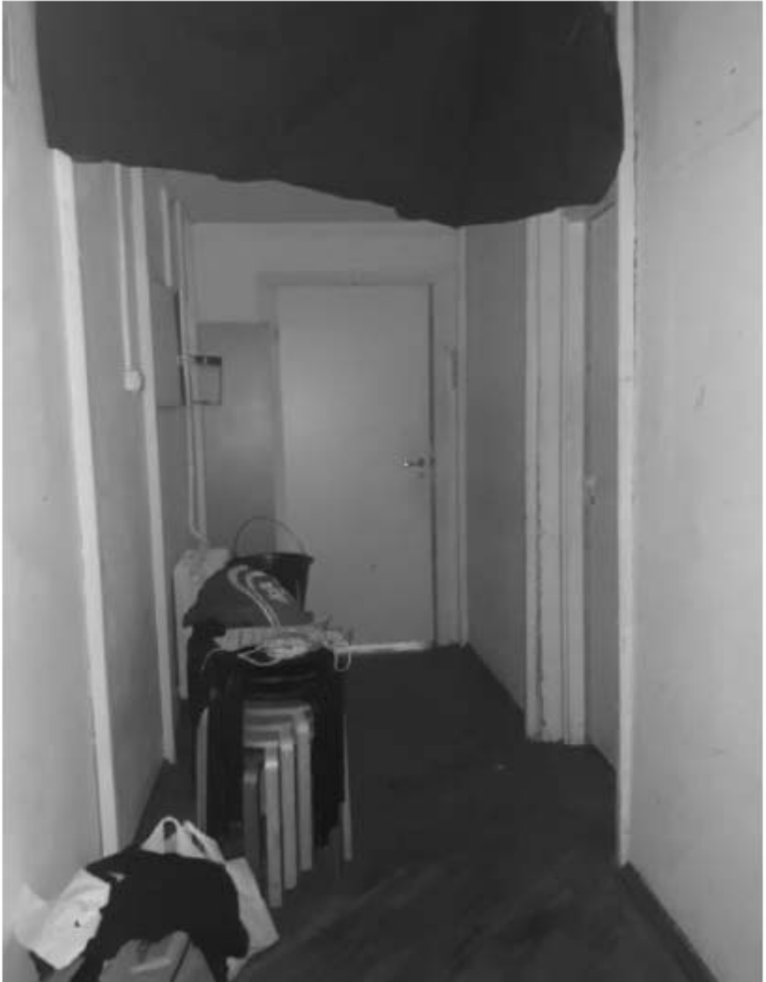
156. «Особняк Безобразовой». Санкт-Петербург, Моховая ул., 34, литера А (Моховая ул., 34). Дворовый корпус. 4-й этаж. Фрагмент помещения 22-Н(2). Фото: 18.05.2021.
