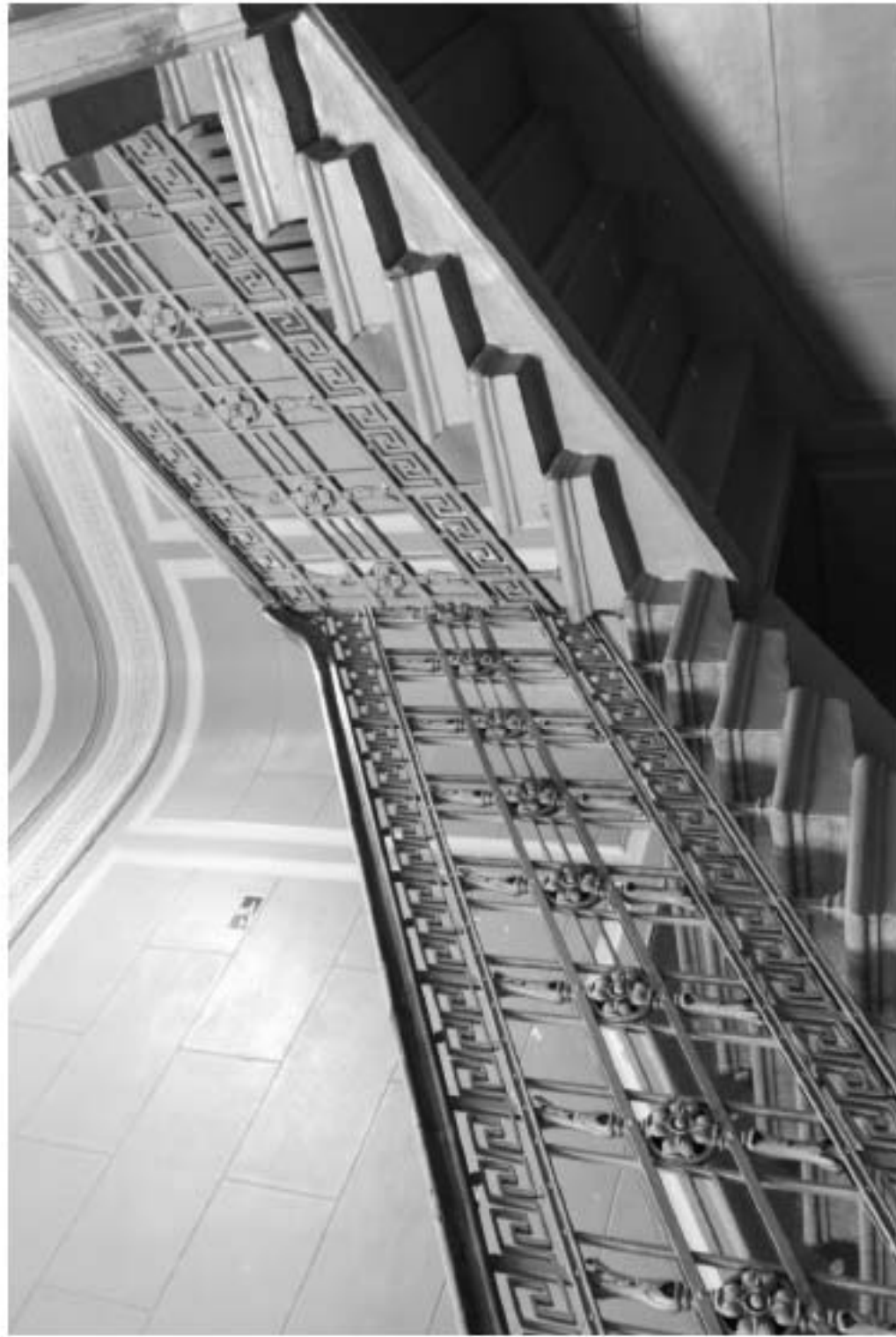
3. «Особняк Безобразовой». Санкт-Петербург, Моховая ул., 34, литера А (Моховая ул., 34). Лицевой корпус. Северная трехмаршевая лестница. Фото: 18.05.2021.
