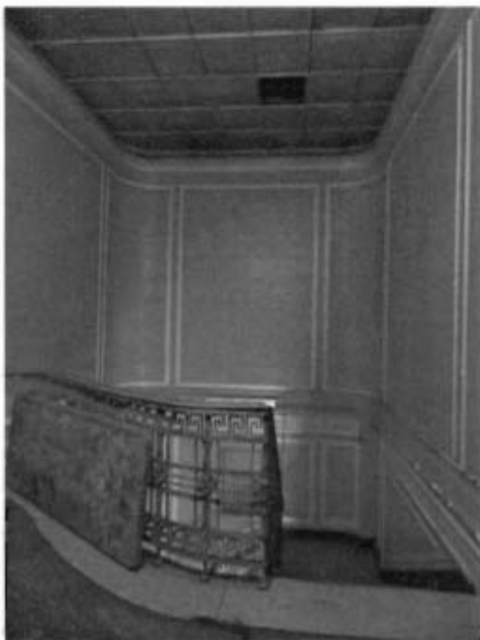
20. Лестница в северо-западной части здания.
