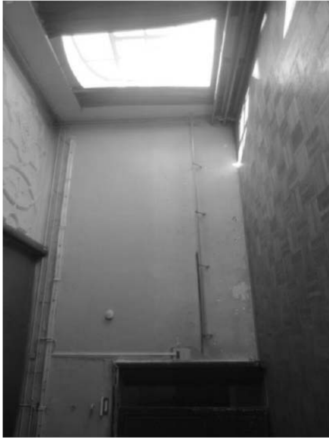
33. «Особняк Безобразовой». Санкт-Петербург, Моховая ул., 34, литера А (Моховая ул., 34). Лицевой корпус. 1-й этаж. Фрагмент помещения 10-Н(20). Фото: 18.05.2021.
