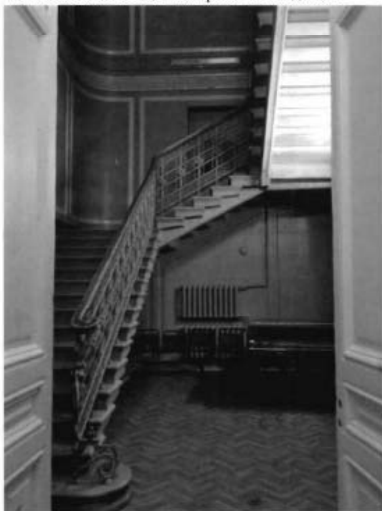
19. Лестница в северо-западной части здания.
