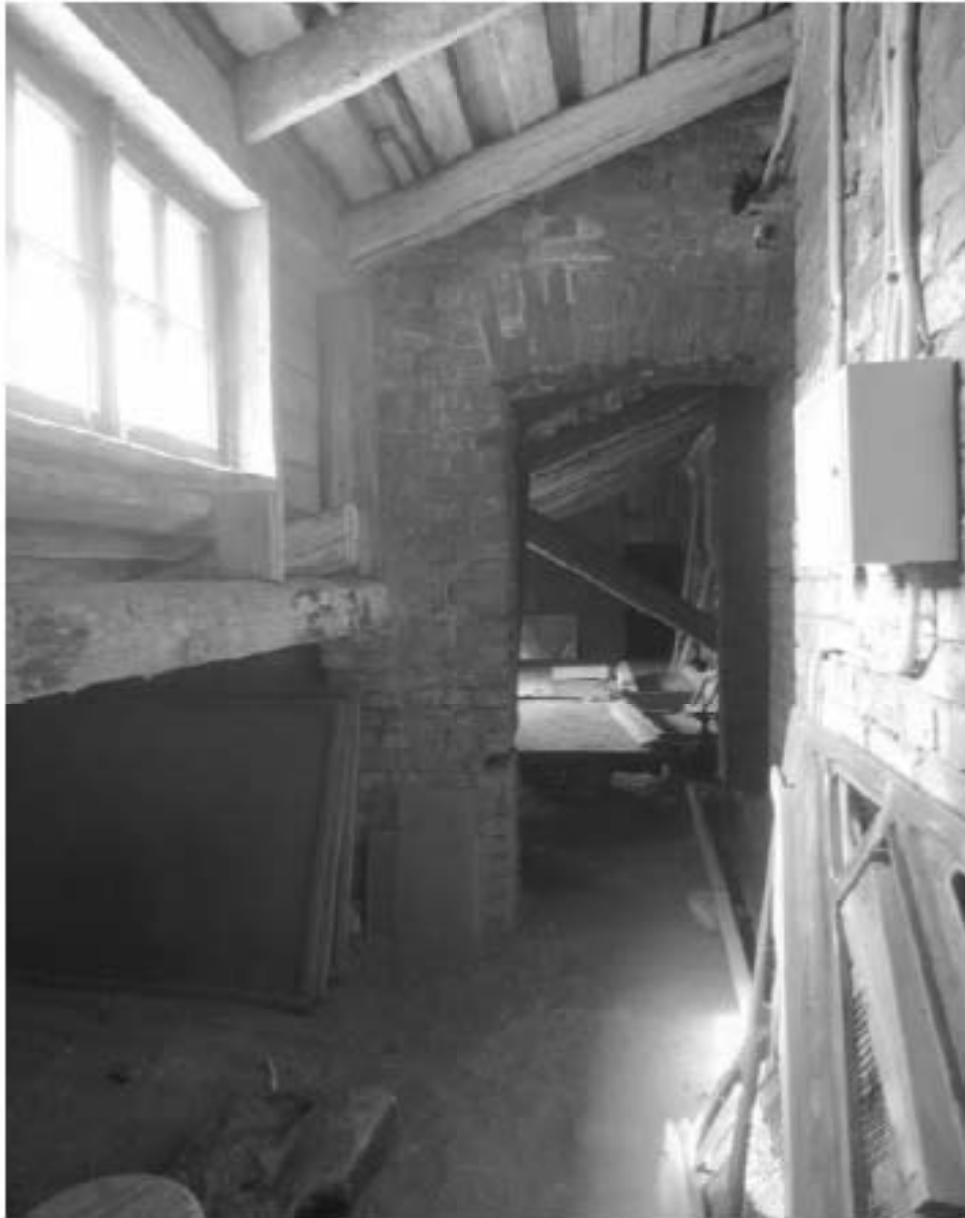
182. «Особняк Безобразовой». Санкт-Петербург, Моховая ул., 34, литера А (Моховая ул., 34). Фрагмент чердачного помещения. Фото: 18.05.2021.
