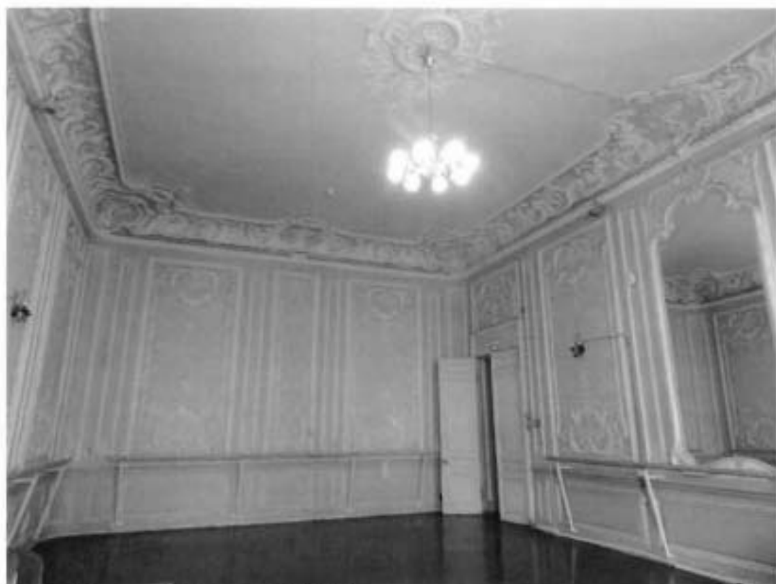
14. Помещение 2 этажа (18-Н (1)).
