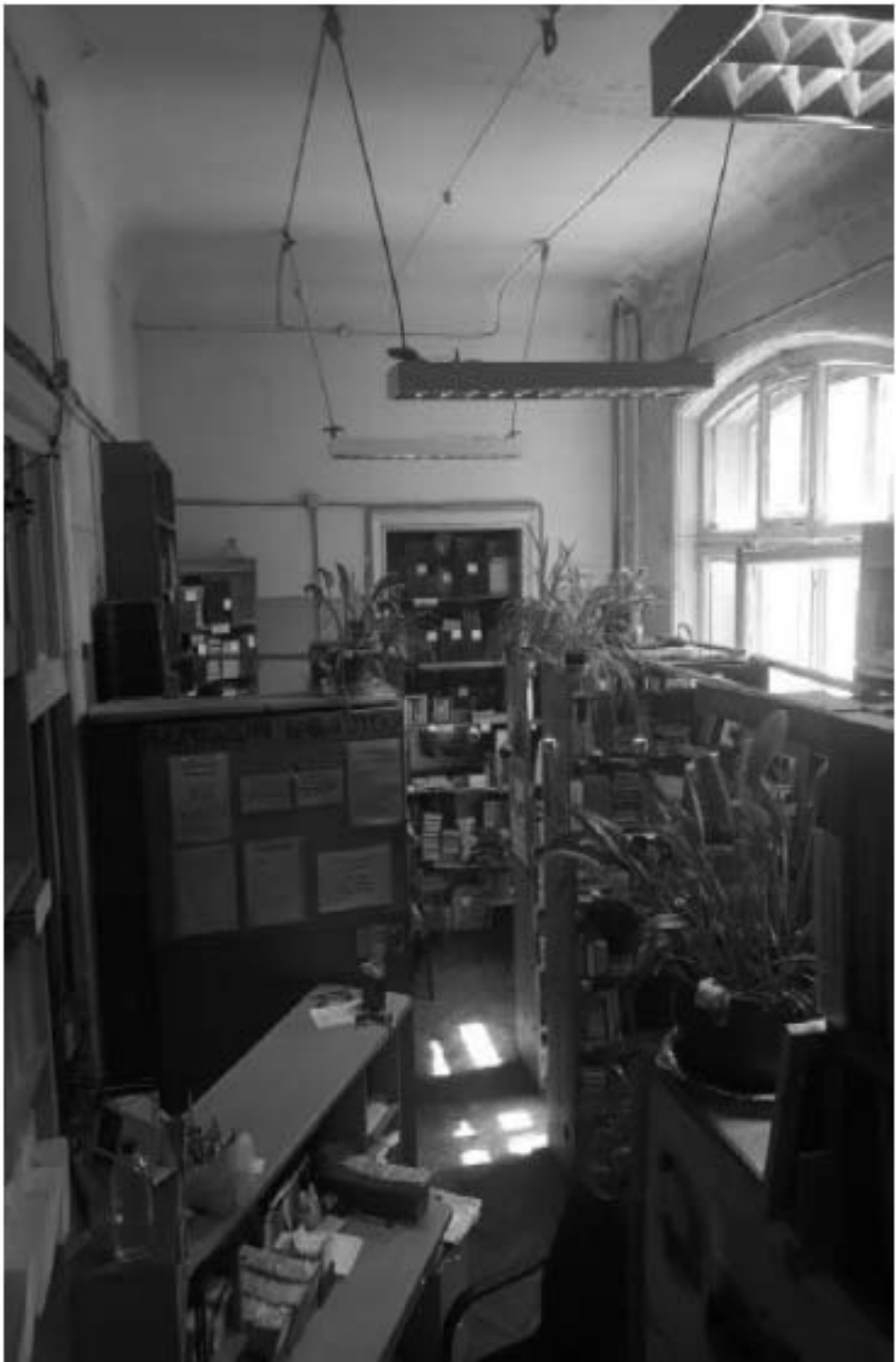
249. «Особняк Безобразовой». Санкт-Петербург, Моховая ул., 34, литера А (Моховая ул., 34). Лицевой корпус. 3-й этаж. Фрагмент помещения 21-Н(19). Фото: 18.05.2021.
