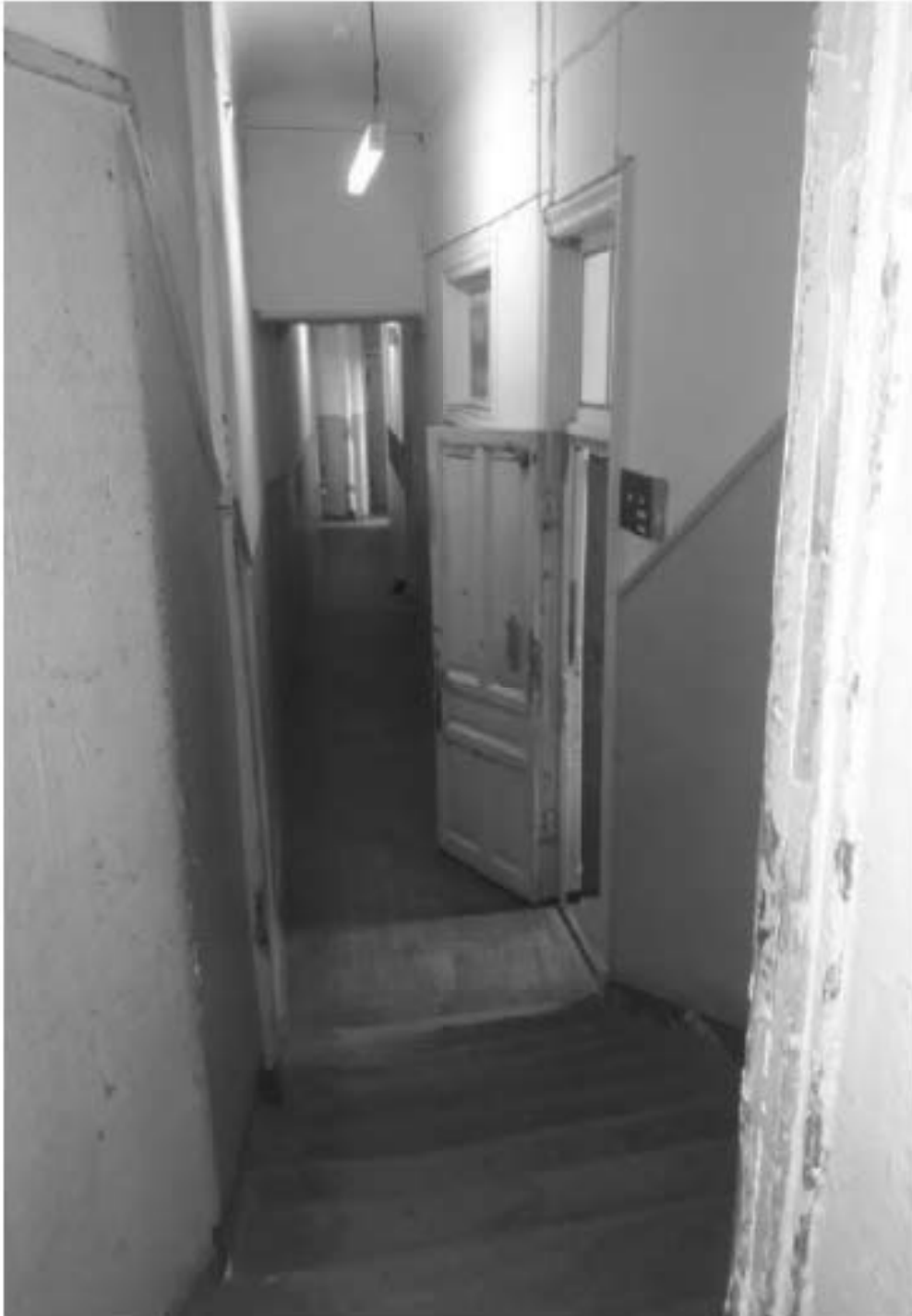
152. «Особняк Безобразовой». Санкт-Петербург, Моховая ул., 34, литера А (Моховая ул., 34). Дворовый корпус. 3-й этаж. Фрагмент помещения 21-Н(21). Фото: 18.05.2021.
