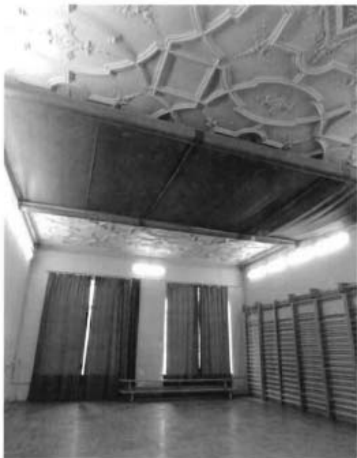
16. Помещение 2 этажа (19-Н (14)).
