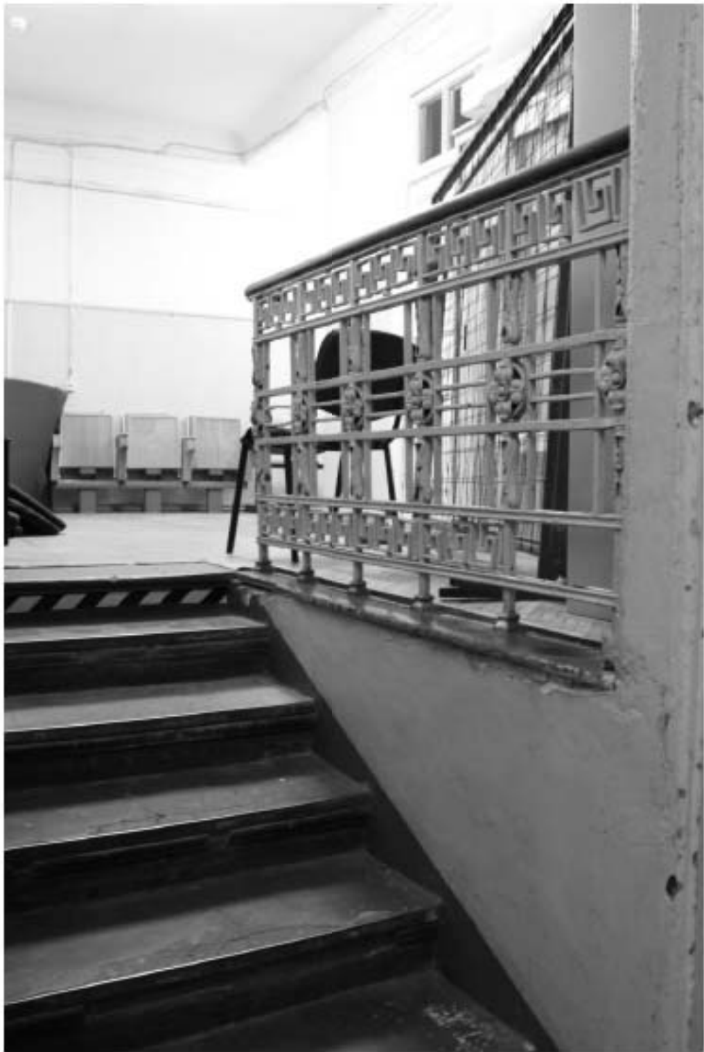
154. «Особняк Безобразовой». Санкт-Петербург, Моховая ул., 34, литера А (Моховая ул., 34). Дворовый корпус. 3-й этаж. Фрагмент помещения 21-Н(17). Фото: 18.05.2021.
