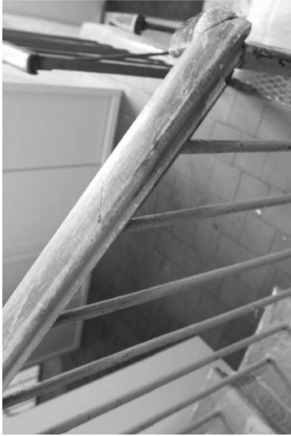
19. «Особняк Безобразовой». Санкт-Петербург, Моховая ул., 34, литера А (Моховая ул., 34). Дворовой корпус. Винтовая лестница в северной части здания. Фото: 18.05.2021.
