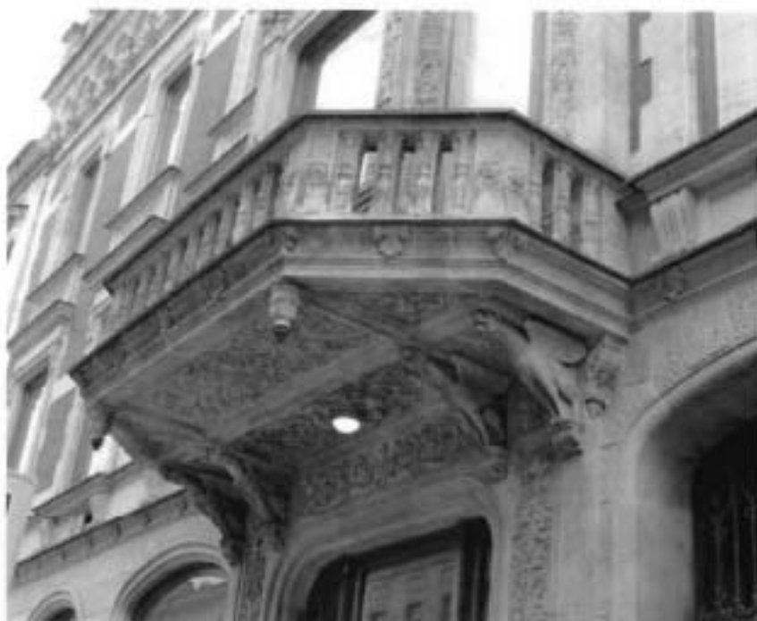
2. Фрагмент декора лицевого фасада.
