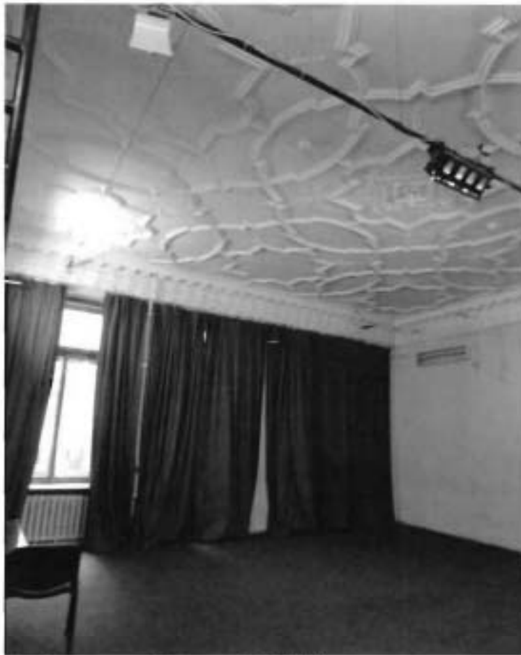
8. Помещение 1 этажа (10-Н(20)).
