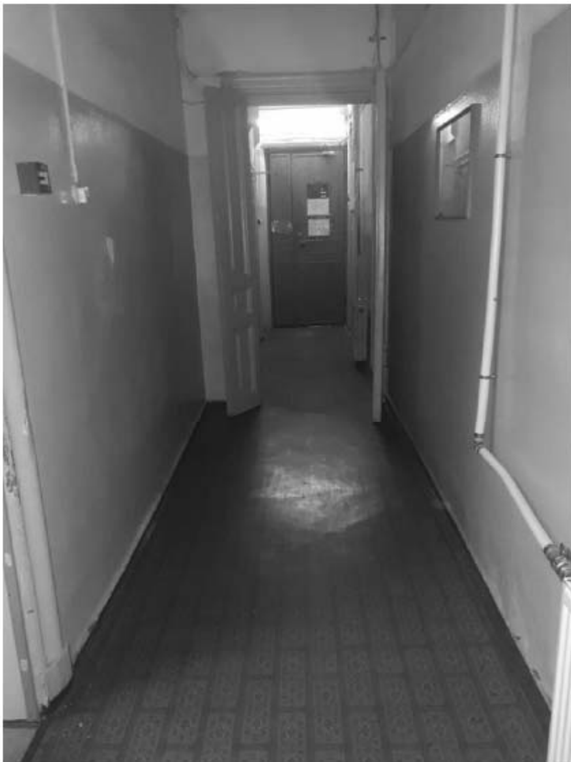
99. «Особняк Безобразовой». Санкт-Петербург, Моховая ул., 34, литера А (Моховая ул., 34). Дворовый корпус. 2-й этаж. Фрагмент помещения 19-Н(8). Фото: 18.05.2021.
