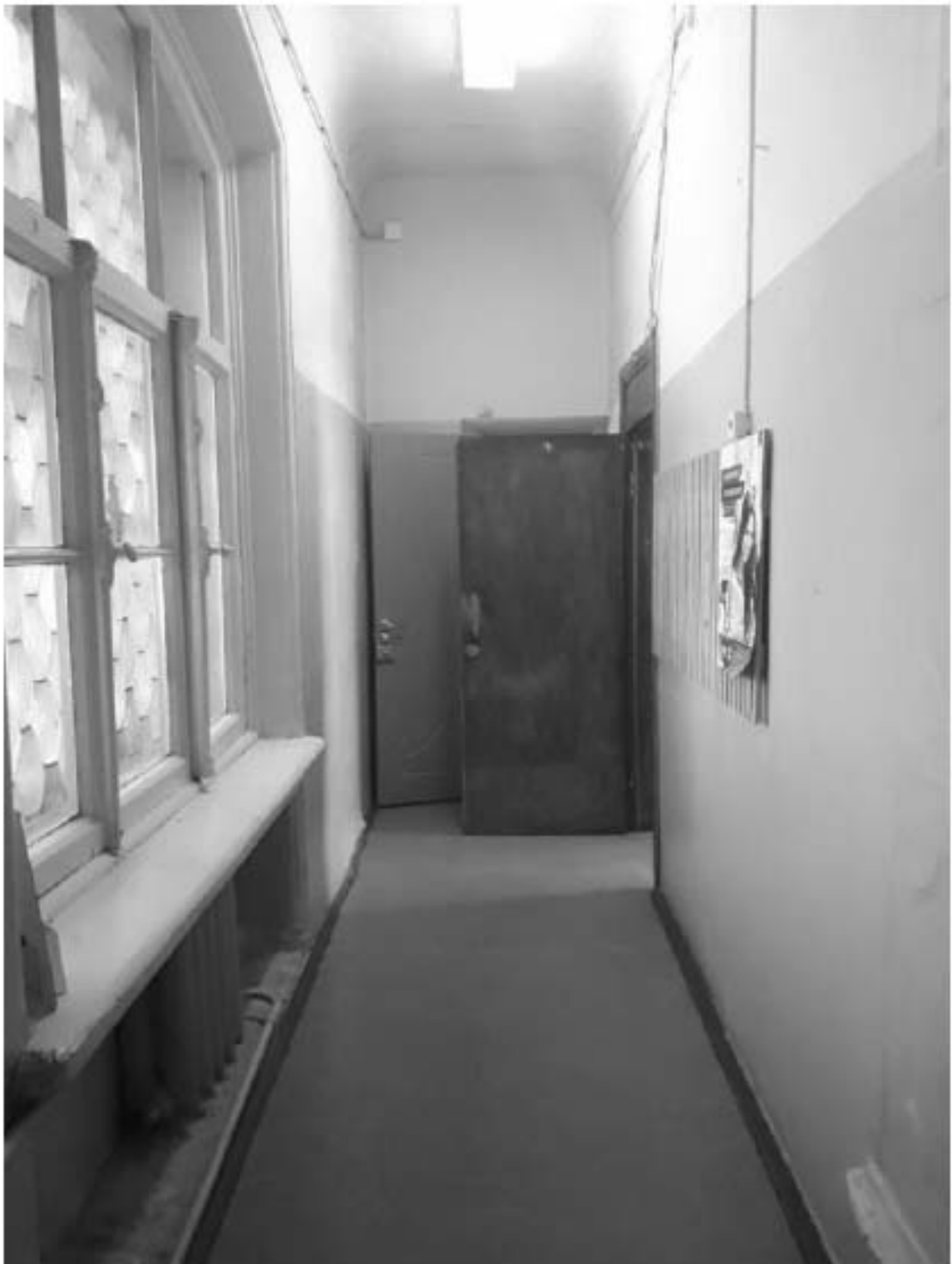
102. «Особняк Безобразовой». Санкт-Петербург, Моховая ул., 34, литера А (Моховая ул., 34). Дворовый корпус. 3-й этаж. Фрагмент помещения 20-Н(7). Фото: 18.05.2021.
