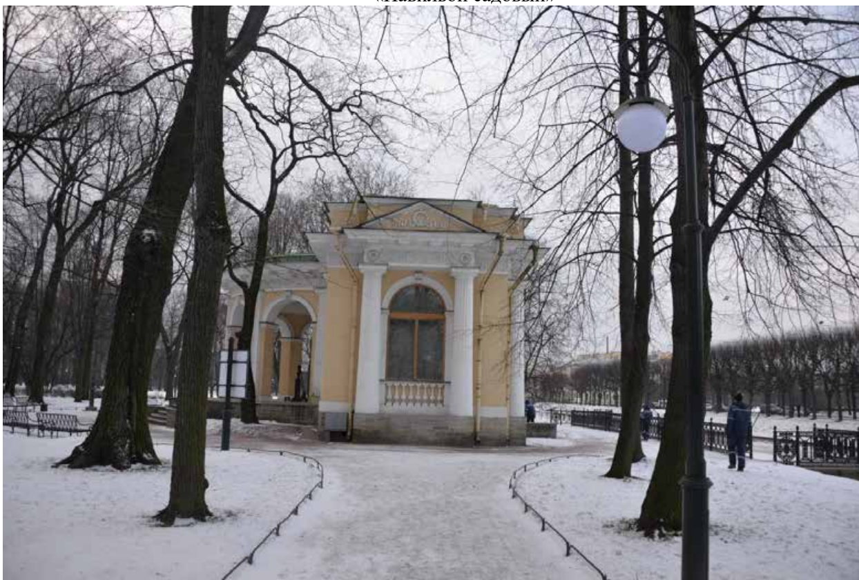
14. Восточный фасад объекта культурного наследия федерального значения «Павильон садовый»
