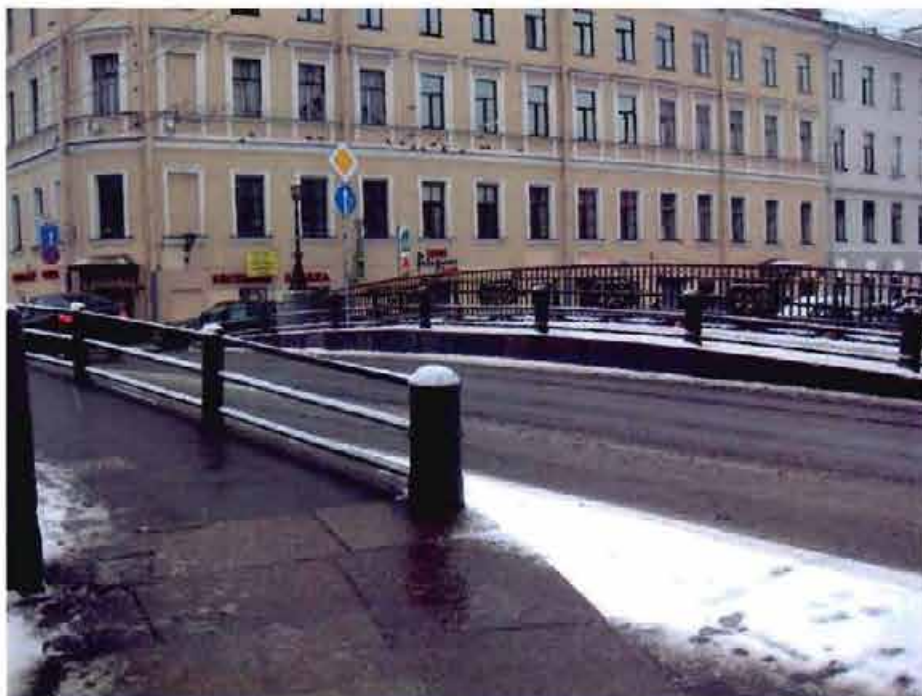
1. Вид на поверхность моста и силовое ограждение
