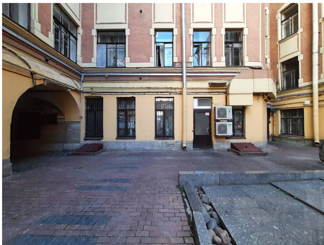
Фото 6. Фрагмент дворового фасада выявленного объекта культурного наследия «Дом С.М. Дейчмана»
