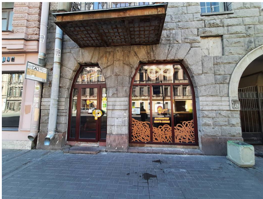
Фото 2. Фрагмент лицевого фасада выявленного объекта культурного наследия «Дом С.М. Дейчмана», вход в помещение 2-Н
