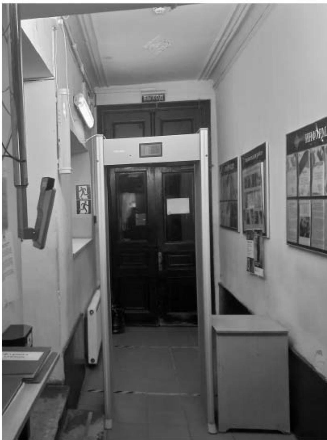
Фото 18. Входной тамбур. Предмет охраны - профилированная штукатурная тяга по периметру потолка; лепная ромбовидная розетка в центральной части потолка, с мотивами растительного характера.
