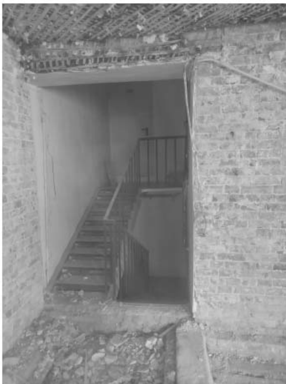
Фото 55. Лестница на мансарду.
