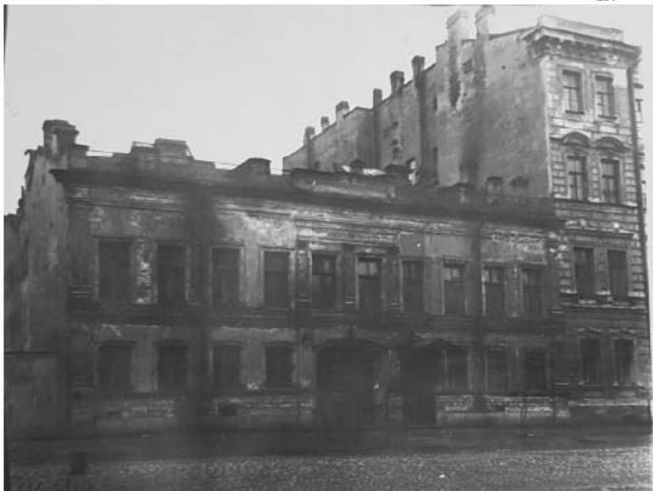
45. Вид фасада дома №28 на 5-й линии Васильевского острова. 1947 г. ЦГАКФФД СПб. ВР 75122
