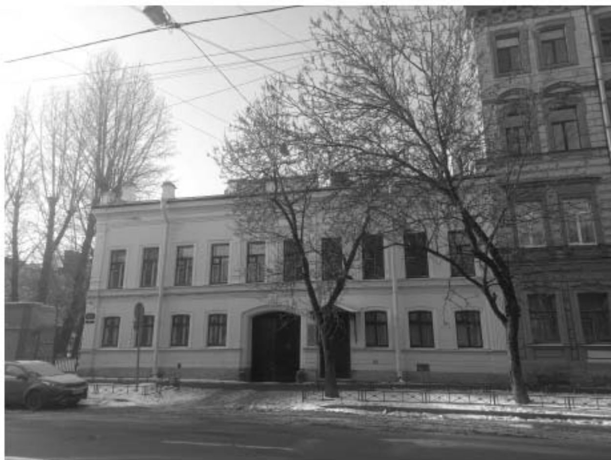
Фото 1. Лицевой корпус, главный фасад.
