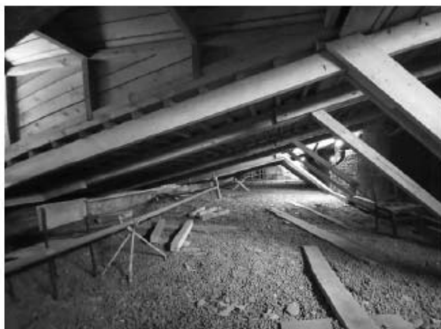
Фото 71. Чердак лицевого корпуса со стороны двора.
