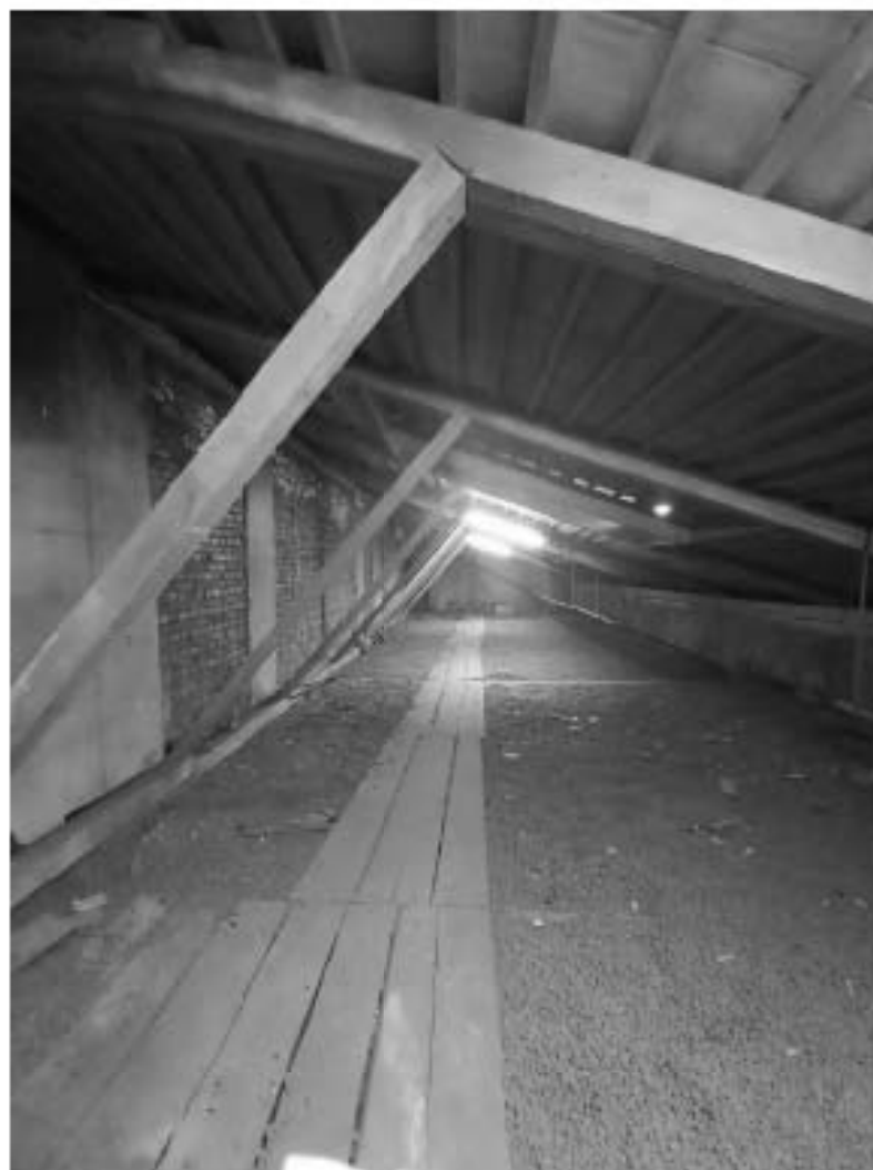
Фото 70. Чердак лицевого корпуса со стороны 5-й линии ВО.
