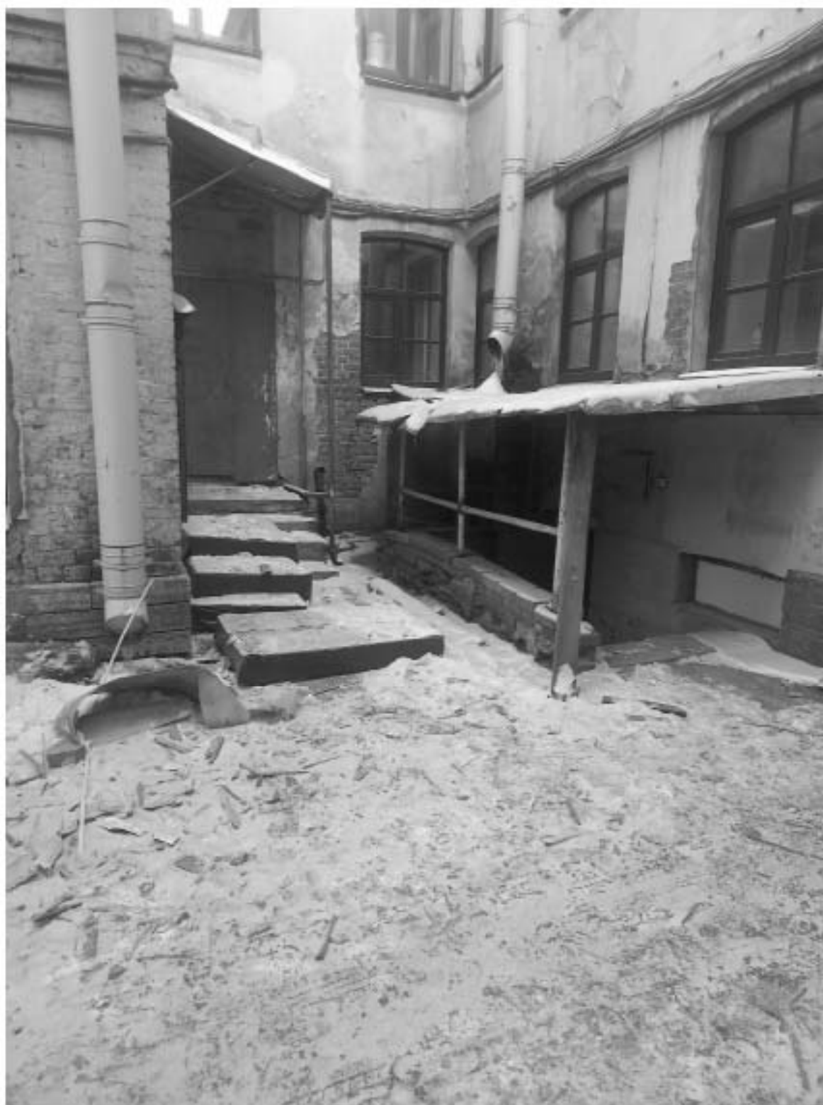
Фото 8. Прямок лицевого корпуса в зоне перехода к северному флигелю.
