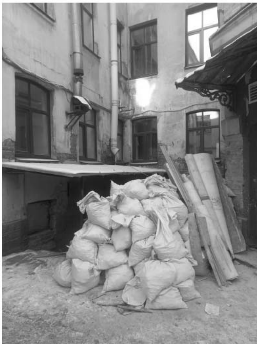
Фото 7. Прямок лицевого корпуса в зоне перехода к южному флигелю.
