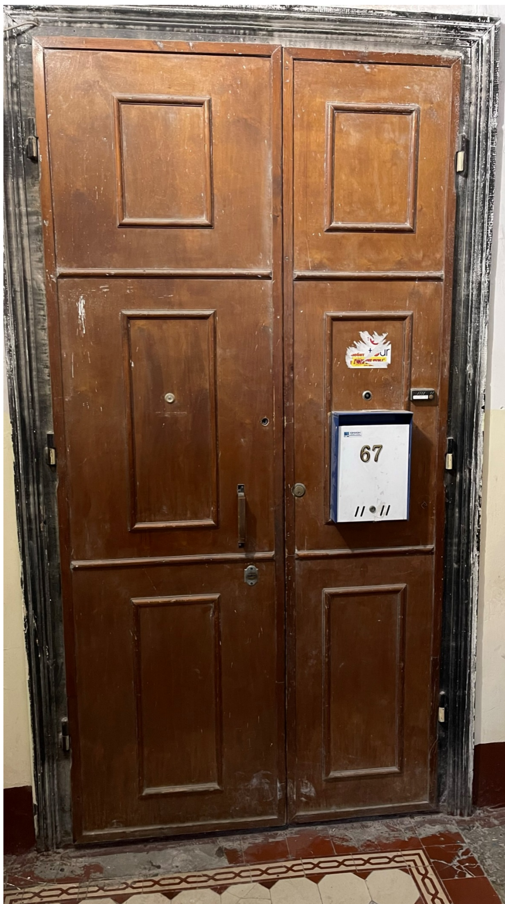
3. Вид на входную дверь в квартиру №67;
