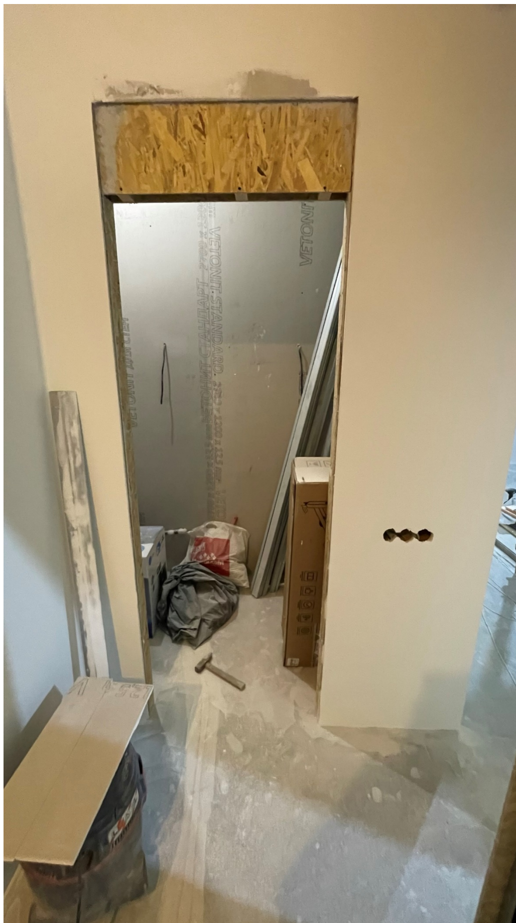
7. Фрагмент интерьера коридора (помещение №1/6.8);
