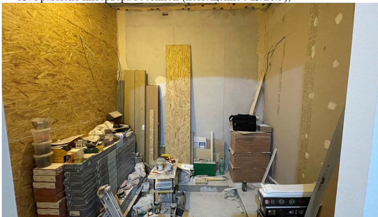
14.Фрагмент интерьера кухни (помещение №5/7.0);
