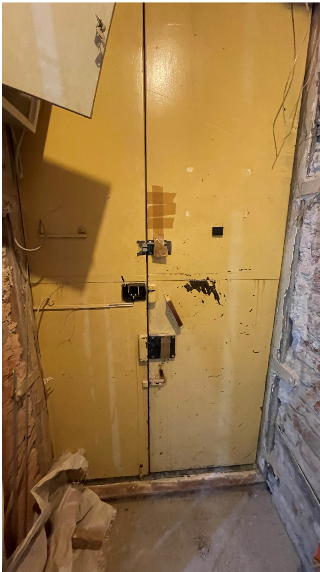
4. Вид на входную дверь в квартире №67;
