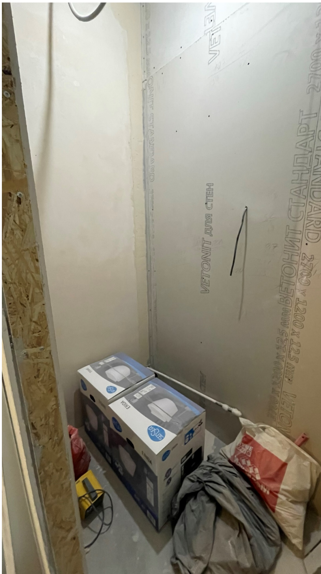
10. Фрагмент інтер'єра санузла (поміщення №4/3.5);
