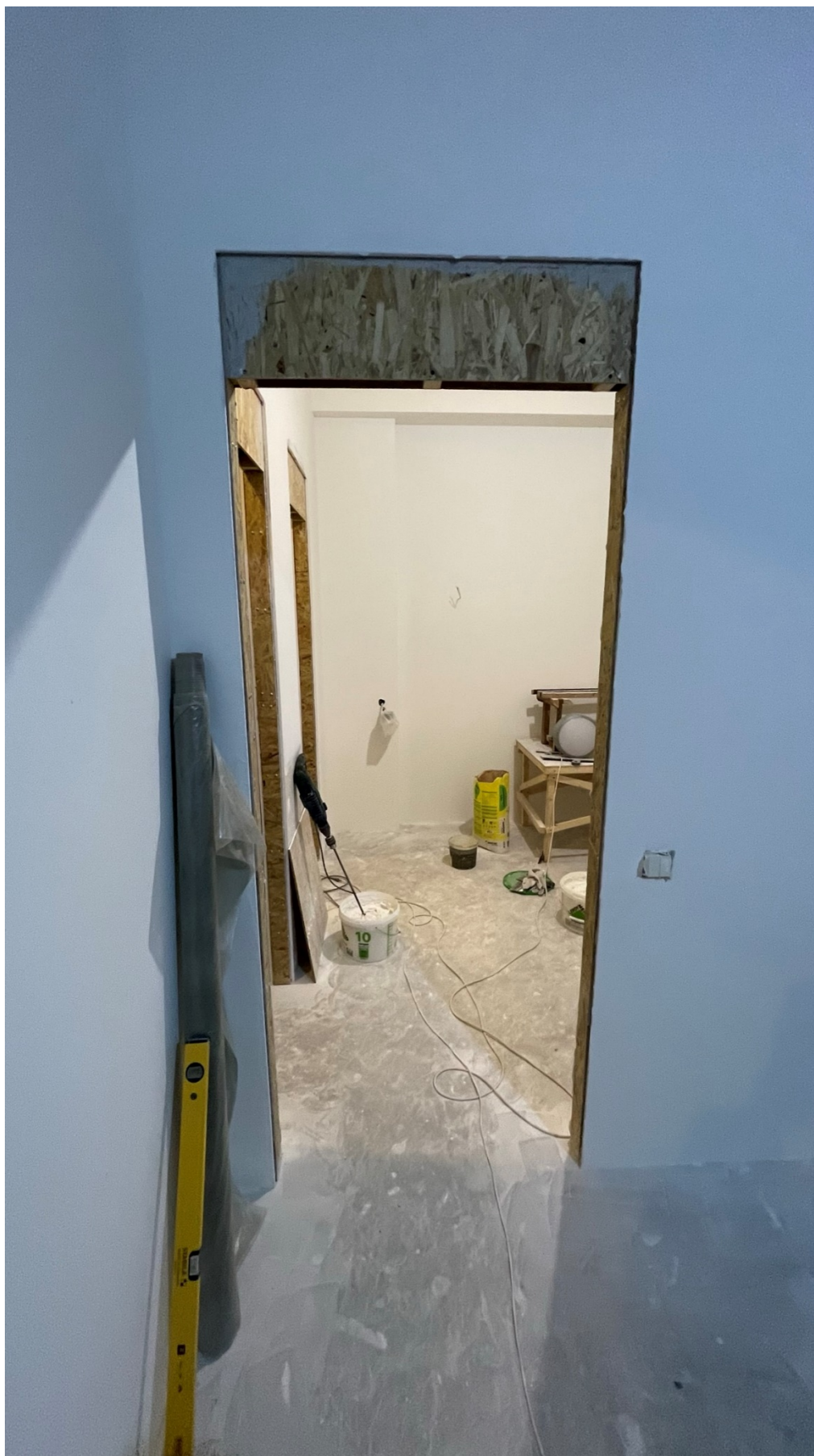
16. Вид на кабинет (помещение №8/9.9);
