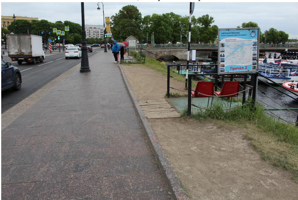
Фото 4. Вид на тротуар из гранитных плит на участке набережной Кронверкского пролива «Иоанновский мост-Восточный Артиллерийский мост», литера А с востока.
