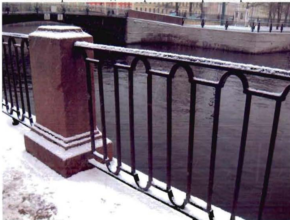
2. Ограждение набережной на участке между Инженерным Первым и Михайловским (1-м Садовым) мостами (правый берег)
