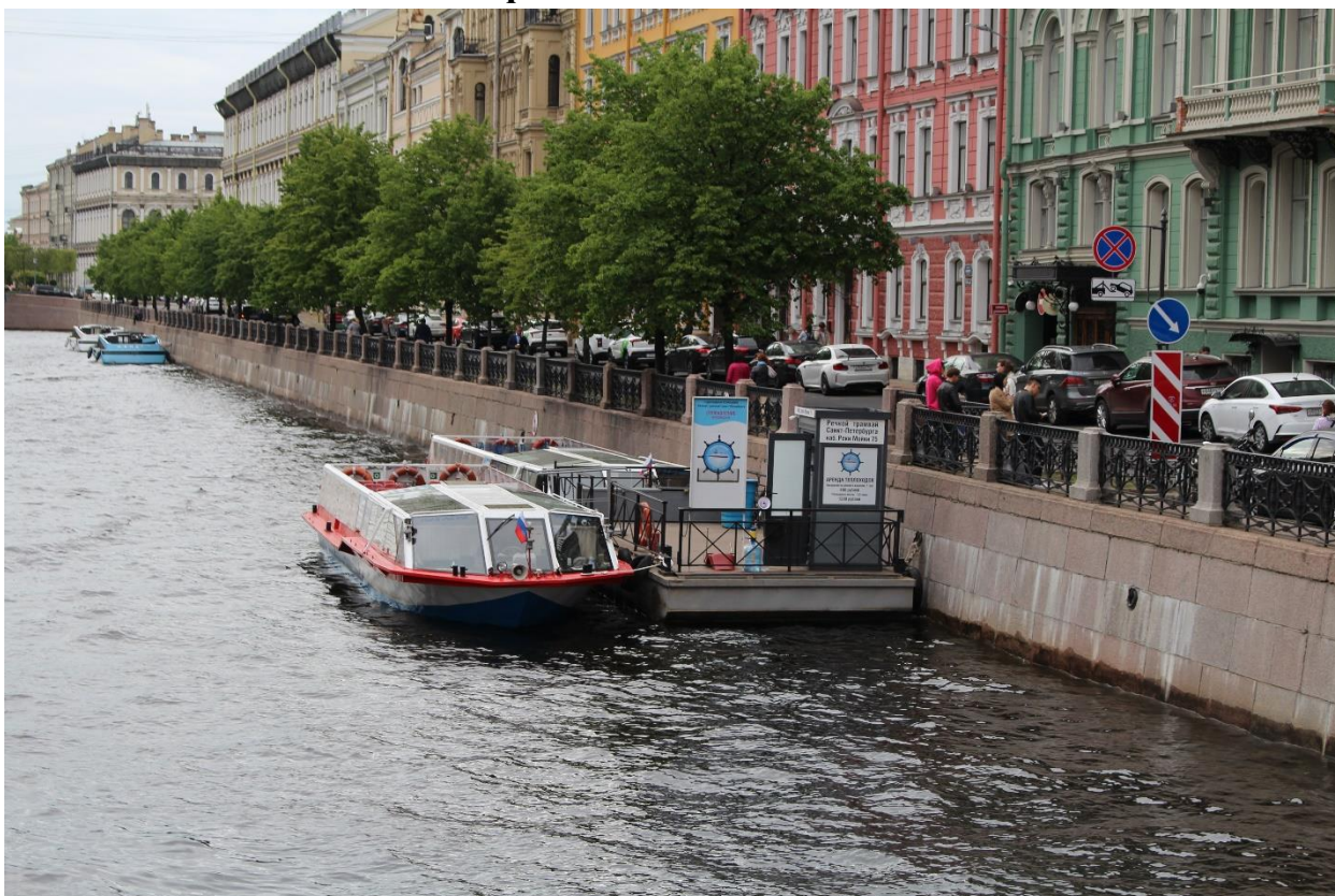
Фото 1. Общий вид на спуск № 11 (литера А) объекта культурного наследия федерального значения «Набережные со спусками» с Красного моста.
