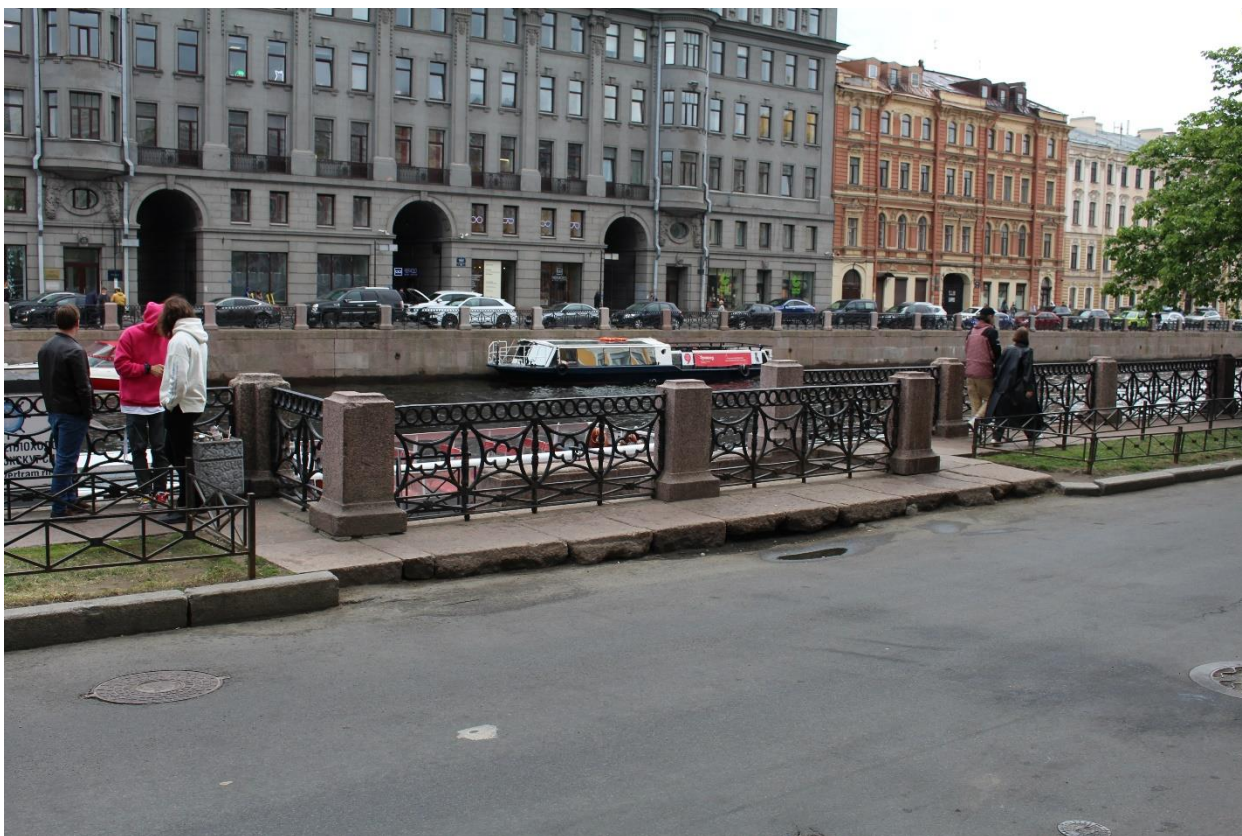
Фото 3. Вид на спуск № 11 (литера А) объекта культурного наследия федерального значения «Набережные со спусками» с севера.
