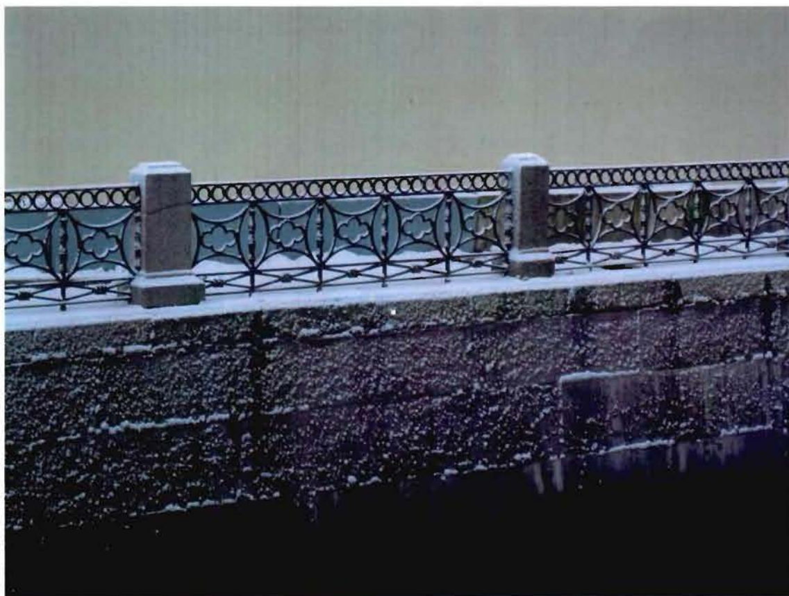
6. Ограждение набережной. Левобережная стенка
