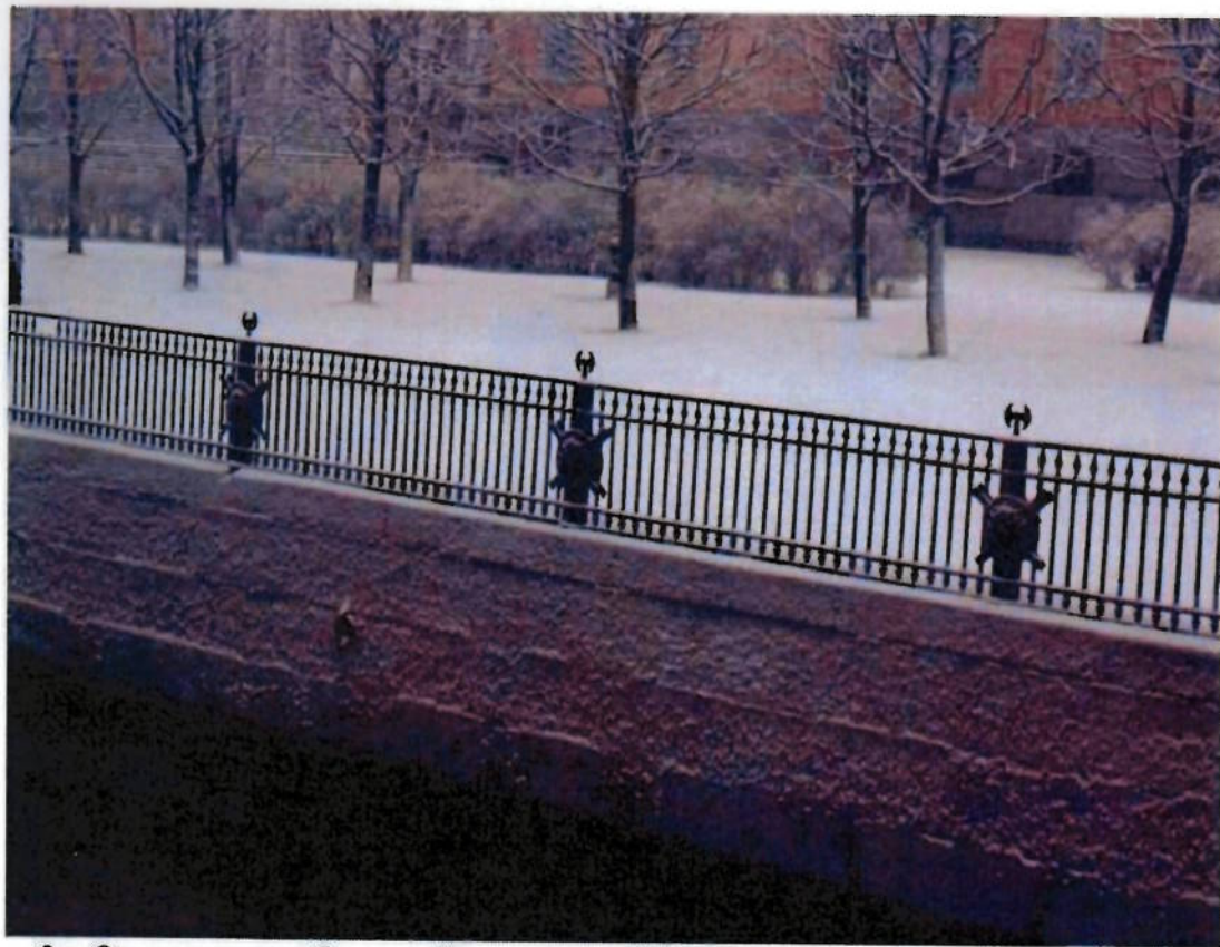
3. Ограждение набережной со стороны Михайловского (Инженерного) замка
