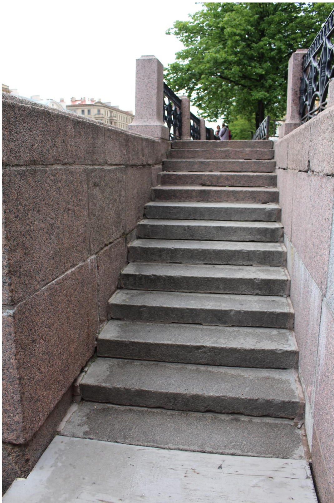
Фото 6. Вид на лестницу спуска № 11 (литера А) объекта культурного наследия федерального значения «Набережные со спусками» с нижней площадки.
