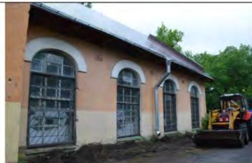
окно второго света торцевого фасада машинного зала – трехчастное, с полуциркульным завершением;
