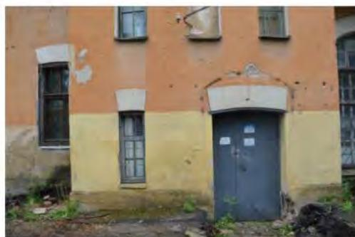
дверной проем юго-западной раскреповки с лучковой перемычкой, декорированной штукатурной разделкой под кирпич - габариты, местоположение;
