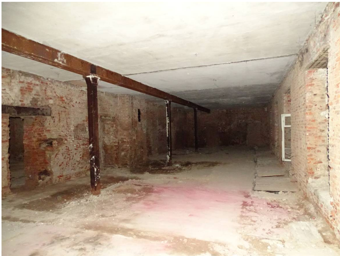
Фото 06. Секция 3. Помещение 1-го этажа. Съемка 15.06.2023 г. Трушковский В.Э.
