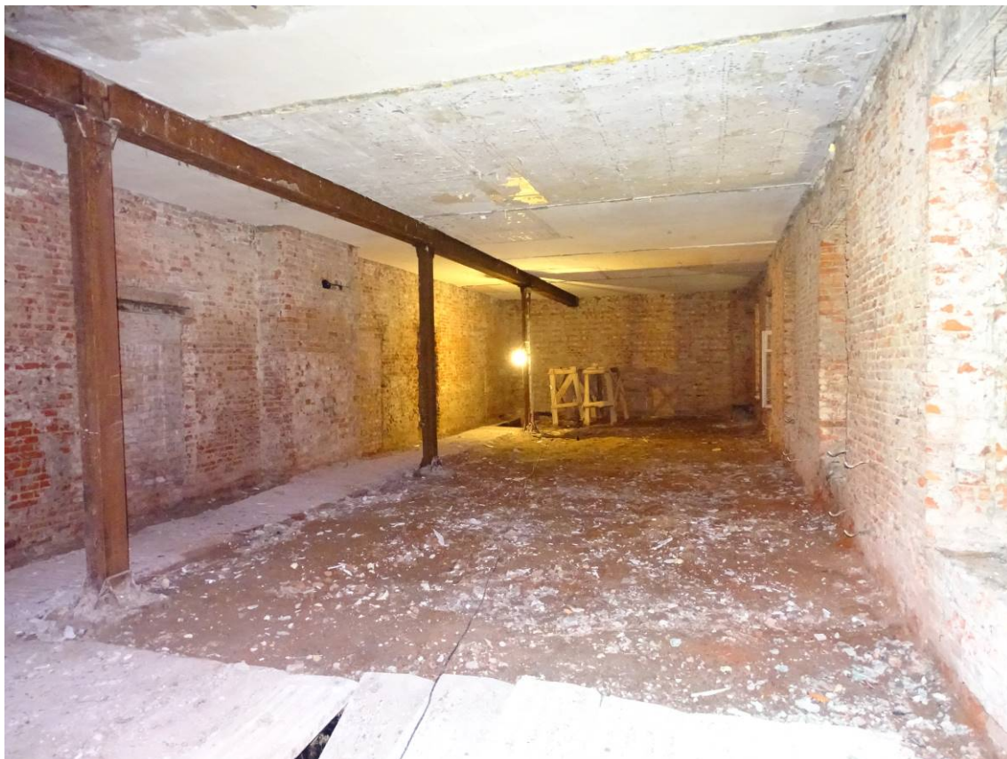
Фото 02. Секция 3. Помещение 1-го этажа. Съемка 15.06.2023 г. Трушковский В.Э.
