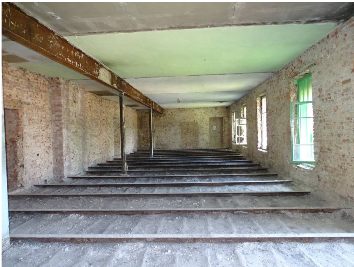
Фото 20. Секция 4. Помещение 3-го этажа. Съемка 15.06.2023 г. Трушковский В.Э.
