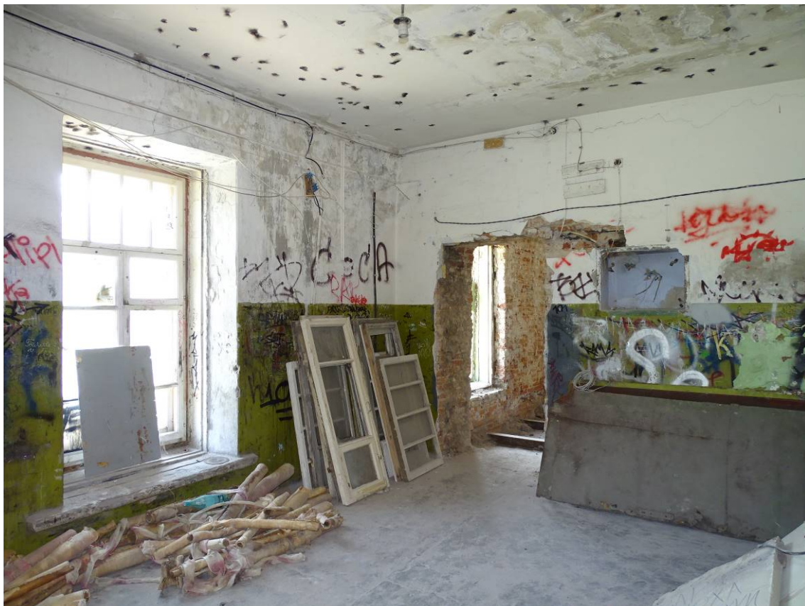
Фото 06. Секция 1. Вестибюль 2-го этажа. Съемка 15.06.2023 г. Трушковский В.Э.
