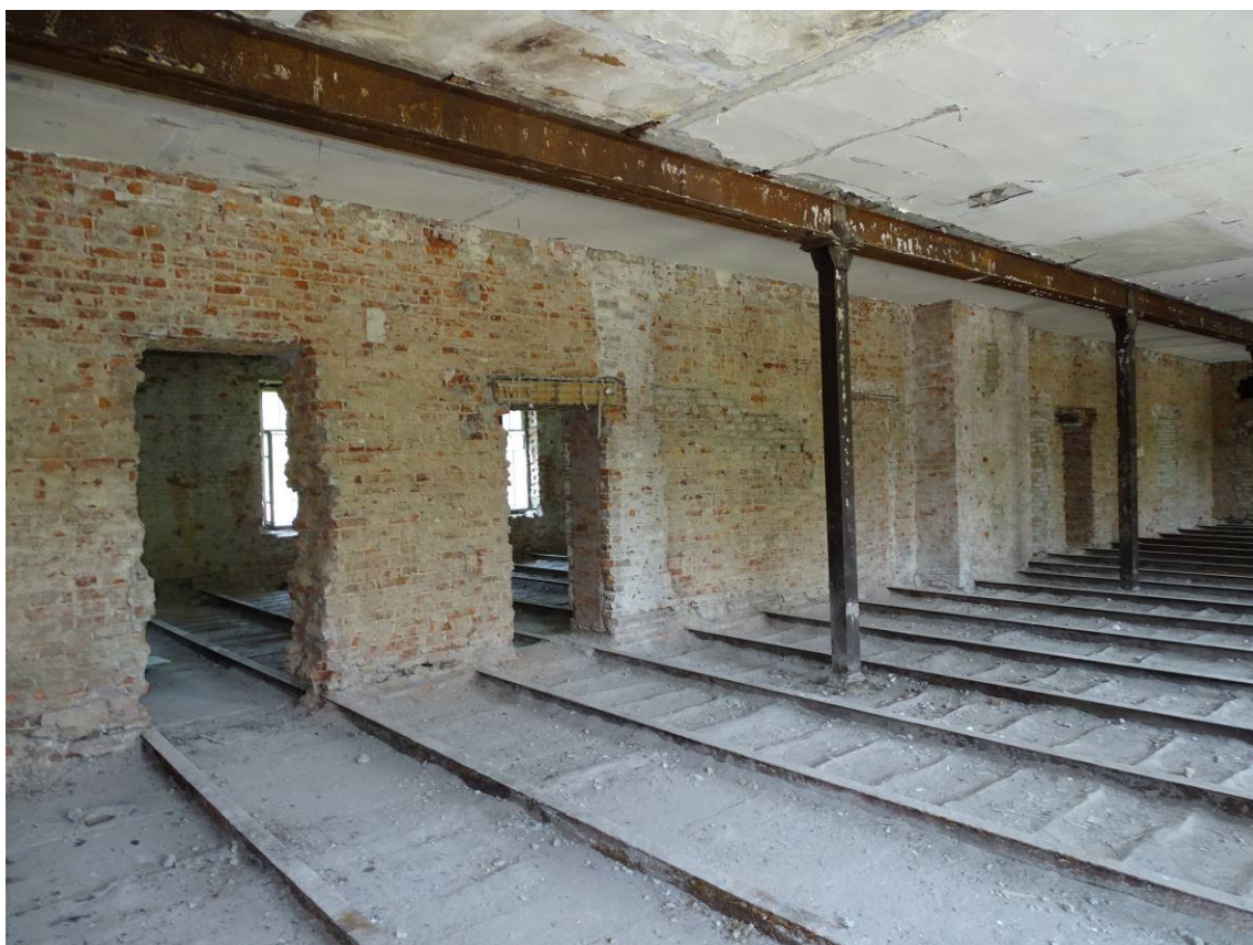
Фото 13. Секция 2. Помещение 2-го этажа. Съемка 15.06.2023 г. Трушковский В.Э.
