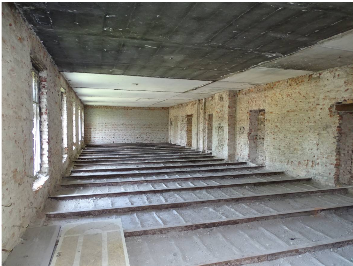
Фото 16. Секция 2. Помещение 3-го этажа. Съемка 15.06.2023 г. Трушковский В.Э.
