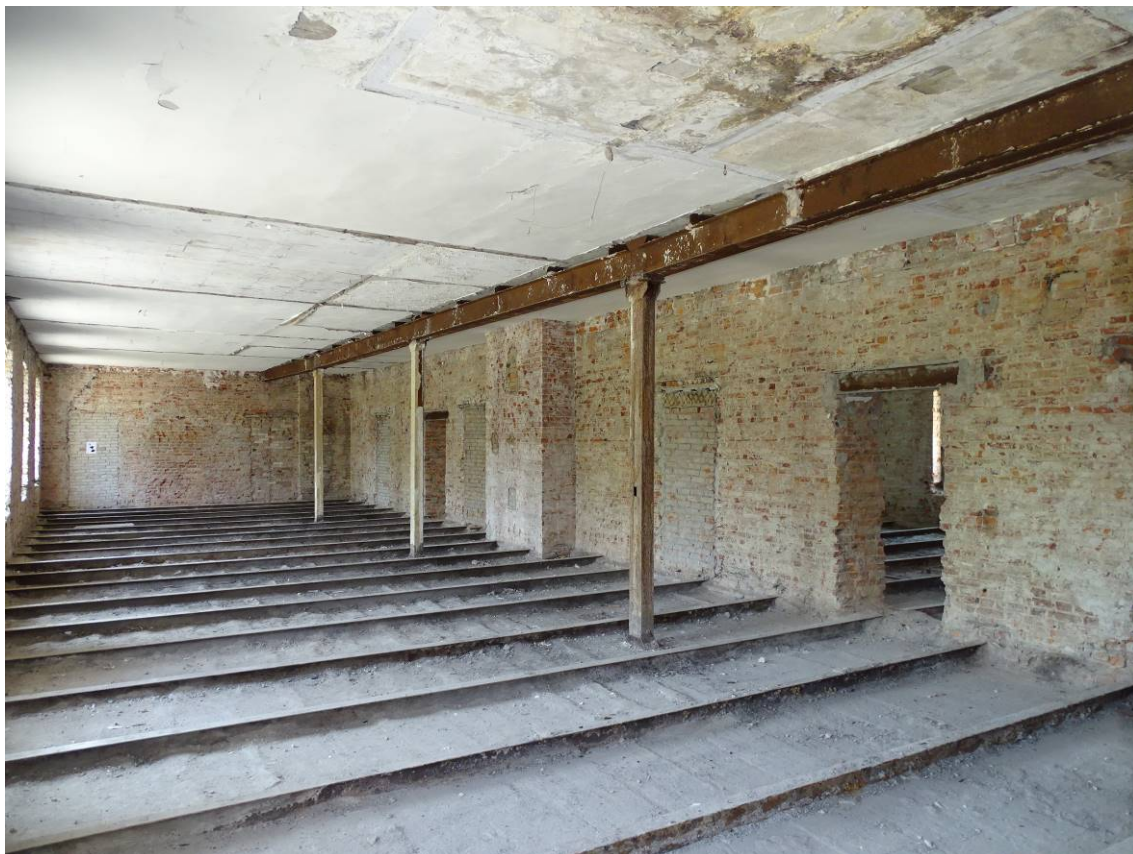
Фото 14. Секция 2. Помещение 2-го этажа. Съемка 15.06.2023 г. Трушковский В.Э.
