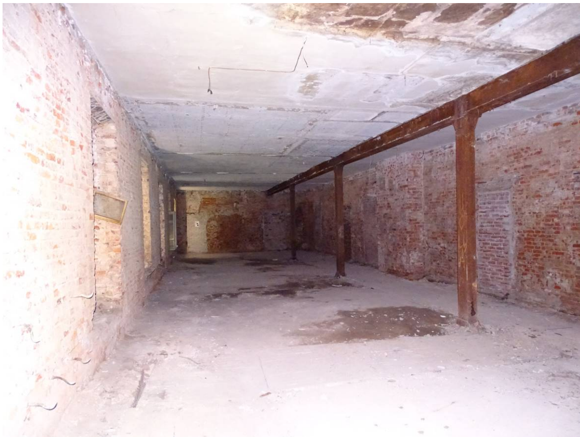
Фото 06. Секция 2. Помещение 1-го этажа. Съемка 15.06.2023 г. Трушковский В.Э.
