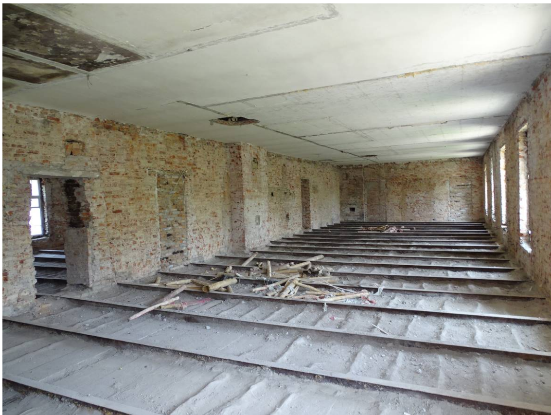
Фото 12. Секция 1. Помещение 3-го этажа. Съемка 15.06.2023 г. Трушковский В.Э.
