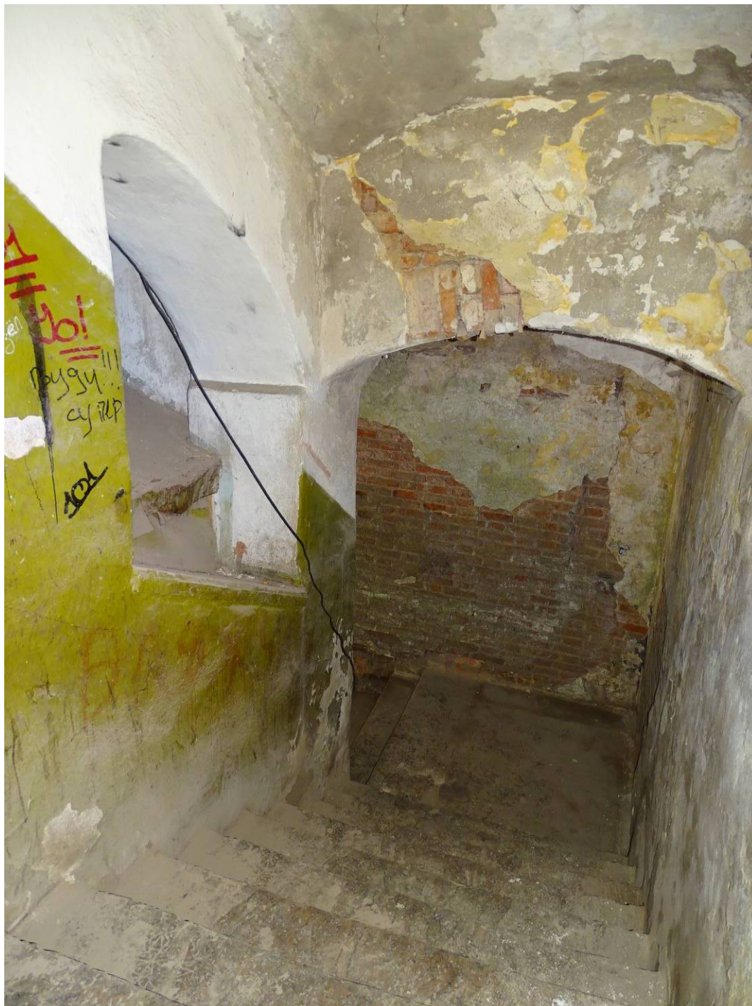
Фото 05. Секция 1. Восточная лестница. Вид с междуэтажной площадки. Съемка 15.06.2023 г. Трушковский В.Э.
