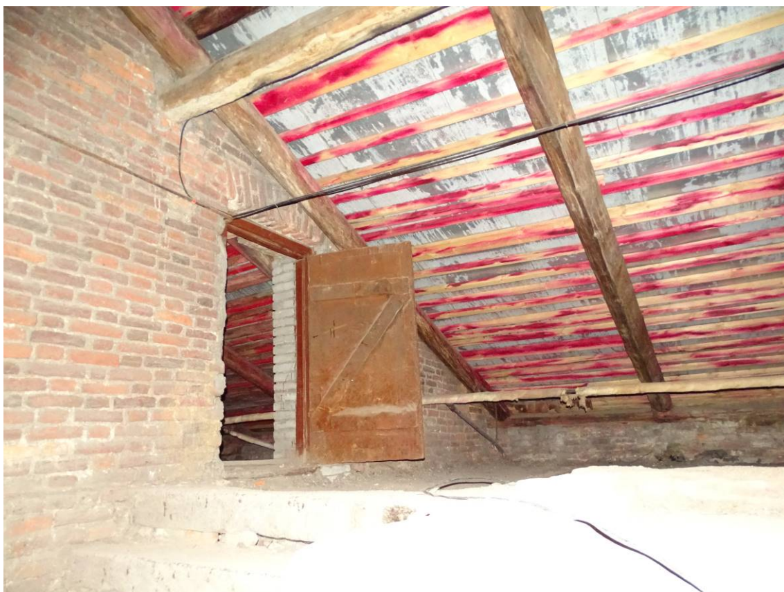
Фото 20. Секция 3. Чердачное помещение. Съемка 15.06.2023 г. Трушковский В.Э.
