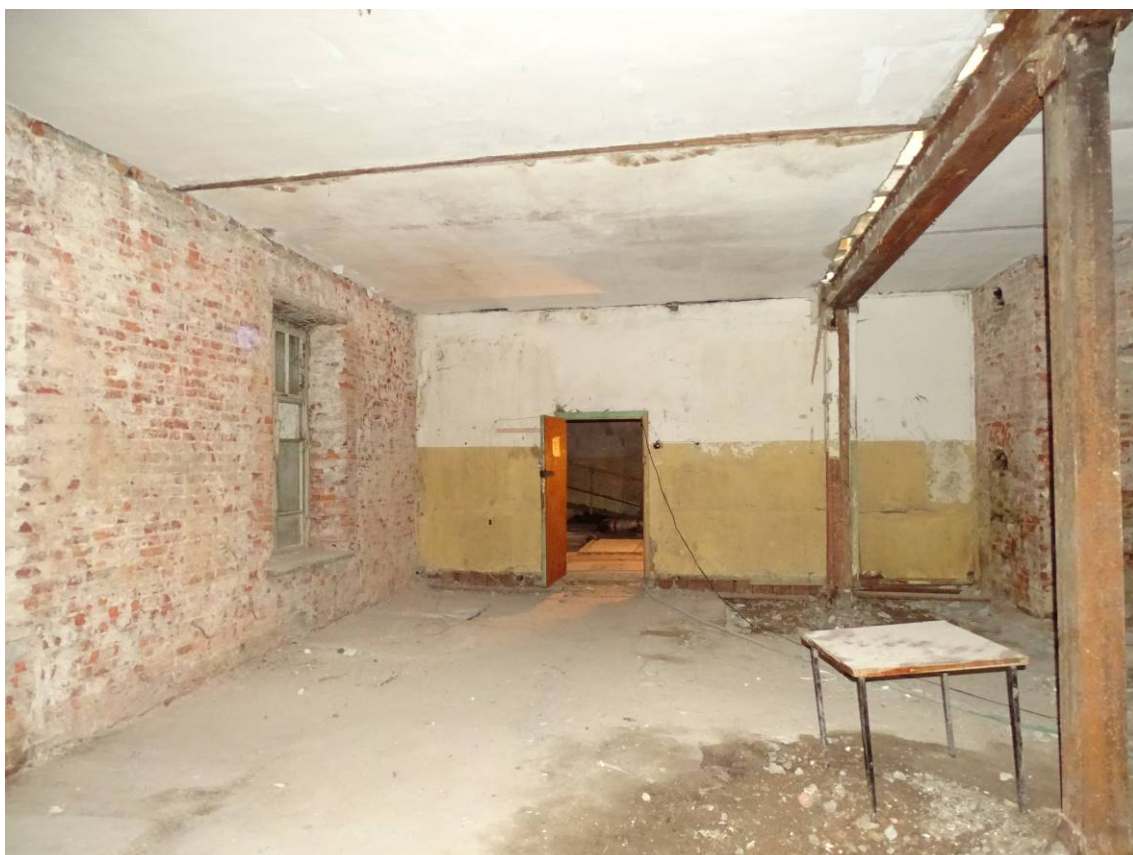
Фото 03. Секция 2. Помещение 1-го этажа. Съемка 15.06.2023 г. Трушковский В.Э.
