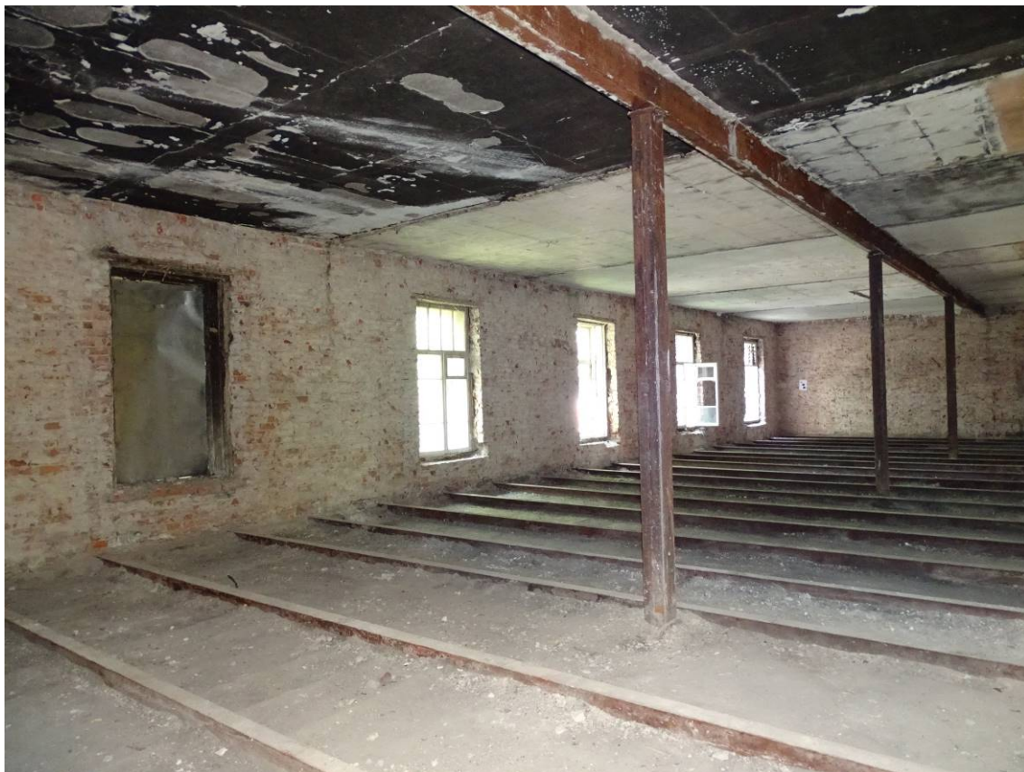
Фото 18. Секция 4. Помещение 3-го этажа. Съемка 15.06.2023 г. Трушковский В.Э.
