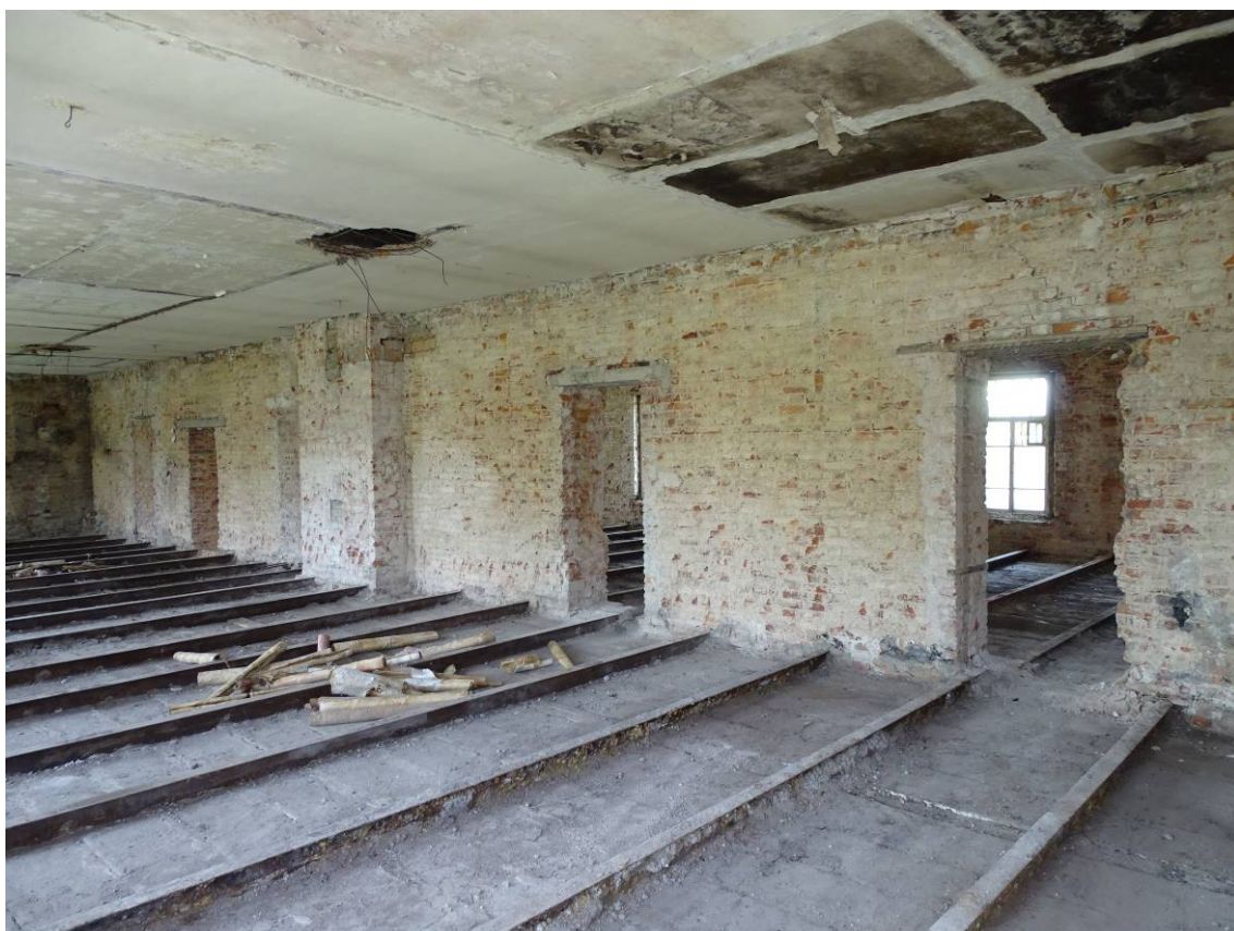
Фото 09. Секция 1. Помещение 2-го этажа. Съемка 15.06.2023 г. Трушковский В.Э.
