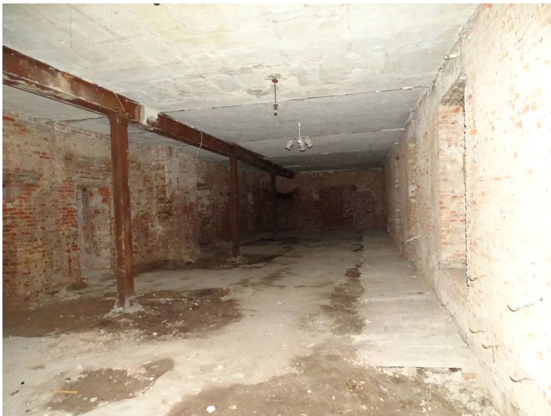
Фото 05. Секция 2. Помещение 1-го этажа. Съемка 15.06.2023 г. Трушковский В.Э.
