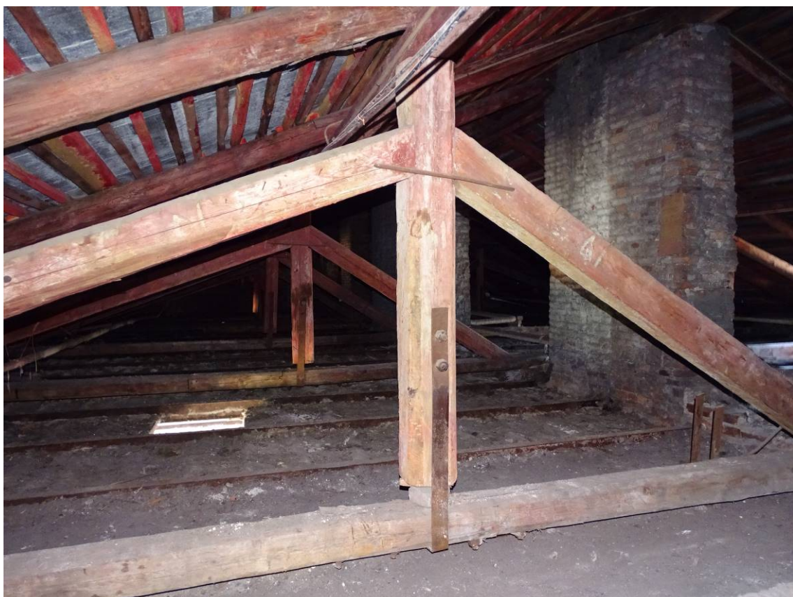
Фото 22. Секция 3. Чердачное помещение. Съемка 15.06.2023 г. Трушковский В.Э.
