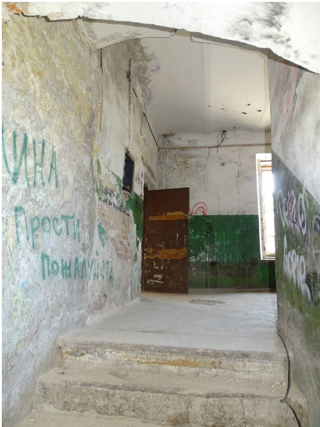
Фото 07. Секция 2. 2-й этаж. Восточная лестница. Съемка 15.06.2023 г. Трушковский В.Э.
