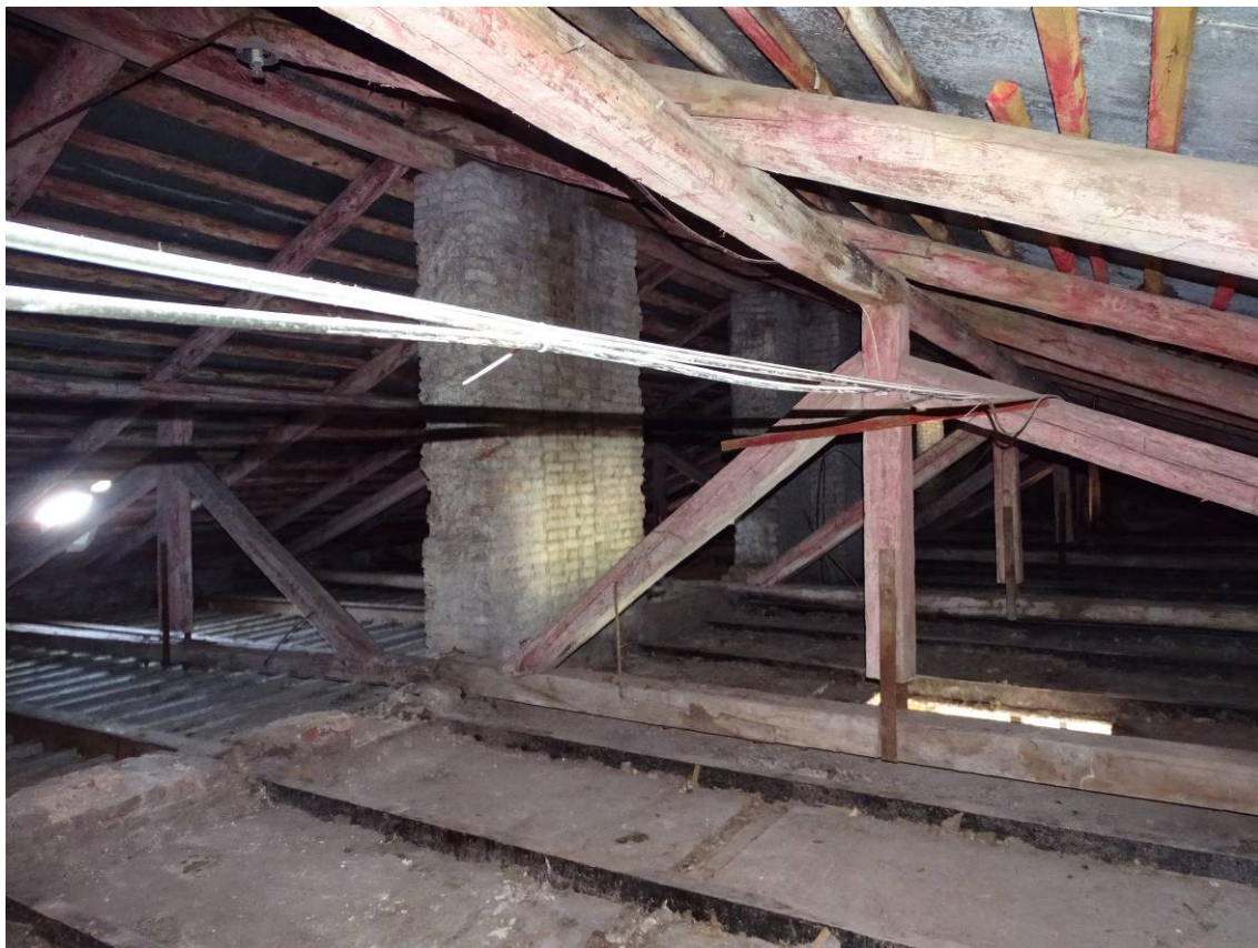
Фото 24. Секция 2. Чердачное помещение. Съемка 15.06.2023 г. Трушковский В.Э.
