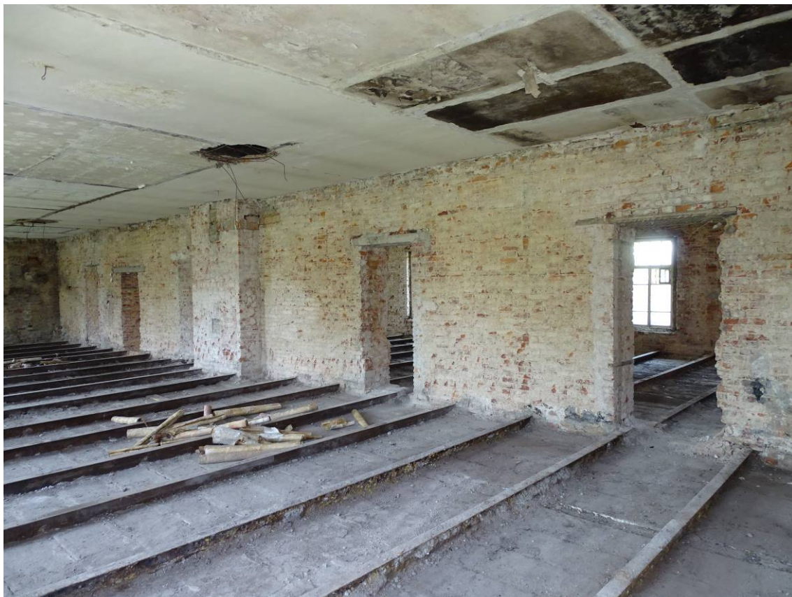
Фото 13. Секция 1. Помещение 3-го этажа. Съемка 15.06.2023 г. Трушковский В.Э.
