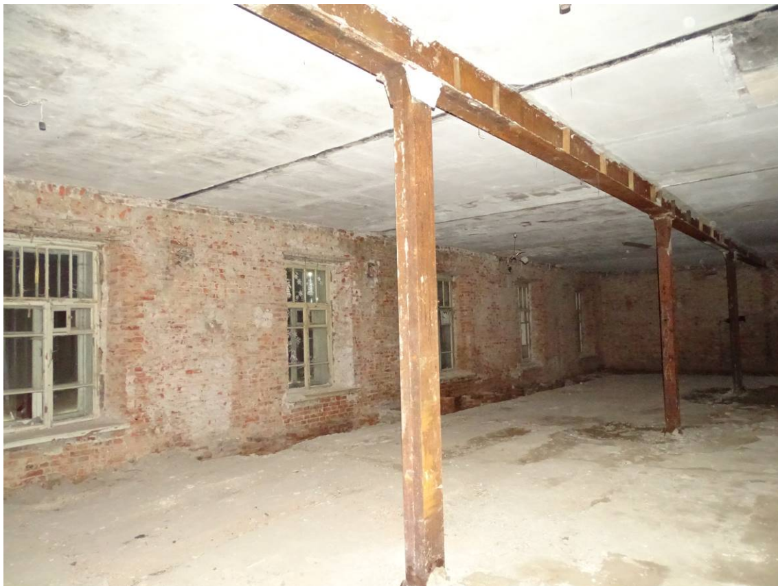
Фото 03. Секция 4. Помещение 1-го этажа. Съемка 15.06.2023 г. Трушковский В.Э.
