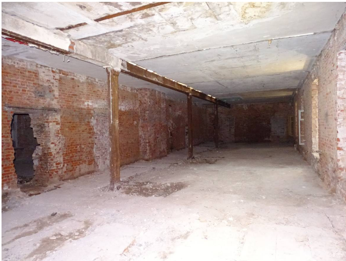
Фото 03. Секция 1. Помещение 1-го этажа. Съемка 15.06.2023 г. Трушковский В.Э.
