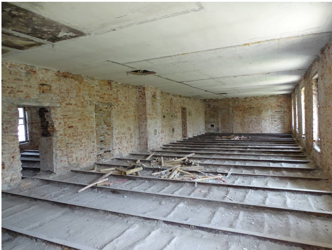
Фото 08. Секция 1. Помещение 2-го этажа. Съемка 15.06.2023 г. Трушковский В.Э.
