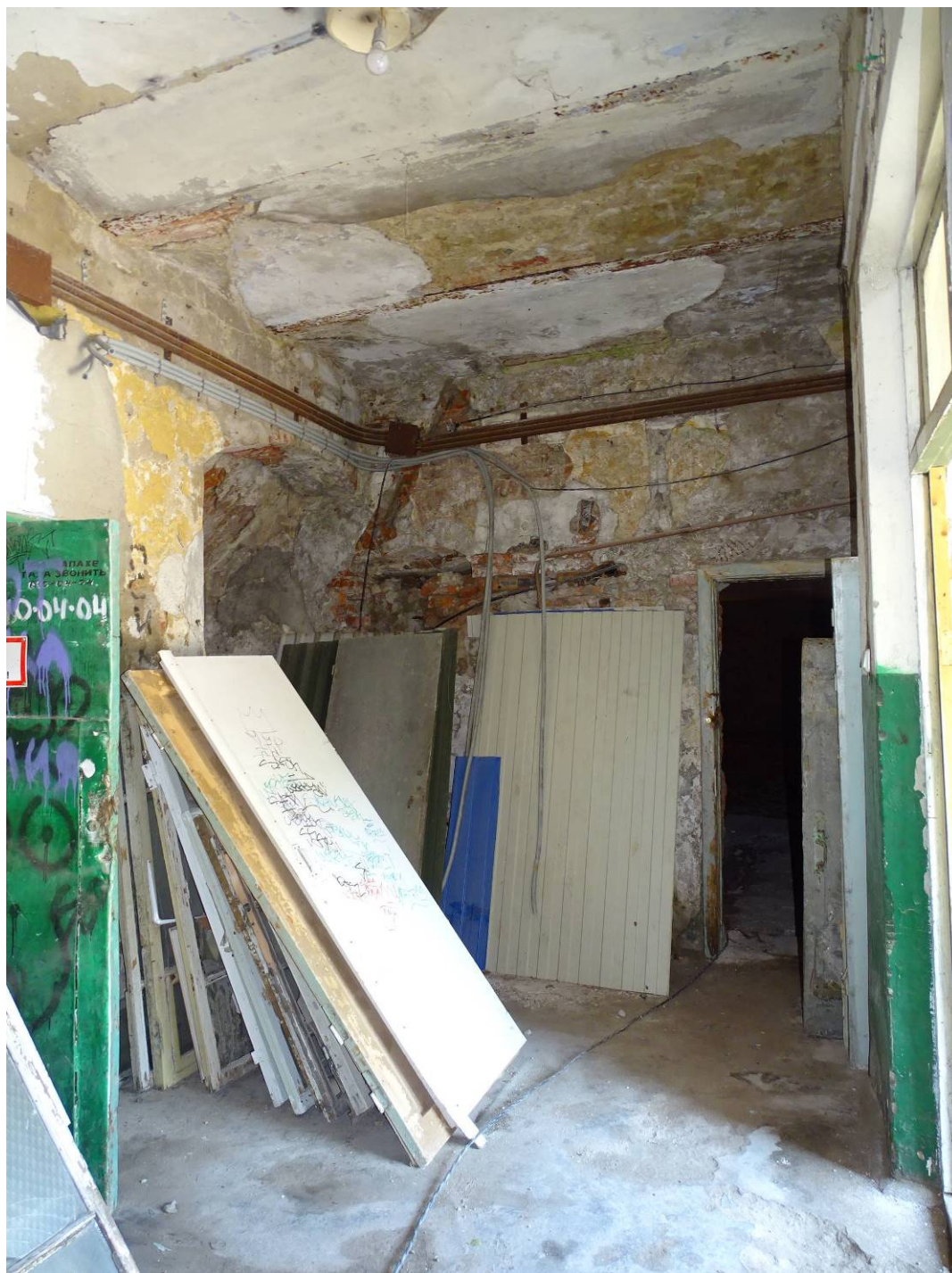
Фото 01. Секция 3. 1-й этаж. Восточный вестибюль. Съемка 15.06.2023 г. Трушковский В.Э.
