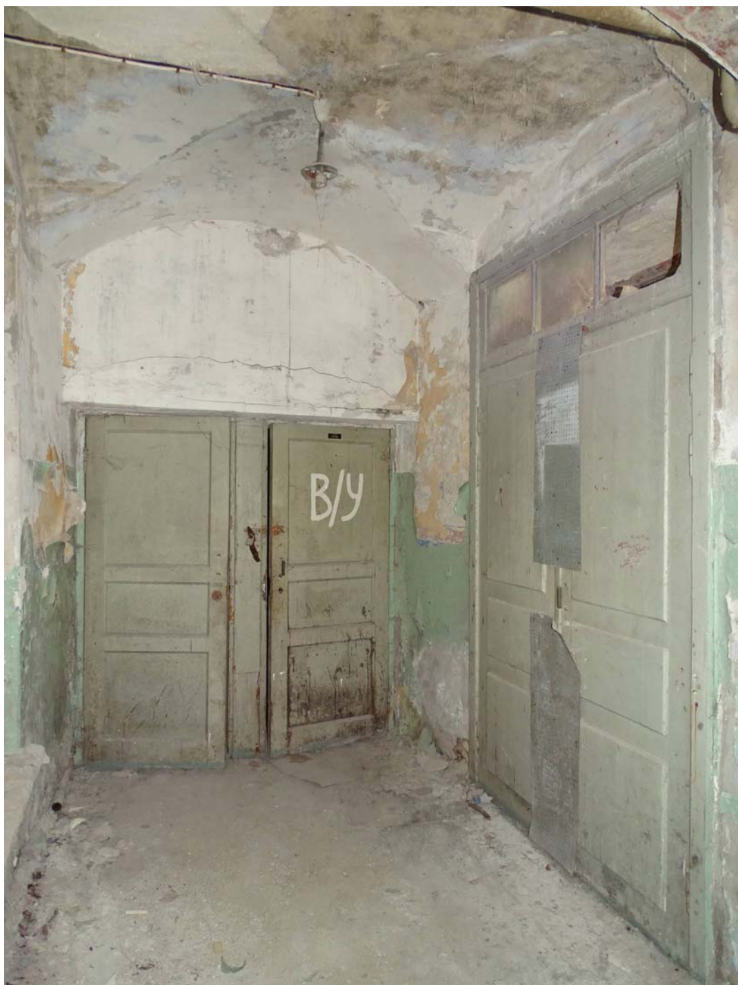
Фото 07. Секция 4. 1-й этаж. Коридор. Съемка 15.06.2023 г. Трушковский В.Э.
