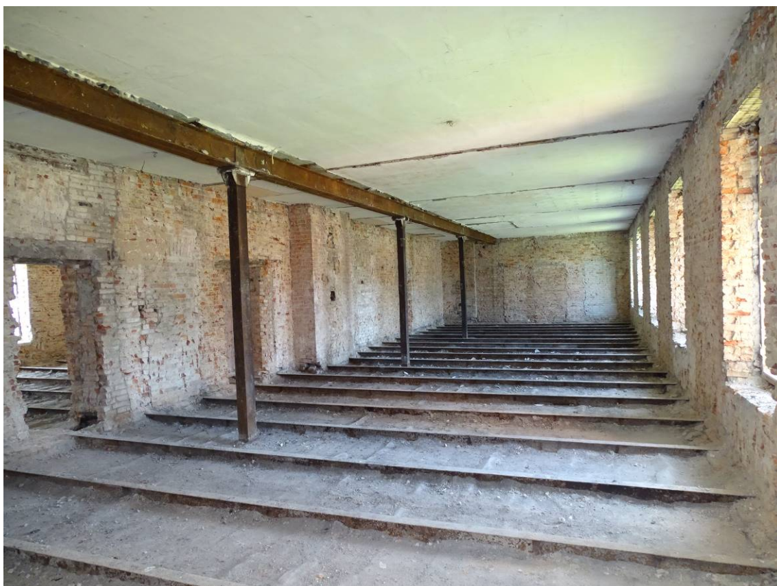
Фото 12. Секция 3. Помещение 2-го этажа. Съемка 15.06.2023 г. Трушковский В.Э.
