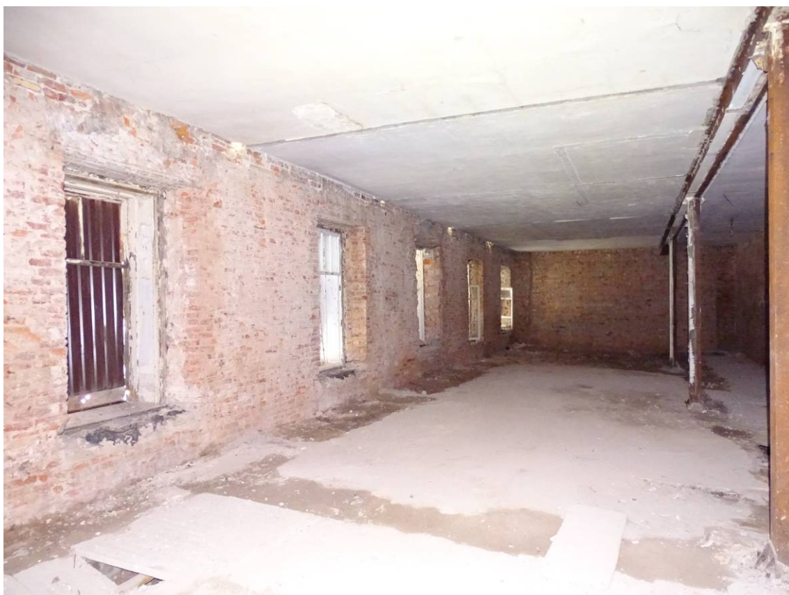
Фото 04. Секция 4. Помещение 1-го этажа. Съемка 15.06.2023 г. Трушковский В.Э.
