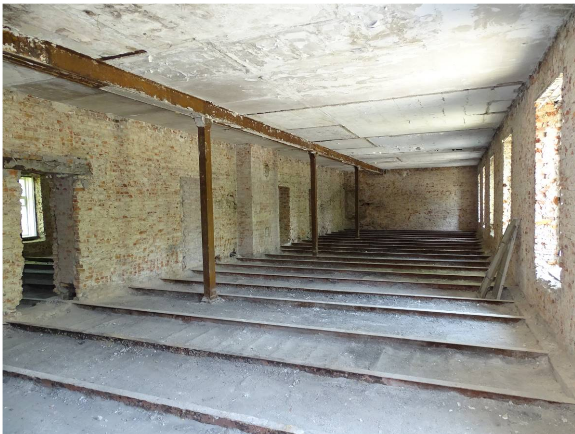
Фото 13. Секция 4. Помещение 2-го этажа. Съемка 15.06.2023 г. Трушковский В.Э.
