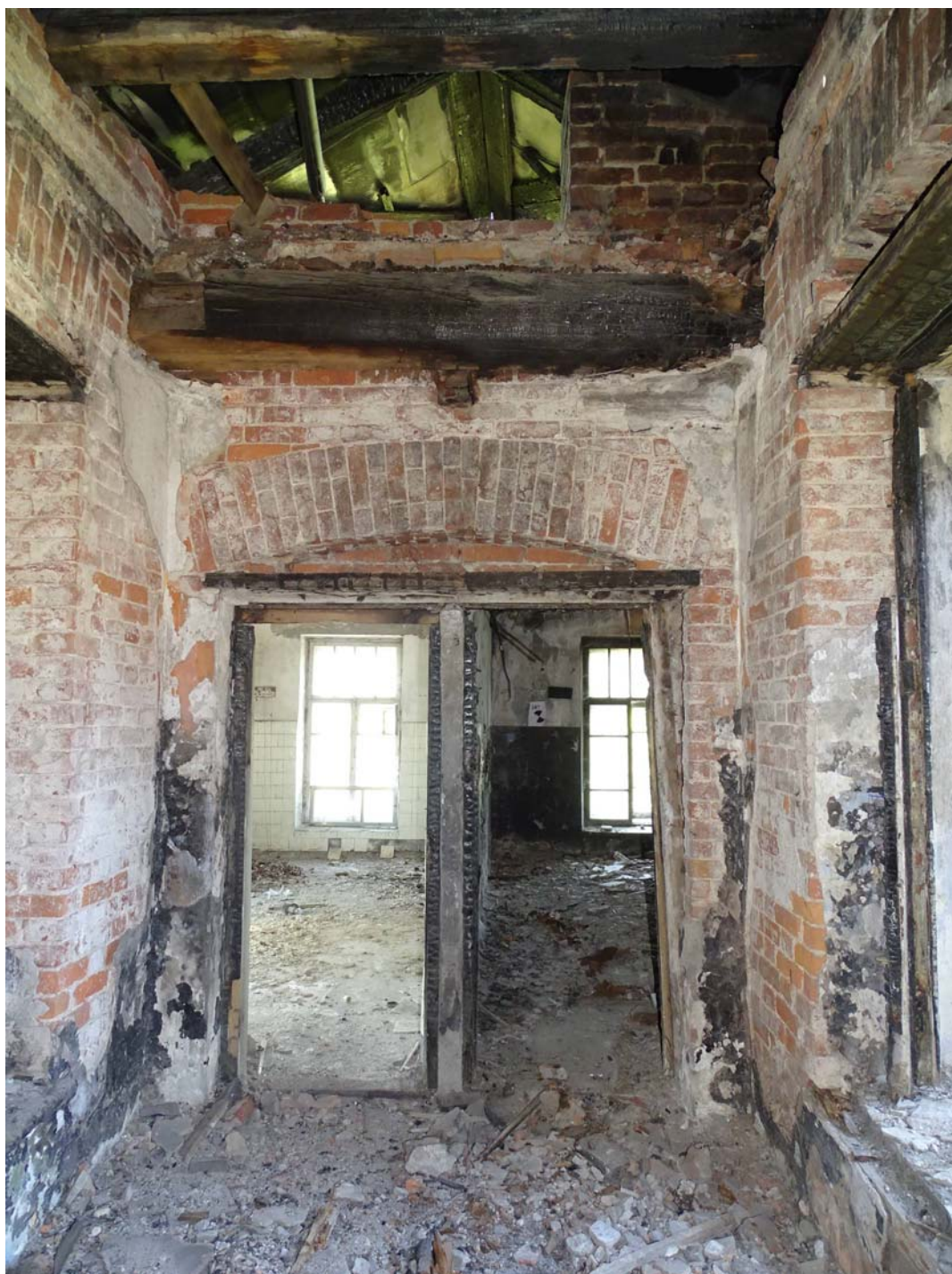
Фото 22. Секция 4. Коридор, вход в ризалит. Съемка 15.06.2023 г. Трушковский В.Э.
