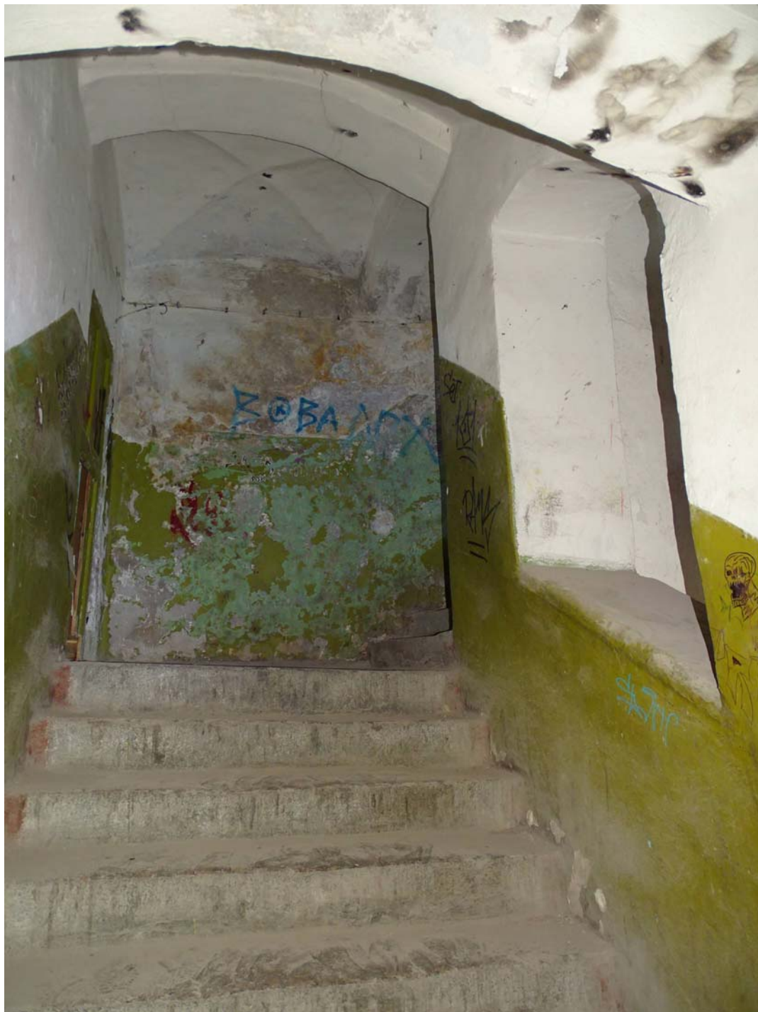
Фото 10. Секция 1. Восточная лестница. Вид с междуэтажной площадки. Съемка 15.06.2023 г. Трушковский В.Э.
