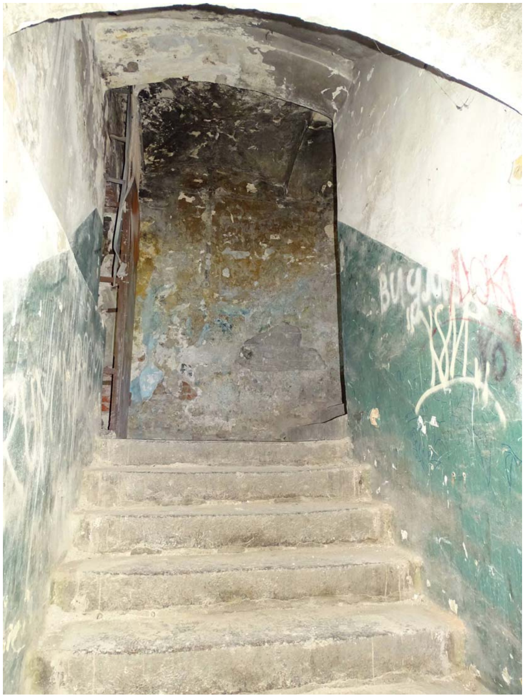
Фото 11. Секция 4. 1-й этаж. Восточная лестница. Съемка 15.06.2023 г. Трушковский В.Э.
