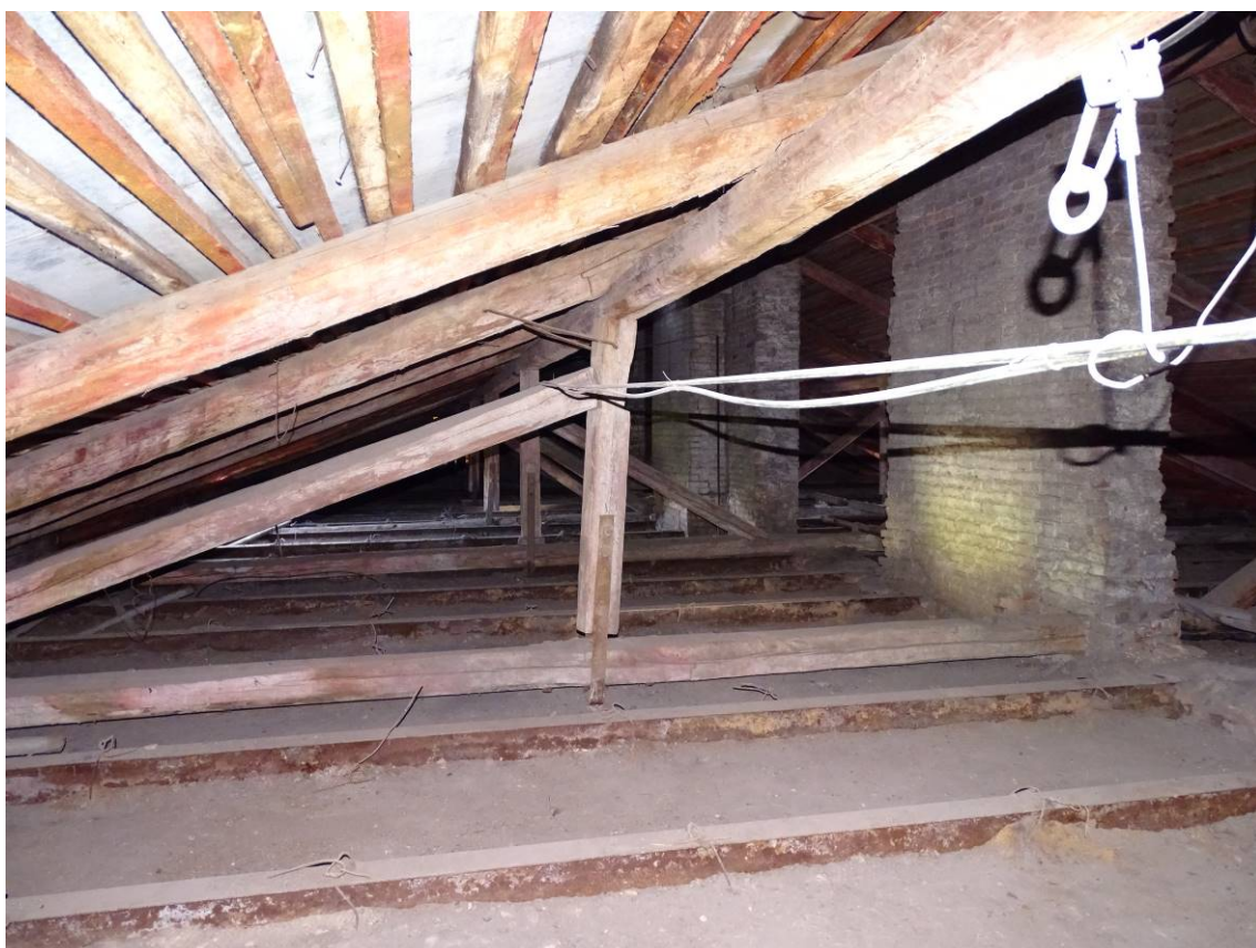
Фото 25. Секция 2. Чердачное помещение. Съемка 15.06.2023 г. Трушковский В.Э.
