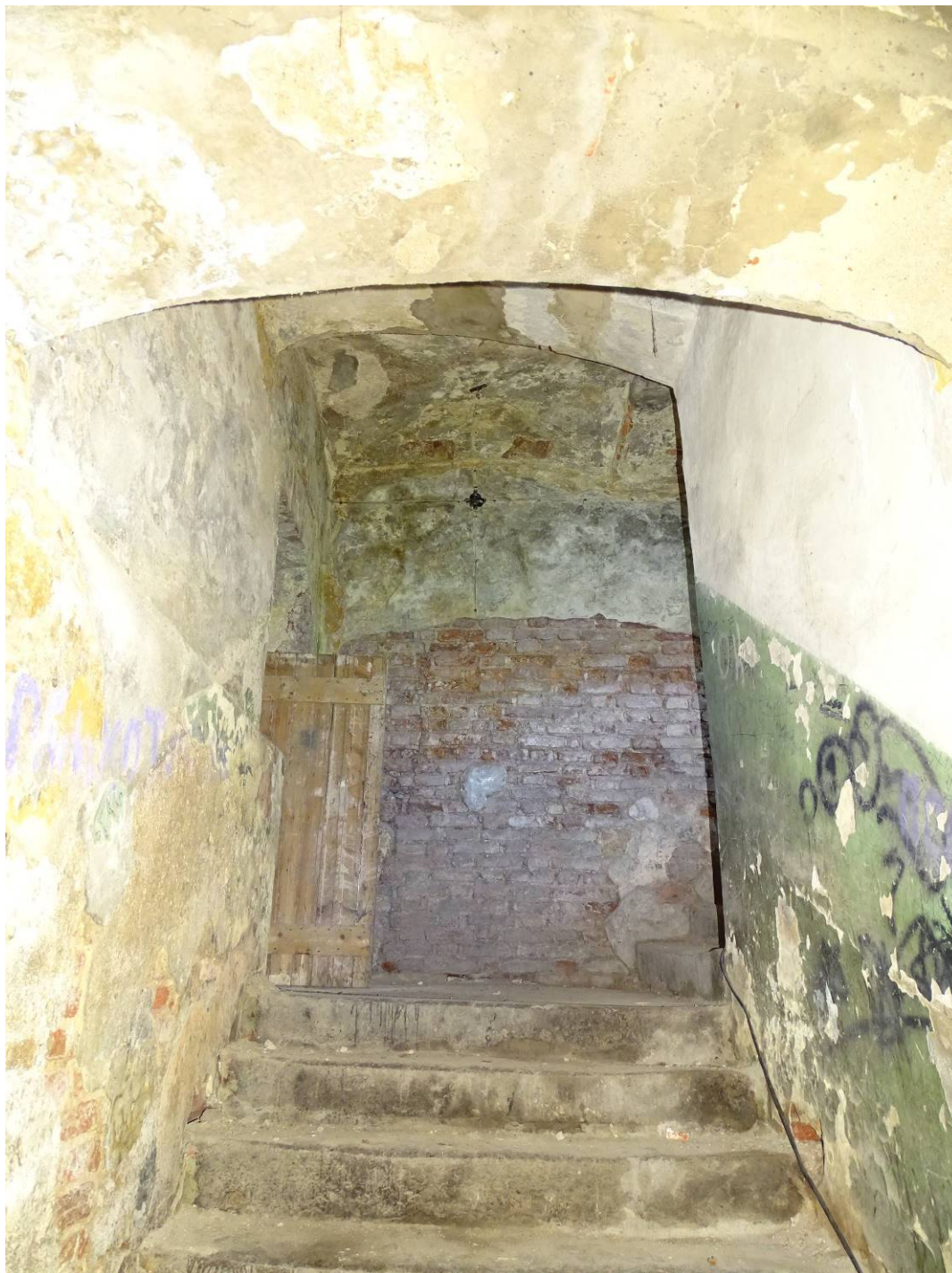
Фото 08. Секция 3. 1-й этаж. Восточная лестница. Съемка 15.06.2023 г. Трушковский В.Э.
