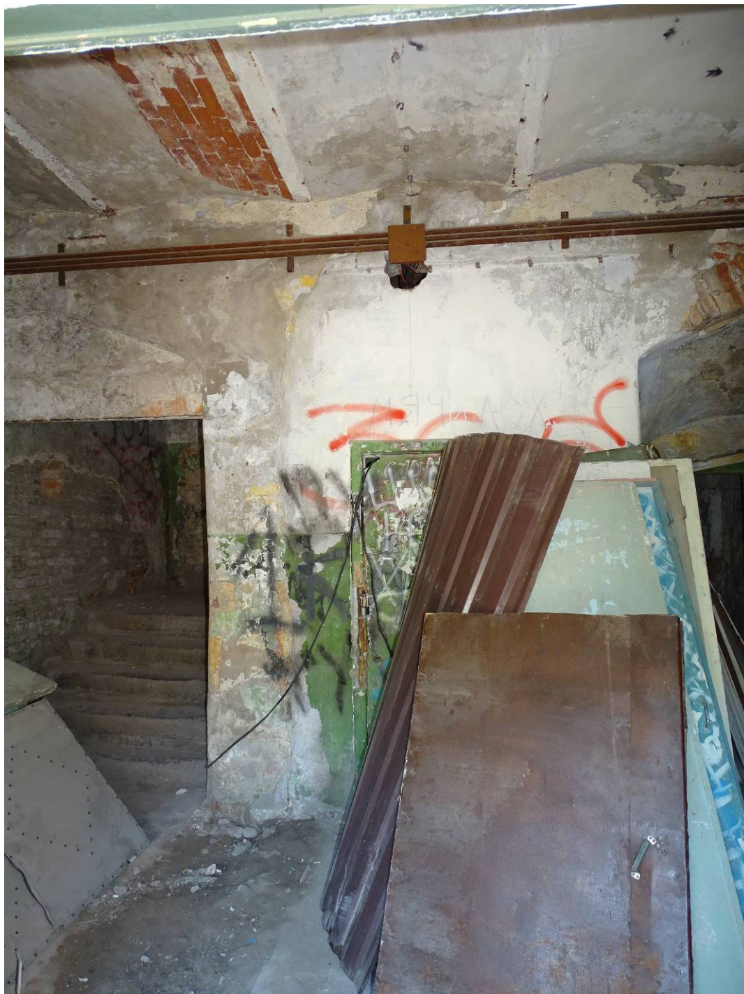
Фото 01. Секция 2. 1-й этаж. Восточный вестибюль. Съемка 15.06.2023 г. Трушковский В.Э.
