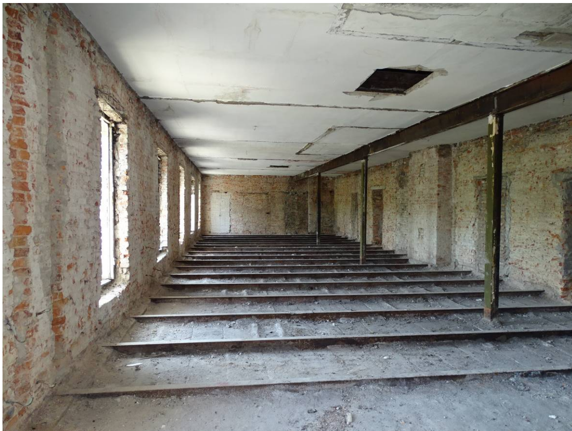
Фото 19. Секция 3. Помещение 3-го этажа. Съемка 15.06.2023 г. Трушковский В.Э.
