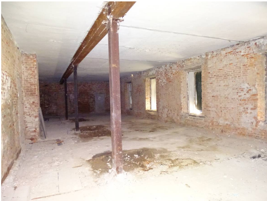
Фото 02. Секция 2. Помещение 1-го этажа. Съемка 15.06.2023 г. Трушковский В.Э.
