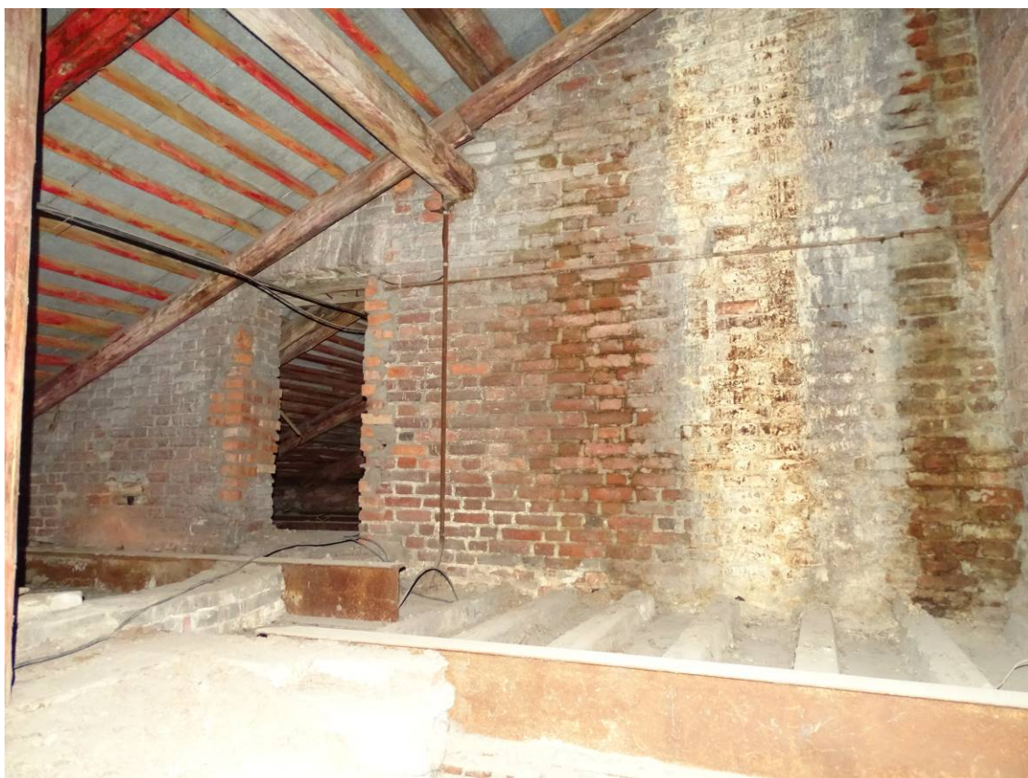
Фото 23. Секция 2. Чердачное помещение. Съемка 15.06.2023 г. Трушковский В.Э.
