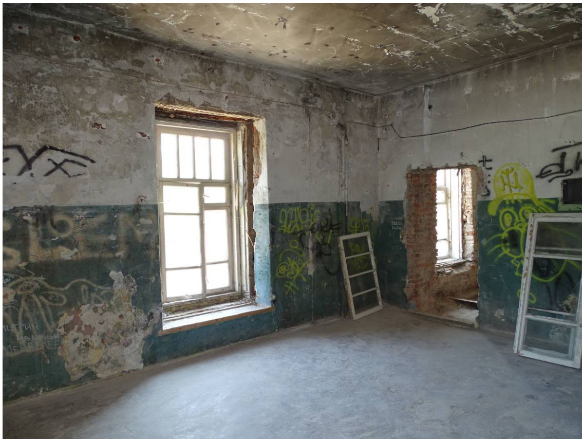
Фото 16. Секция 4. 3-й этаж. Холл восточной лестницы. Съемка 15.06.2023 г. Трушковский В.Э.
