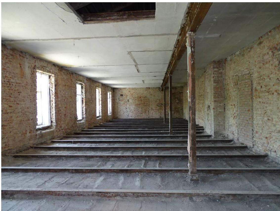
Фото 19. Секция 4. Помещение 3-го этажа. Съемка 15.06.2023 г. Трушковский В.Э.
