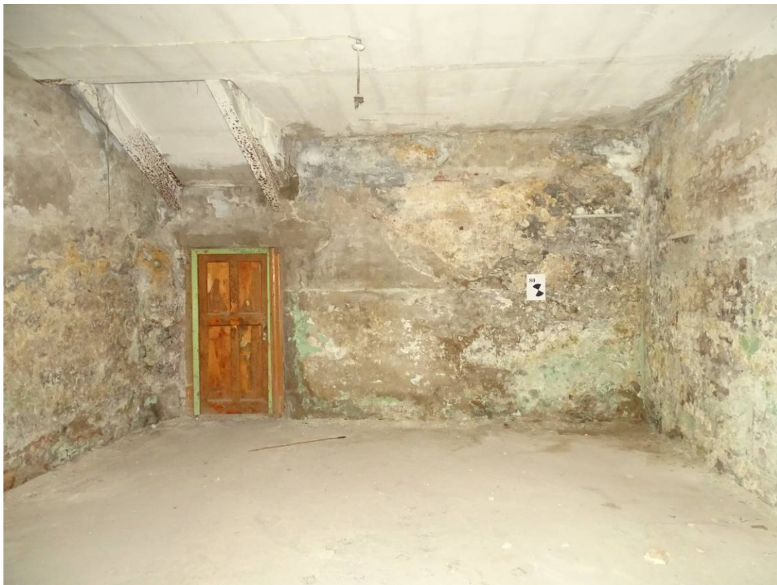
Фото 04. Секция 2. 1-й этаж. Вестибюль западной лестницы. Съемка 15.06.2023 г. Трушковский В.Э.
