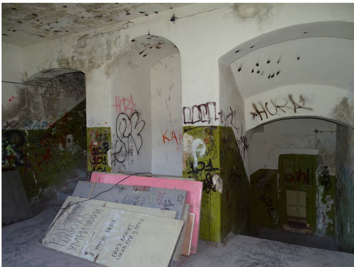
Фото 07. Секция 1. Вестибюль 2-го этажа. Съемка 15.06.2023 г. Трушковский В.Э.
