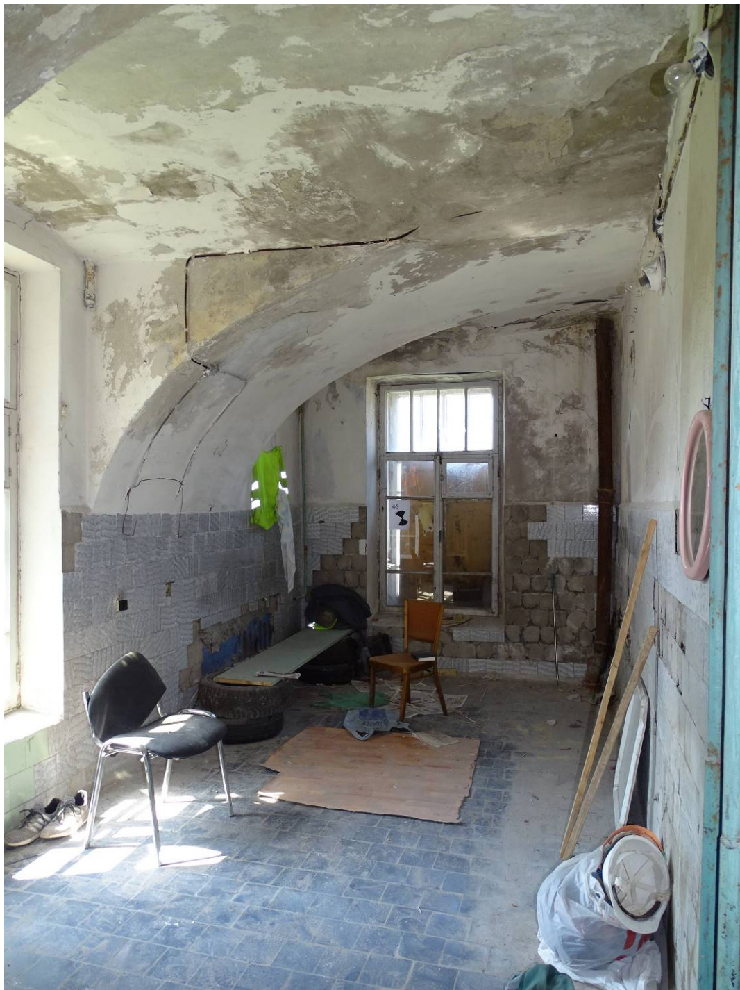
Фото 13. Секция 3. Помещение ризалита 2-го этажа. Съемка 15.06.2023 г. Трушковский В.Э.
