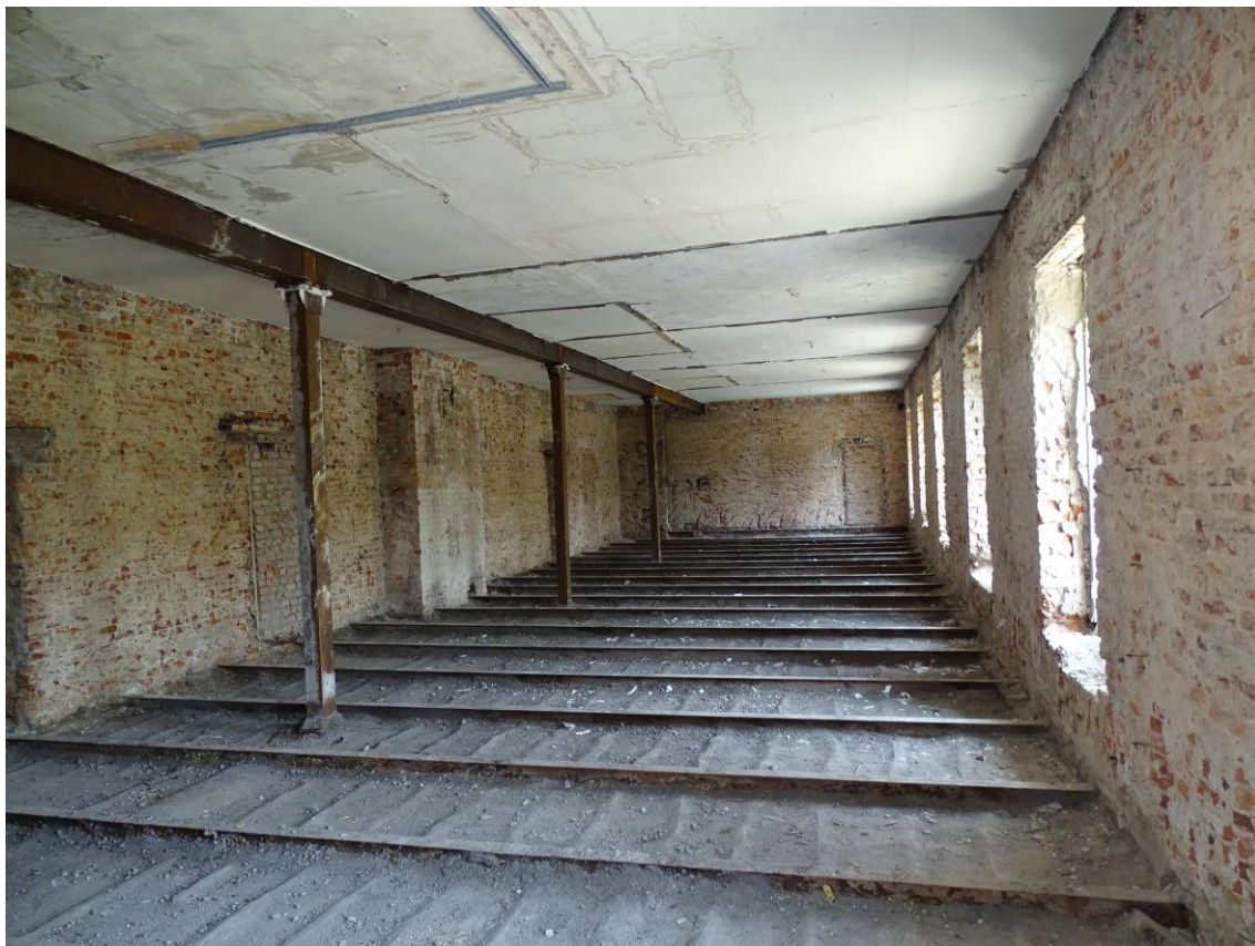
Фото 14. Секция 3. Помещение 2-го этажа. Съемка 15.06.2023 г. Трушковский В.Э.
