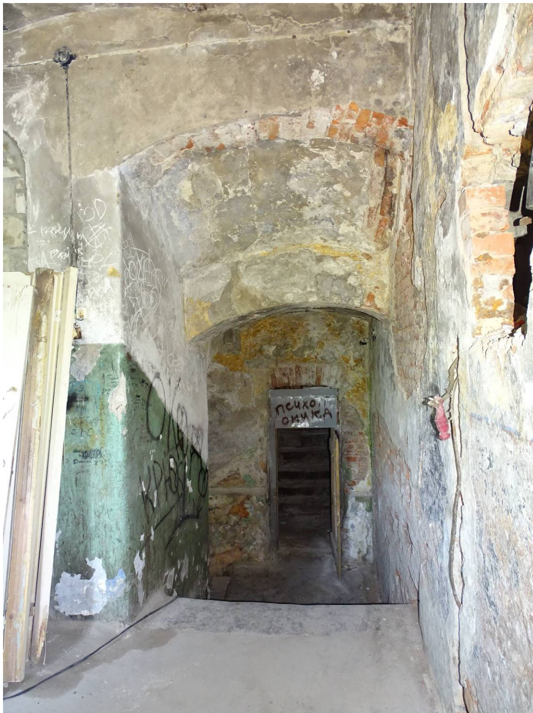
Фото 16. Секция 3. 2-й этаж. Восточная лестница. Съемка 15.06.2023 г. Трушковский В.Э.
