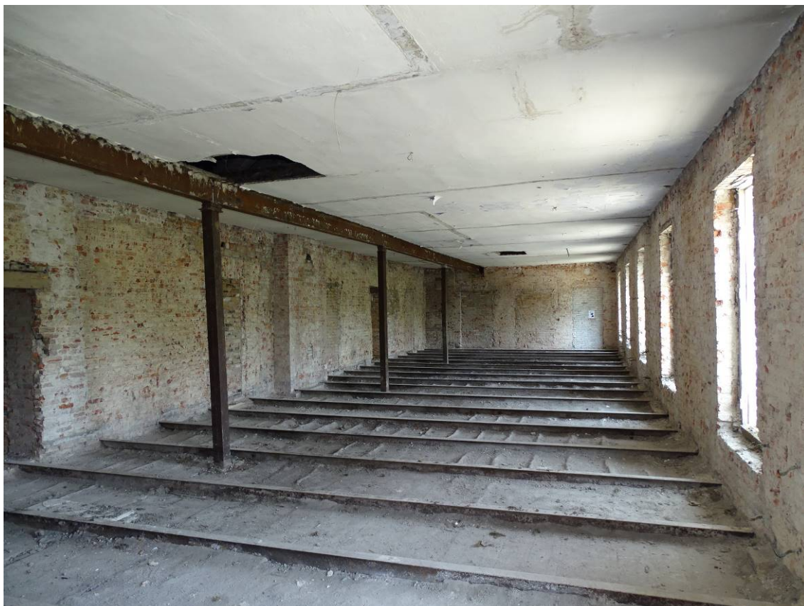
Фото 21. Секция 2. Помещение 3-го этажа. Съемка 15.06.2023 г. Трушковский В.Э.
