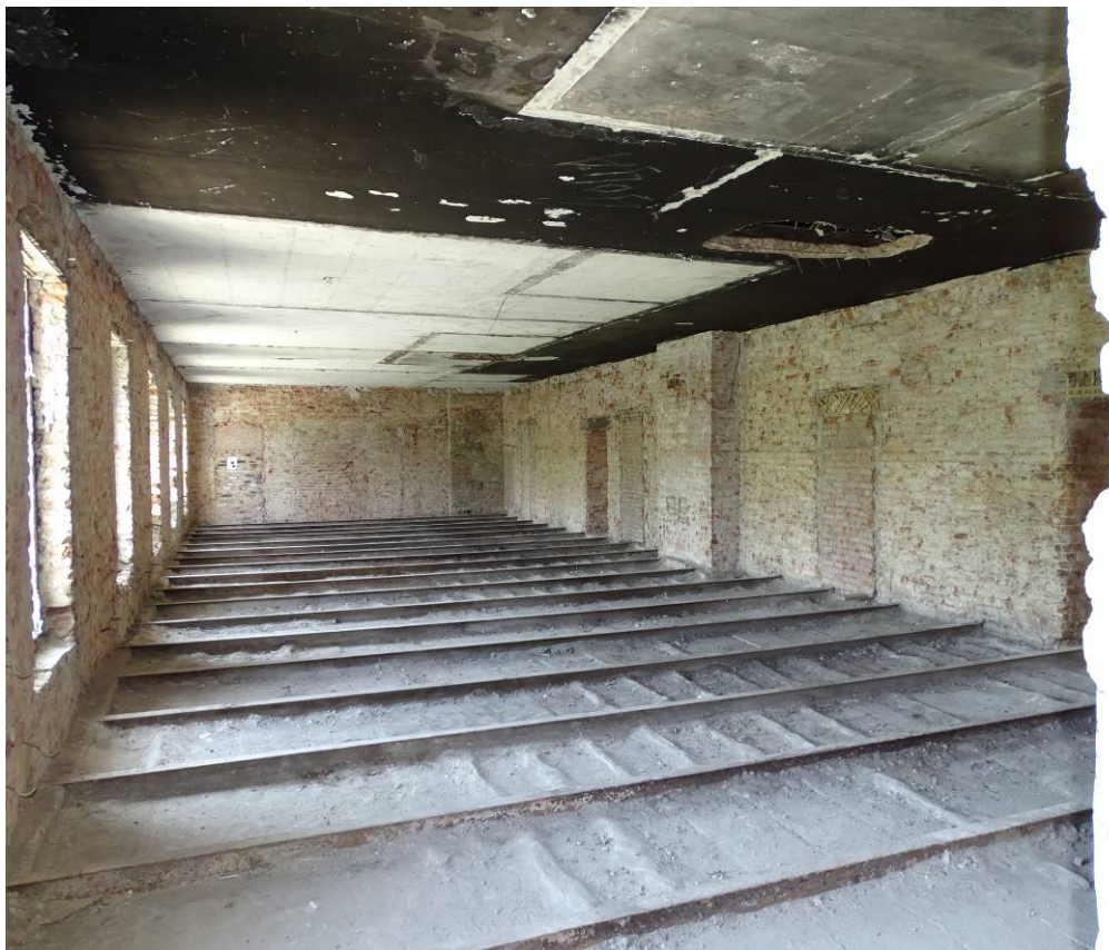
Фото 22. Секция 2. Помещение 3-го этажа. Съемка 15.06.2023 г. Трушковский В.Э.
