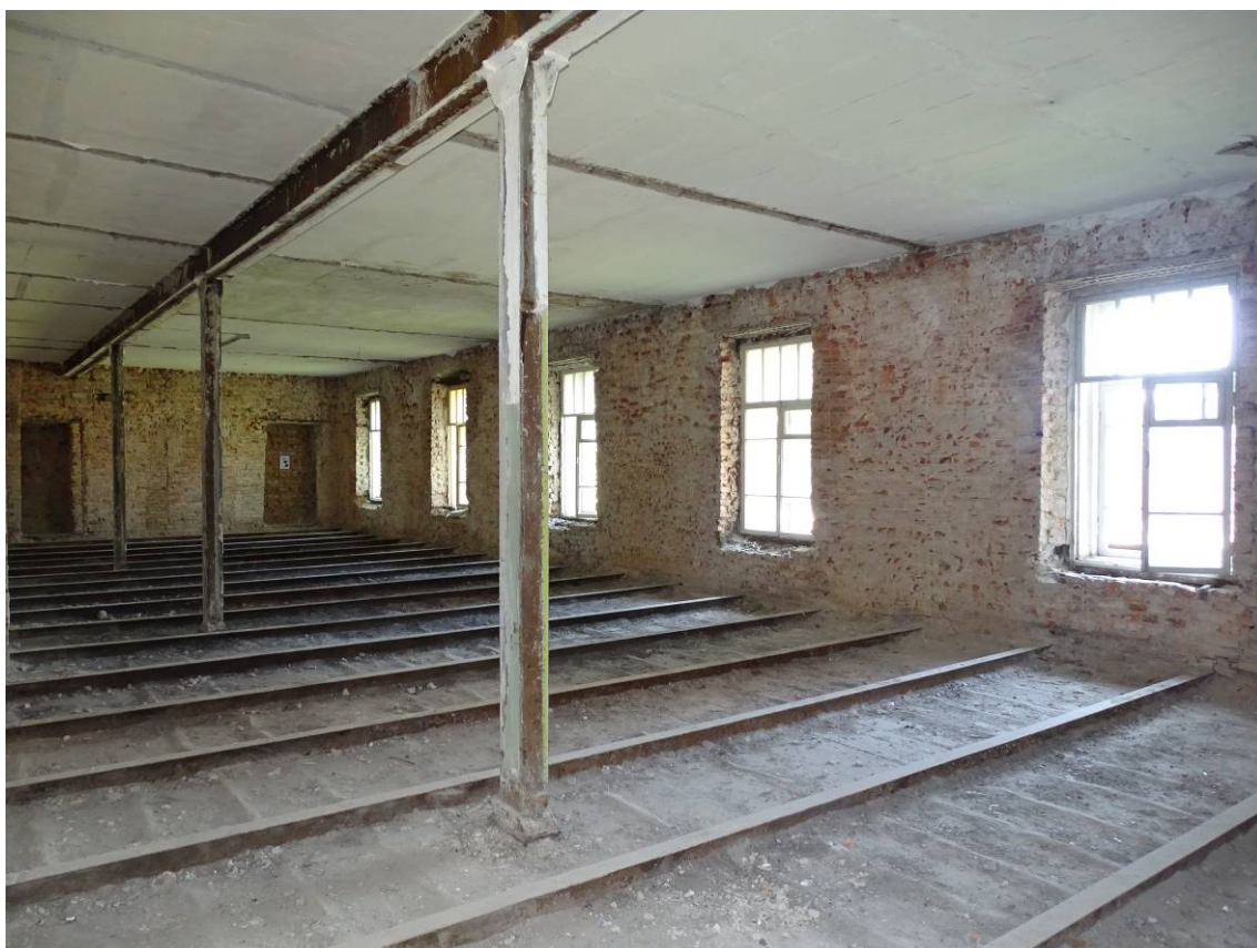
Фото 15. Секция 4. Помещение 2-го этажа. Съемка 15.06.2023 г. Трушковский В.Э.
