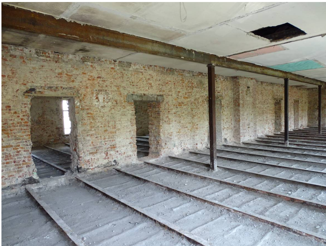
Фото 18. Секция 3. Помещение 3-го этажа. Съемка 15.06.2023 г. Трушковский В.Э.
