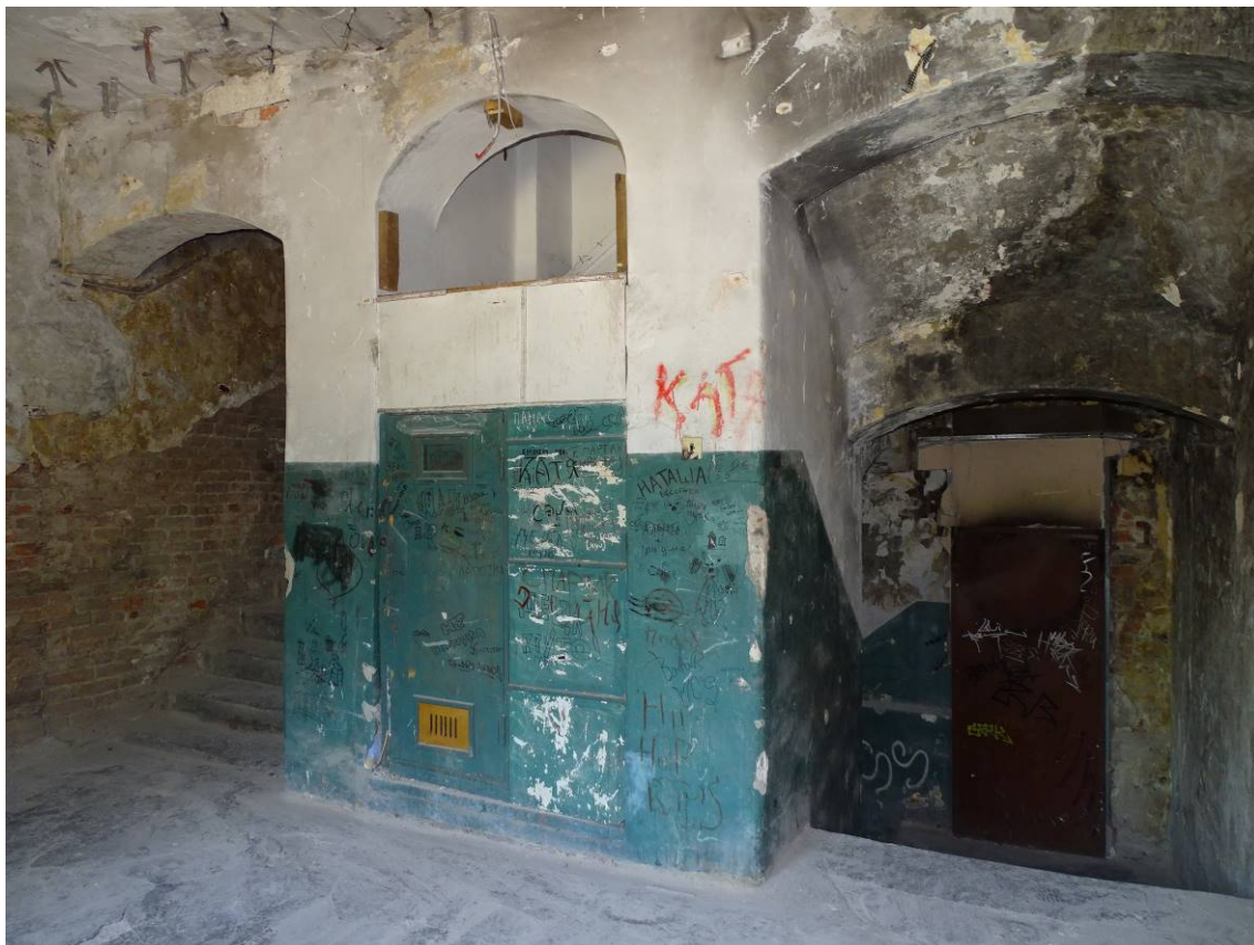
Фото 12. Секция 4. 2-й этаж. Холл восточной лестницы. Съемка 15.06.2023 г. Трушковский В.Э.
