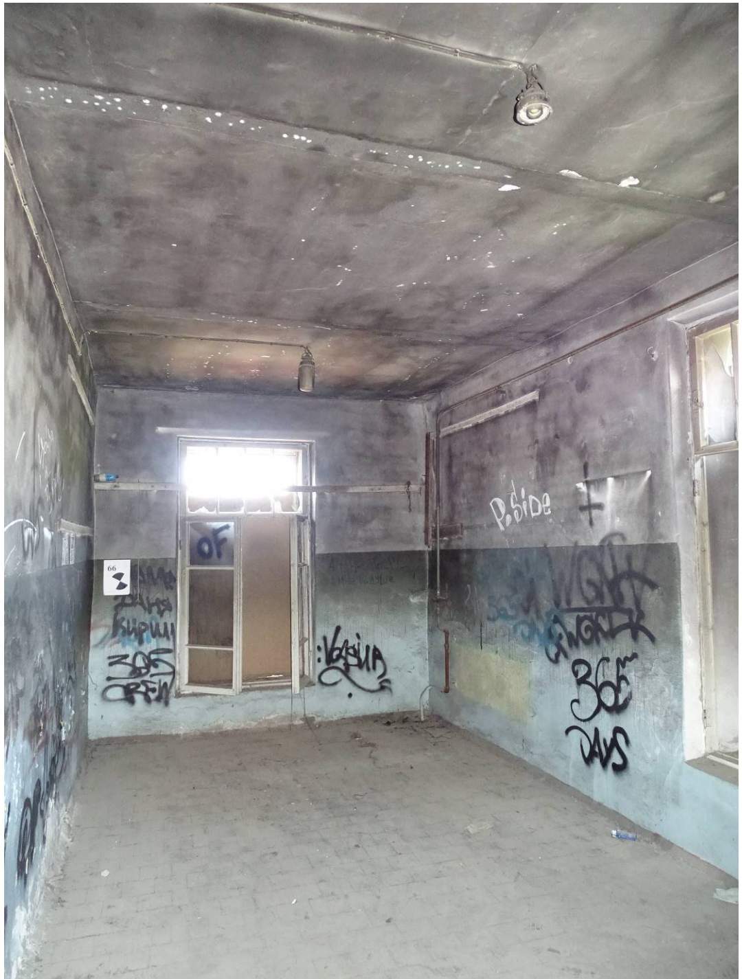
Фото 18. Секция 2. 3-й этаж. Помещение ризалита. Съемка 15.06.2023 г. Трушковский В.Э.
