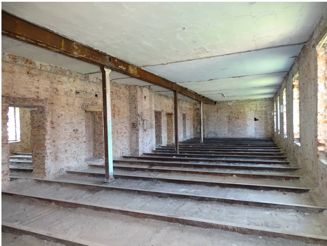
Фото 12. Секция 2. Помещение 2-го этажа. Съемка 15.06.2023 г. Трушковский В.Э.
