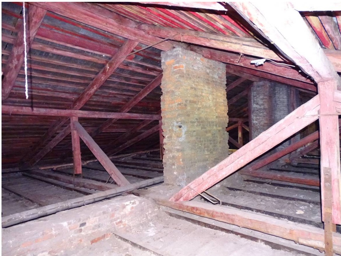
Фото 21. Секция 3. Чердачное помещение. Съемка 15.06.2023 г. Трушковский В.Э.
