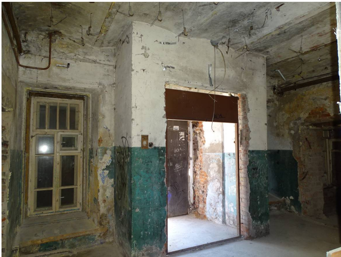
Фото 01. Секция 4. 1-й этаж. Восточный вестибюль. Съемка 15.06.2023 г. Трушковский В.Э.
