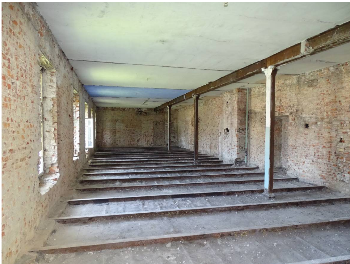
Фото 11. Секция 3. Помещение 2-го этажа. Съемка 15.06.2023 г. Трушковский В.Э.
