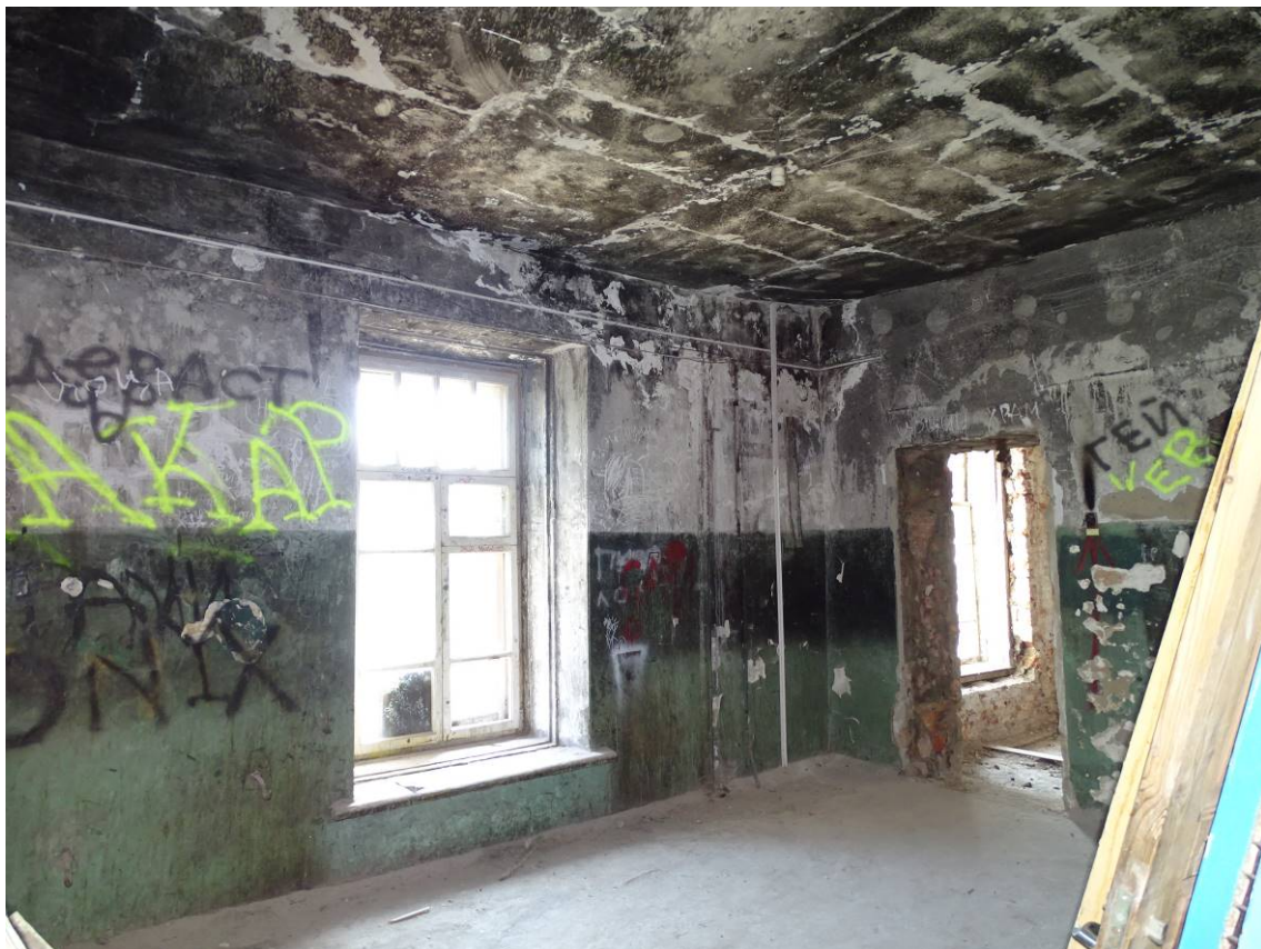
Фото 17. Секция 3. Холл 3-го этажа восточной лестницы. Съемка 15.06.2023 г. Трушковский В.Э.
