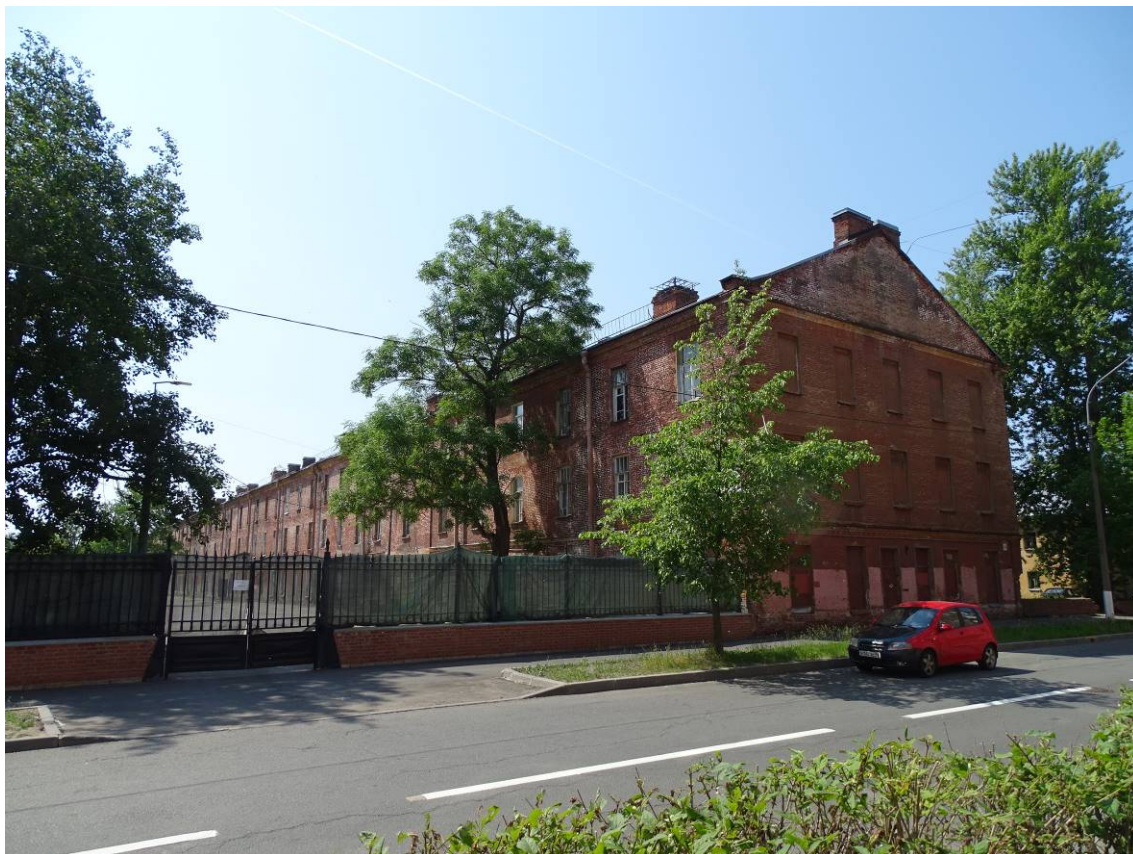
Фото 09. Служительский флигель. Вид с северной стороны. Съемка 15.06.2023 г. Трушковский В.Э.
