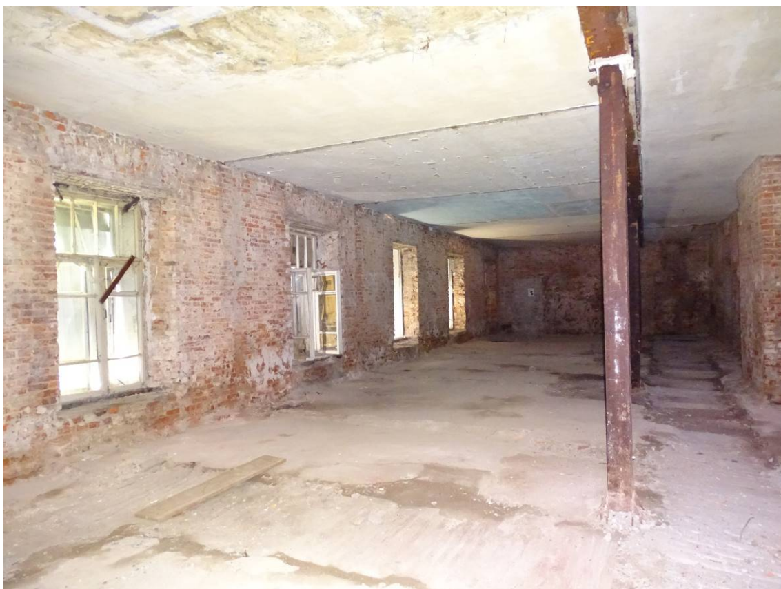
Фото 07. Секция 3. Помещение 1-го этажа. Съемка 15.06.2023 г. Трушковский В.Э.
