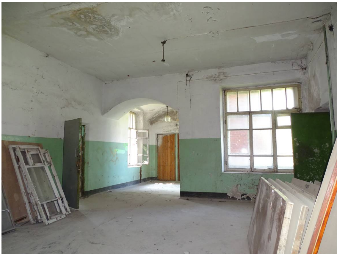
Фото 10. Секция 2. 2-й этаж. Вестибюль западной лестницы. Съемка 15.06.2023 г. Трушковский В.Э.
