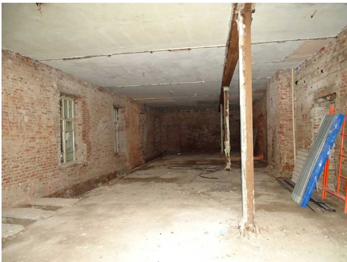
Фото 03. Секция 3. Помещение 1-го этажа. Съемка 15.06.2023 г. Трушковский В.Э.
