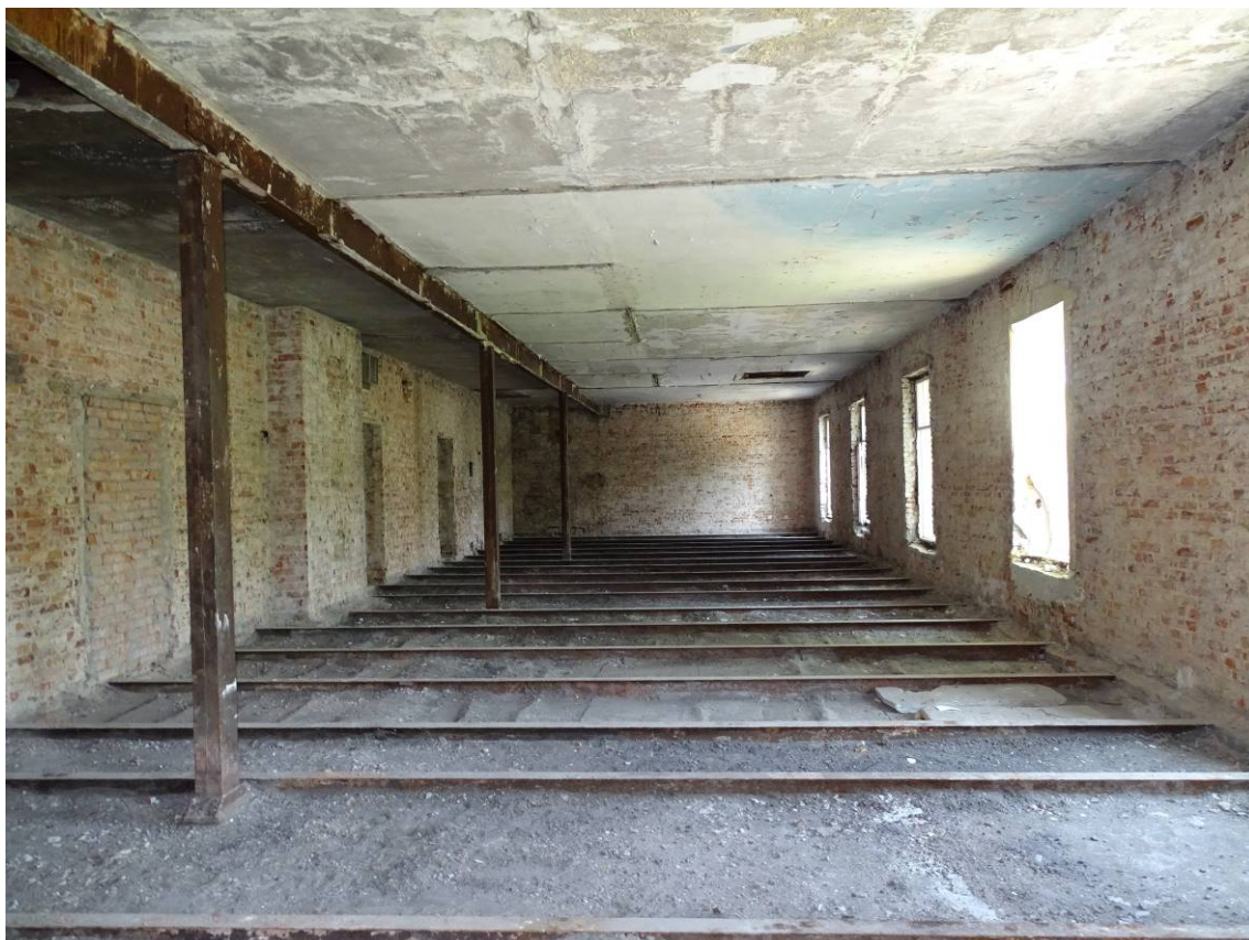
Фото 17. Секция 4. Помещение 3-го этажа. Съемка 15.06.2023 г. Трушковский В.Э.
