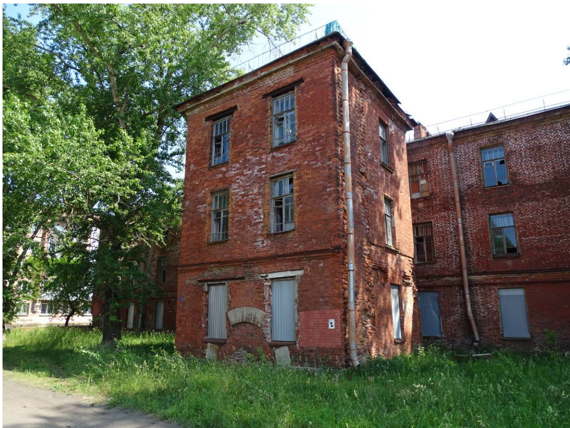
Фото 08. Служительский флигель. Северный ризалит западного фасада. Съемка 15.06.2023 г. Трушковский В.Э.
