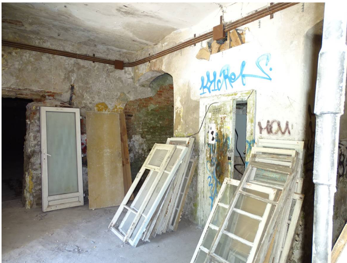
Фото 01. Секция 1. 1-й этаж. Восточный вестибюль. Съемка 15.06.2023 г. Трушковский В.Э.
