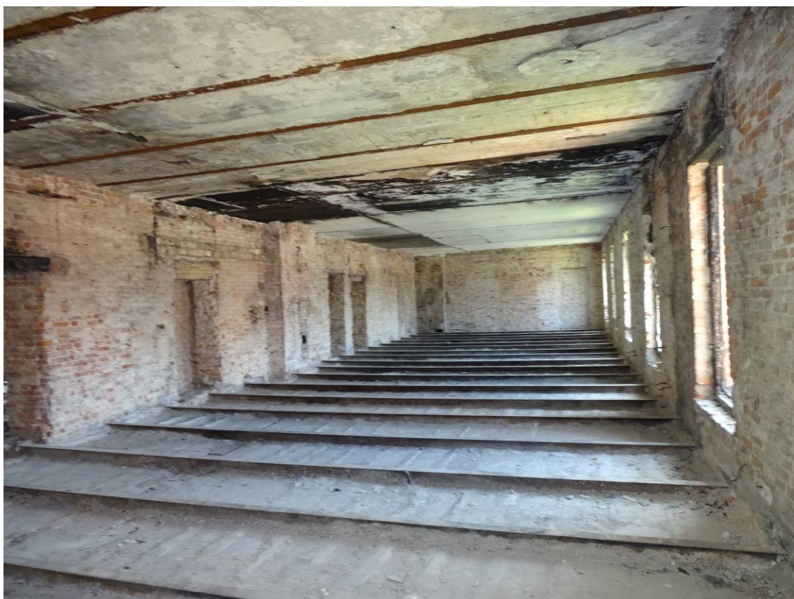
Фото 17. Секция 2. Помещение 3-го этажа. Съемка 15.06.2023 г. Трушковский В.Э.
