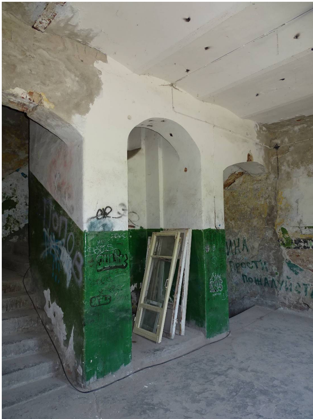
Фото 08. Секция 2. 2-й этаж. Восточная лестница. Съемка 15.06.2023 г. Трушковский В.Э.
