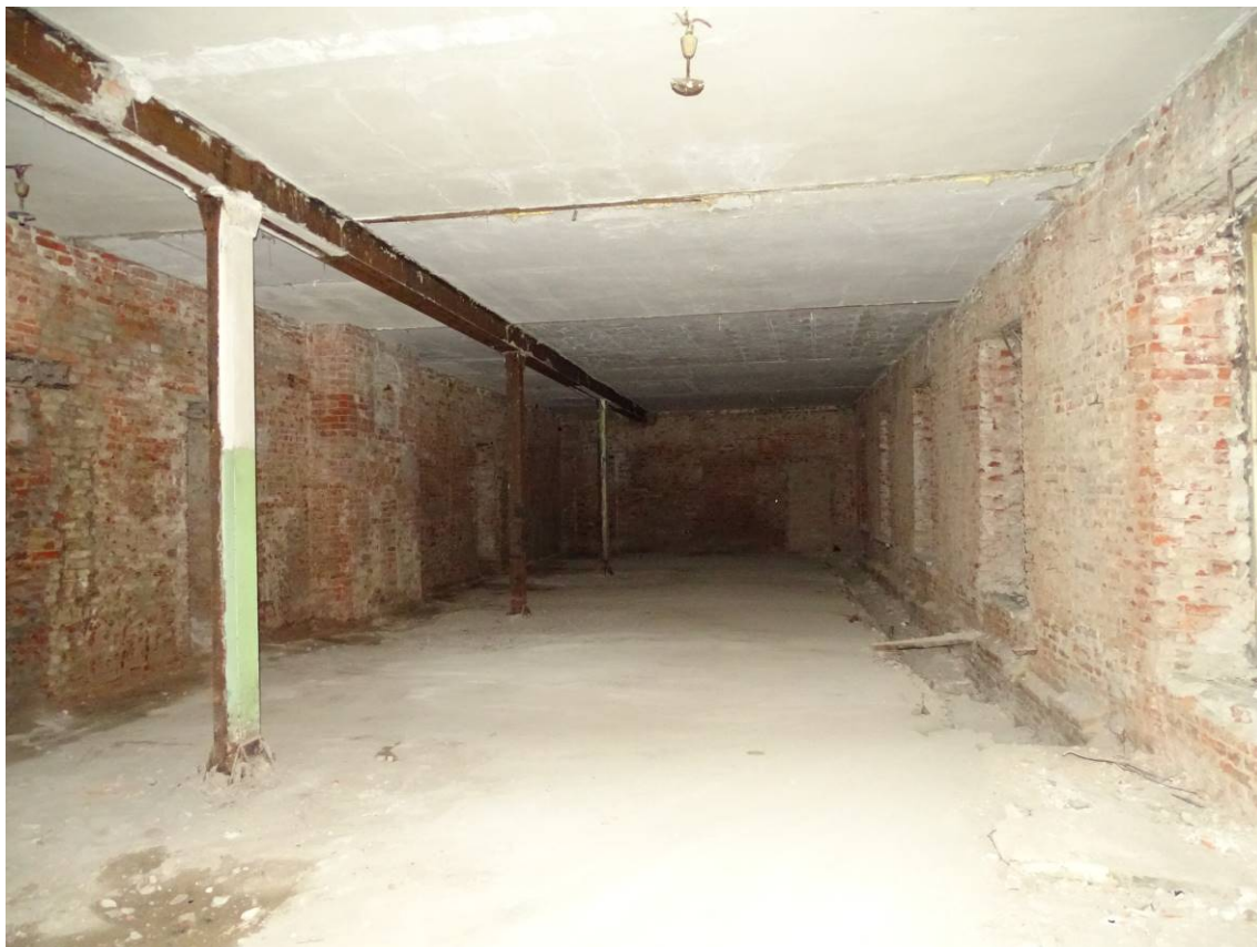
Фото 05. Секция 4. Помещение 1-го этажа. Съемка 15.06.2023 г. Трушковский В.Э.
