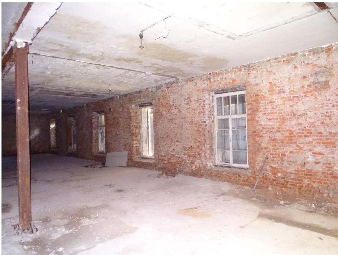
Фото 02. Секция 4. Помещение 1-го этажа. Съемка 15.06.2023 г. Трушковский В.Э.
