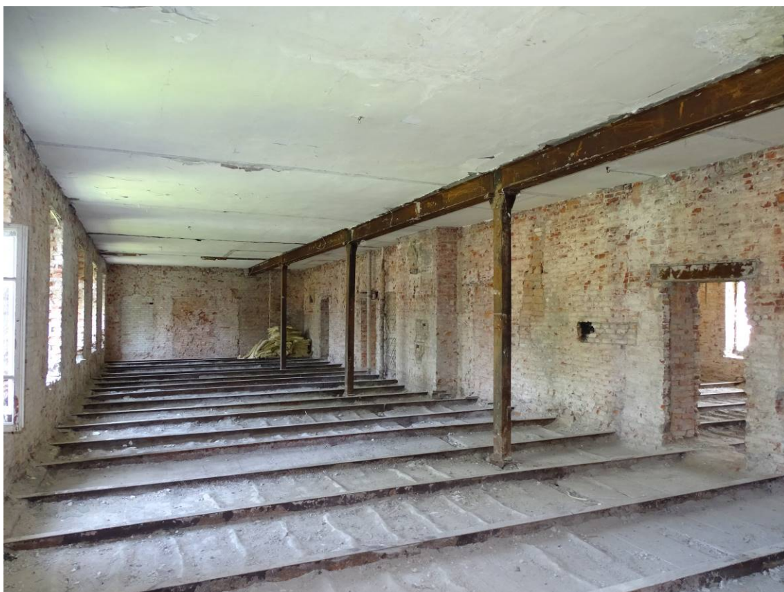
Фото 11. Секция 2. Помещение 2-го этажа. Съемка 15.06.2023 г. Трушковский В.Э.
