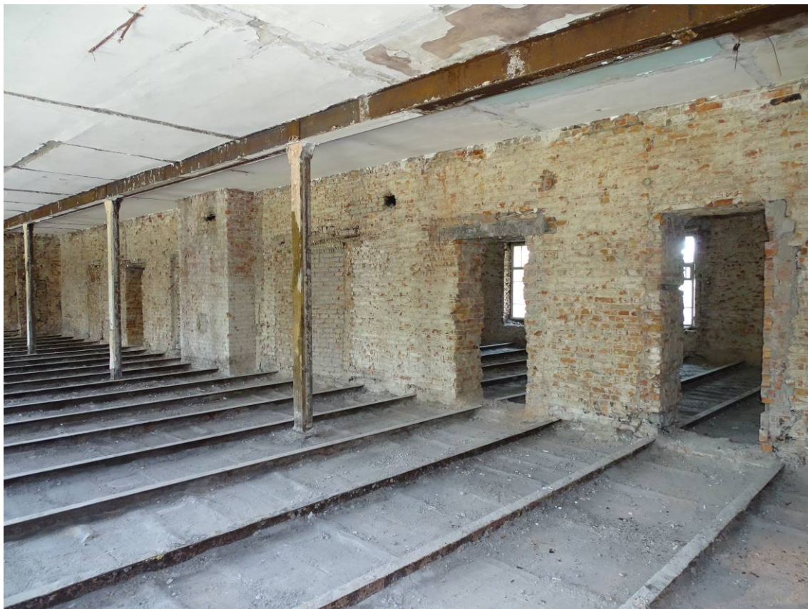
Фото 14. Секция 4. Помещение 2-го этажа. Съемка 15.06.2023 г. Трушковский В.Э.
