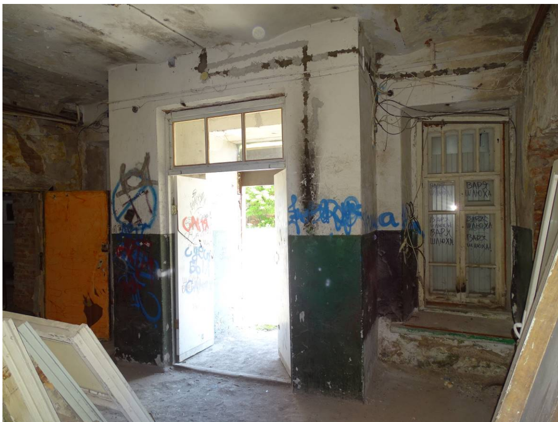
Фото 02. Секция 1. 1-й этаж. Восточный вестибюль. Съемка 15.06.2023 г. Трушковский В.Э.
