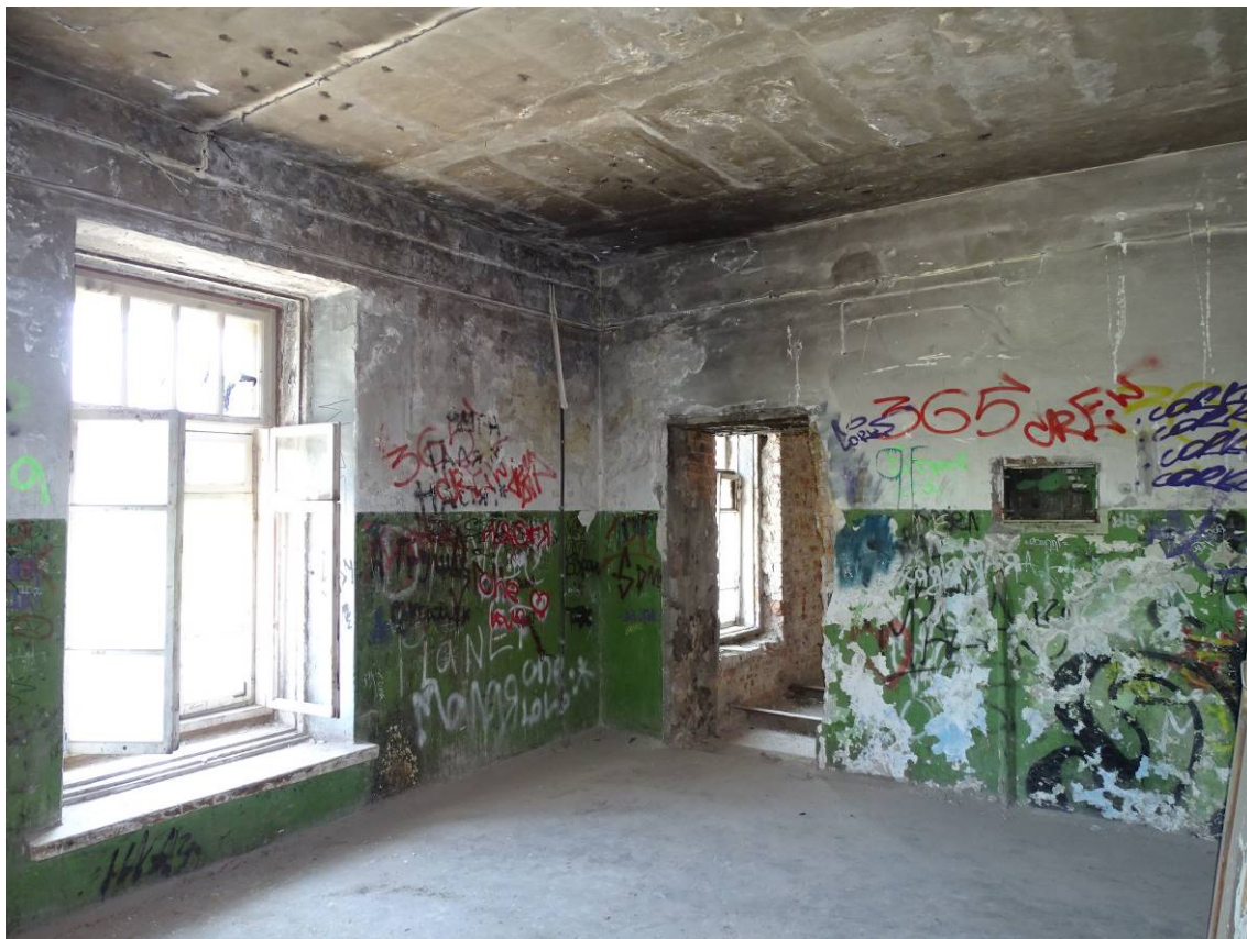
Фото 20. Секция 2. 3-й этаж. Восточный вестибюль. Съемка 15.06.2023 г. Трушковский В.Э.
