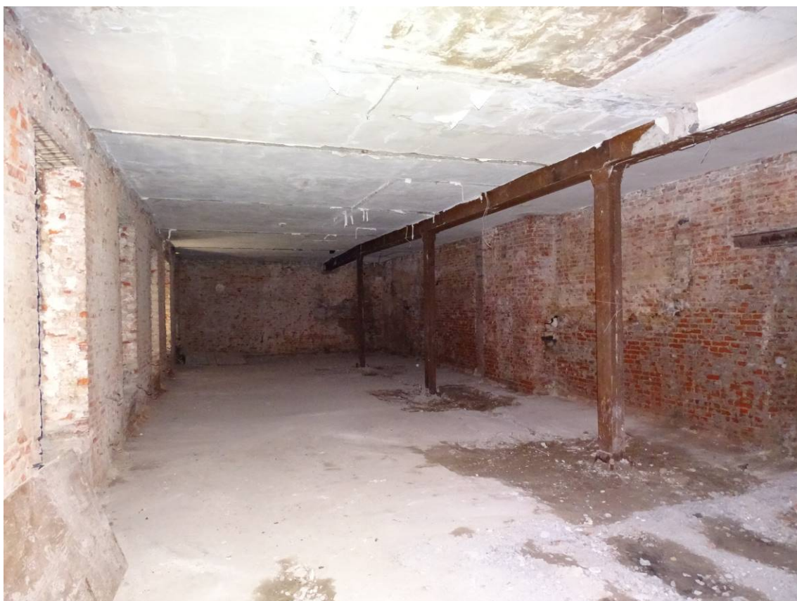
Фото 04. Секция 1. Помещение 1-го этажа. Съемка 15.06.2023 г. Трушковский В.Э.
