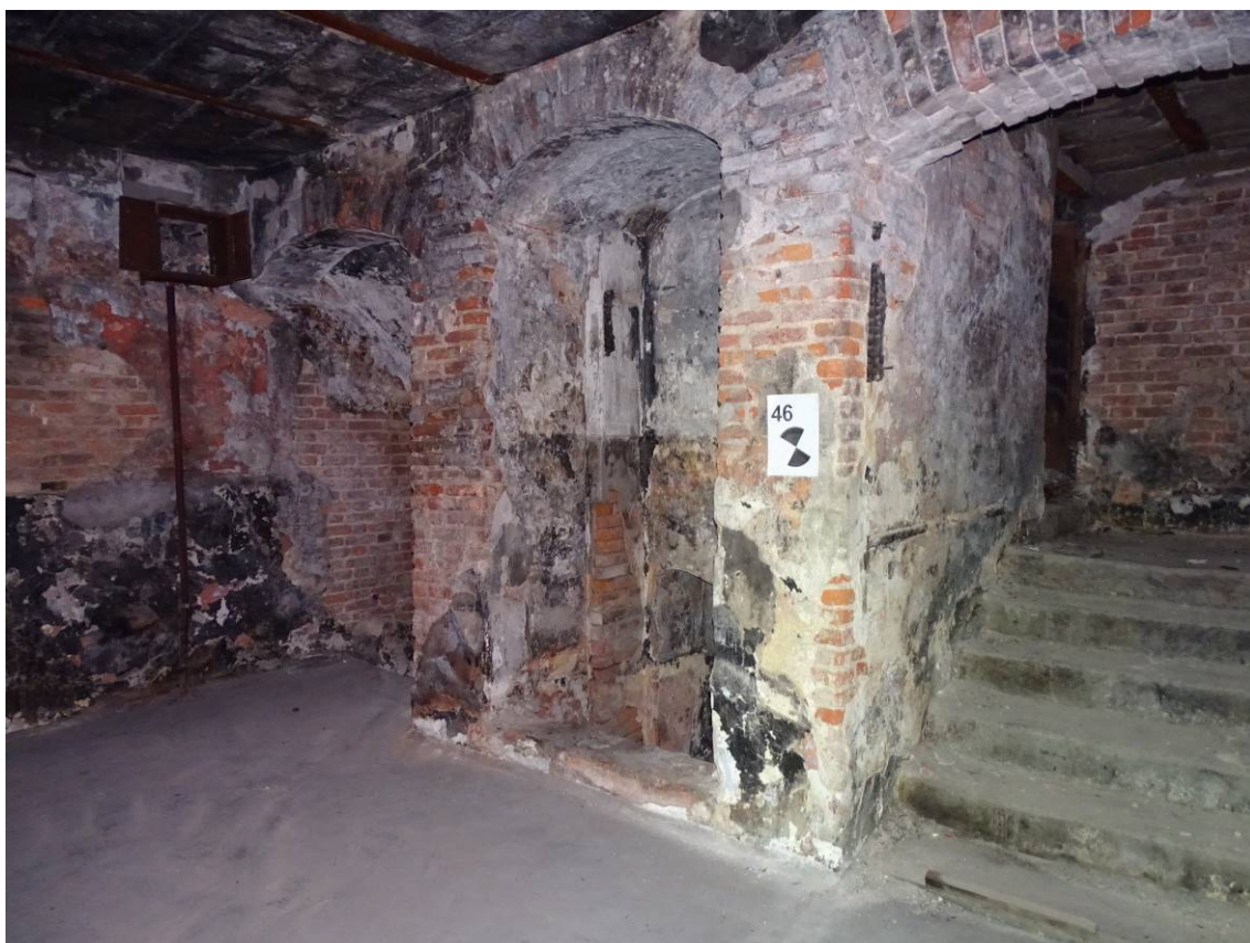
Фото 21. Секция 4. 3-й этаж. Вестибюль западной лестницы. Съемка 15.06.2023 г. Трушковский В.Э.
