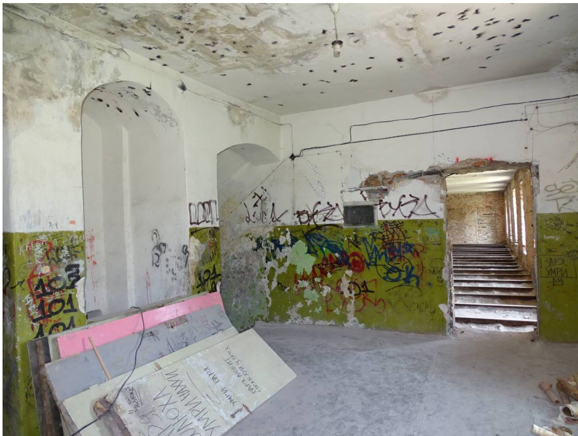
Фото 11. Секция 1. Вестибюль 3-го этажа. Съемка 15.06.2023 г. Трушковский В.Э.
