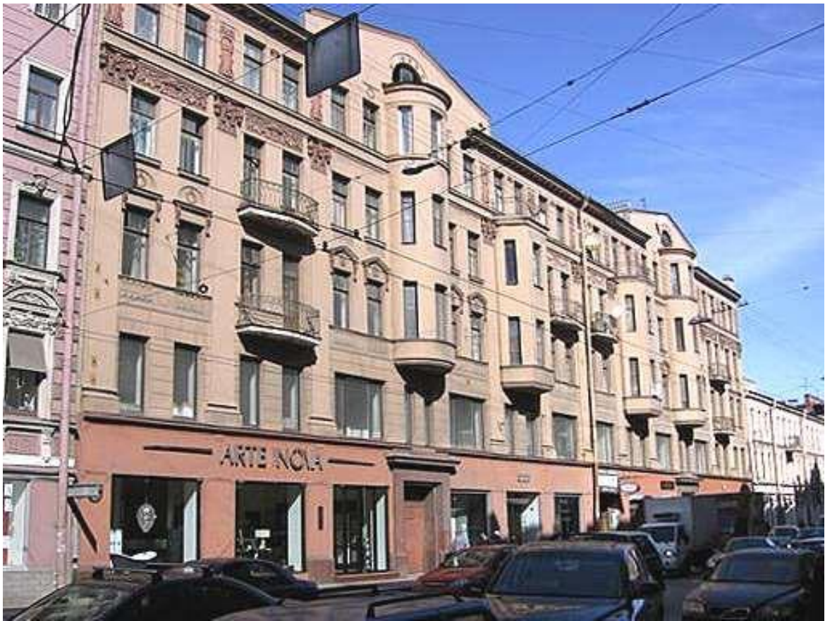
36. Большой пр. П.С., дом 22-24. Главный фасад. Фотоснимок 2009 г.
