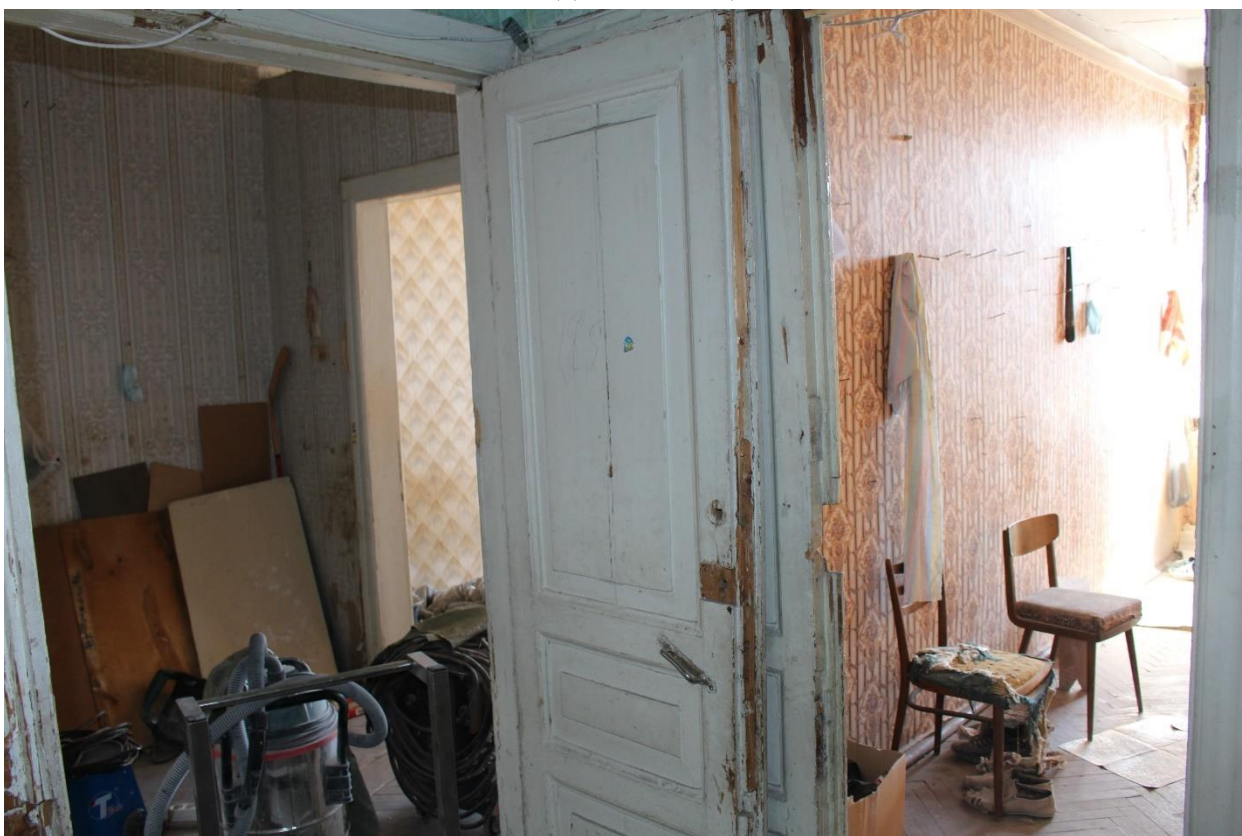
Фото 20. Вид на помещение № 18, ведущее в помещения № 16 и № 17.
