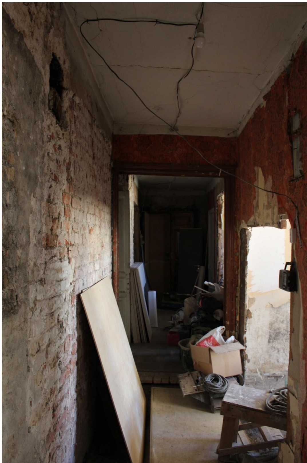
Фото 29. Вид на помещение № 19 в сторону помещения № 1.
