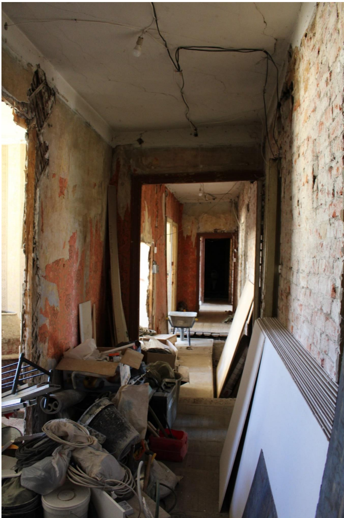
Фото 15. Вид на помещение 1.
