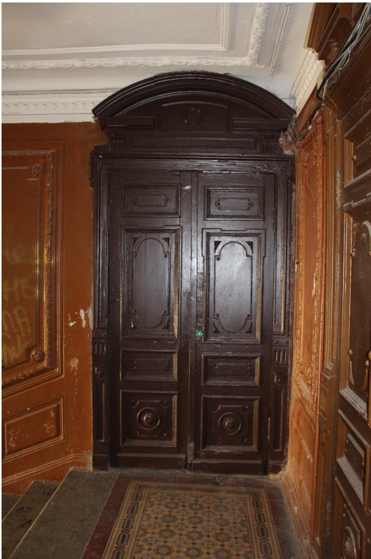
Фото 14. Вид на входную дверь квартиры № 11 с парадной лестницы (1ЛК).
