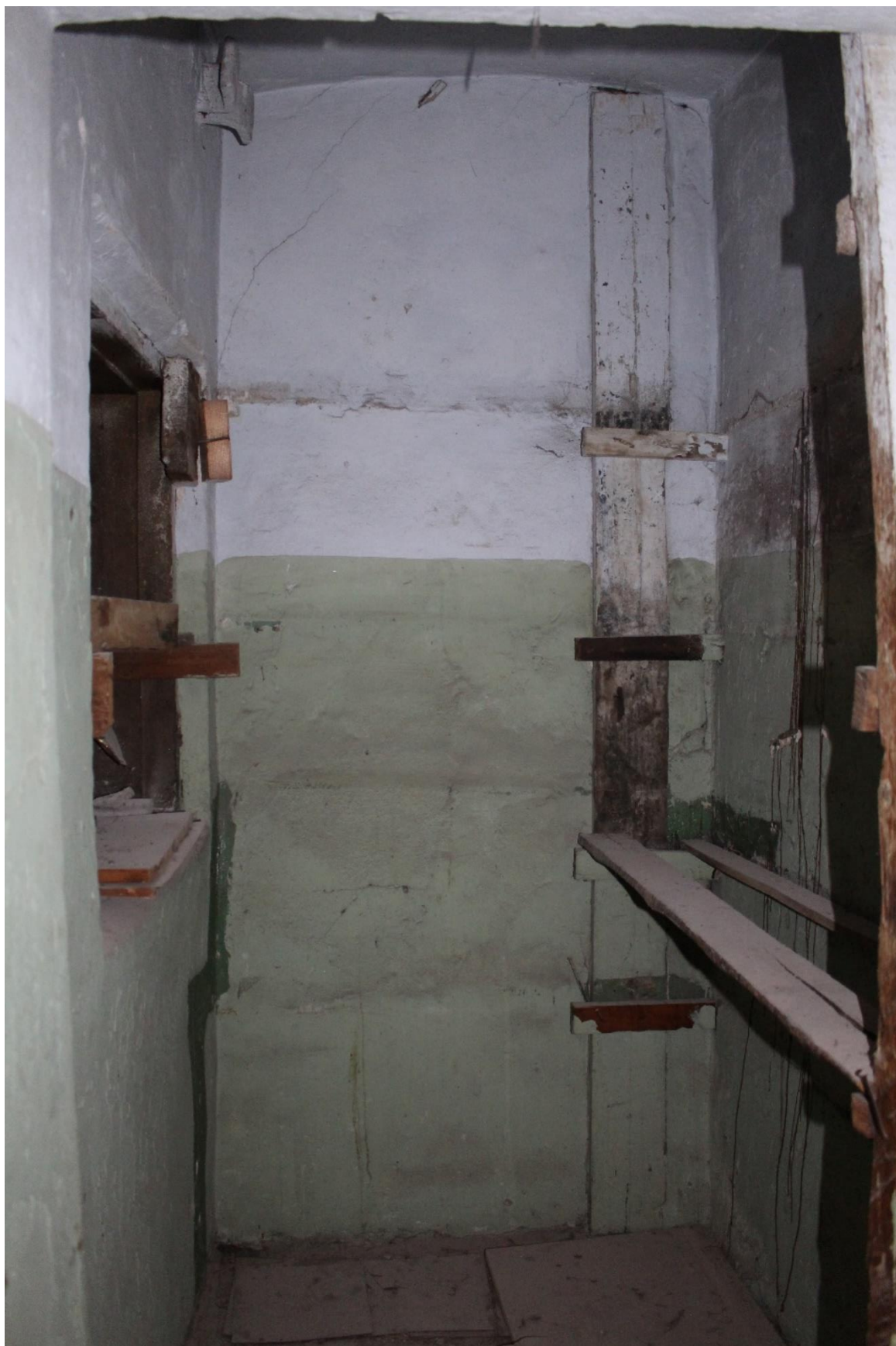
Фото 47. Вид на помещение № 7.
