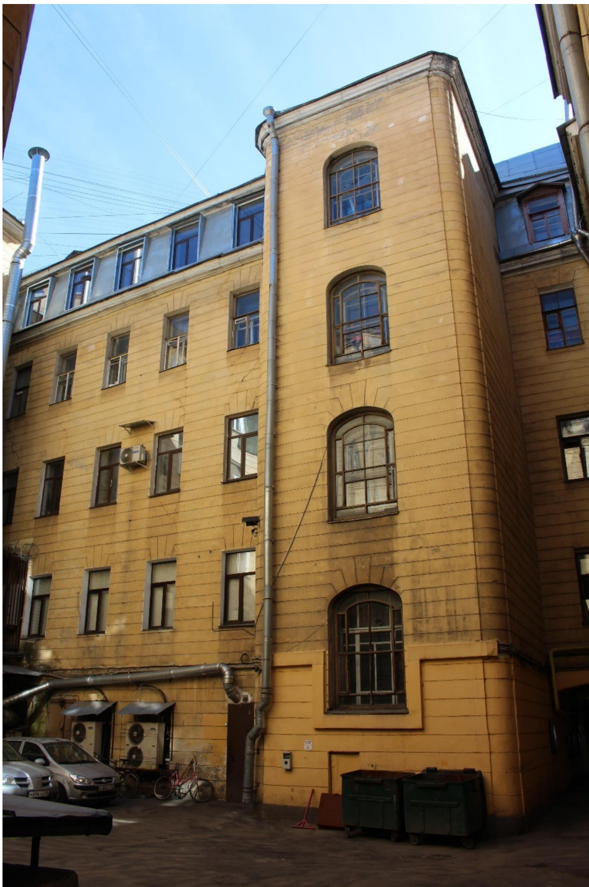
Фото 8. Вид на дворовый фасад лицевого корпуса.
