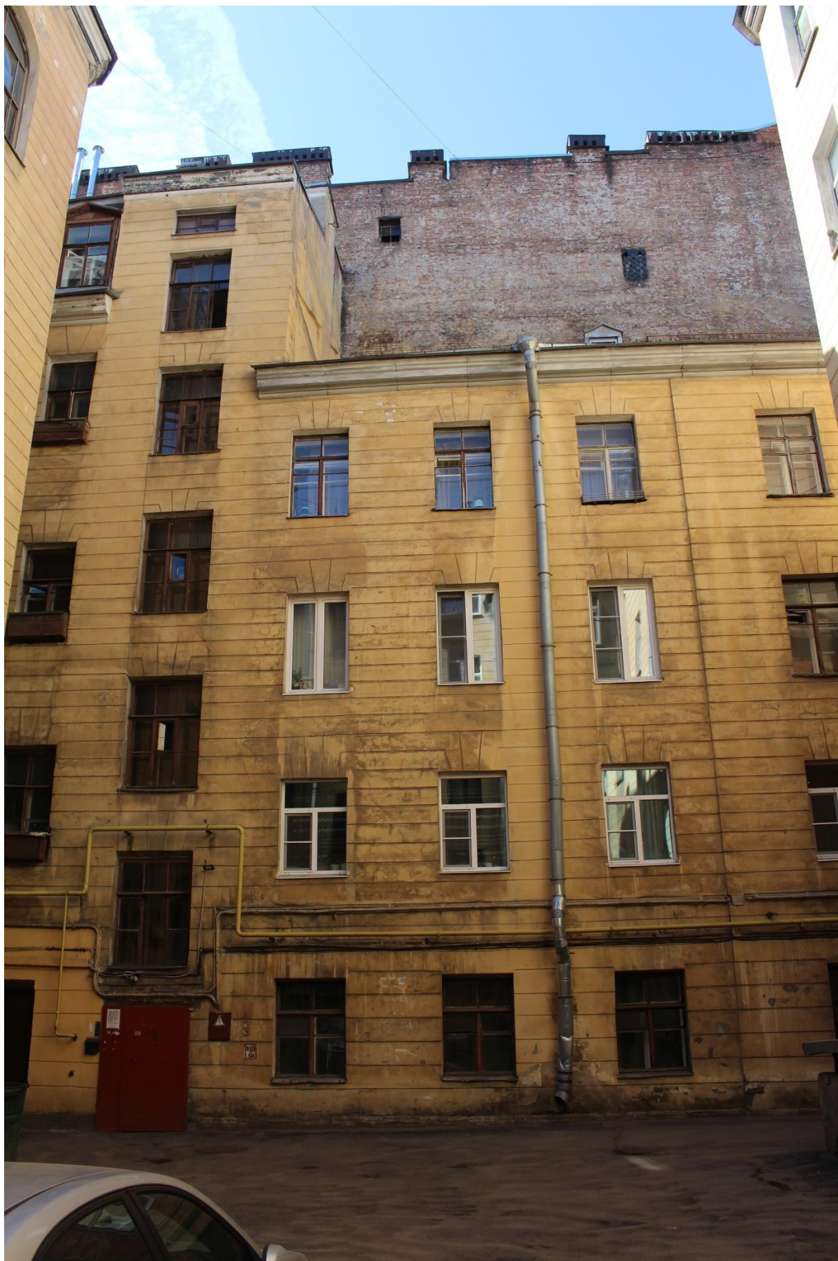
Фото 12. Вид на западный дворовый корпус южного двора.
