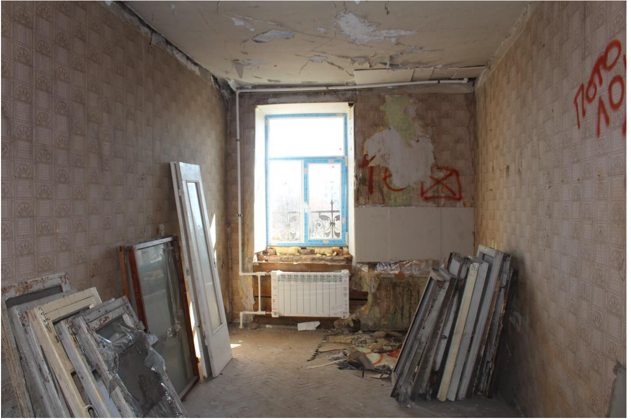
Фото 41. Вид на помещение № 13.
