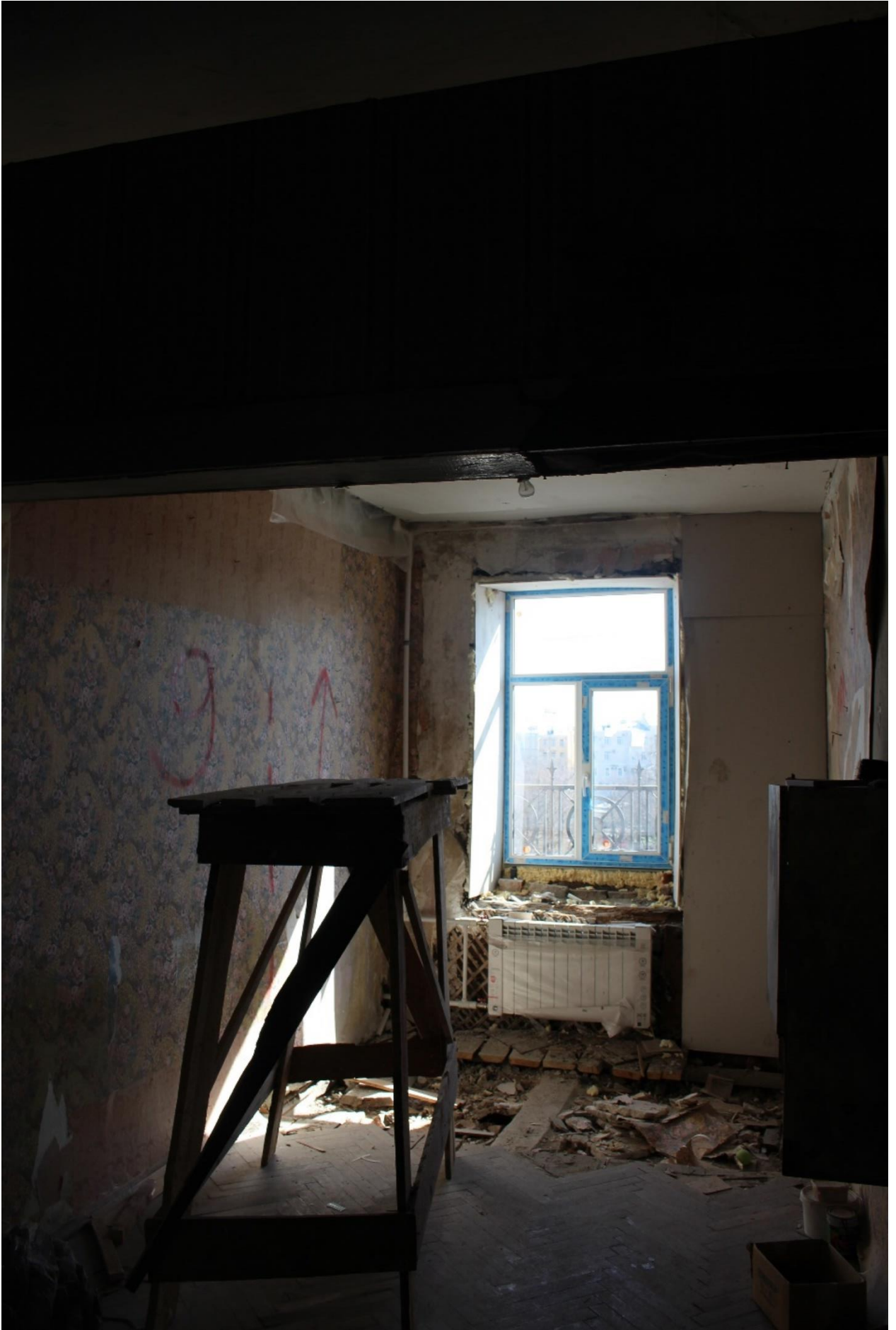
Фото 23. Вид на помещение № 16.
