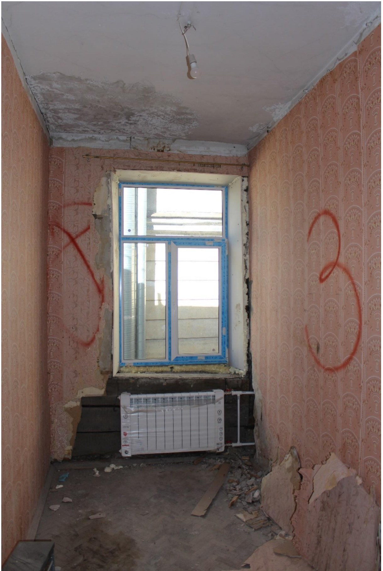
Фото 33. Вид на помещение № 5.
