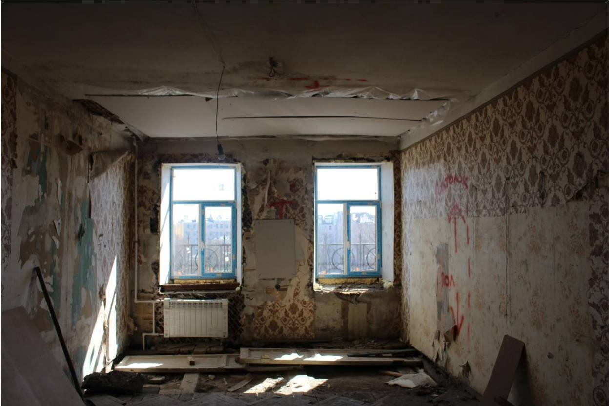
Фото 36. Вид на помещение № 14.
