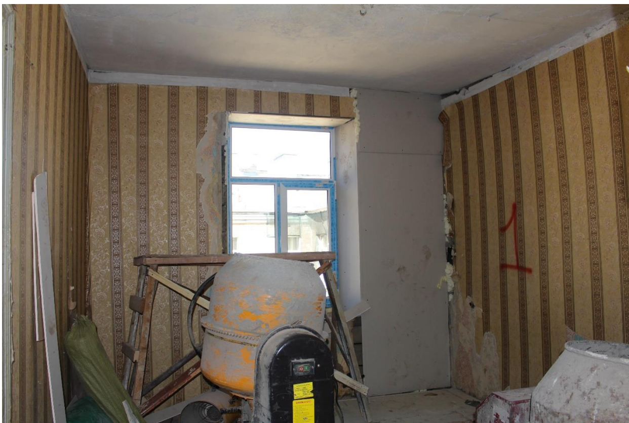
Фото 19. Вид на помещение № 3.
