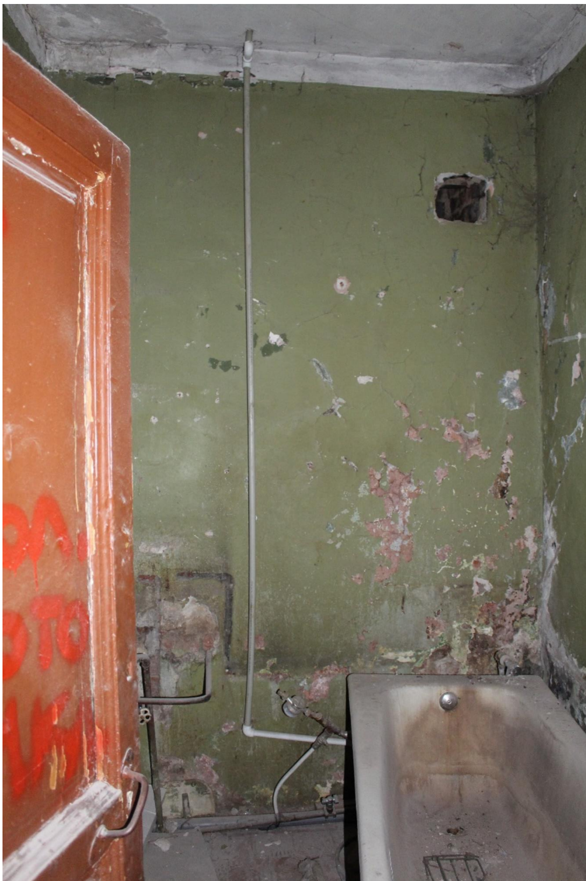
Фото 44. Вид на помещение № 9.
