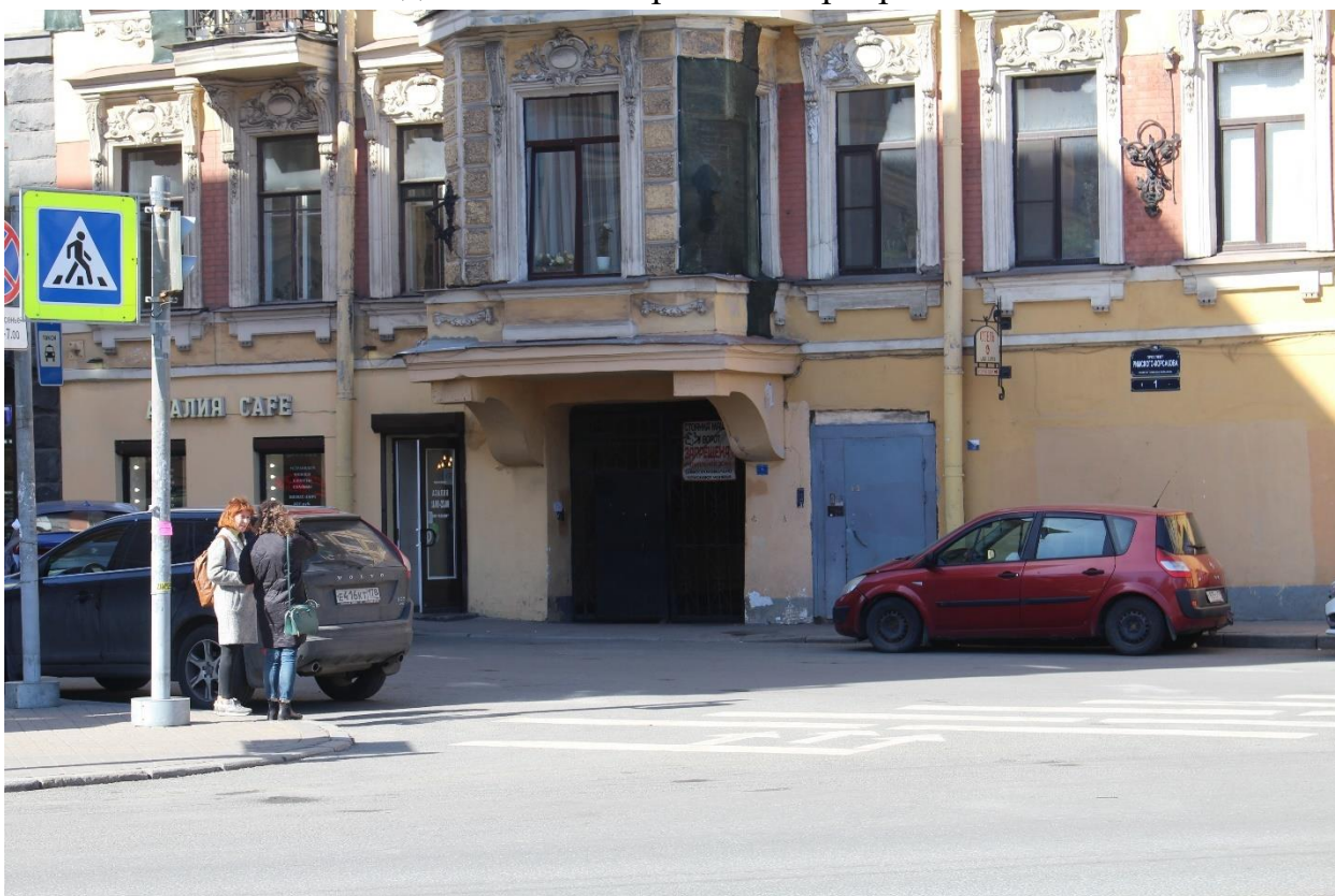
Фото 4. Вид на арку воротного проезда, ведущую во двор и вход в 1ЛК.
