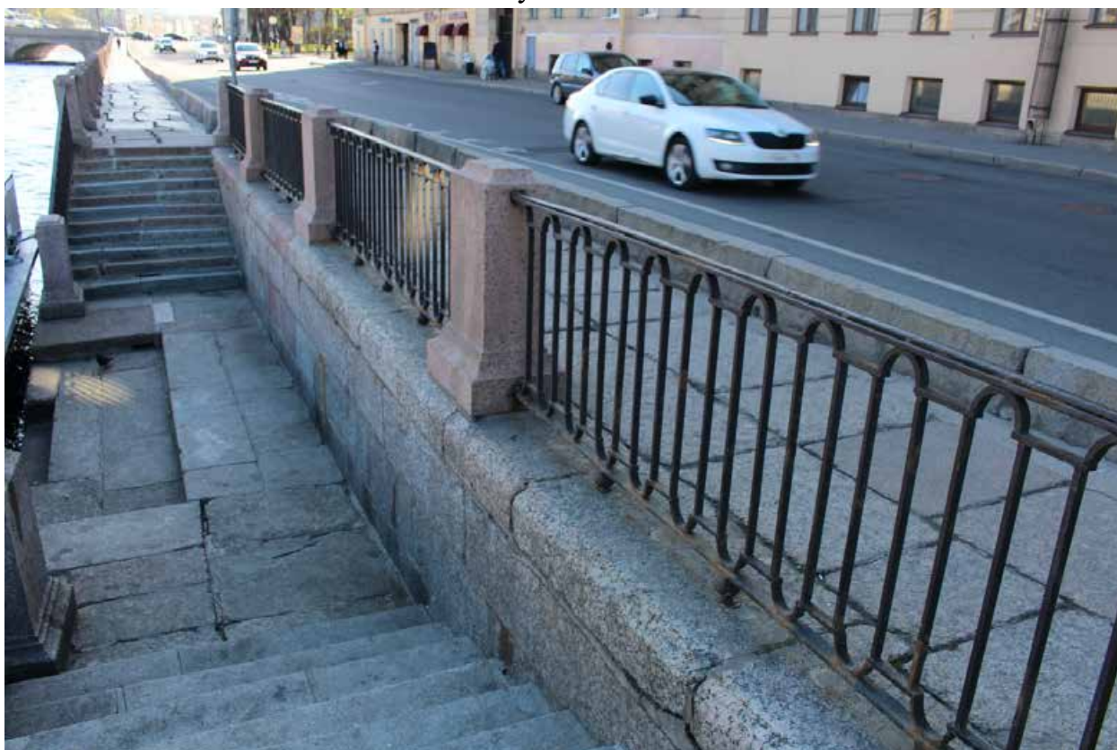
Фото 8. Вид на объект культурного наследия федерального значения «Набережные со спусками» на участке набережной реки Фонтанки «Горсткий мост - Обуховский мост».
