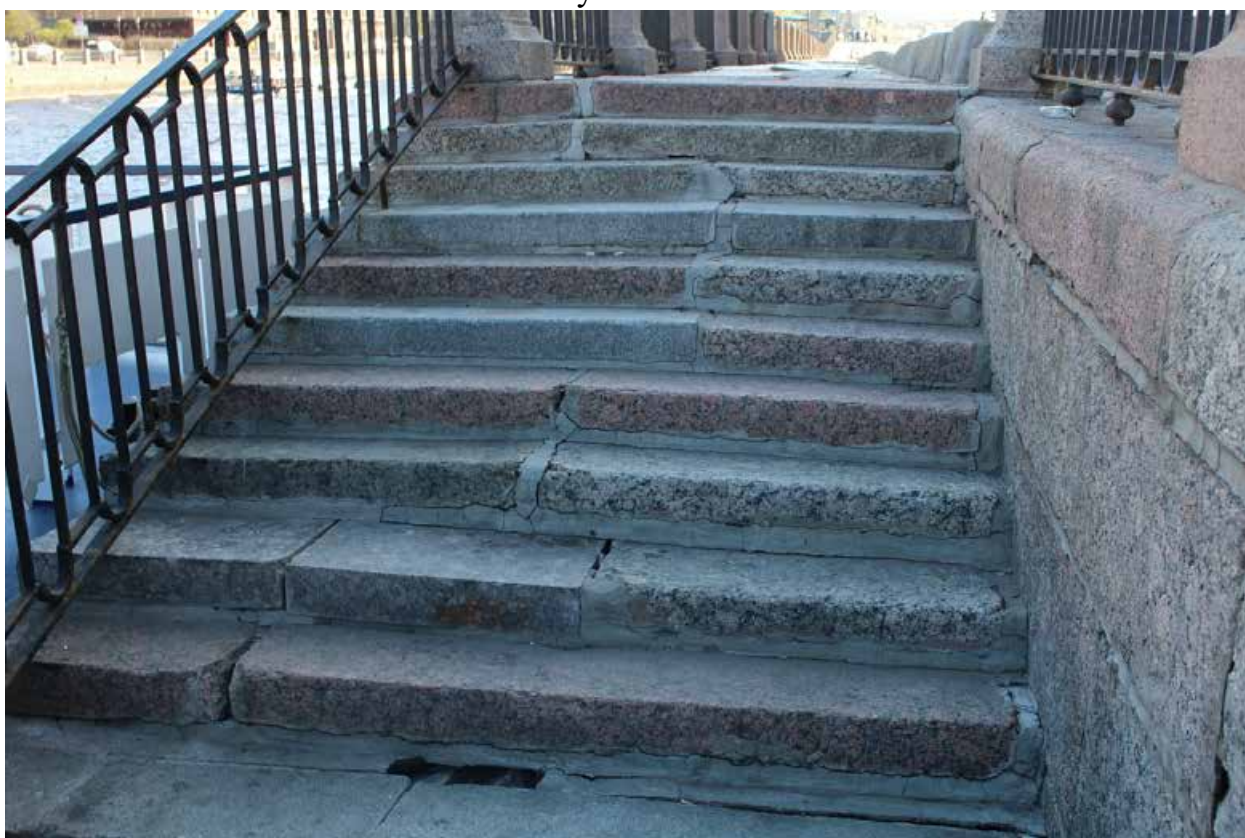
Фото 4. Вид на объект культурного наследия федерального значения «Набережные со спусками» на участке набережной реки Фонтанки «Горсткий мост - Обуховский мост».
