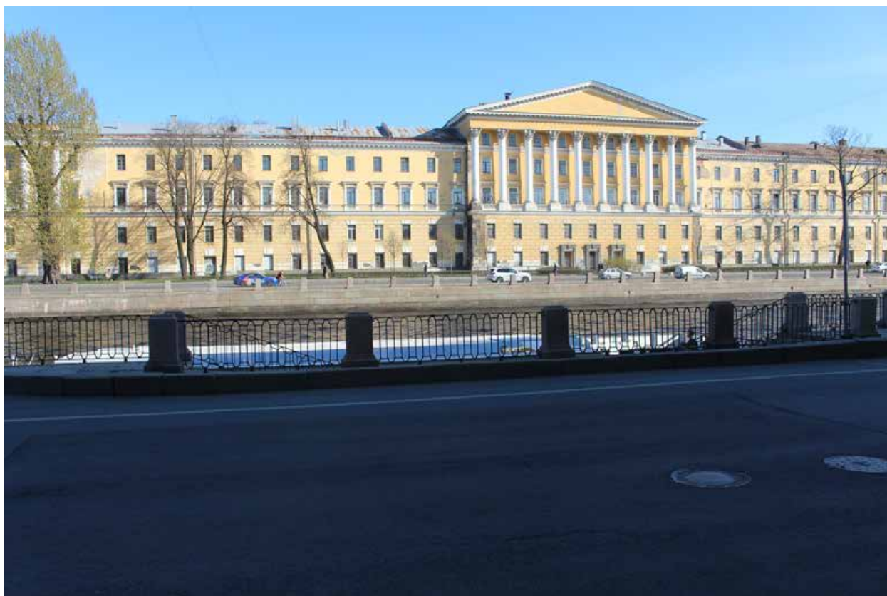
Фото 9. Вид на объект культурного наследия федерального значения «Набережные со спусками» на участке набережной реки Фонтанки «Горсткий мост - Обуховский мост».
