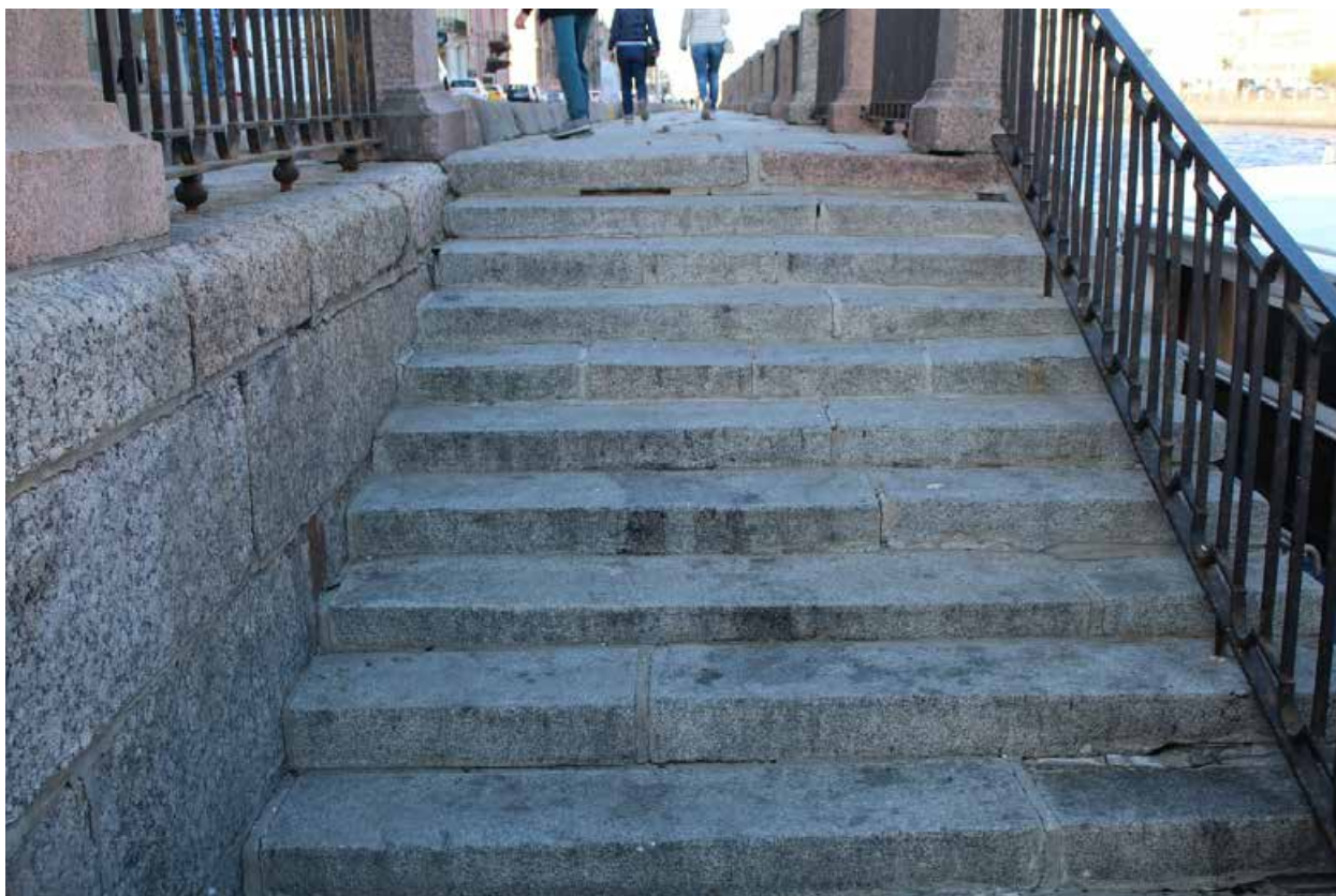
Фото 7. Вид на объект культурного наследия федерального значения «Набережные со спусками» на участке набережной реки Фонтанки «Горсткий мост - Обуховский мост».
