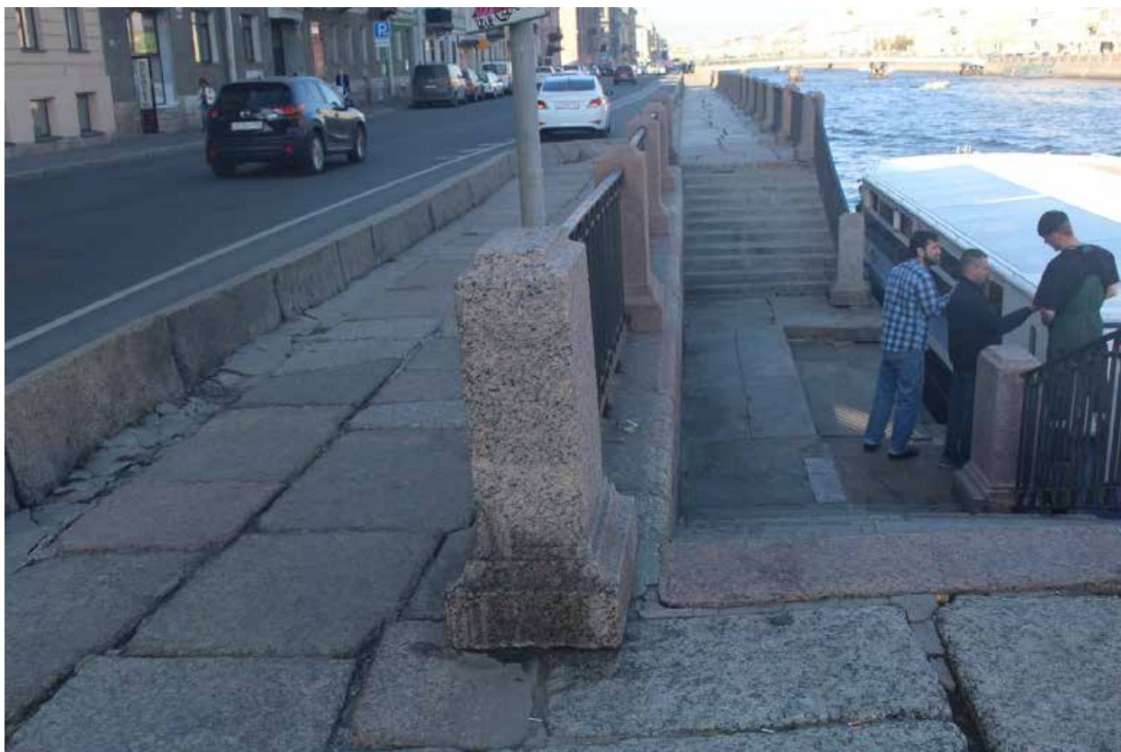
Фото 3. Вид на объект культурного наследия федерального значения «Набережные со спусками» на участке набережной реки Фонтанки «Горсткий мост - Обуховский мост».
