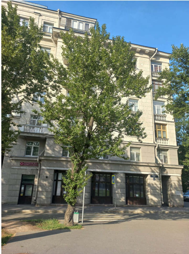
11. Фрагмент лицевого фасада вдоль Московского шоссе дома 16, корп. 1, литера А
