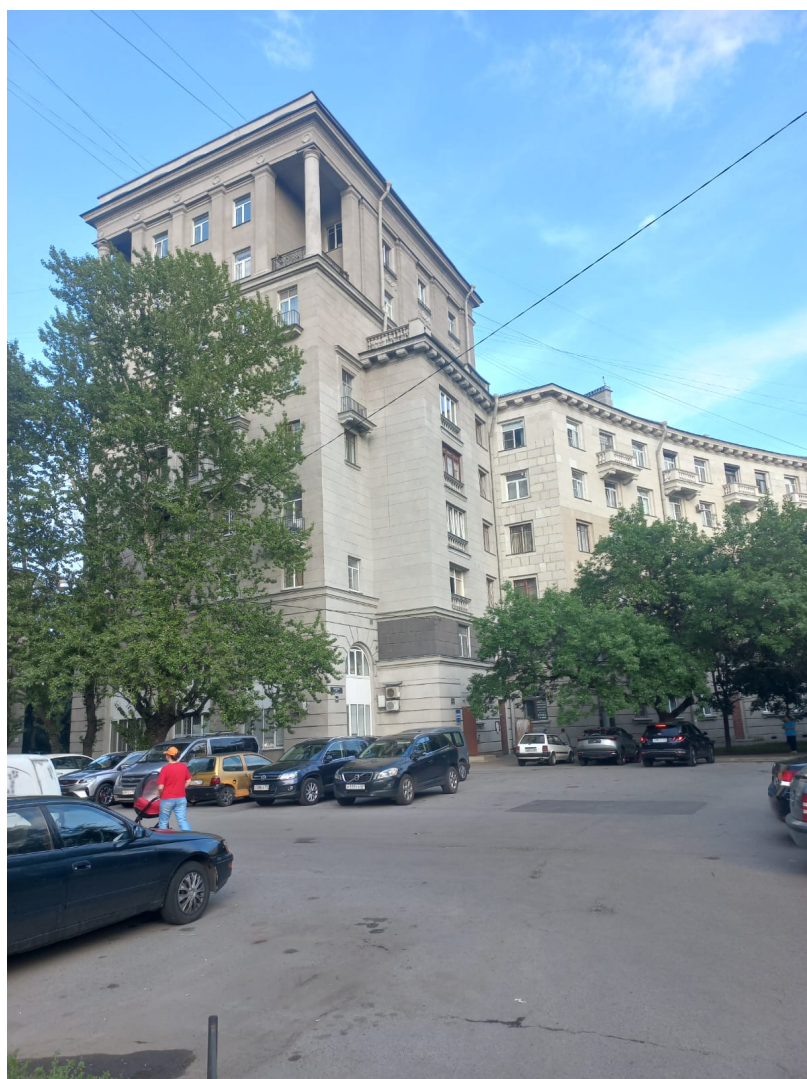
16. Общий вид полукруглой части лицевого фасада дома 16, корп. 1, литера А
