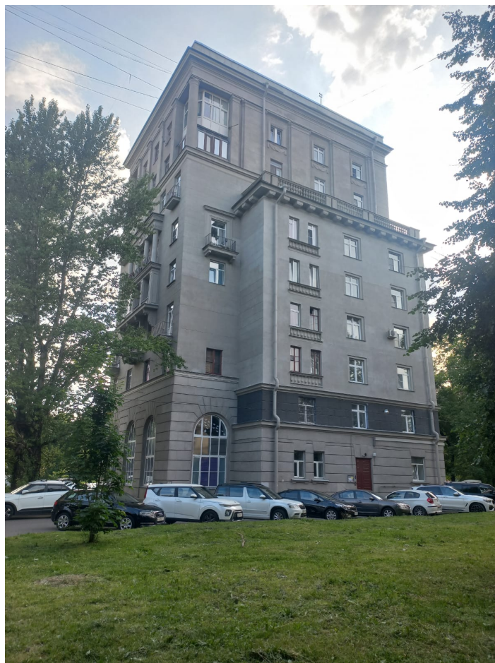
5. Фрагмент дворового фасада со стороны северо-востока дома 14, корп. 1, литера А (у проезда между домами 14 и 16)
