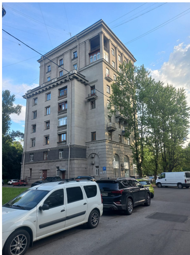
6. Фрагмент северо-западной части фасада дома 16, корп. 1, литера А рядом с проездом между домами 16 и 14
