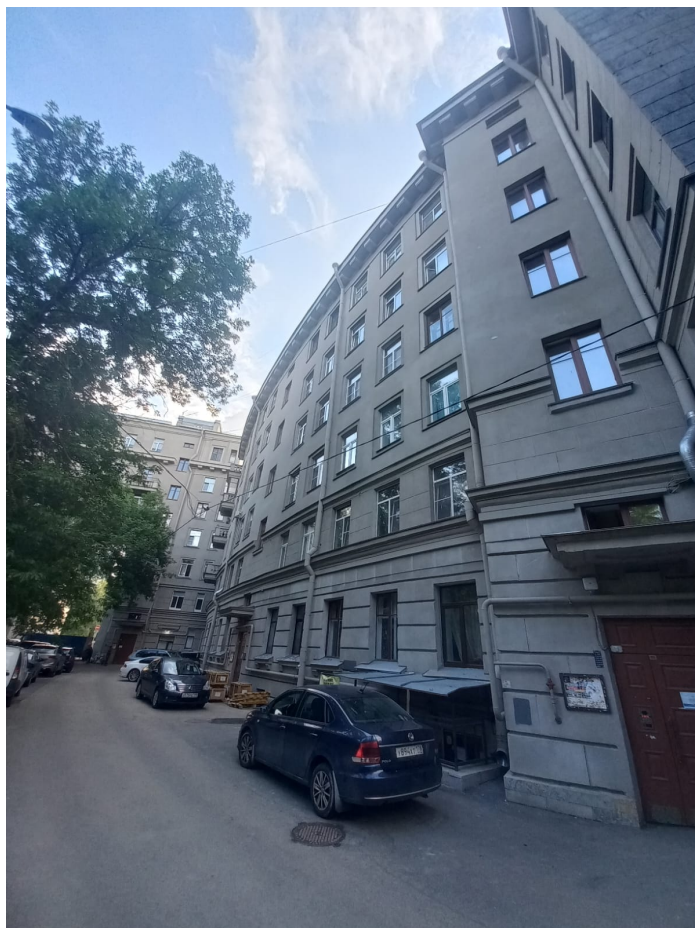
7. Общий вид полукруглой части дворового фасада дома 16, корп. 1, литера А
