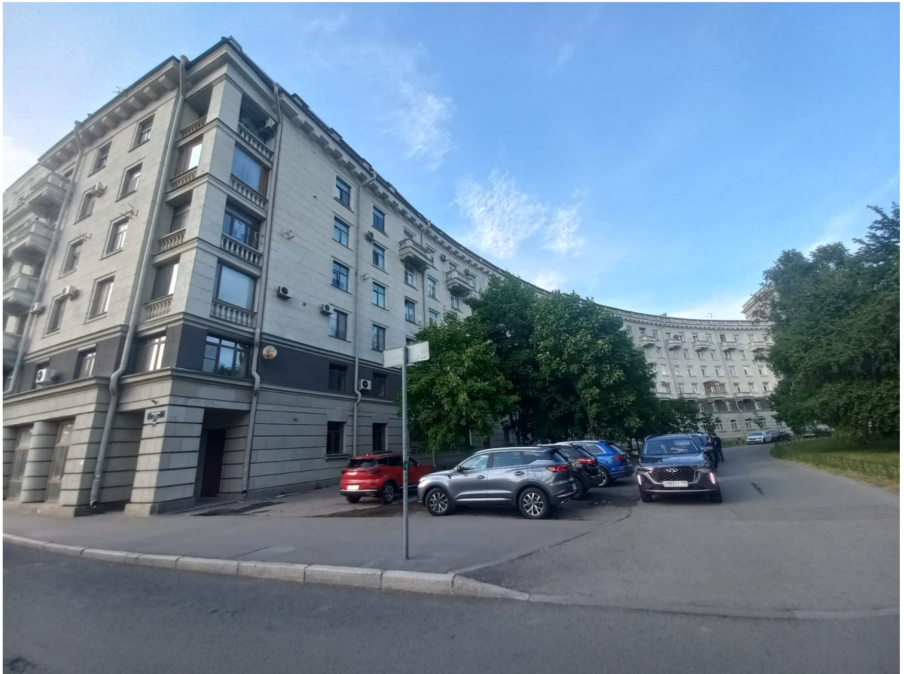
17. Общий вид полукруглой части лицевого фасада дома 14, корп. 1, литера А
