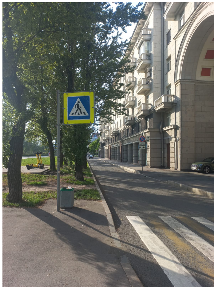
12. Фрагмент лицевого фасада вдоль Московского шоссе дома 16, корп. 1, литера А
