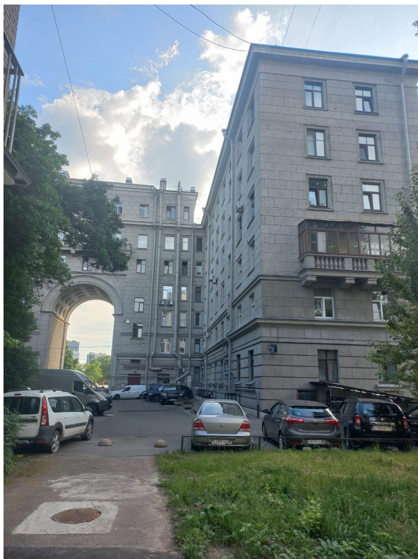
2. Вид дворового фасада и северо-западной проездной арки дома 14, корп. 1, литера А.
