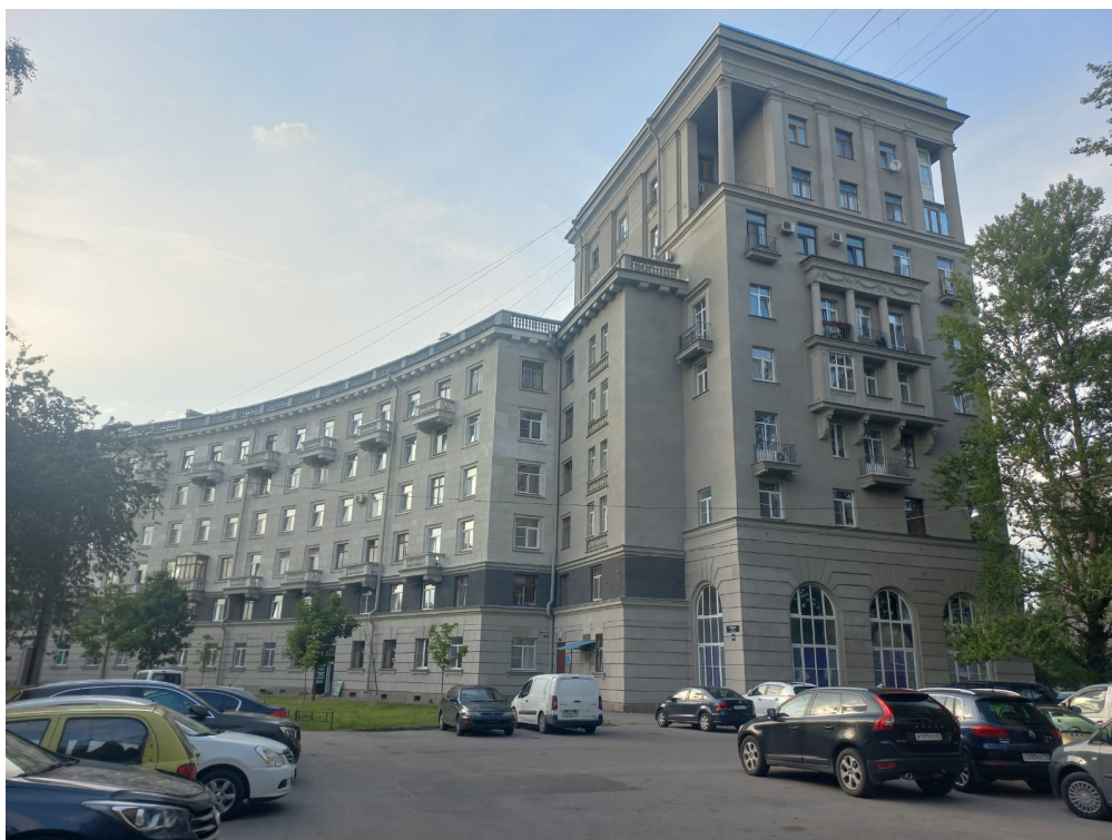
15. Общий вид полукруглой части лицевого фасада дома 14, корп. 1, литера А
