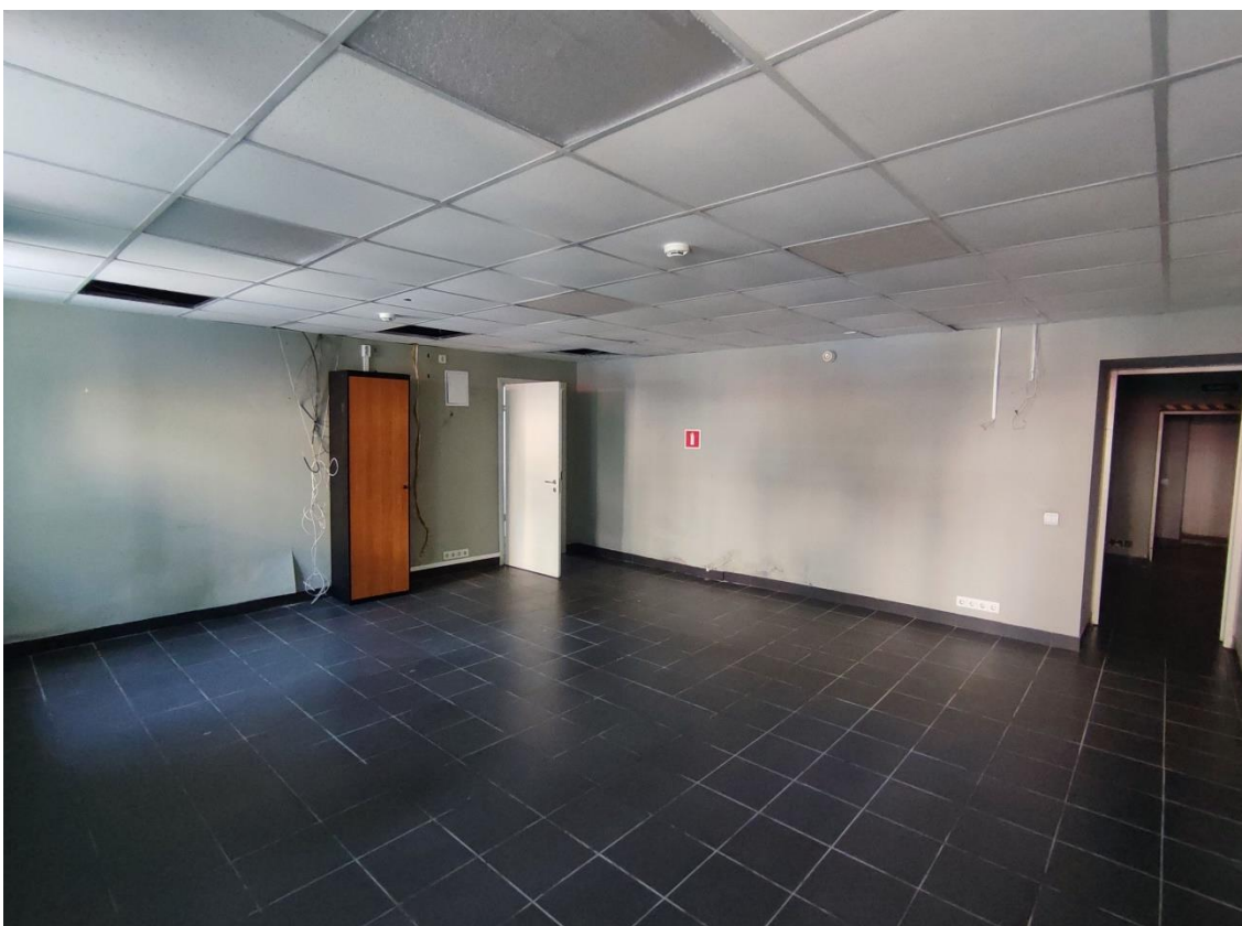
13. Объект культурного наследия регионального значения «Жилой дом купчихи Улановой», расположенный по адресу: Санкт-Петербург, город Кронштадт, проспект Ленина, дом 18, литера А. Общий вид пом. 1-Н (4) в уровне 1-го этажа.
