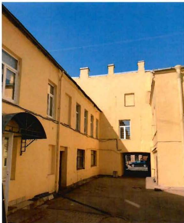
3. Дворовый фасад. Общий вид.
