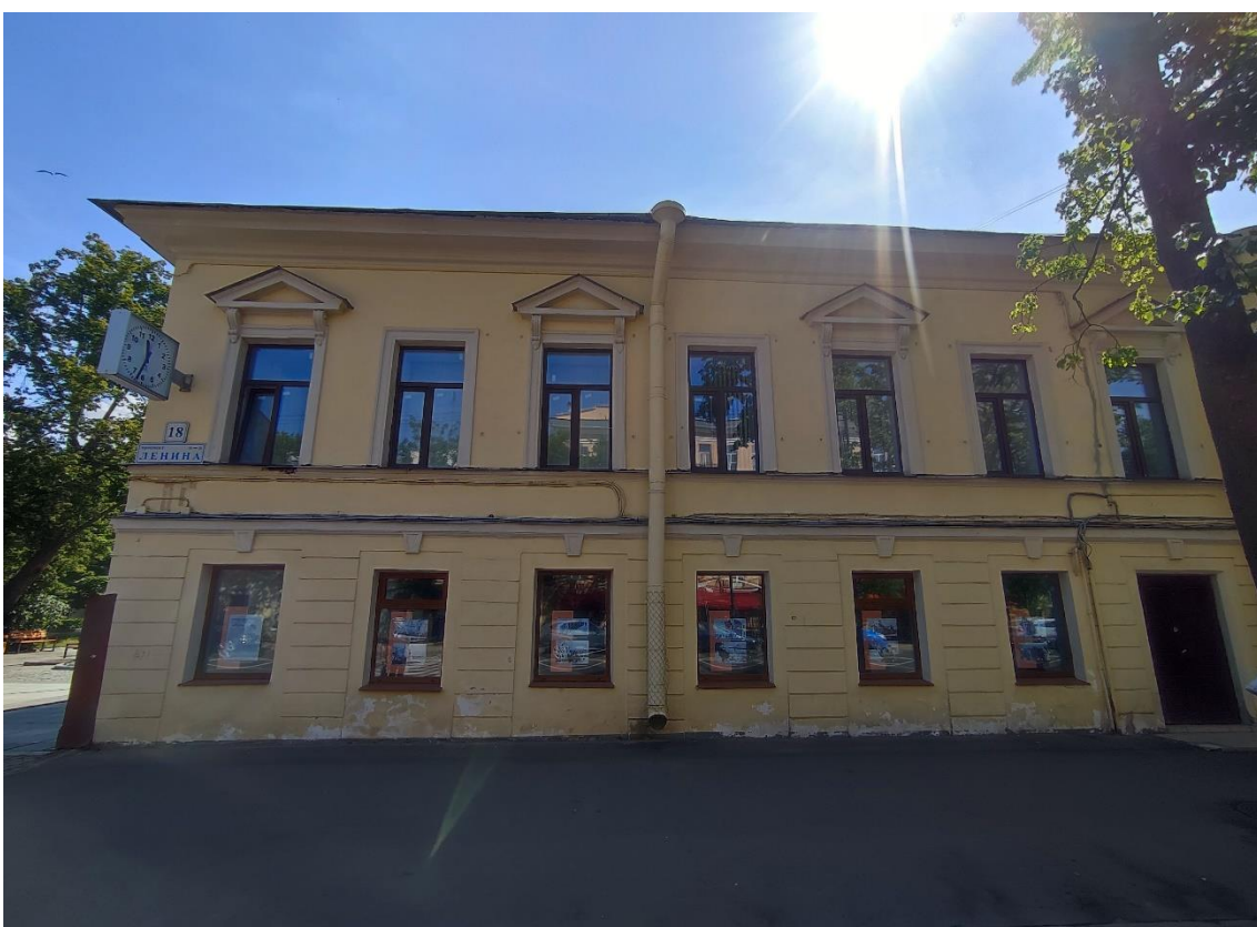
6. Объект культурного наследия регионального значения «Жилой дом купчихи Улановой», расположенный по адресу: Санкт-Петербург, город Кронштадт, проспект Ленина, дом 18, литера А. Фрагмент северо-западного лицевого фасада, оконные проемы пом. 1-Н в уровне 1-го этажа.
