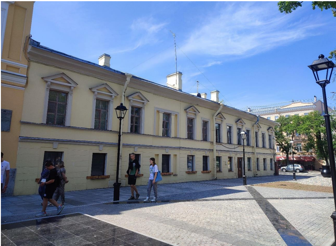
3. Объект культурного наследия регионального значения «Жилой дом купчихи Улановой», расположенный по адресу: Санкт-Петербург, город Кронштадт, проспект Ленина, дом 18, литера А. Общий вид северо-восточного лицевого фасада.
