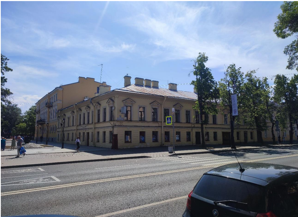
1. Объект культурного наследия регионального значения «Жилой дом купчихи Улановой», расположенный по адресу: Санкт-Петербург, город Кронштадт, проспект Ленина, дом 18, литера А. Общий вид от проспекта Ленина.
