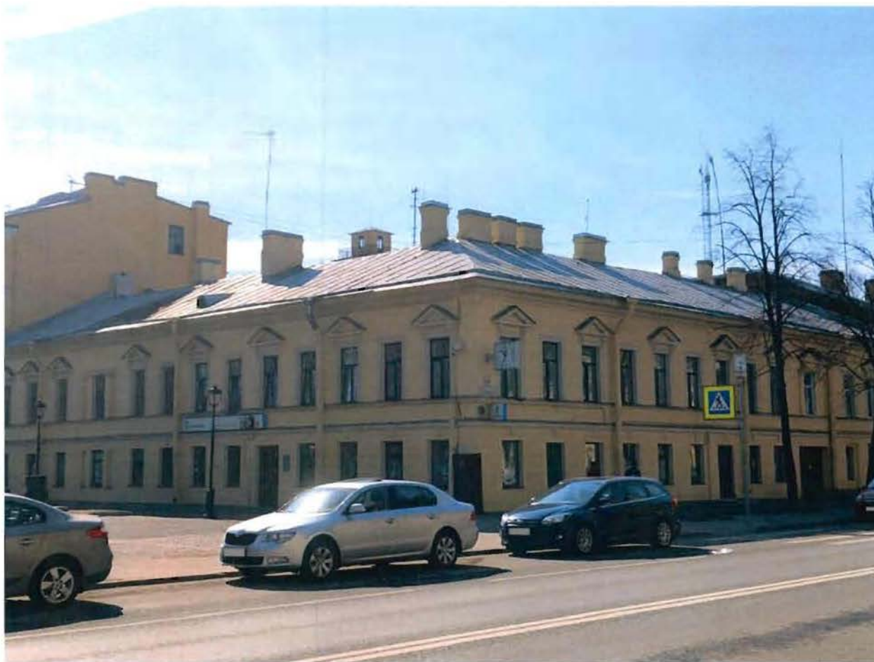
1. Фасад. Общий вид.
