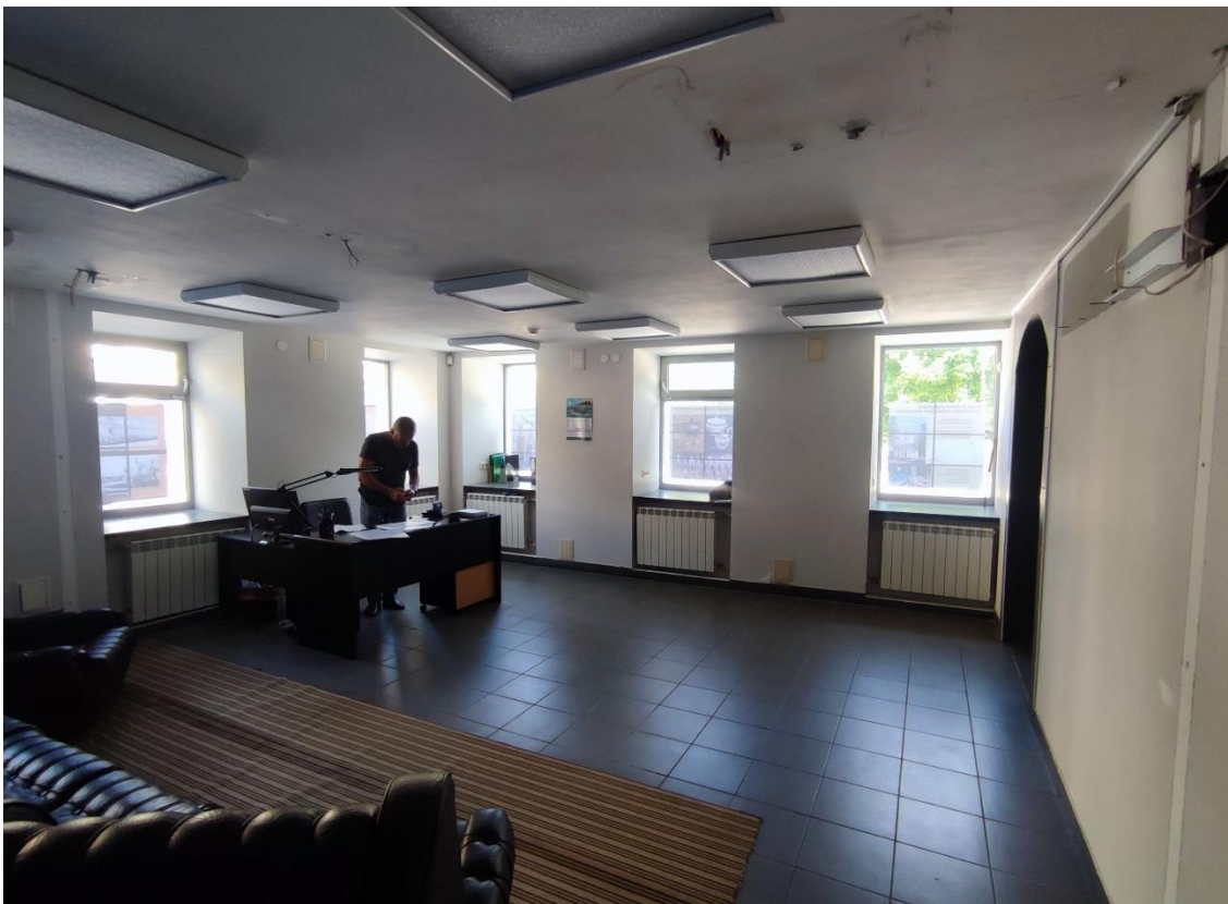
10. Объект культурного наследия регионального значения «Жилой дом купчихи Улановой», расположенный по адресу: Санкт-Петербург, город Кронштадт, проспект Ленина, дом 18, литера А. Общий вид пом. 1-Н (3) в уровне 1-го этажа.
