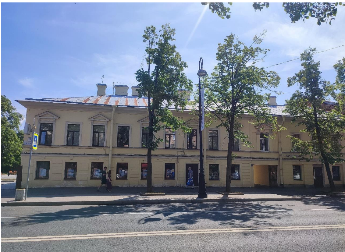
5. Объект культурного наследия регионального значения «Жилой дом купчихи Улановой», расположенный по адресу: Санкт-Петербург, город Кронштадт, проспект Ленина, дом 18, литера А. Общий вид северо-западного лицевого фасада.
