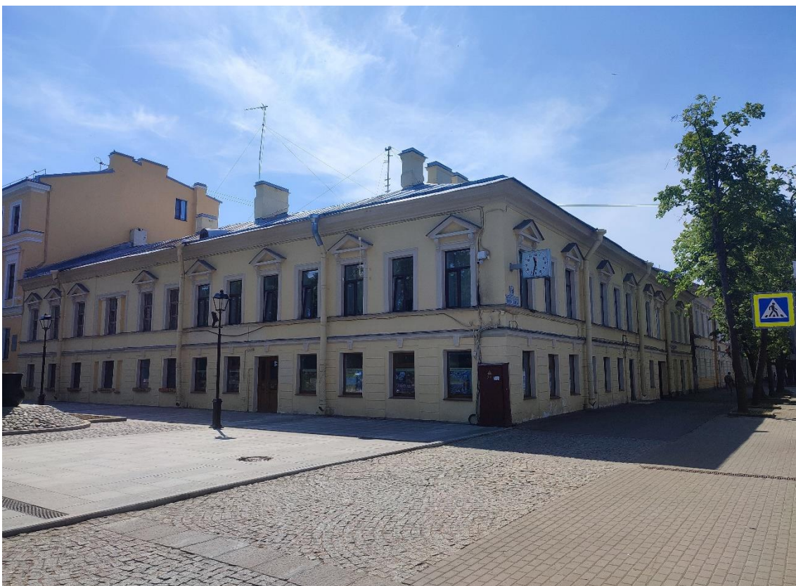
2. Объект культурного наследия регионального значения «Жилой дом купчихи Улановой», расположенный по адресу: Санкт-Петербург, город Кронштадт, проспект Ленина, дом 18, литера А. Общий вид северо-западного и северо-восточного лицевых фасадов.
