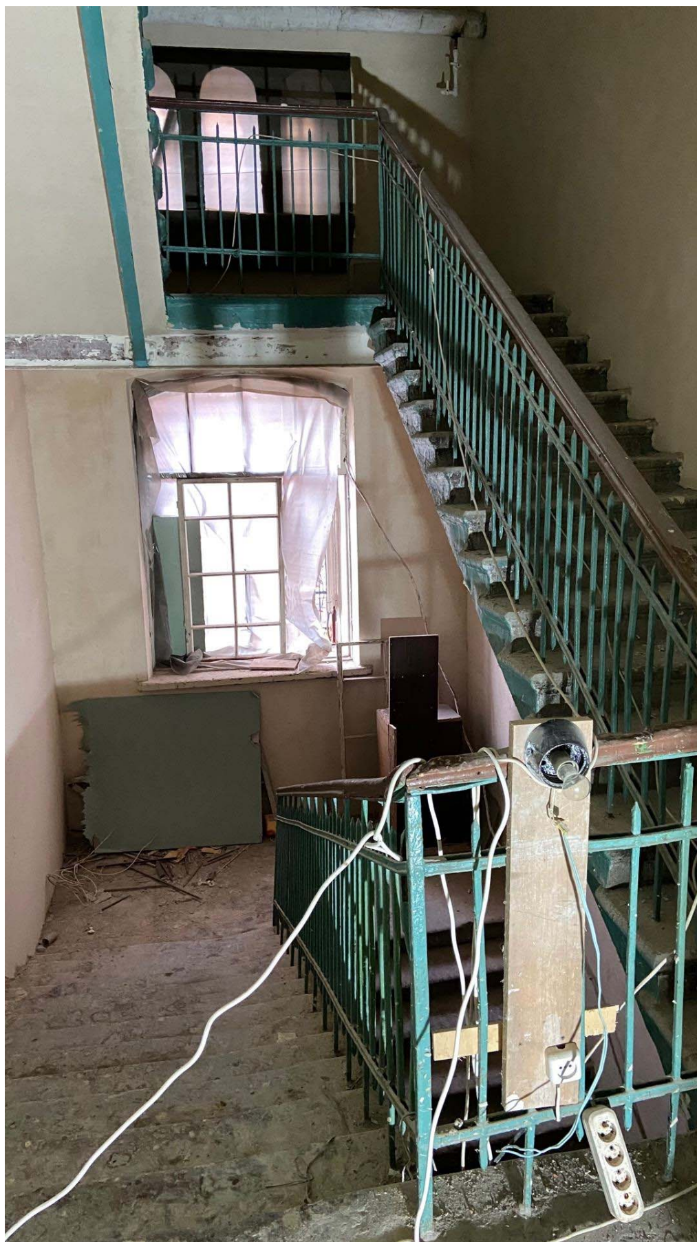
Фото 13. Вид на помещение лестничной клетки 2ЛК. Фото 10.06.2023 г.
