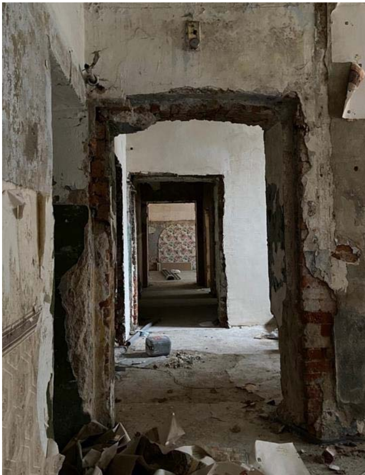
Фото 4. Вид на помещения кв. 1, кв. 3. Фото 10.06.2023 г.
