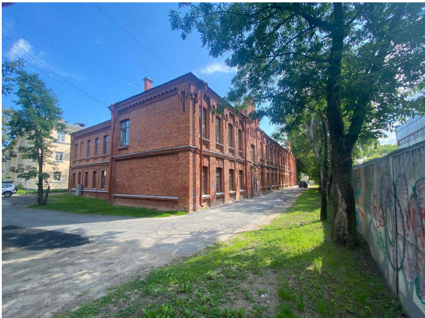
Фото 1. Общий вид здания с юго-западного угла. Фото 10.06.2023 г.
