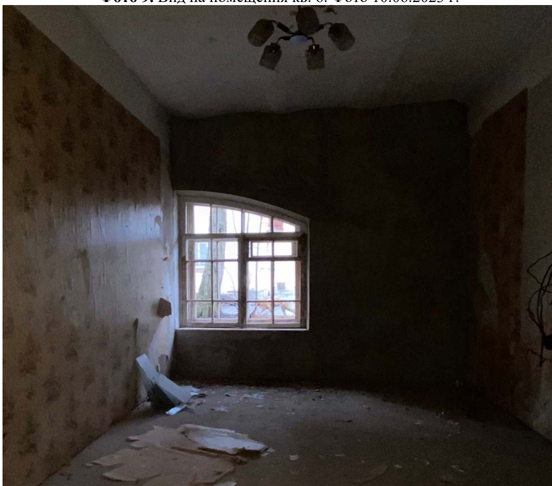
Фото 10. Вид на оконное заполнение кв. 2. Фото 10.06.2023 г.
