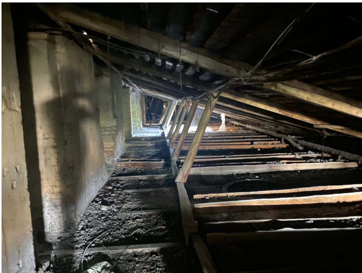
Фото 14. Вид на помещение неотапливаемого чердака. Фото 10.06.2023 г.
