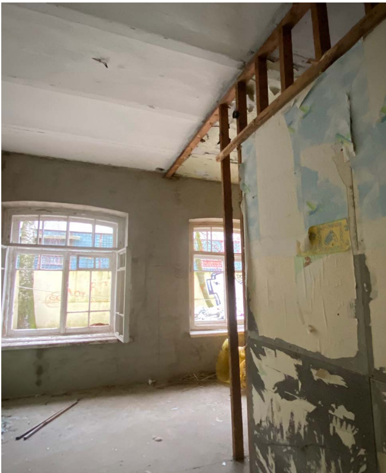
Фото 7. Вид на помещения кв. 7. Фото 10.06.2023 г.
