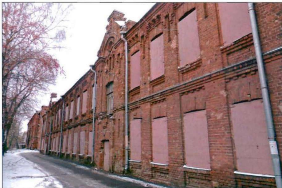
2. Общий вид с юго-востока.
