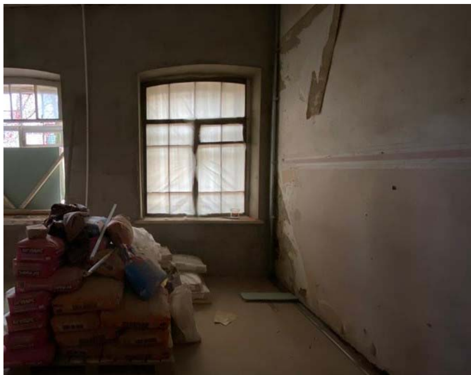
Фото 9. Вид на помещения кв. 6. Фото 10.06.2023 г.
