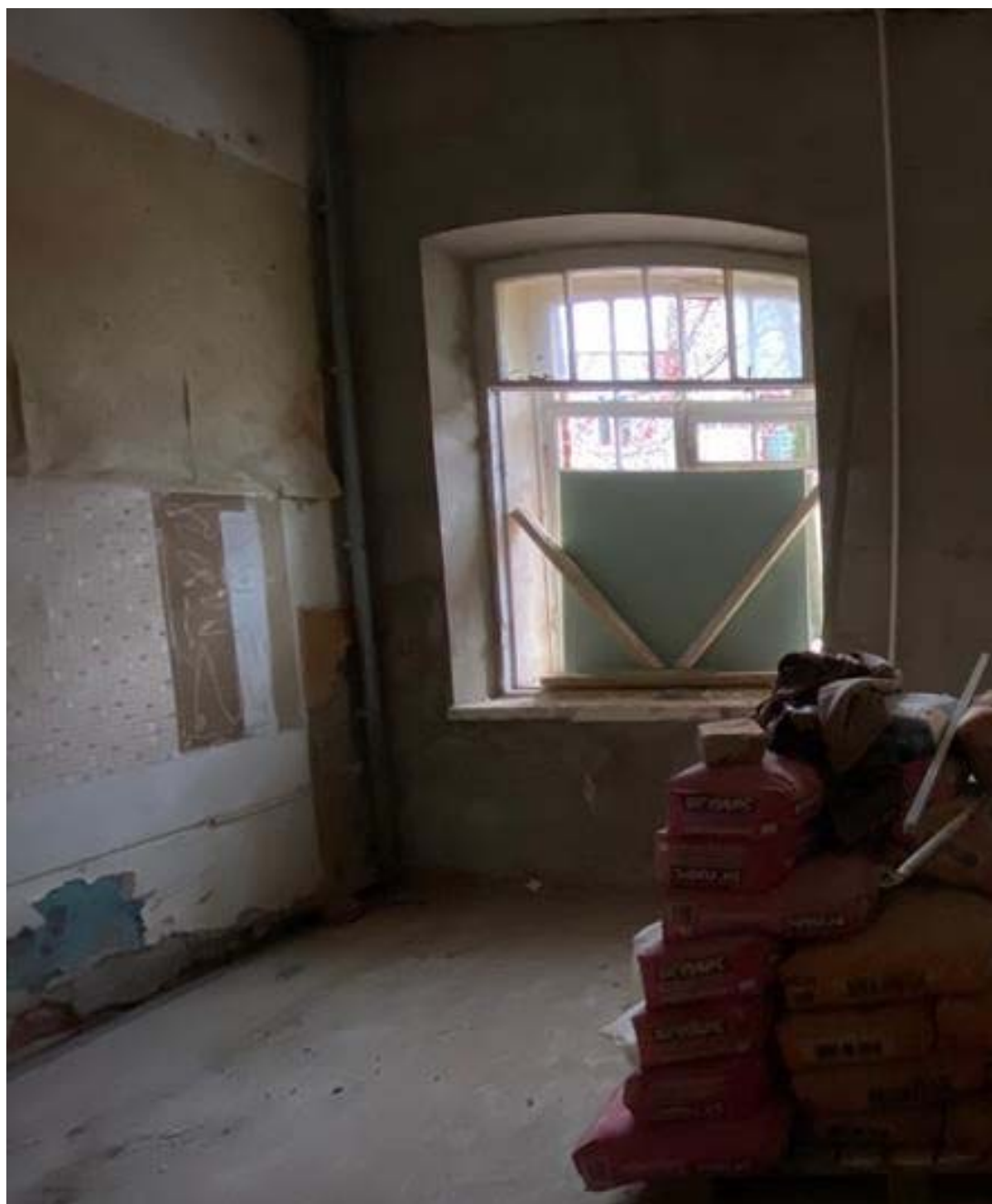
Фото 8. Вид на помещения кв. 6. Фото 10.06.2023 г.
