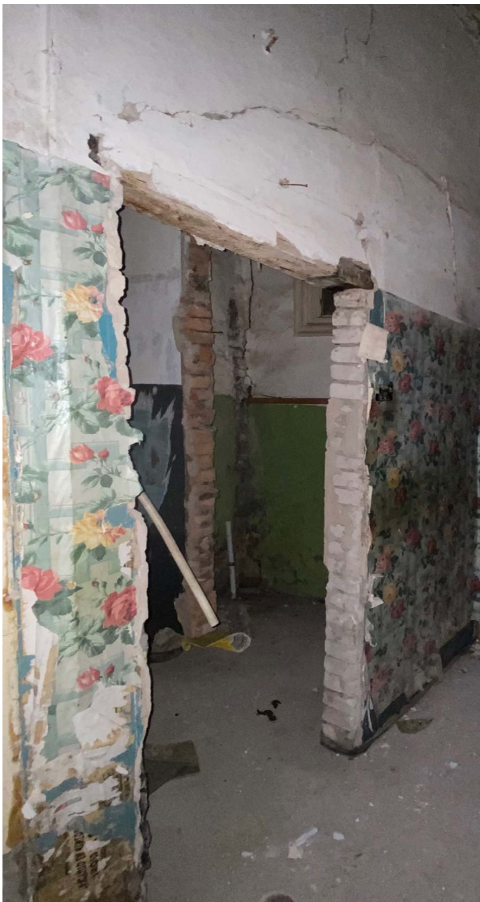
Фото 6. Вид на помещения кв. 4. Фото 10.06.2023 г.
