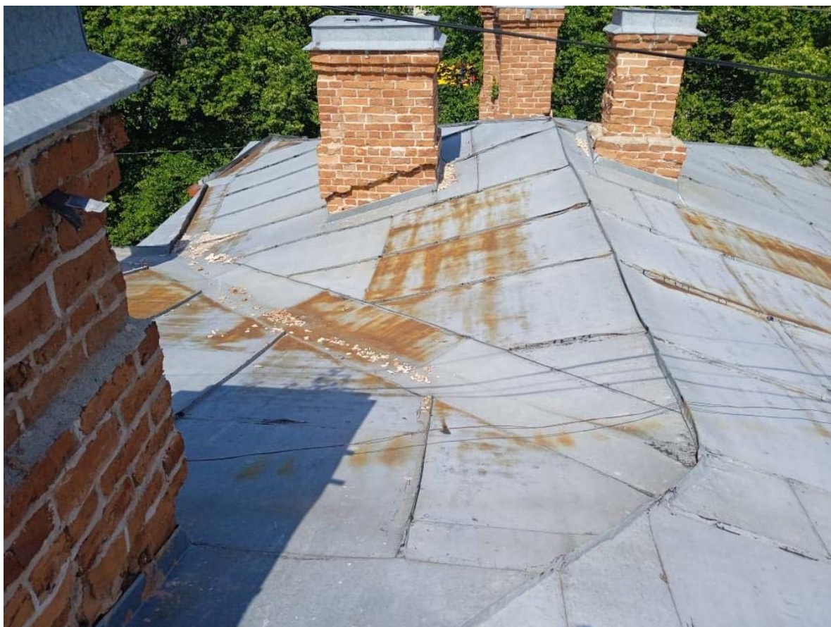
Фото 16. Вид на крышу здания. Фото 10.06.2023 г.
