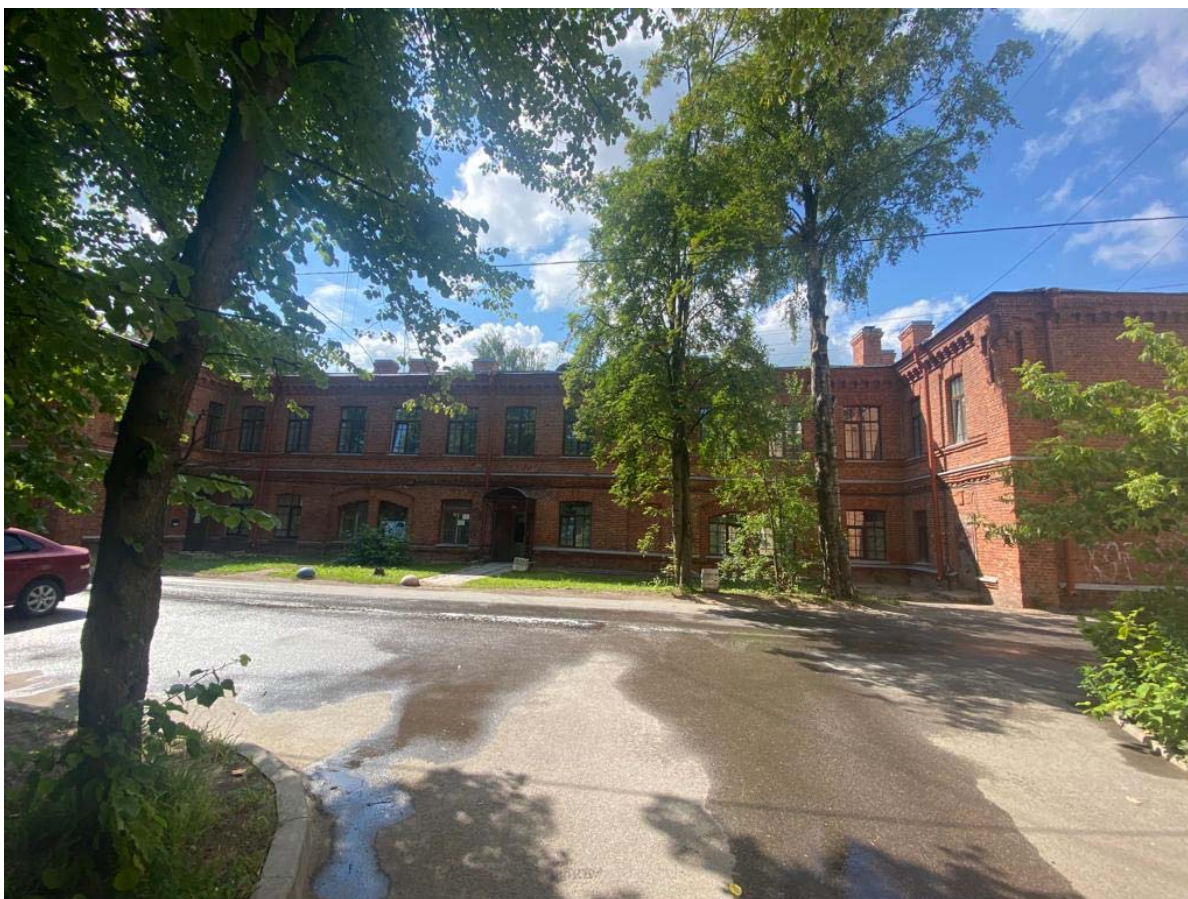
Фото 2. Общий вид здания с северной стороны. Фото 10.06.2023 г.
