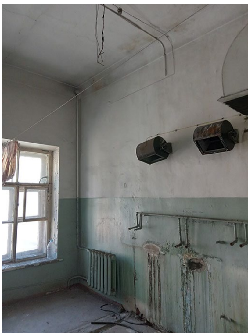
Фото 86. Выявленный объект культурного наследия «Здание детского приюта вел. кн. Александры Николаевны (со служебными постройками)» по адресу: г. Санкт-Петербург, Лермонтовский пр. 51, 12-я Красноармейская б/№
