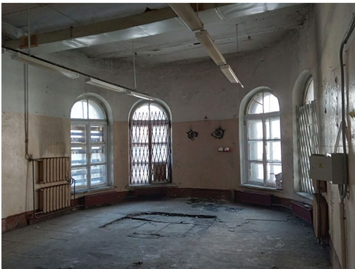
Фото 64. Выявленный объект культурного наследия «Здание детского приюта вел. кн. Александры Николаевны (со служебными постройками)» по адресу: г. Санкт-Петербург, Лермонтовский пр. 51, 12-я Красноармейская б/№
