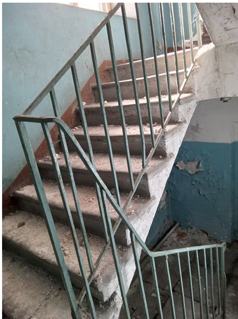
Фото 47. Выявленный объект культурного наследия «Здание детского приюта вел. кн. Александры Николаевны (со служебными постройками)» по адресу: г. Санкт-Петербург, Лермонтовский пр. 51, 12-я Красноармейская б/№
