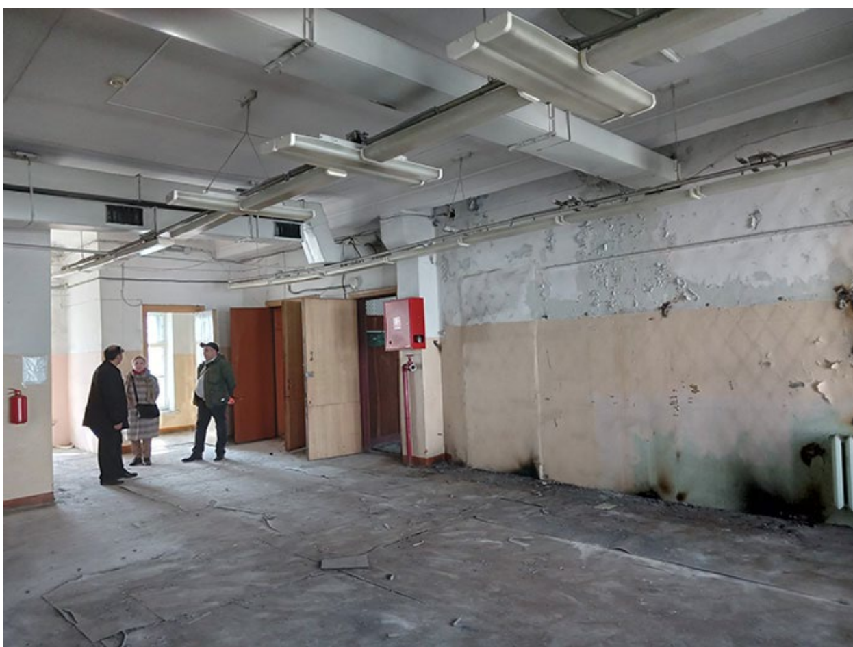
Фото 80. Выявленный объект культурного наследия «Здание детского приюта вел. кн. Александры Николаевны (со служебными постройками)» по адресу: г. Санкт-Петербург, Лермонтовский пр. 51, 12-я Красноармейская б/№
