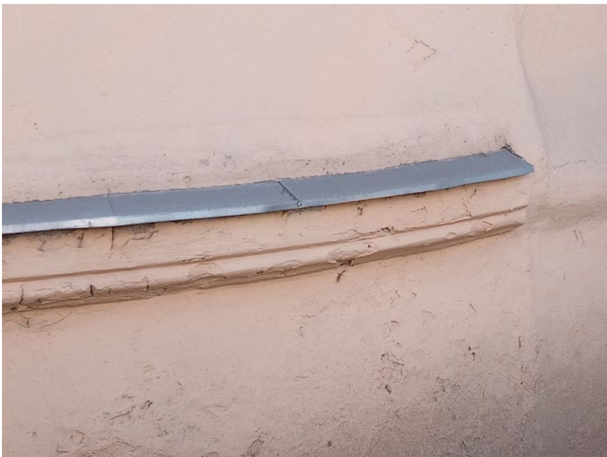
Фото 38. Выявленный объект культурного наследия «Здание детского приюта вел. кн. Александры Николаевны (со служебными постройками)» по адресу: г. Санкт-Петербург, Лермонтовский пр. 51, 12-я Красноармейская б/№
