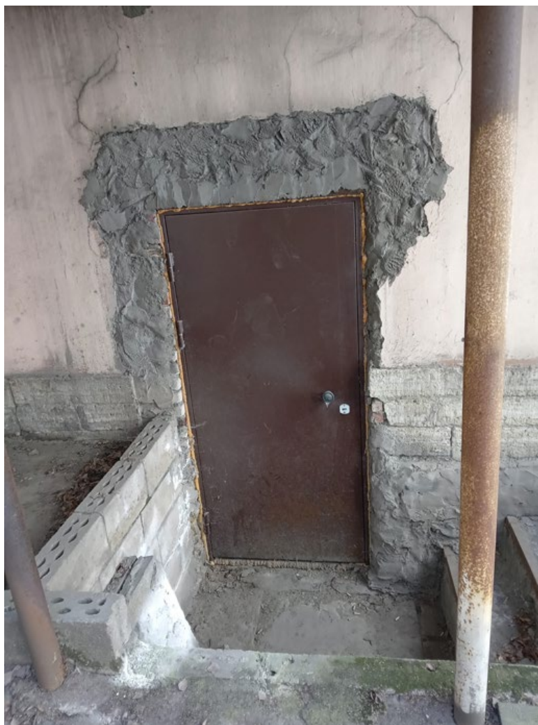
Фото 20. Выявленный объект культурного наследия «Здание детского приюта вел. кн. Александры Николаевны (со служебными постройками)» по адресу: г. Санкт-Петербург, Лермонтовский пр. 51, 12-я Красноармейская б/№
