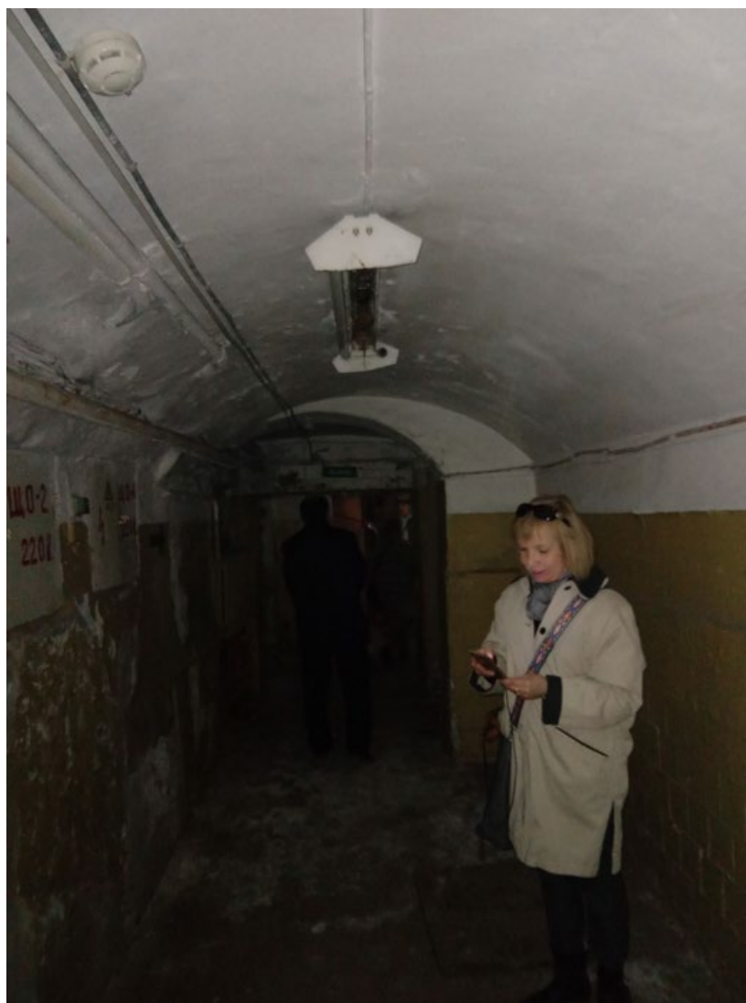
Фото 45. Выявленный объект культурного наследия «Здание детского приюта вел. кн. Александры Николаевны (со служебными постройками)» по адресу: г. Санкт-Петербург, Лермонтовский пр. 51, 12-я Красноармейская б/№
