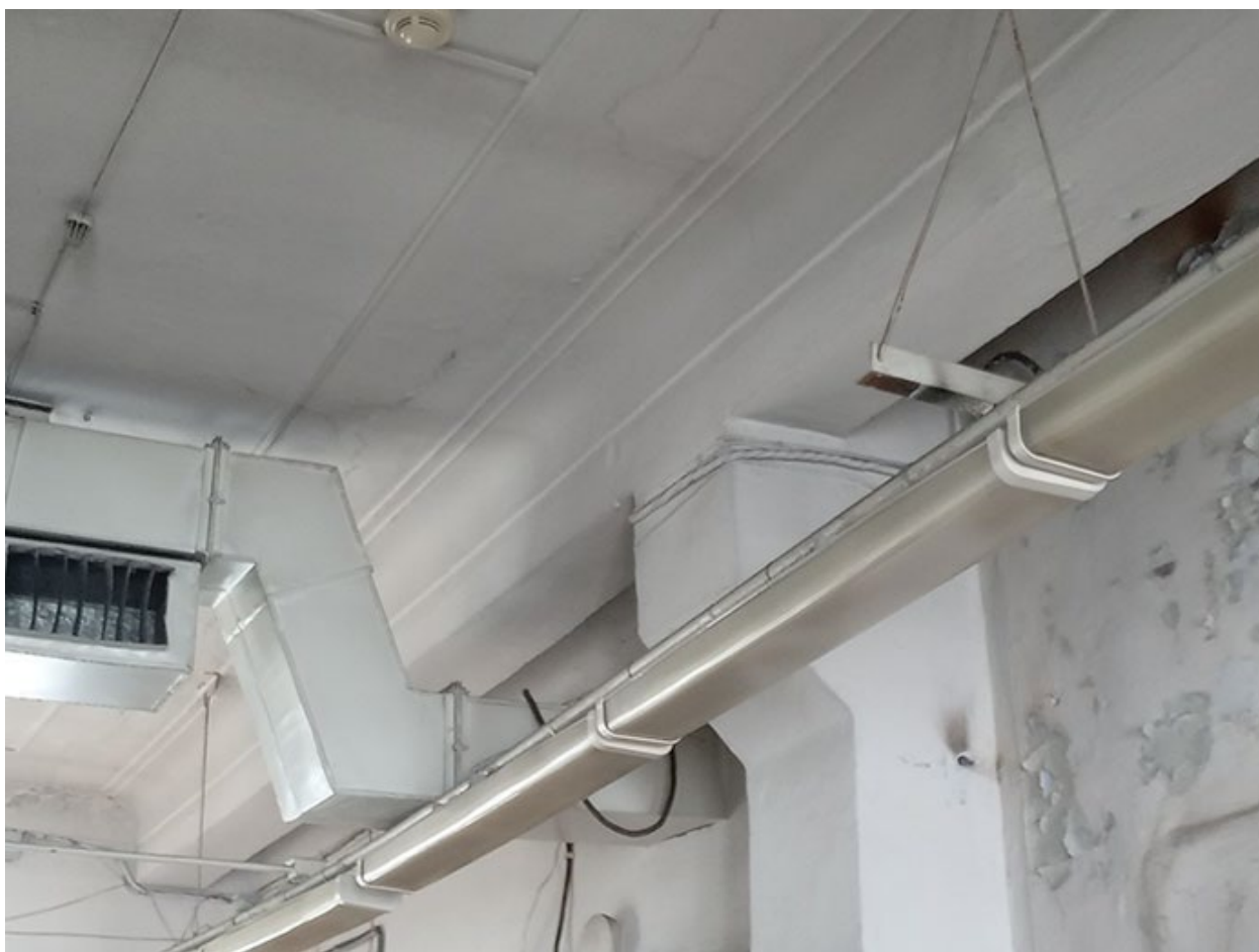
Фото 81. Выявленный объект культурного наследия «Здание детского приюта вел. кн. Александры Николаевны (со служебными постройками)» по адресу: г. Санкт-Петербург, Лермонтовский пр. 51, 12-я Красноармейская б/№
