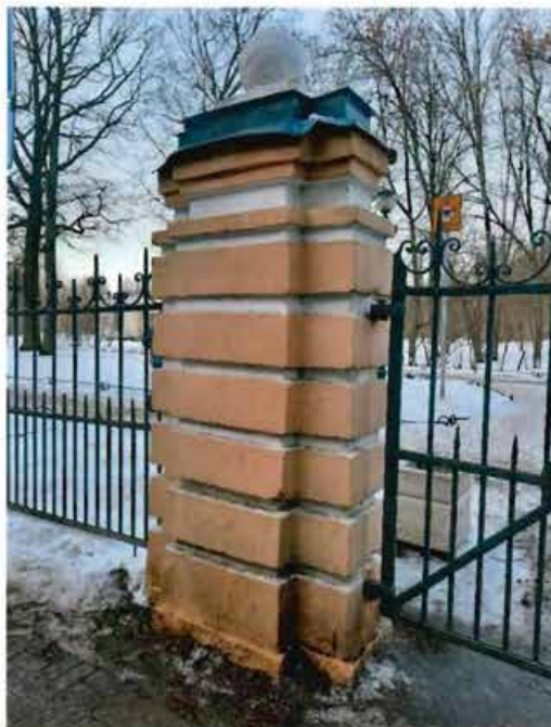
Фото 5: фрагмент объекта культурного наследия. Ворота по Таврической ул. (Вид со стороны Таврической ул.).
