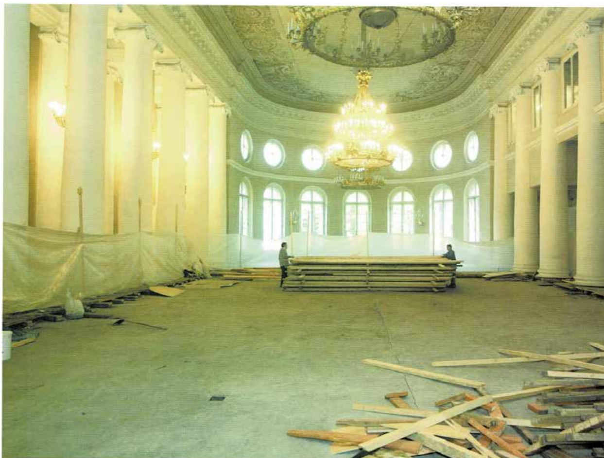
Рис.19. Реставрация Екатерининского зала в 2005 г.
