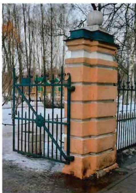
Фото 4: фрагмент объекта культурного наследия. Ворота по Таврической ул. (Вид со стороны Таврической ул.).
