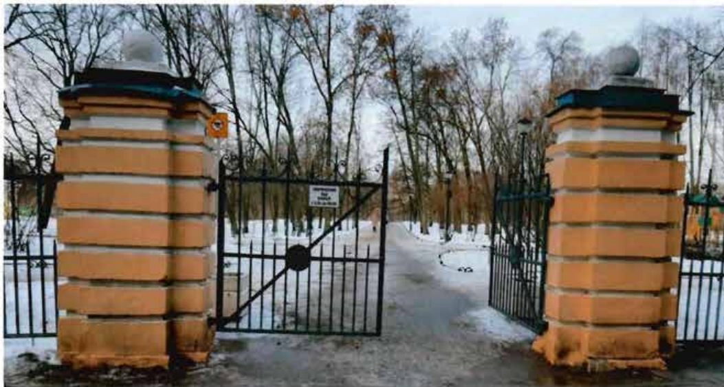
Фото 3: фрагмент объекта культурного наследия. Ворота по Таврической ул. (Вид со стороны Таврической ул.).
