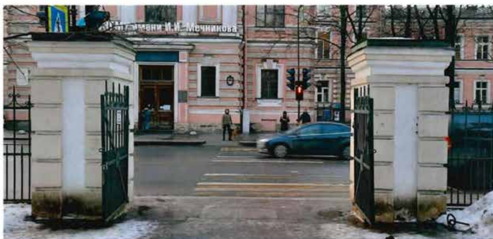
Фото 10: фрагмент объекта культурного наследия. Ворота по Кирочной ул. (Вид со стороны объекта культурного наследия федерального значения «Сад Таврический с прудом»).
