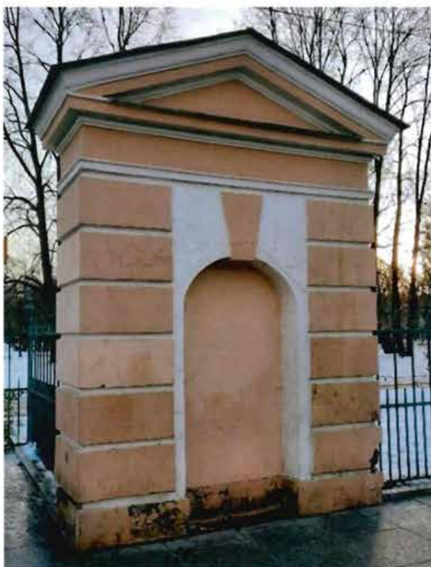
Фото 16: фрагмент объекта культурного наследия по Потемкинской ул.
