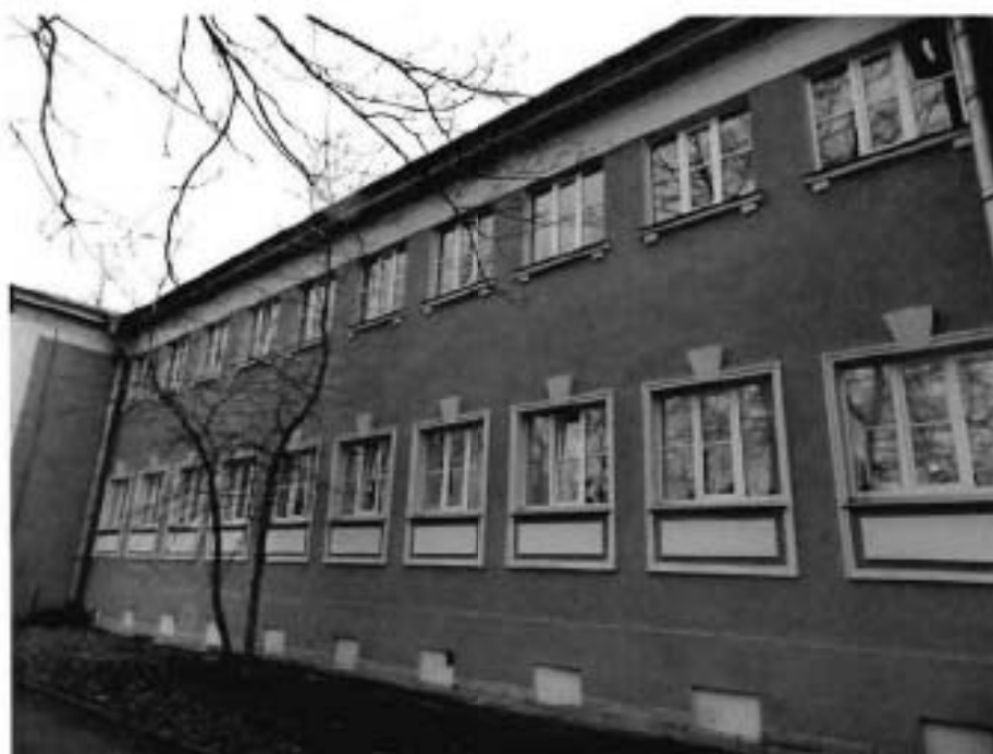
2. Фрагмент восточного фасада
