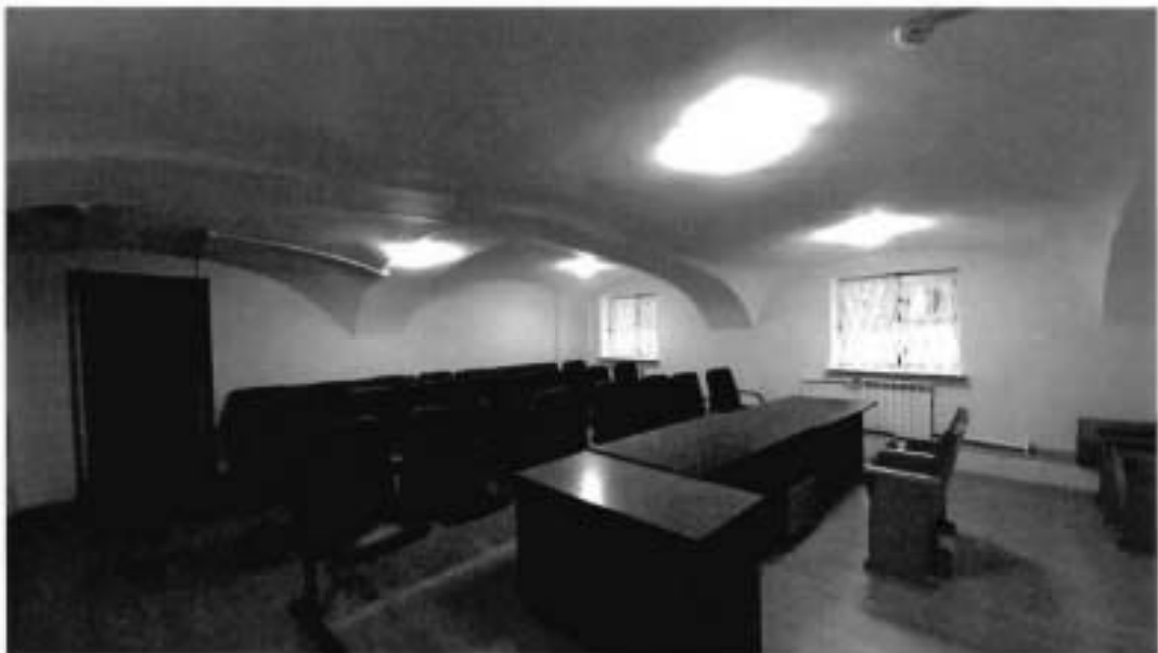
5. Своды в уровне цокольного этажа
