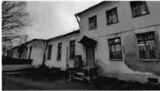
1. Фрагмент восточного фасада
