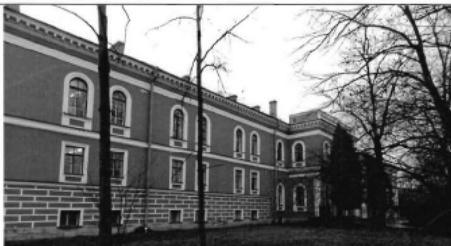
1. Фрагмент лицевого фасада
