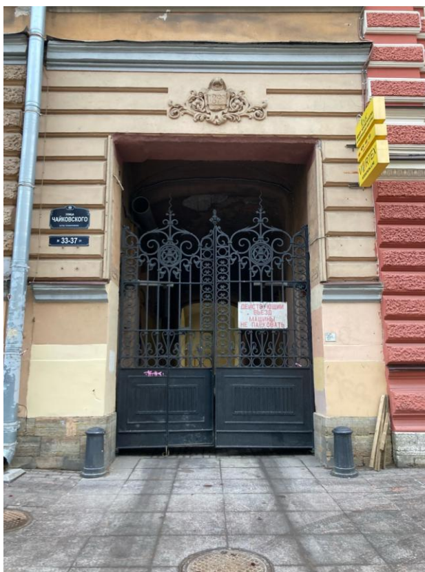
Фото 6. Фрагмент лицевого фасада выявленного объекта культурного наследия «Дом, в котором в 1944-1978 годах жил артист В.В. Меркурьев», воротный проезд
