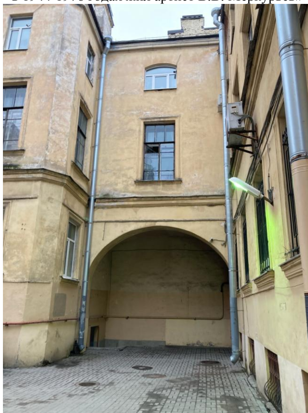
Фото 4. Фрагмент дворового фасада выявленного объекта культурного наследия «Дом, в котором в 1944-1978 годах жил артист В.В. Меркурьев», воротный проезд на ул. Чайковского
