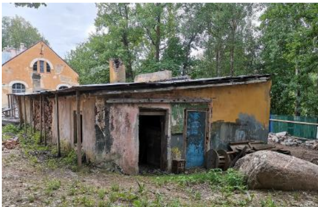
2. Выявленный объект культурного наследия «Павловская электрическая станция (с 2 службами и оградой)» (Санкт-Петербург, г. Павловск, ул. Надгорная, д. 16 лит. А, Б; д. 16а лит. А). Служба, д. 16 лит. Б. Общий вид.
