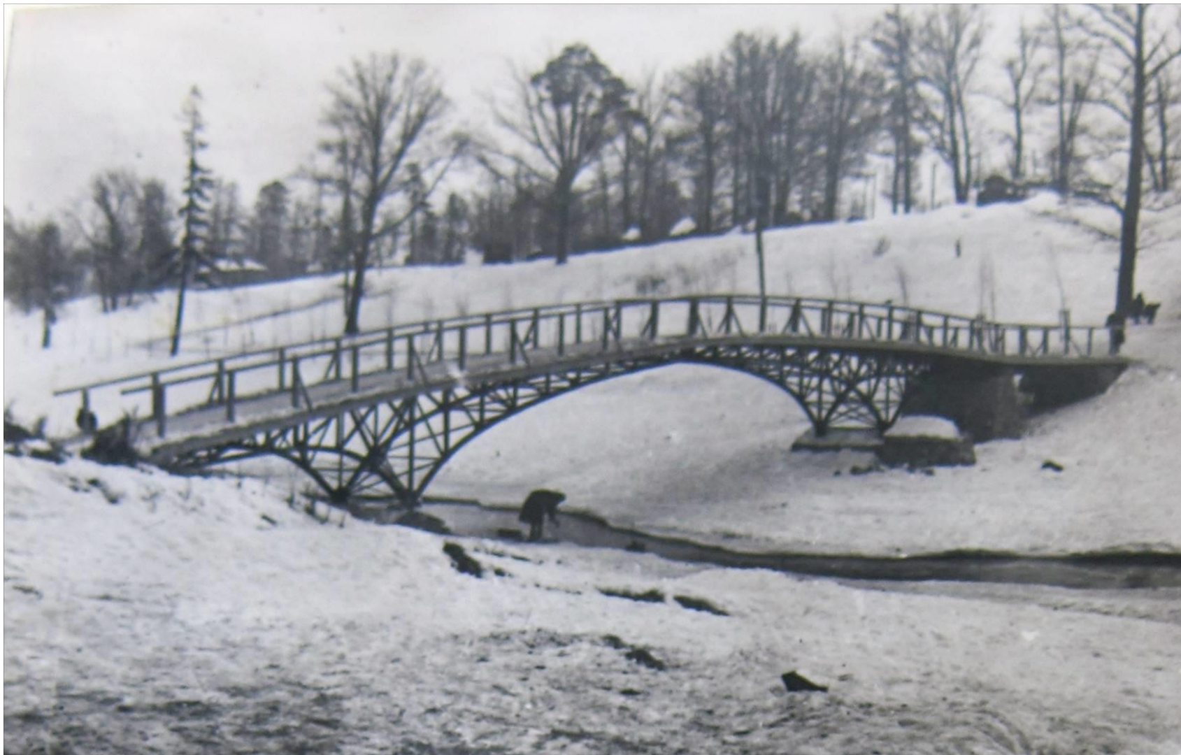
Илл. 102. Вновь сооруженный мост на р. Славянке у Электростанции. Фотография нач. 1950-х гг. – Громова Н.И. Исследование по истории развития бывших районов Павловского парка. 1-я Заречная часть г. Павловска. (Илл. 193). Л. 1953. (на правах рукописи). ГМЗ «Павловск», 3363/1.
