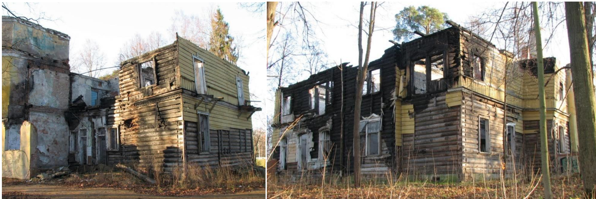
Илл. 97, 98. Дача Панфилова – Дача Трута – Санаторий «Юный водник» (Павловск. Красного Курсанта ул., 11/Мариентальский парк, 23). Фотография. 2011 г. URL: http://www.citywalls.ru/house25788.html .
