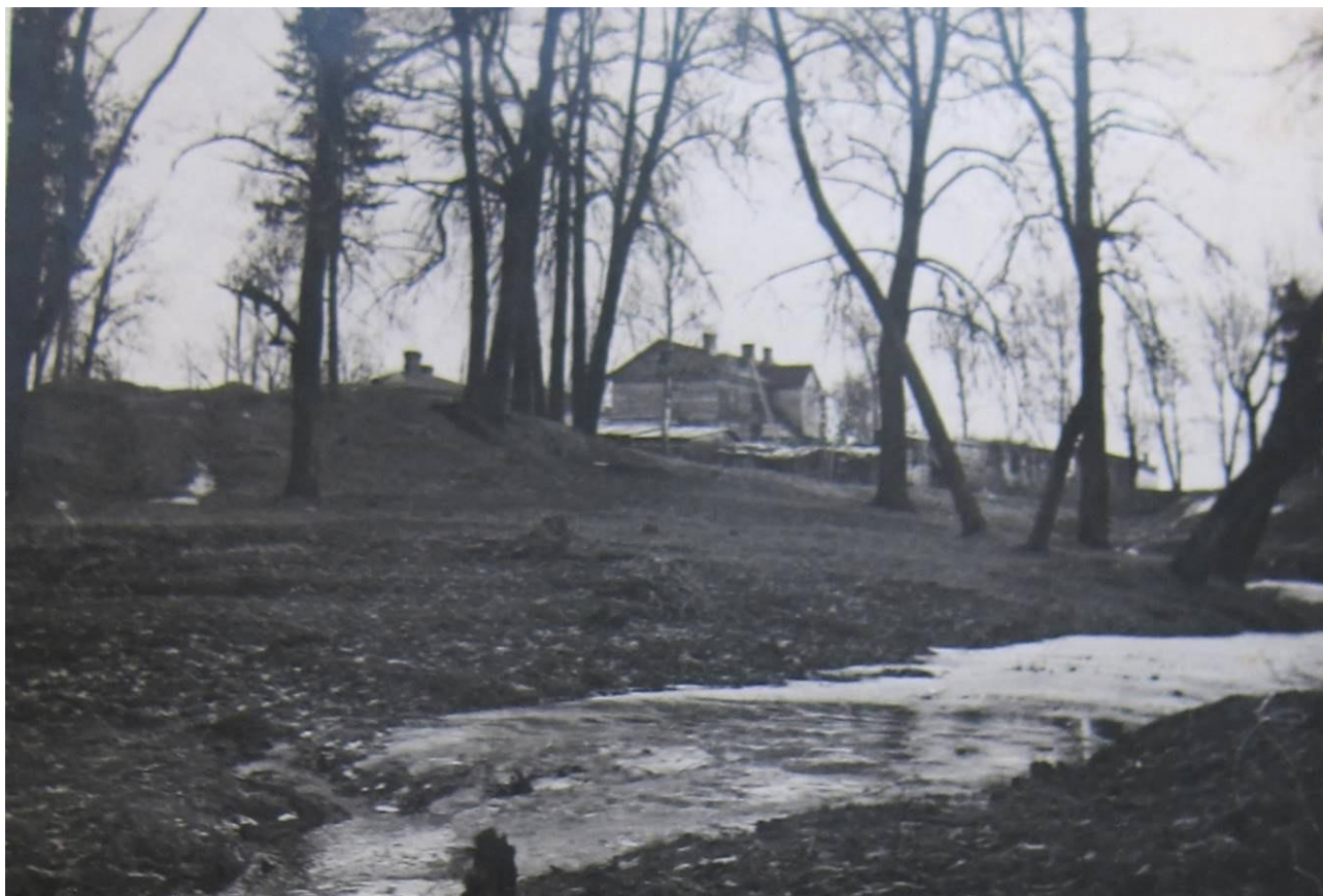
Илл. 103. Вид на устье первого оврага со стороны Павловского дворца. Плато между первым и вторым оврагами. Полуразрушенные постройки дачи Горковенко. Фотография. 1951 г. ГМЗ «Павловск». Нег. № 22623.
