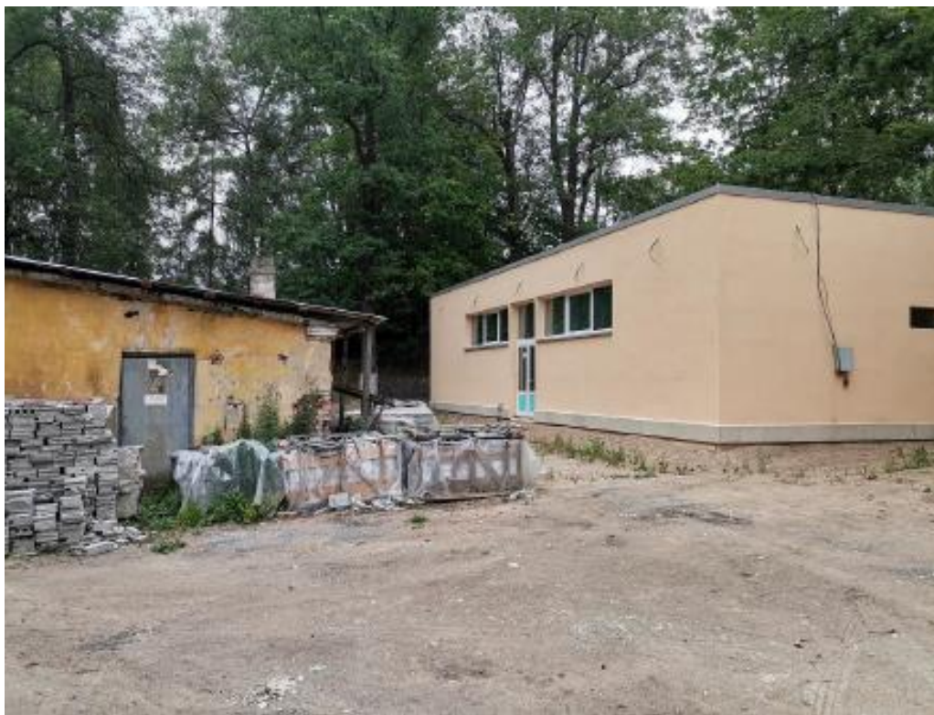
3. Выявленный объект культурного наследия «Павловская электрическая станция (с 2 службами и оградой)» (Санкт-Петербург, г. Павловск, ул. Надгорная, д. 16 лит. А, Б; д. 16а лит. А). Территория и служба, д. 16 лит. Б. Общий вид.
