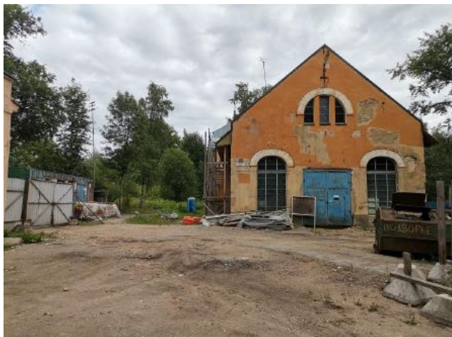
6. Выявленный объект культурного наследия «Павловская электрическая станция (с 2 службами и оградой)» (Санкт-Петербург, г. Павловск, ул. Надгорная, д. 16 лит. А, Б; д. 16а лит. А). Главное здание. Северо-западный фасад.
