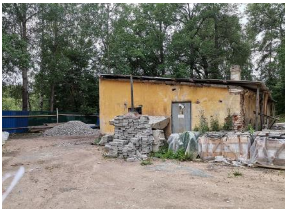
4. Выявленный объект культурного наследия «Павловская электрическая станция (с 2 службами и оградой)» (Санкт-Петербург, г. Павловск, ул. Надгорная, д. 16 лит. А, Б; д. 16а лит. А). Территория и служба, д. 16 лит. Б. Общий вид.
