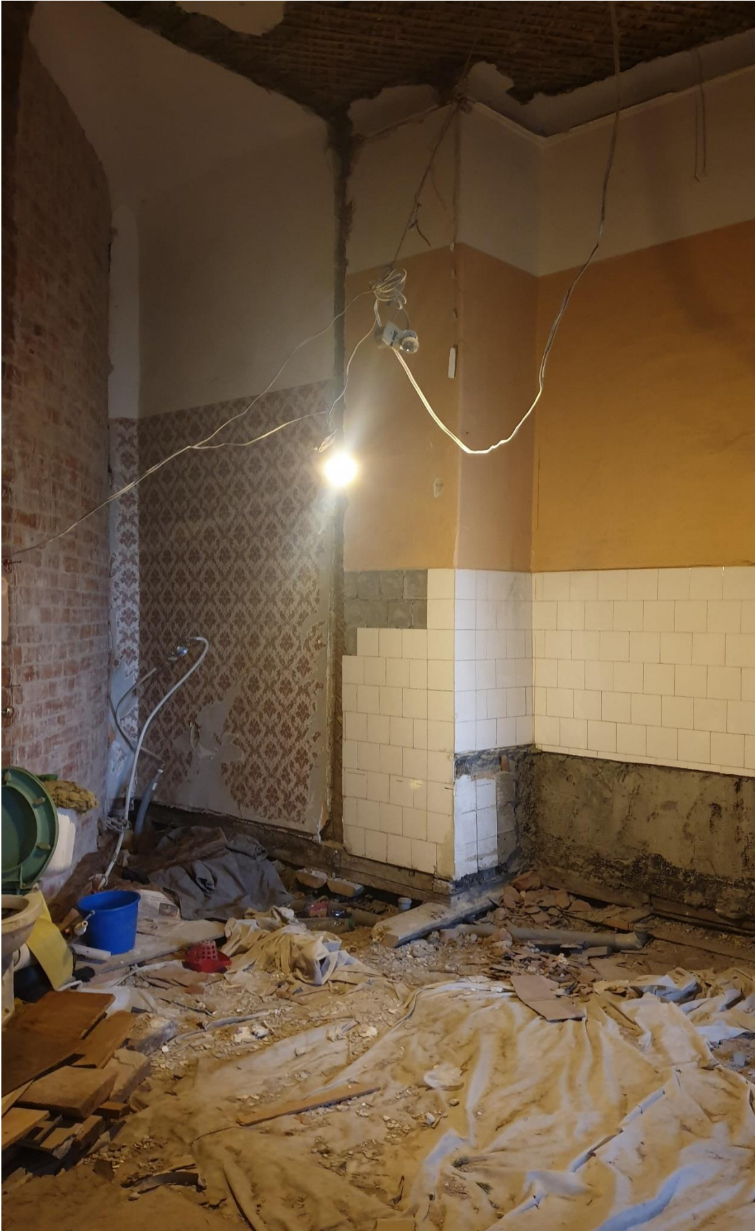
Фото 6. Объект культурного наследия регионального значения «Дом Л.Л.Кенига», расположенного по адресу: Санкт-Петербург, ул.Блохина, д. 2/77, лит.А. Квартира 43. Помещения 6, 2 (перегородки, формирующие помещения, демонтированы).
