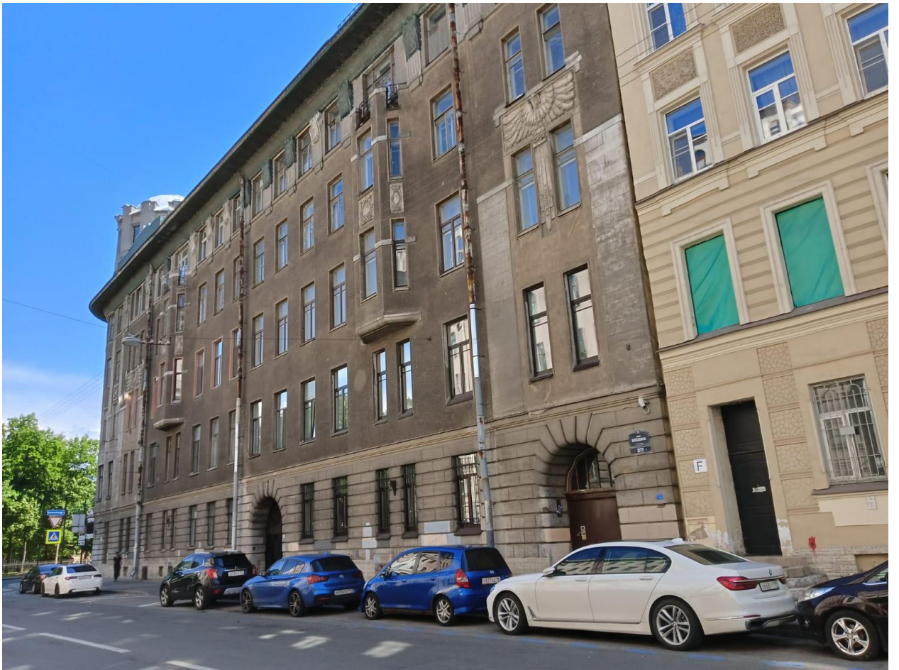
Фото 3. Объект культурного наследия регионального значения «Дом Л.Л.Кенига», расположенного по адресу: Санкт-Петербург, ул.Блохина, д. 2/77, лит.А. Северный фасад.
