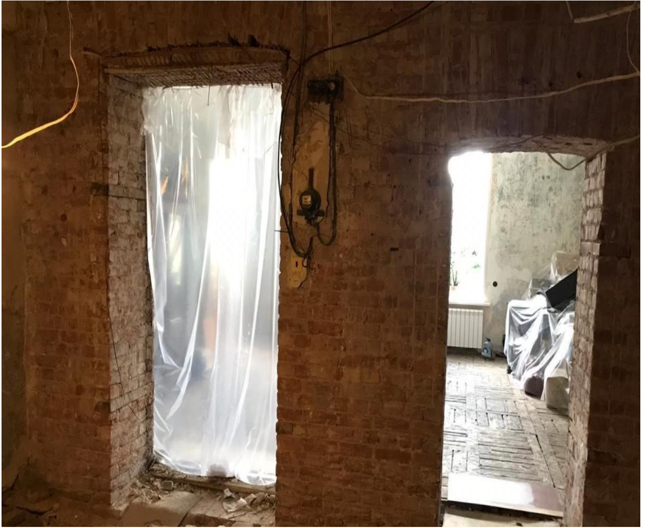
Фото 8. Объект культурного наследия регионального значения «Дом Л.Л.Кенига», расположенного по адресу: Санкт-Петербург, ул.Блохина, д. 2/77, лит.А. Квартира 43. Проемы из помещения 1 в помещения 3, 4.
