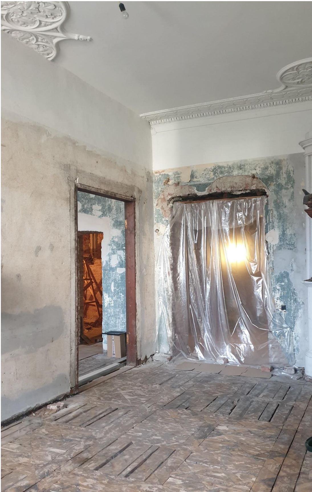
Фото 10. Объект культурного наследия регионального значения «Дом Л.Л.Кенига», расположенного по адресу: Санкт-Петербург, ул.Блохина, д. 2/77, лит.А. Квартира 43. Помещение 3.
