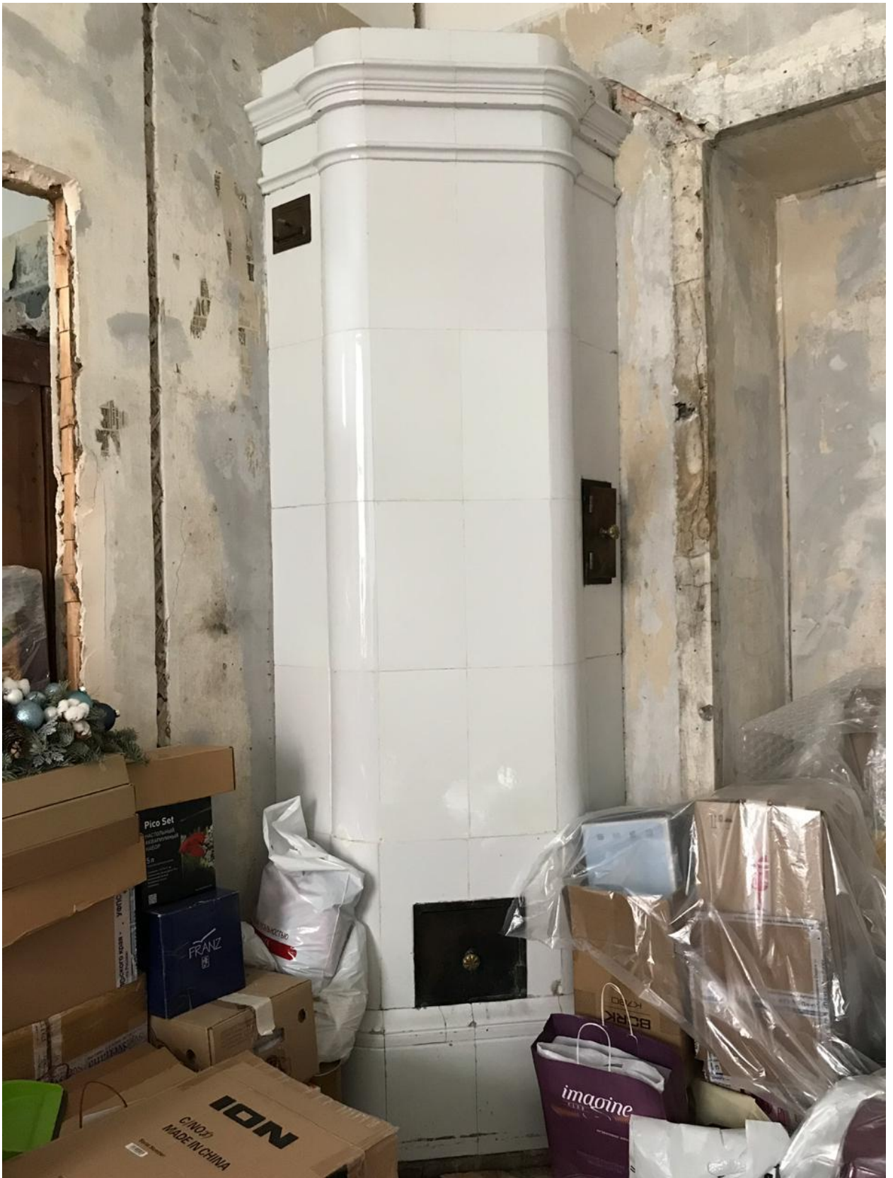
Фото 12. Объект культурного наследия регионального значения «Дом Л.Л.Кенига», расположенного по адресу: Санкт-Петербург, ул.Блохина, д. 2/77, лит.А. Квартира 43. Помещение 7. Печь угловая.
