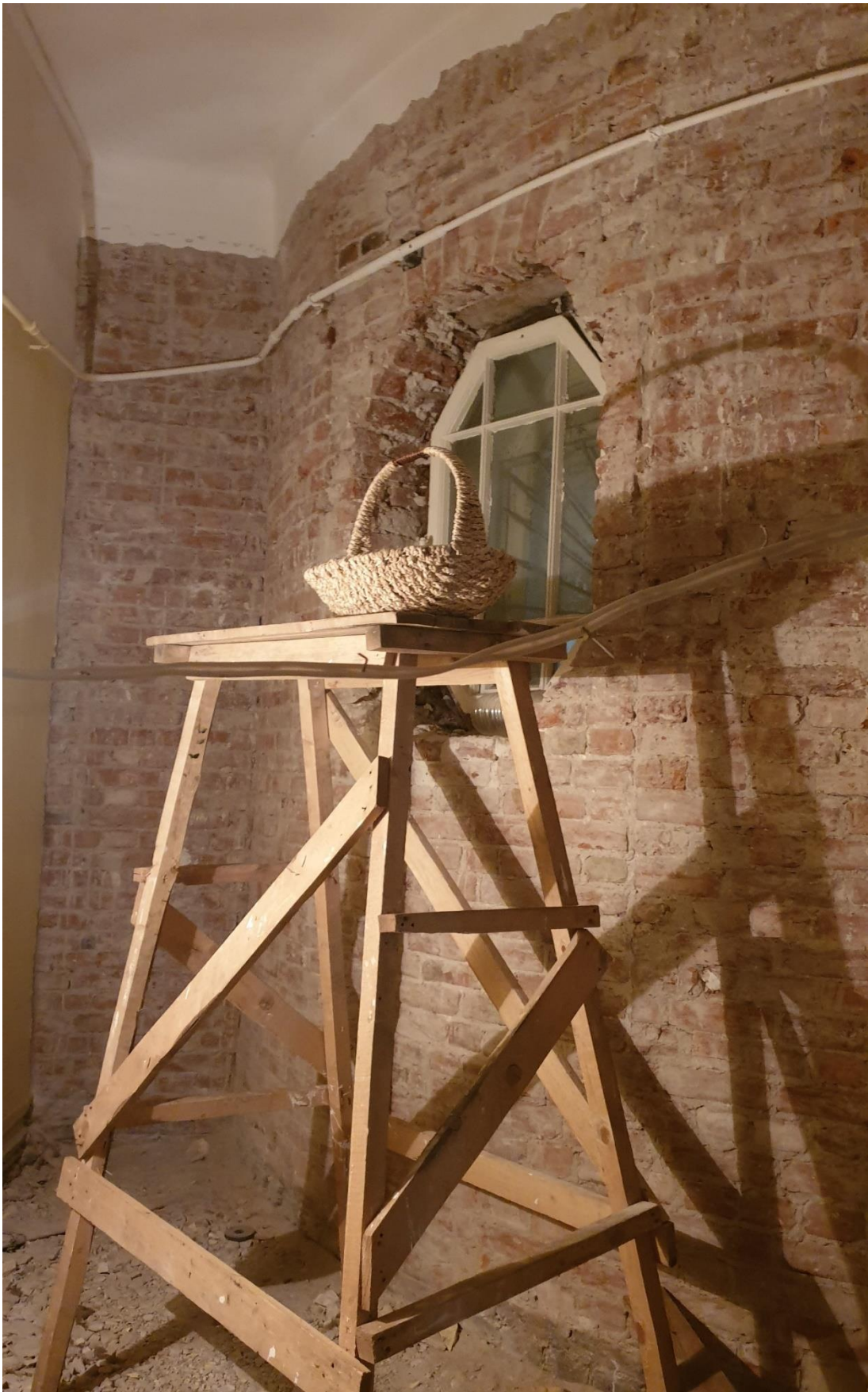
Фото 5. Объект культурного наследия регионального значения «Дом Л.Л.Кенига», расположенного по адресу: Санкт-Петербург, ул.Блохина, д. 2/77, лит.А. Квартира 43, помещение 5.
