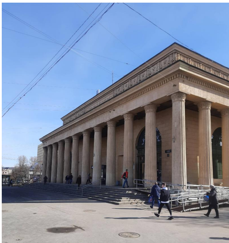
Фото 2. Фасад объекта культурного наследия регионального значения «Станция метро «Кировский завод», г. Санкт-Петербург, пр. Стачек, д. 70, литера А (от 07.04.2023 г.)
