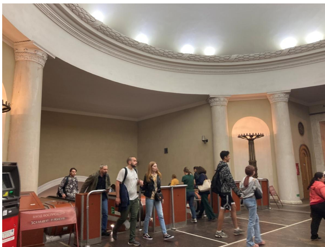
Фото 10 Фрагмент интерьера объекта культурного наследия регионального значения «Станция метро «Кировский завод», г. Санкт-Петербург, пр. Стачек, д. 70, литера А. (наклонный ход) (от 10.07.2023 г.)
