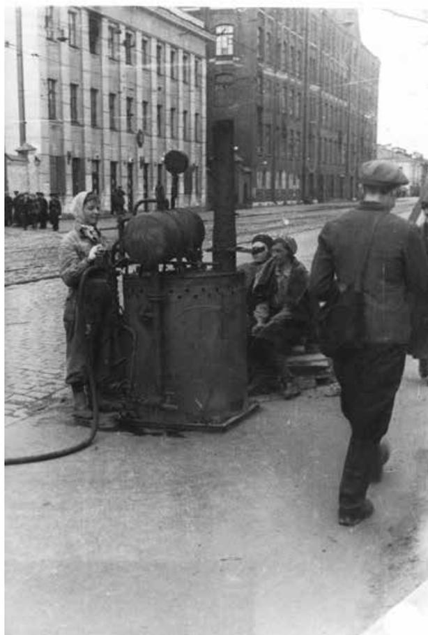
65. Отогревание водопроводных труб во время восстановления водопроводной сети на проспекте Карла Маркса. 1942г. ЦГАКФФД СПб. Ар 25367.
