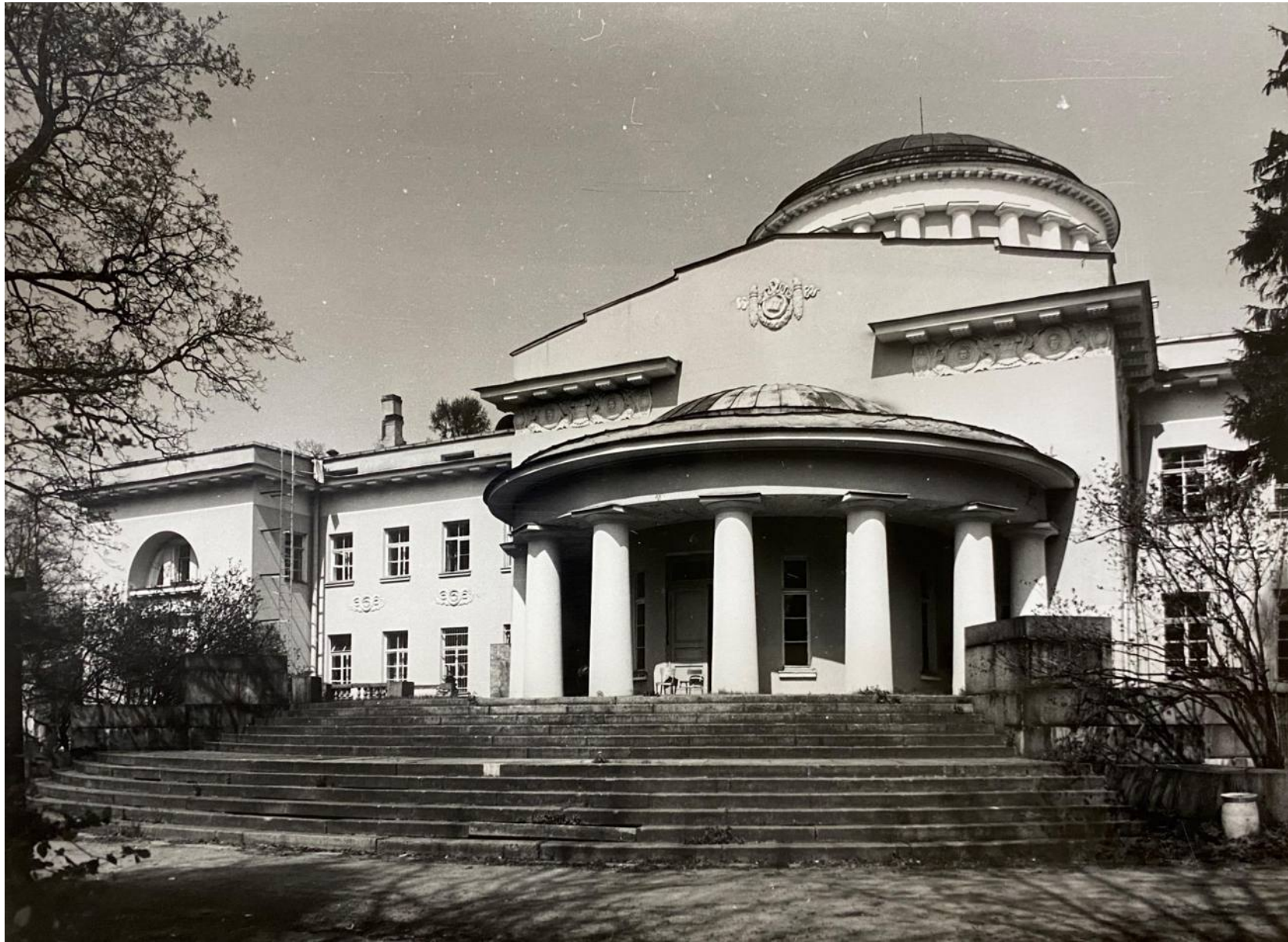
54. Ансамбль усадьбы Шуваловых (Е.А. Воронцовой-Дашковой). Большой дворец. Южный садовый фасад. Центральная часть. Дата: 1985 г. Автор: В.И. Шлакан // Архив КГИОП, № 55301/1-Н.
