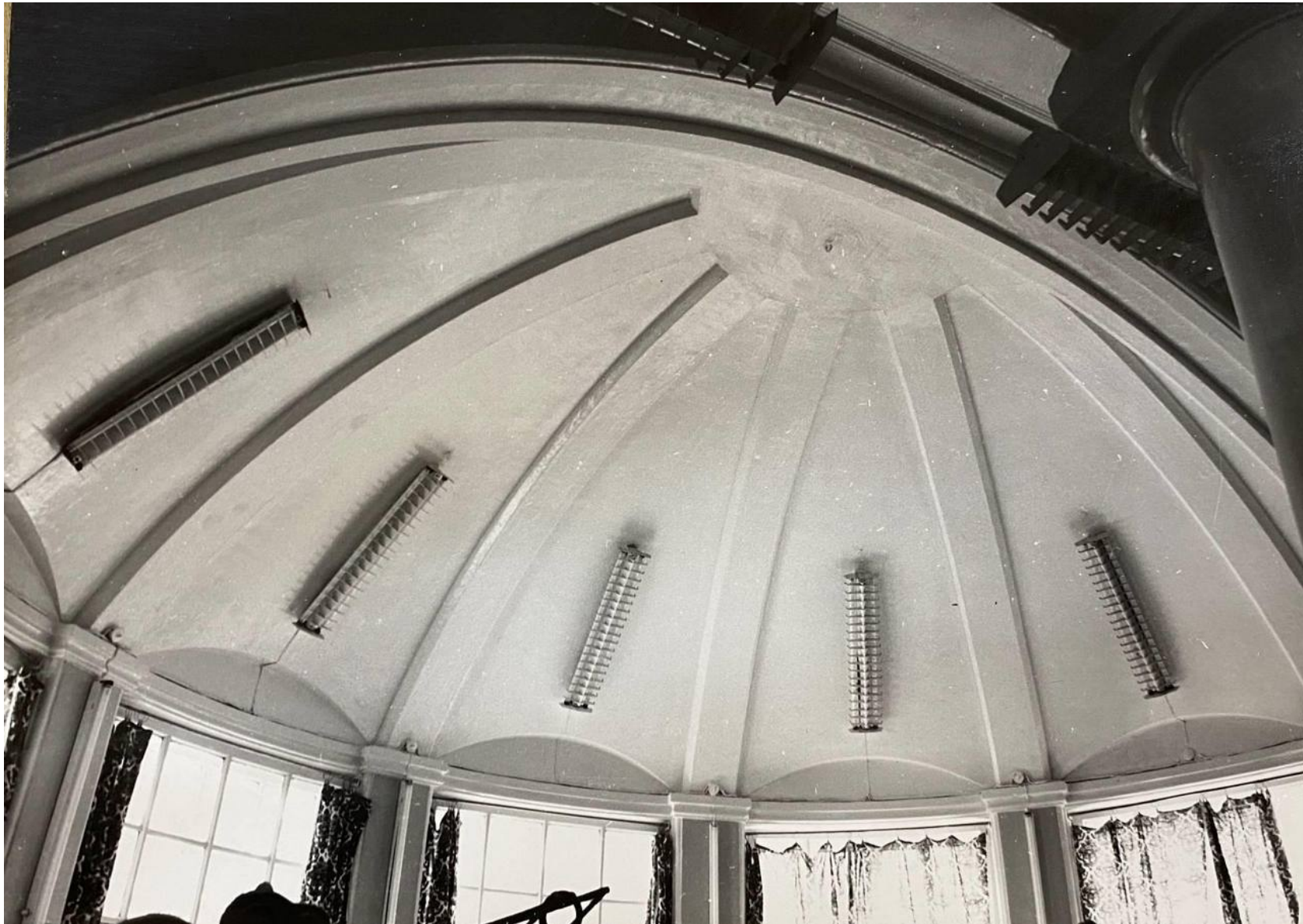
67. Ансамбль усадьбы Шуваловых (Е.А. Воронцовой-Дашковой). Большой дворец. Полуротонда. Интерьер 2-го этажа. Дата: 1985 г. Автор: В.И. Шлакан // Архив КГИОП, № 55324/1-Н.
