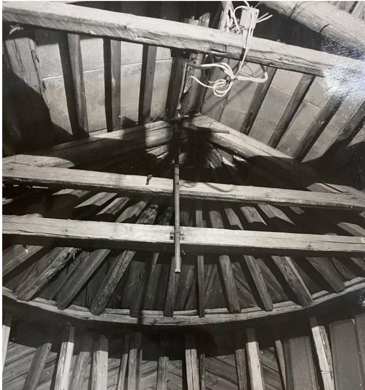
98. Ансамбль усадьбы Шуваловых. Малый дворец («Белый дом»). Полуротонда. Конструкция крыши. Дата: 1985 г. Автор: В.И. Шлакан // Архив КГИОП, № 55325/1-Н.
