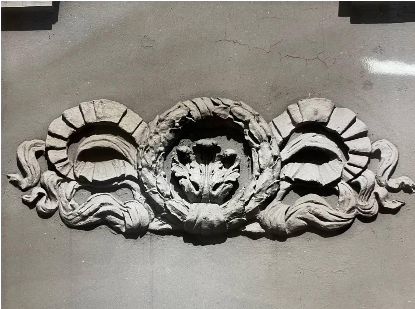
61. Ансамбль усадьбы Шуваловых (Е.А. Воронцовой-Дашковой). Большой дворец. Южный фасад. Лепной декор между окнами 1-го и 2-го этажа. Дата: 1985 г. Автор: В.И. Шлакан // Архив КГИОП, № 55313/1-Н.
