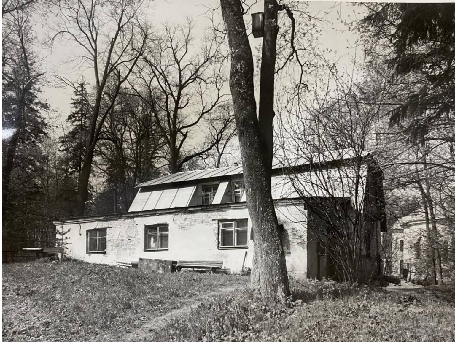
134. Ансамбль усадьбы Шуваловых. Дом садовника. Восточный фасад. Дата: 1985 г. Автор: В.И. Шлакан // Архив КГИОП, № 55364/1-Н.
