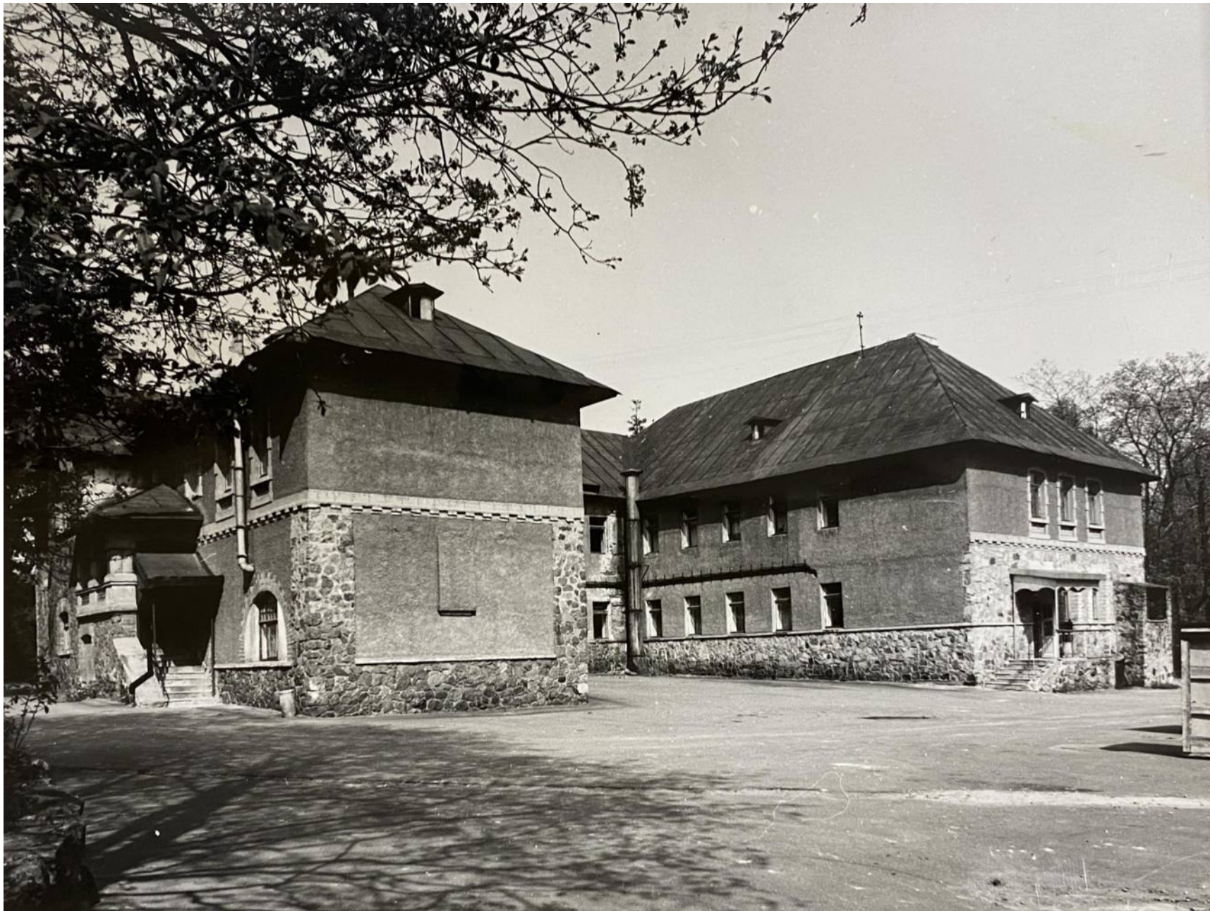
122. Ансамбль усадьбы Щуваловых. Ферма. Общий вид с юго-востока. Дата: 1985 г. Автор: В.И. Шлакан // Архив КГИОП.
