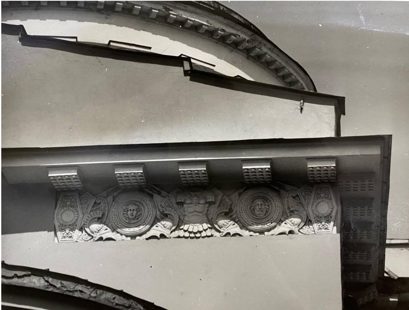
59. Ансамбль усадьбы Шуваловых (Е.А. Воронцовой-Дашковой). Большой дворец. Южный фасад. Центральная часть. Фрагмент фриза и венчающего карниза. Дата: 1985 г. Автор: В.И. Шлакан // Архив КГИОП, № 55311/1-Н.
