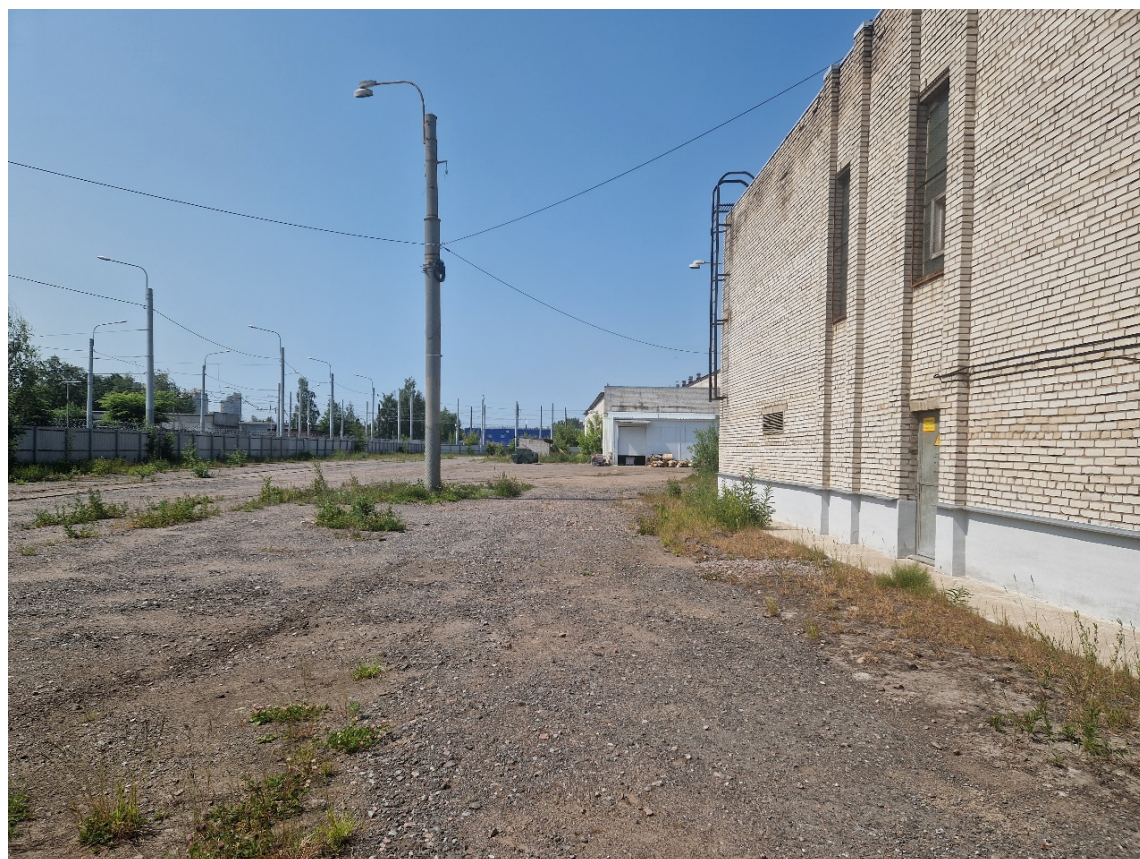
Рис. 13. СПб-2023. Красногвардейский район, Хасанская ул., 9. Общий вид участка обследования. Точка фотофиксации 4. Вид с востока.
