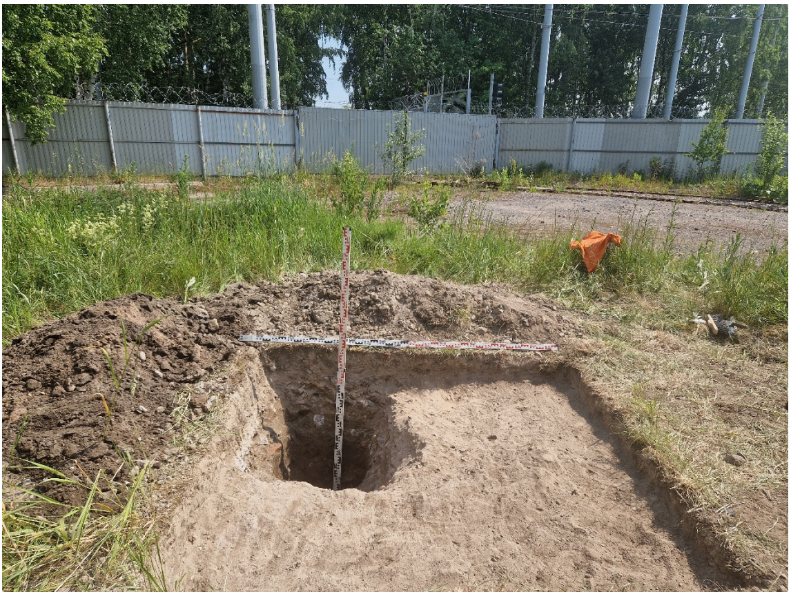
Рис. 19. СПБ-2023. Красногвардейский район, Хасанская ул., 9. Шурф 1. Контрольный прокоп в северо-восточном углу шурфа. Вид с запада.
