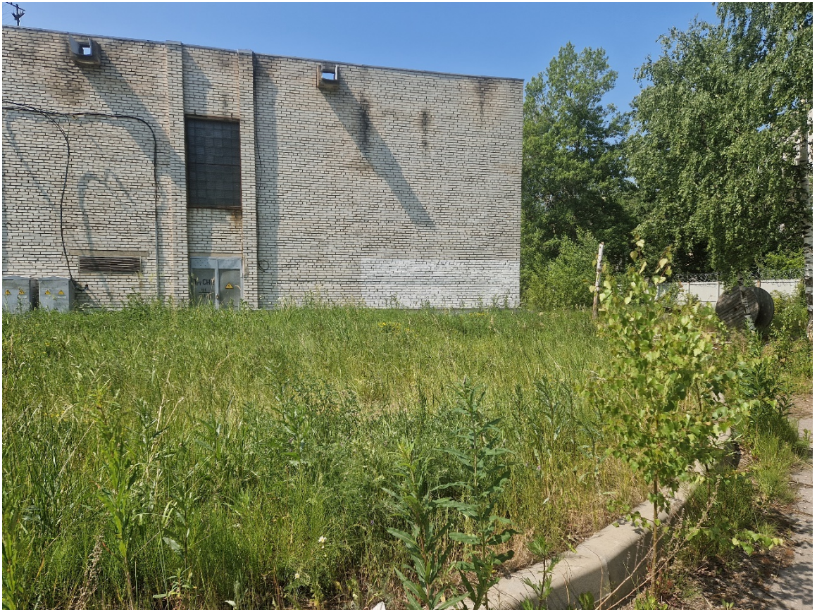
Рис. 10. СПб-2023. Красногвардейский район, Хасанская ул., 9. Общий вид участка обследования. Точка фотофиксации 1. Вид с востока.
