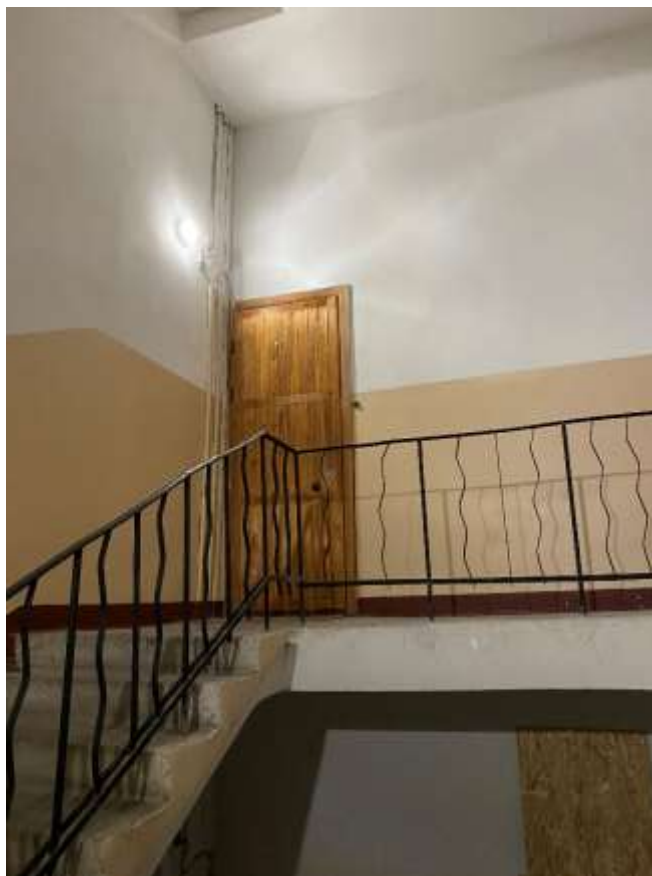
Фото 6. Вход в квартиру № 57 с общедомовой лестничной клетки.
