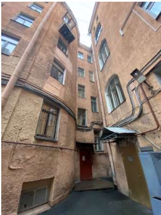
Фото 5. Фрагмент юго-западного дворового фасада. Вид с запада.
