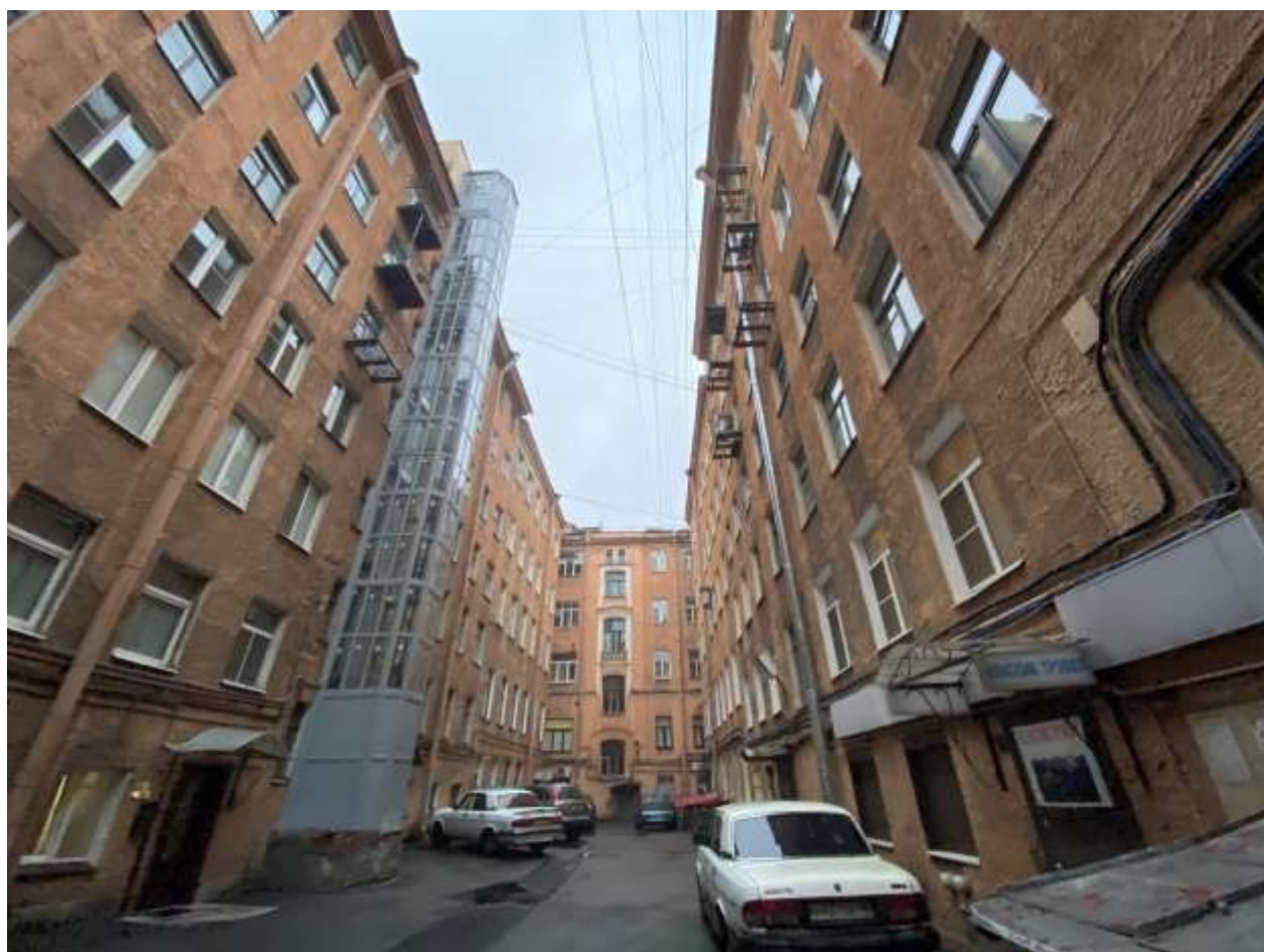
Фото 4. Общий вид дворовых фасадов. Вид с юго-востока.
