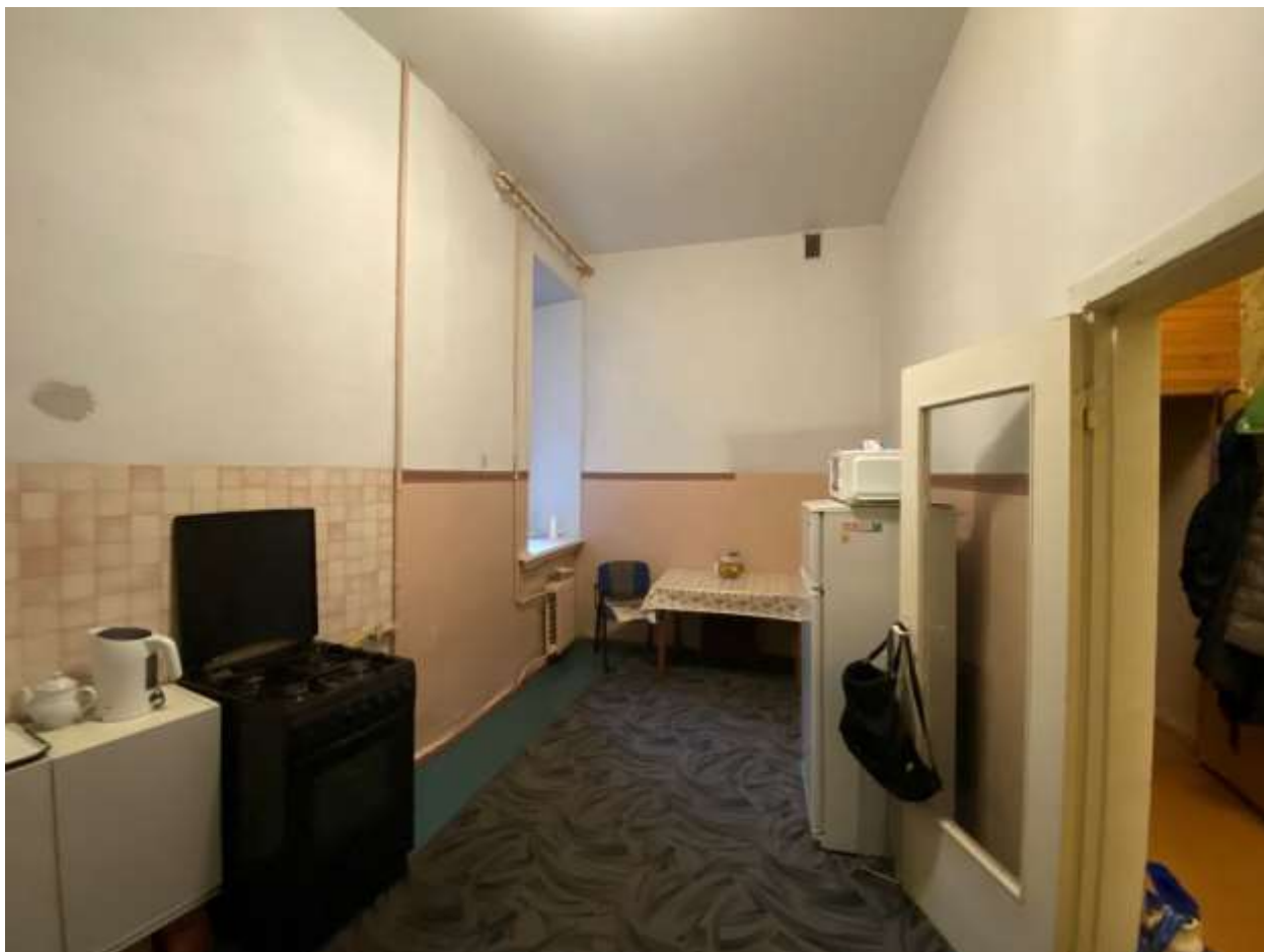
Фото 23. Помещение № 9. Кухня. Вид с юго-востока.
