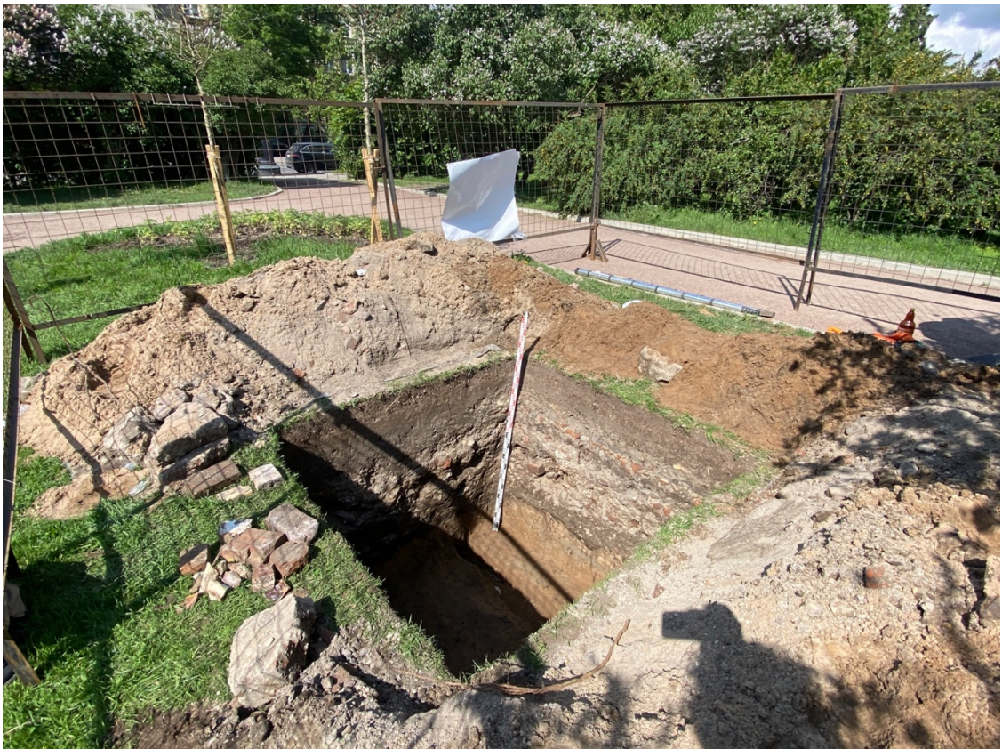
Рис. 41. Санкт-Петербург, Петроградский район, сквер им. Т.Г. Шевченко. Шурф №1. Общий вид местоположения шурфа после финальной фиксации. Вид на север.
