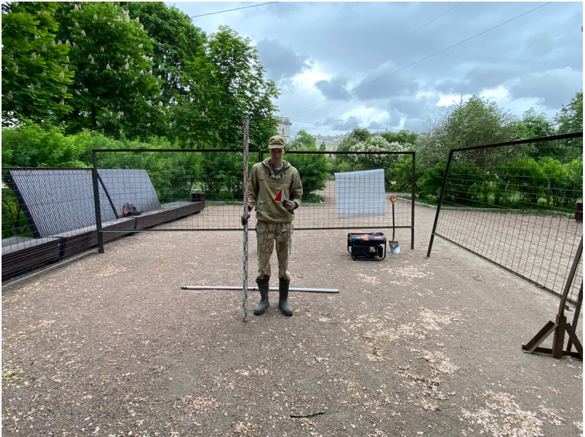
Рис. 49. Санкт-Петербург, Петроградский район, сквер им. Т.Г. Шевченко. Шурф №2. Местоположение шурфа до начала работ. Вид на север.
