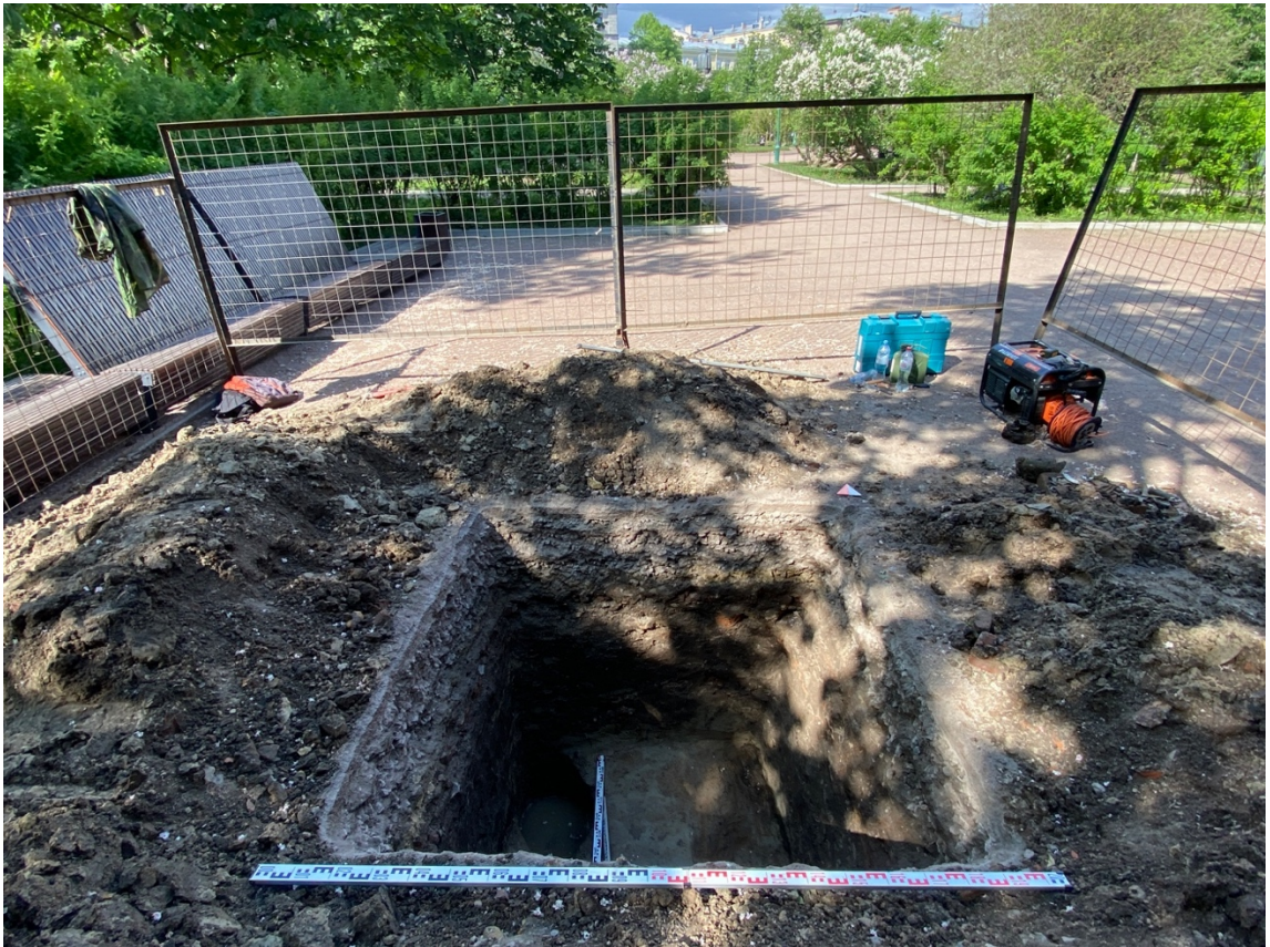
Рис. 60. Санкт-Петербург, Петроградский район, сквер им. Т.Г. Шевченко. Шурф №2. Общий вид местоположения шурфа после финальной фиксации. Вид на север.
