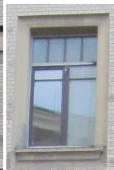
четвертый этаж – профилированный штукатурный наличник, профилированный подоконный выступ на стилизованных кронштейнах, декорированных цветочными розетками и соединенных плодово-растительной гирляндой, рельефным геометрическим орнаментом в подоконном простенке; пояс с орнаментом «бегущая волна» и розетка – над окнами 4-го этажа по 3-ей и 9-ой осям;
