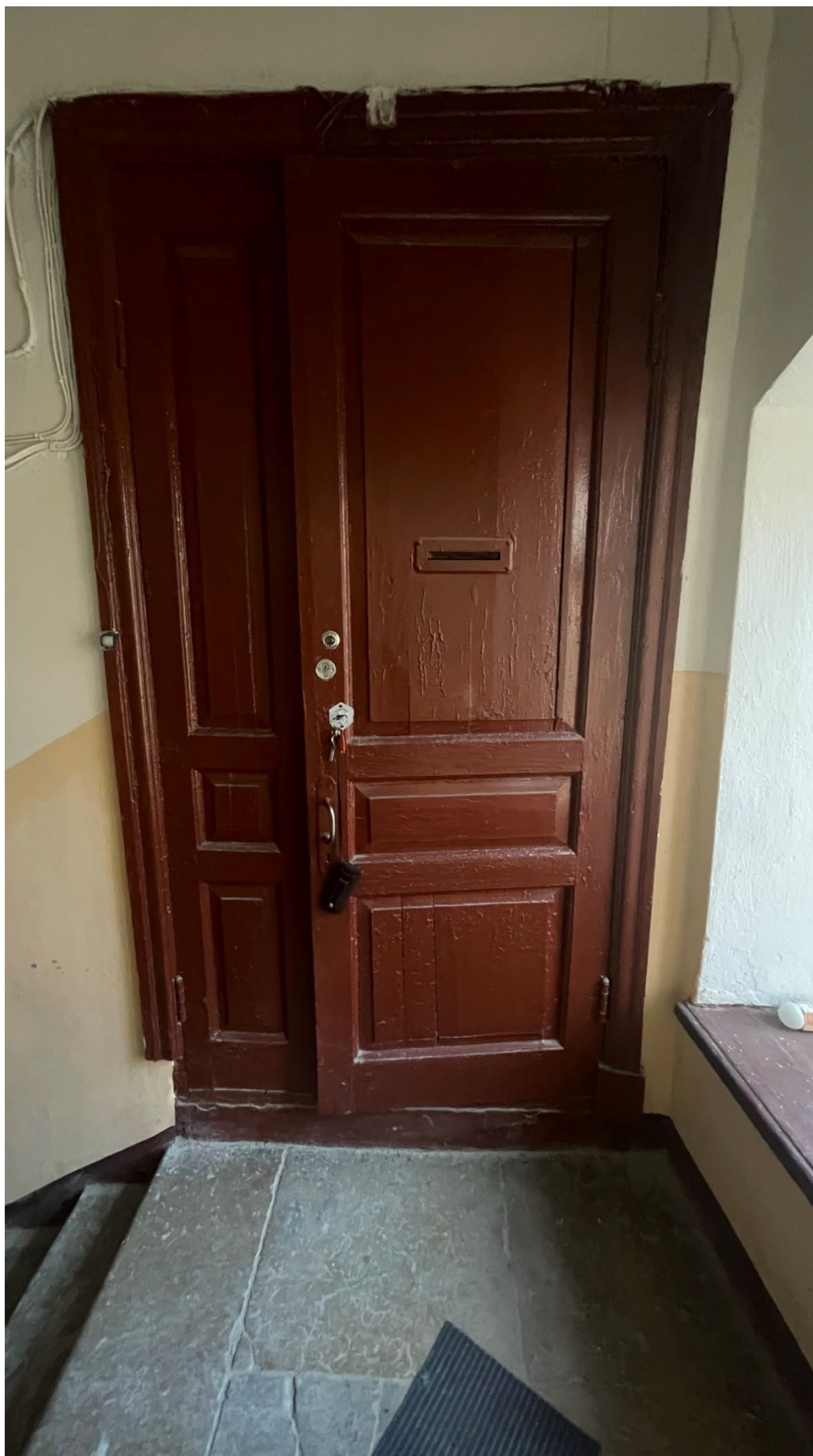
3. Вид на входную дверь в квартиру;
