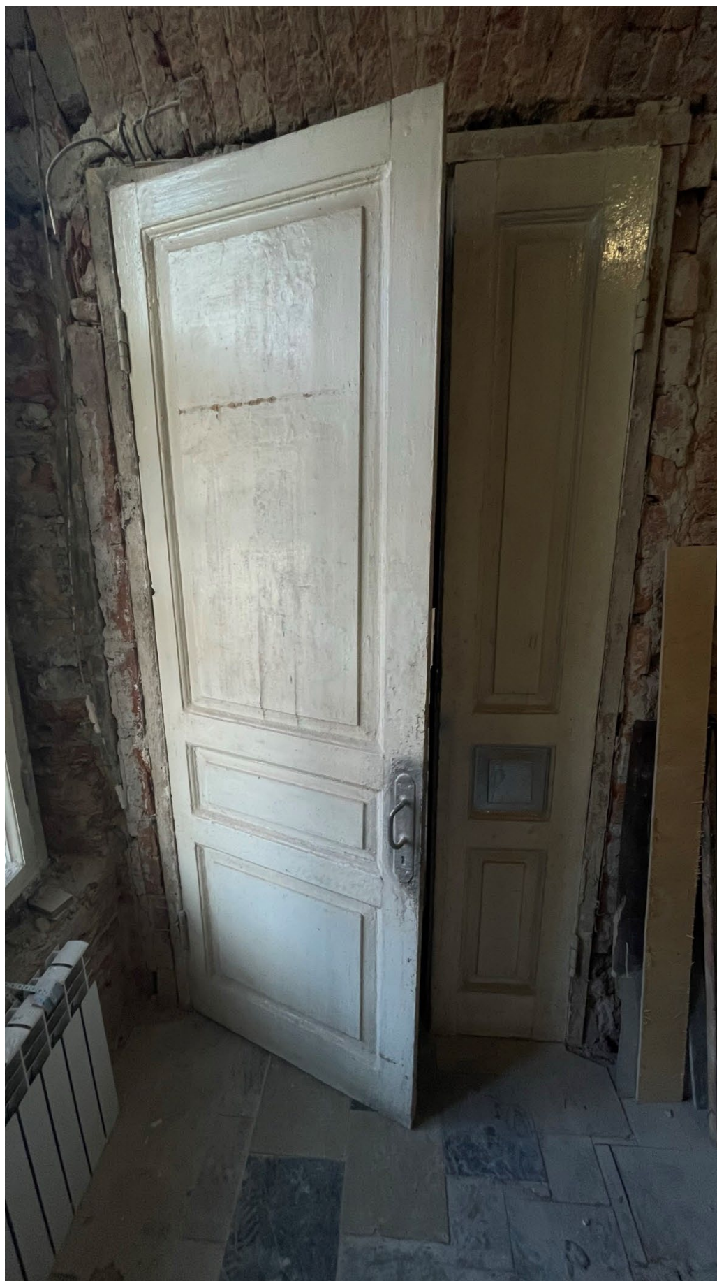
4. Вид на входную дверь в квартире;
