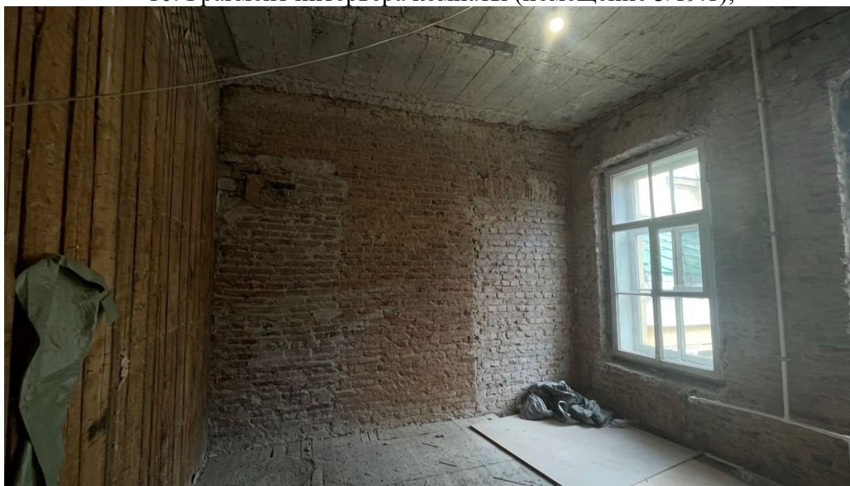
11.Фрагмент интерьера комнаты (помещение 3/19.1);
