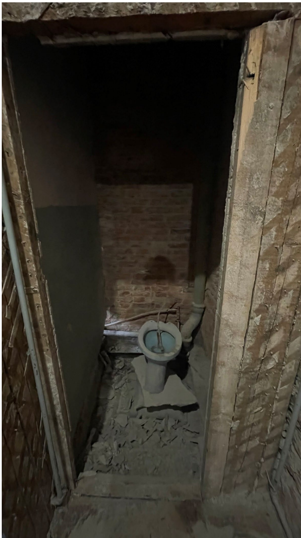
8. Фрагмент интеръера туалета (помещение 5/1.50);
