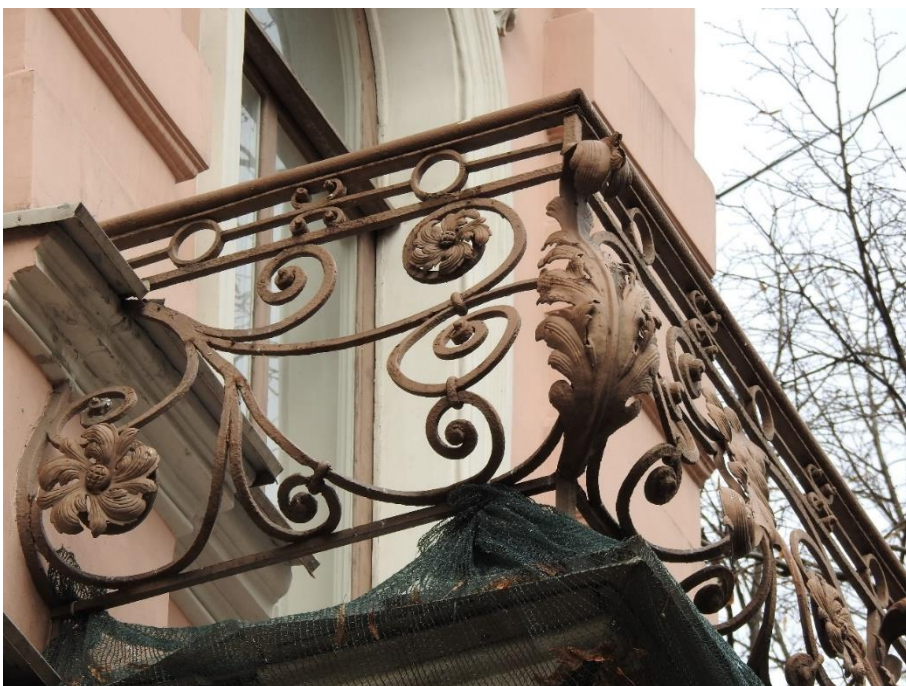
13. «Дом Н.В. Чайковского», ул. Короленко, д. 2, лит. А. Фрагмент фасада по ул. Короленко. Фото 05.04.2023г.
