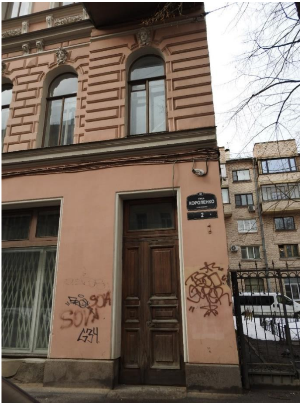
11. «Дом Н.В. Чайковского», ул. Короленко, д. 2, лит. А. Фрагмент фасада по ул. Короленко. Фото 05.04.2023г.
