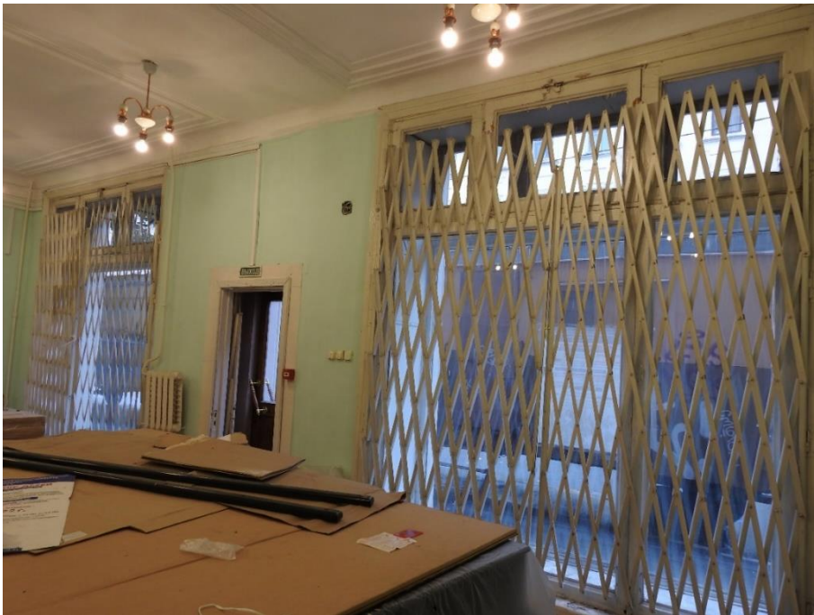
15. «Дом Н.В. Чайковского», ул. Короленко, д. 2, лит. А. Лицевое помещение 1-Н. Фото 05.04.2023г.
