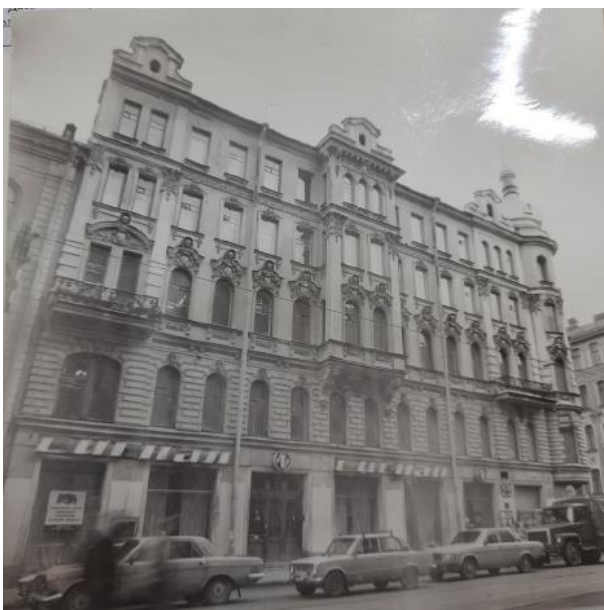
37. Архив КГИОП. П-672. Фото №1. Лицевой фасад по ул. Некрасова. Фото О.В. Евдокимова 1995 г. На первом этаже располагался магазин «Сигнал».
