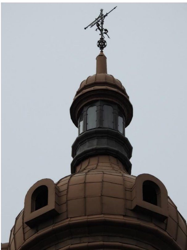
5. «Дом Н.В. Чайковского», ул. Короленко, д. 2, лит. А. Фрагмент фасада по улице Некрасова д.4 с башней углового полуэркера. Фото 05.04.2023г.
