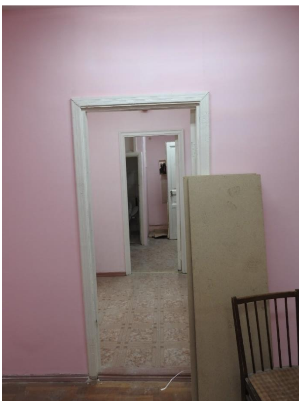
18. «Дом Н.В. Чайковского», ул. Короленко, д. 2, лит. А. Анфилада дворовых помещений. Фото 05.04.2023г.
