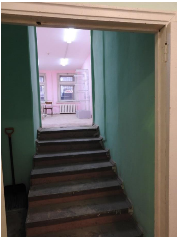
16. «Дом Н.В. Чайковского», ул. Короленко, д. 2, лит. А. Переход из лицевого в дворовое помещение 1-Н. Фото 05.04.2023г.
