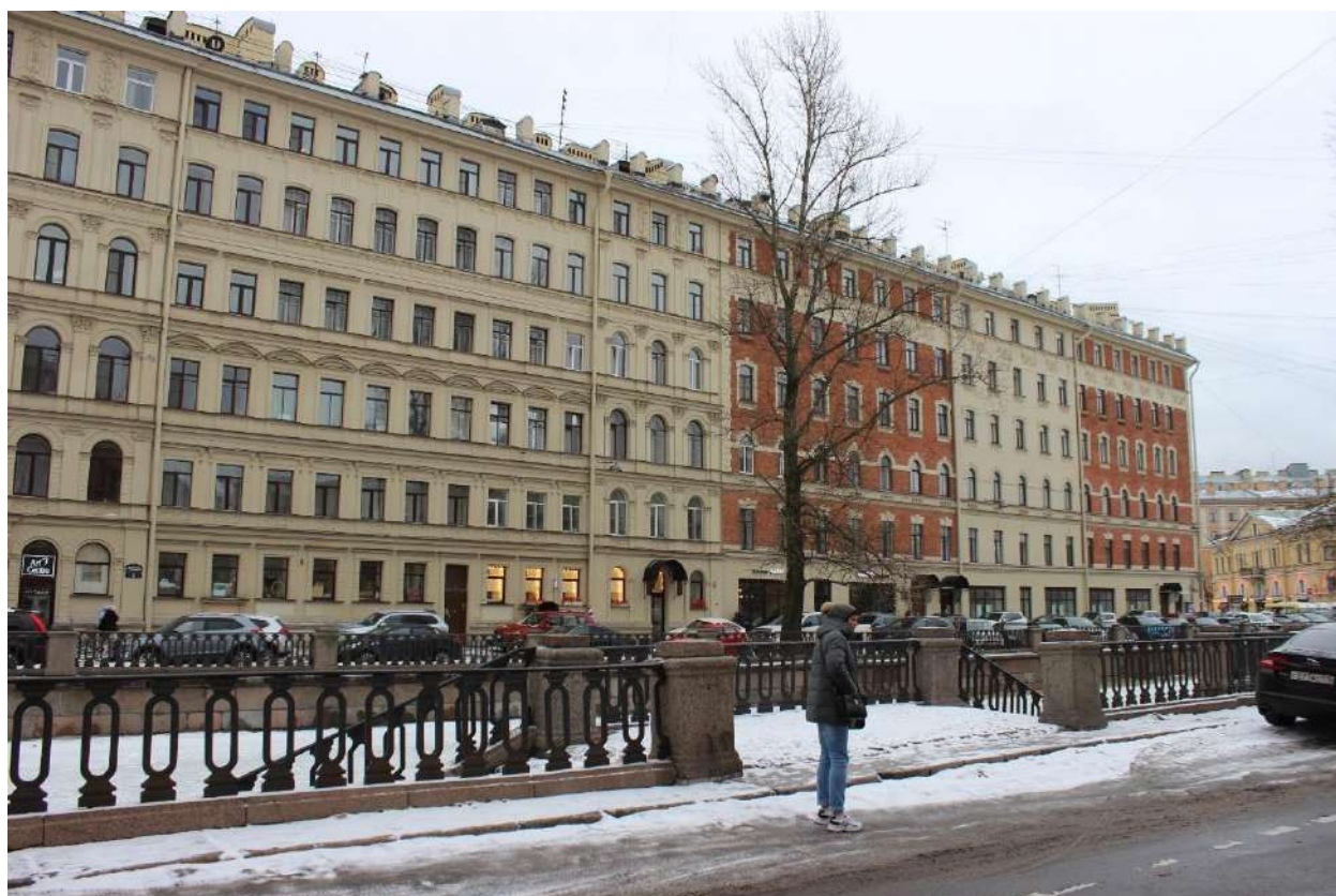
4. Здание по адресу: Санкт-Петербург, Сенная пл., д. 13, лит. А. Северо-западный фасад
