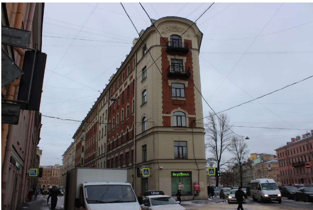
6. Здание по адресу: Санкт-Петербург, Сенная пл., д. 13, лит. А. Восточный фасад
