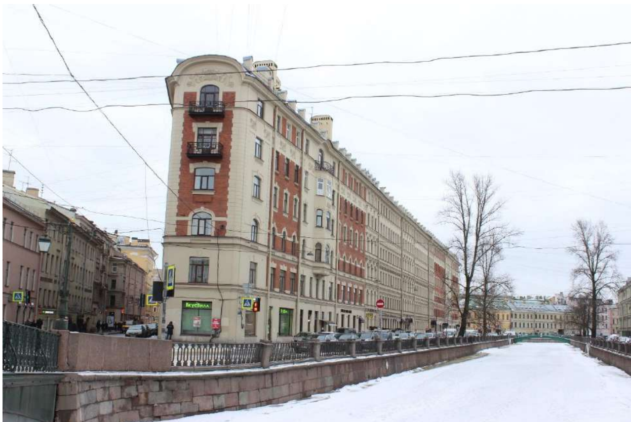
5. Здание по адресу: Санкт-Петербург, Сенная пл., д. 13, лит. А. Северо-западный фасад
