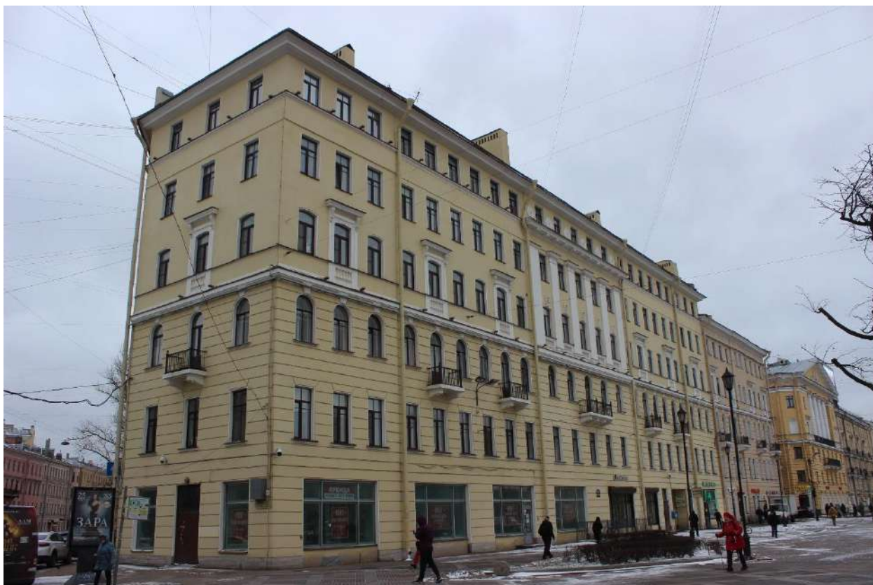
3. Здание по адресу: Санкт-Петербург, Сенная пл., д. 13, лит. А. Южный фасад
