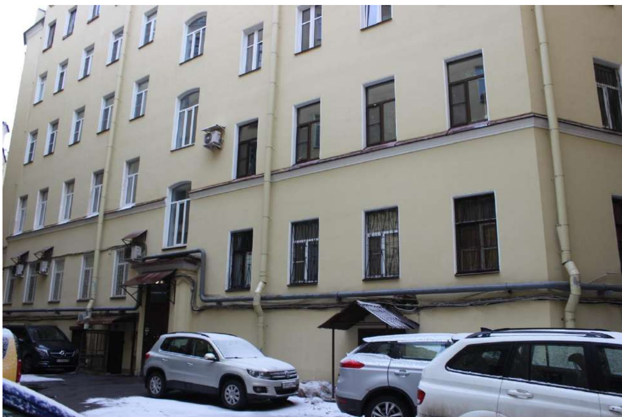
10. Здание по адресу: Санкт-Петербург, Сенная пл., д. 13, лит. А. Фрагмент дворового фасада
