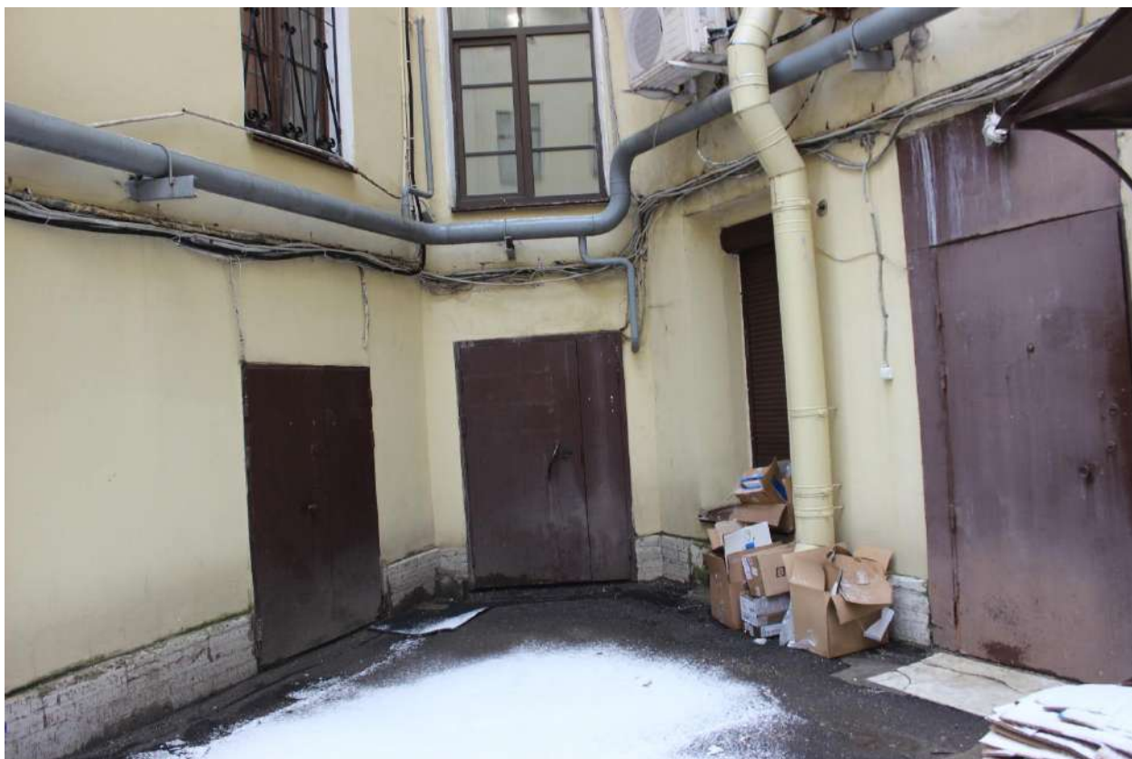
9. Здание по адресу: Санкт-Петербург, Сенная пл., д. 13, лит. А. Фрагмент дворового фасада
