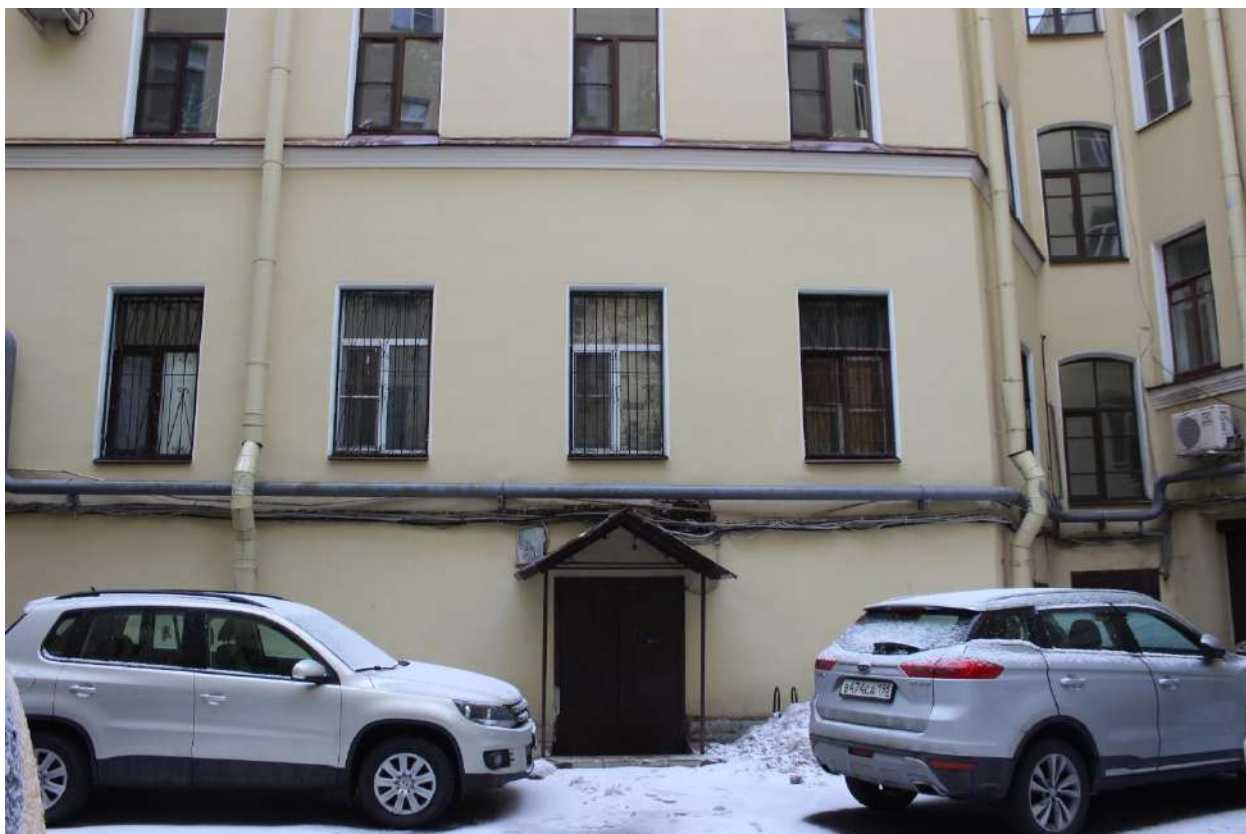
7. Здание по адресу: Санкт-Петербург, Сенная пл., д. 13, лит. А. Фрагмент дворового фасада
