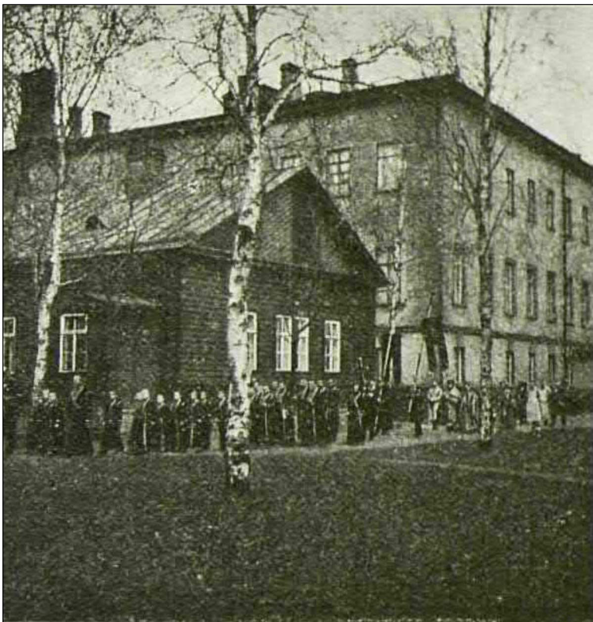
Рис. 11. Крестный ход 12 октября 1902 года у здания полковой церкви и полкового госпиталя. На переднем плане здание заразного отделения, построенное в 1890-х гг. Вид с юго-запада. www.citywalls.ru
