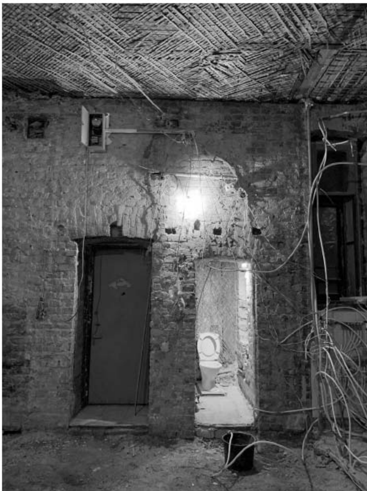
Фото7: Общий вид на помещение с/у и входную металлическую дверь.
