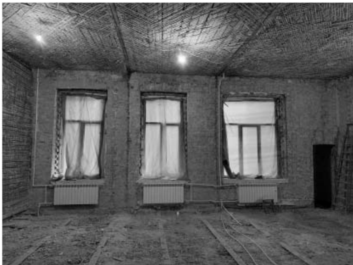
Фото13: Общий вид на на ОК-1, ОК-2 (2 шт.) и вход в бытовые помещения.
