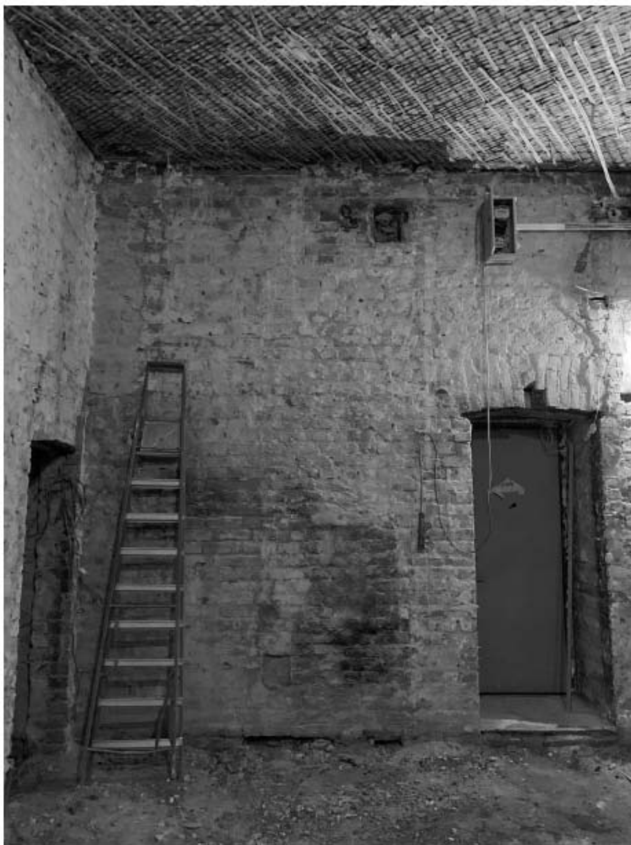
Фото8: Общий вид на вход в бытовое помещение и входную металлическую дверь.
