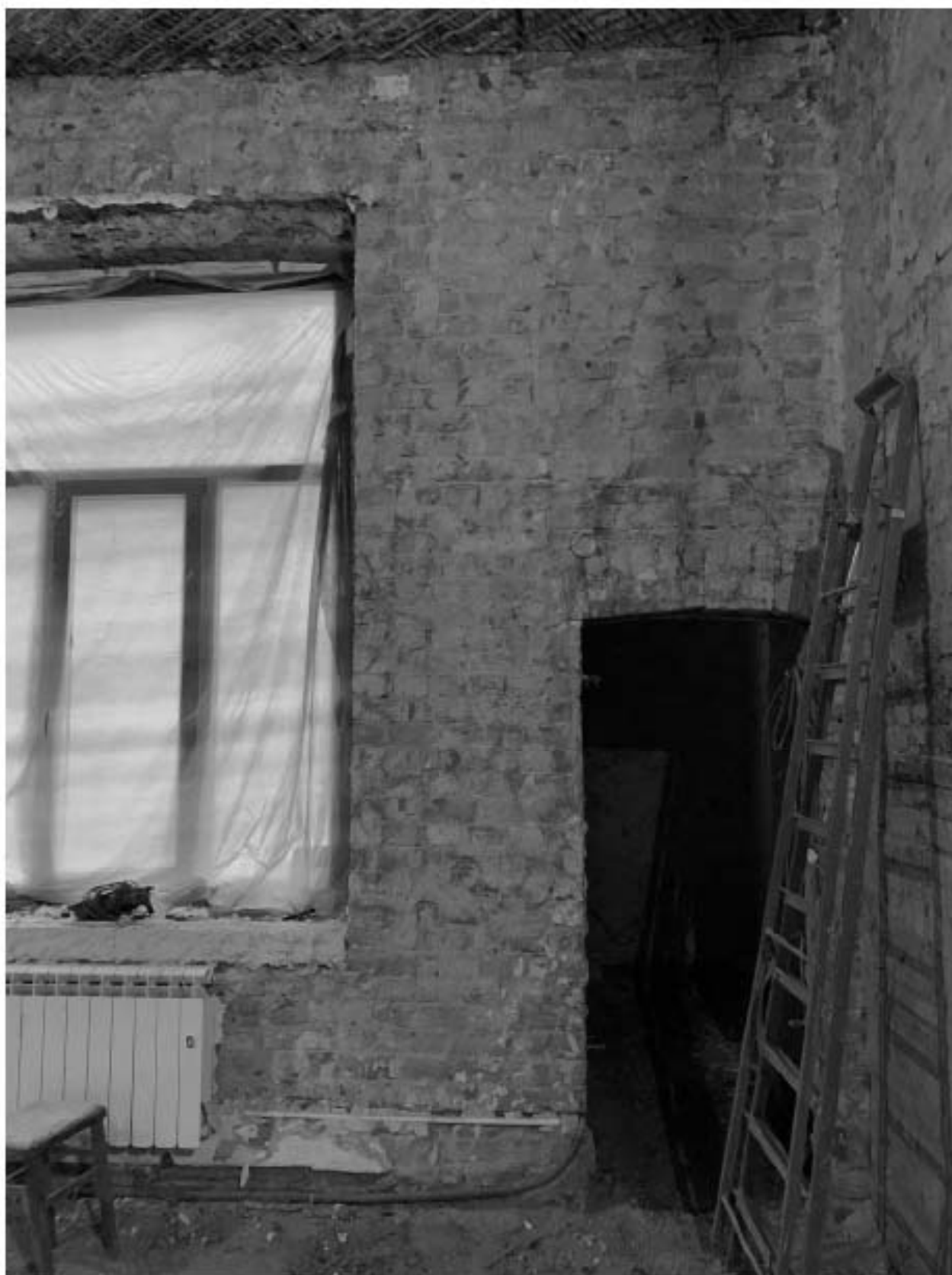
Фото9: Вид на вход в бытовые помещения и ОК-1
