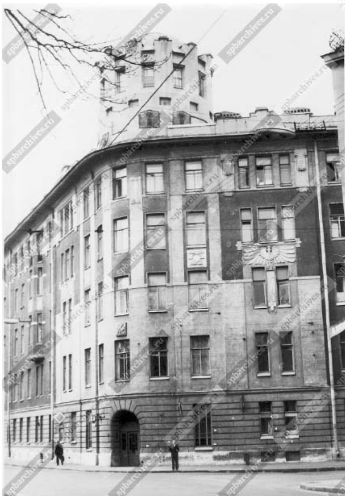
Ил. 59. Вид углового фасада жилого дома №77/2, завершеного башней-ротондой, на углу проспекта Максима Горького и улицы Блохина (бывший доходный дом Л.Л. Кенига, архитектор К.К. Шмидт, 1911 -1912 гг.)
