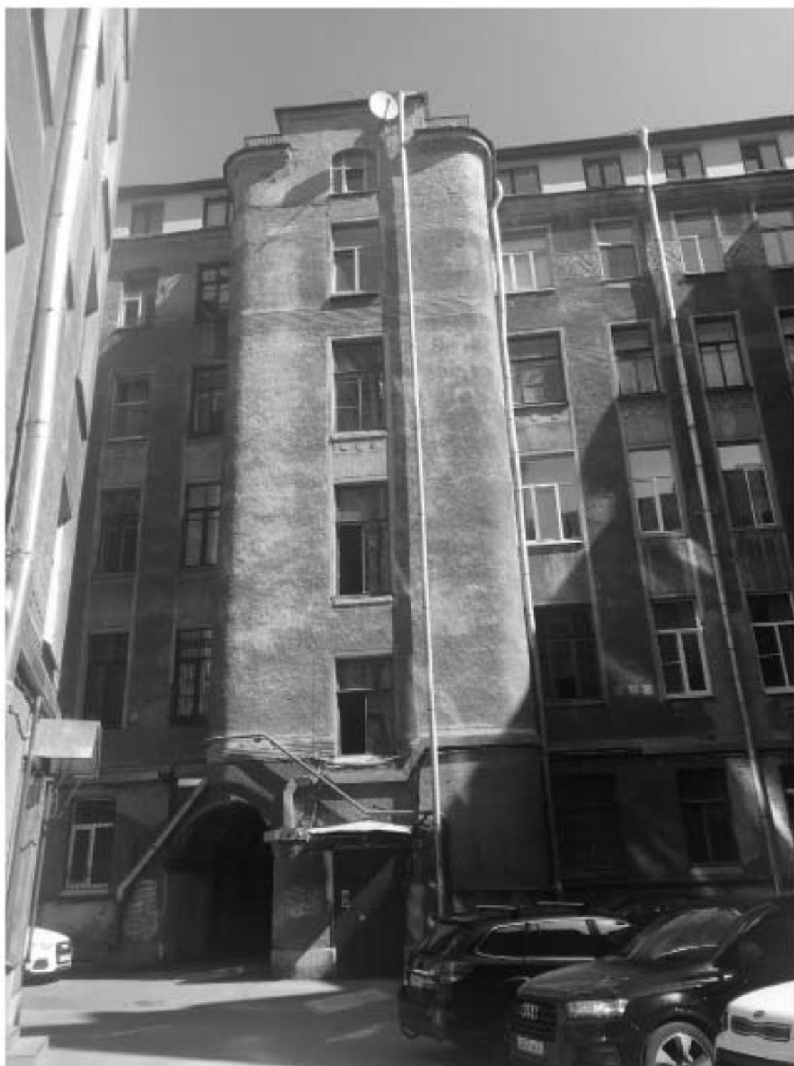
Фото3: Вид со стороны двора. Общий вид.
