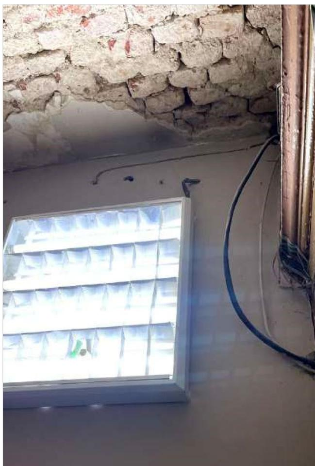
*Фото 5. Фрагмент лестничной клетки первого этажа. Наблюдаются трещины в кирпичной кладке, отслоение штукатурного слоя*
