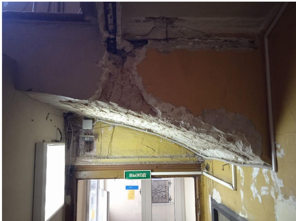
*Фото 6. Фрагмент лестничной клетки первого этажа. Наблюдаются трещины в кирпичной кладке, отслоение штукатурного слоя*
