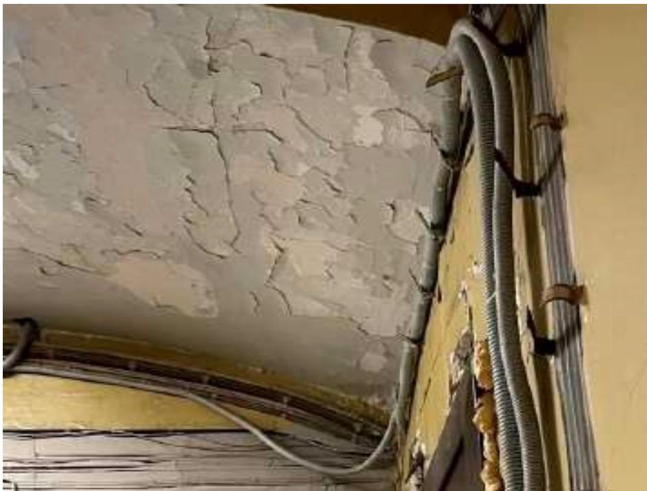
*Фото 50. Фрагмент потолка площадки второго этажа. Повсеместное отслоение штукатурного слоя.*
