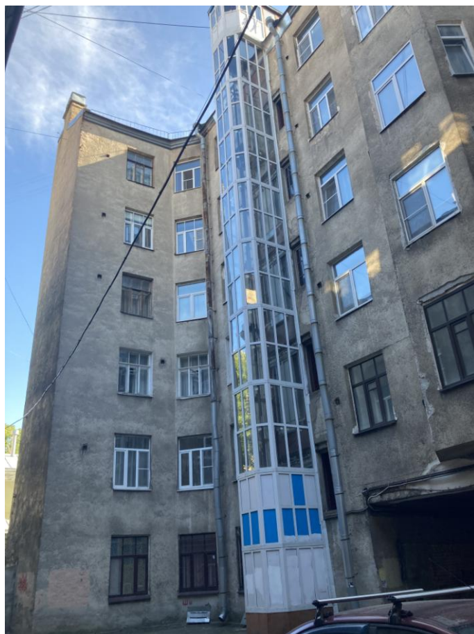
Фото 10. Фрагмент дворового фасада выявленного объекта культурного наследия «Дом Н.И. Алексеева»
