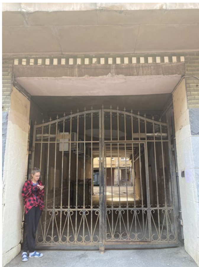
Фото 2. Фрагмент лицевого фасада выявленного объекта культурного наследия «Дом Н.И. Алексеева», воротный проезд
