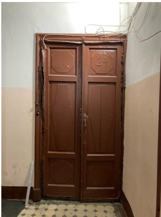
Фото 13. Интерьер квартиры № 24 выявленного объекта культурного наследия «Дом Н.И. Алексева», вход с лестничной клетки
