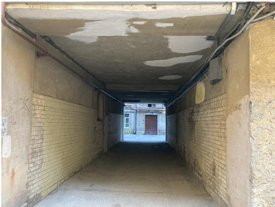
Фото 9. Фрагмент дворового фасада выявленного объекта культурного наследия «Дом Н.И. Алексеева», воротный проезд во дворе
