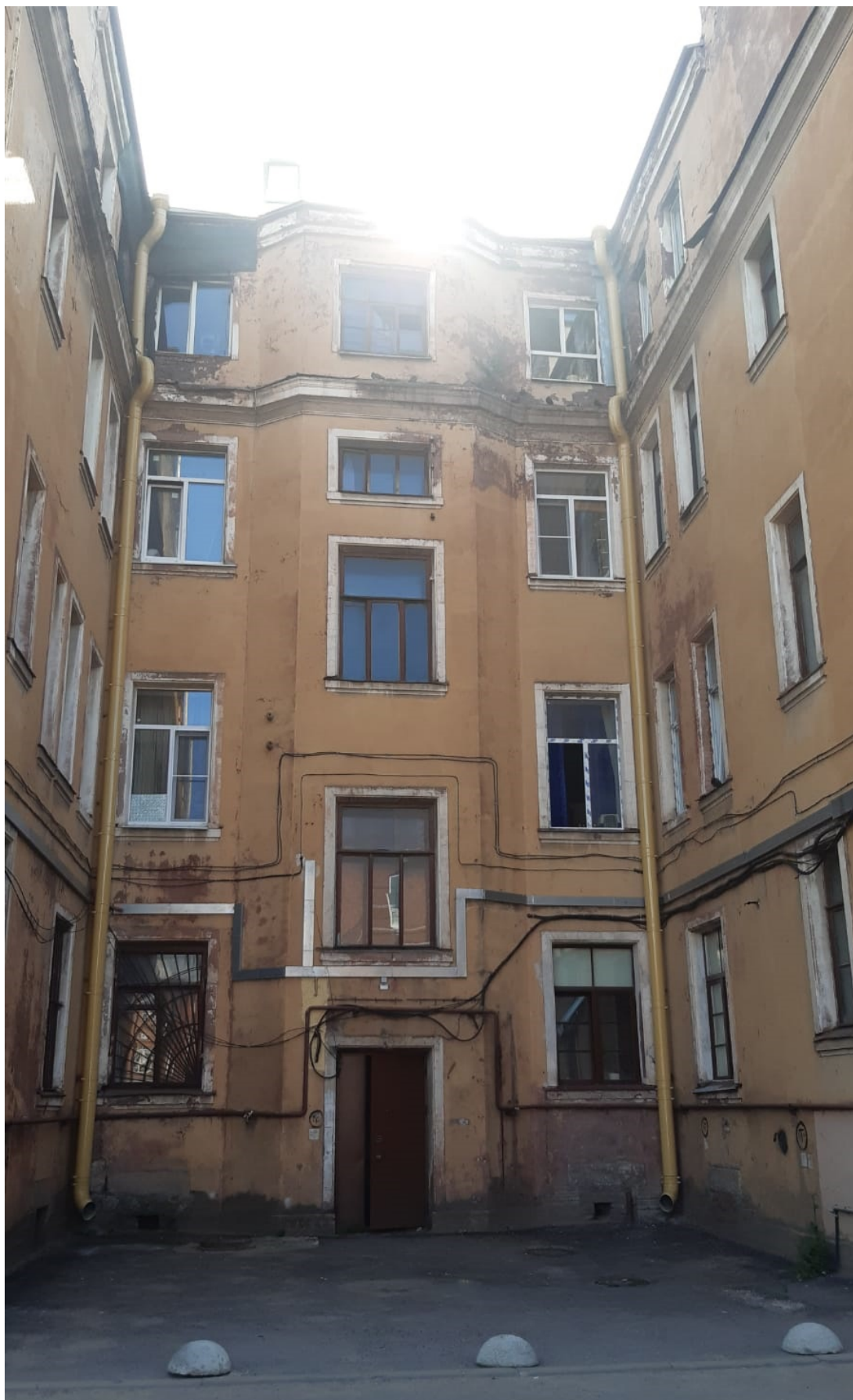
Фото 1. Общий вид дворового северо-восточного фасада здания. Фото от 02.06.2023 г.
