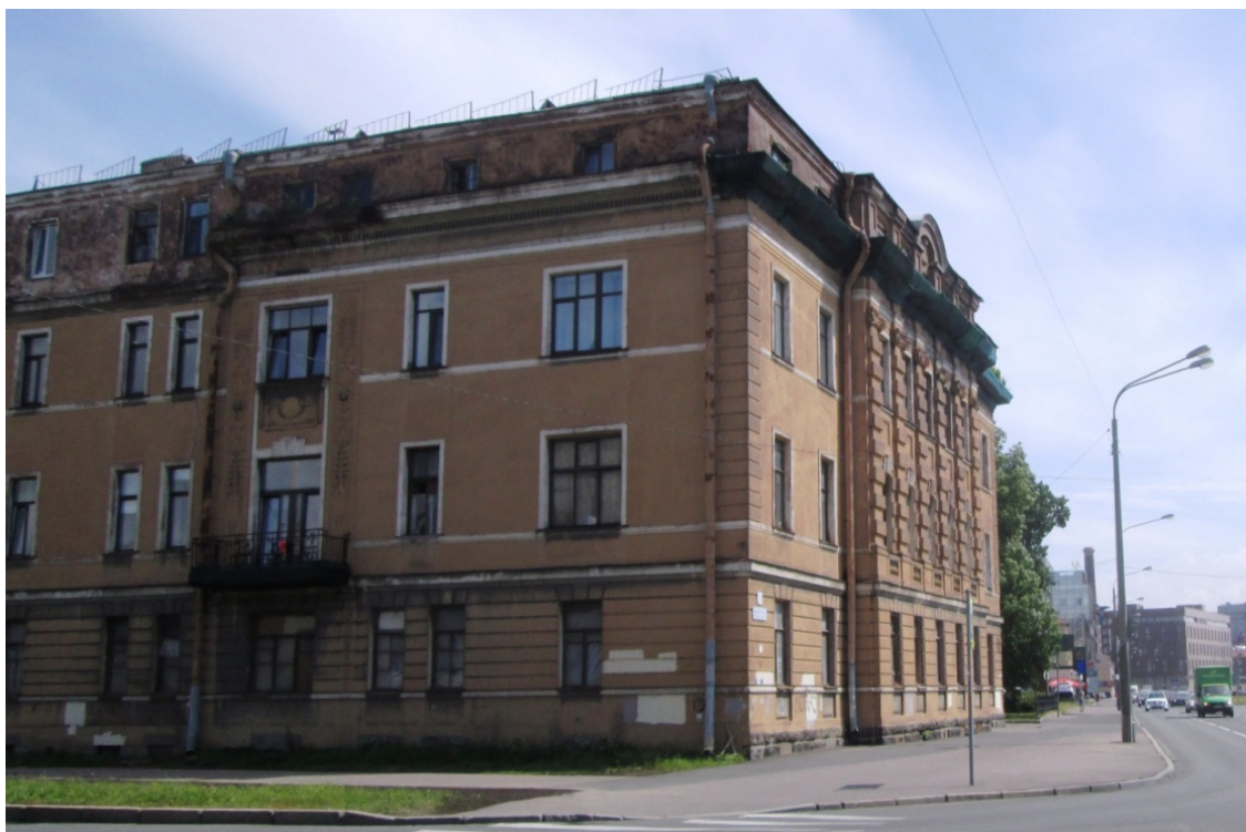
Илл. 11. Объект культурного наследия регионального значения «Жилой дом бумагопрядильной и трикотажной Николаевской мануфактуры акционерного общества мануфактур И. А. Воронин, Лютш и Чешер». Санкт-Петербург, Выборгский район, Выборгская набережная, д. 59, корп. 1, Лит. А. Фото 2021г.
