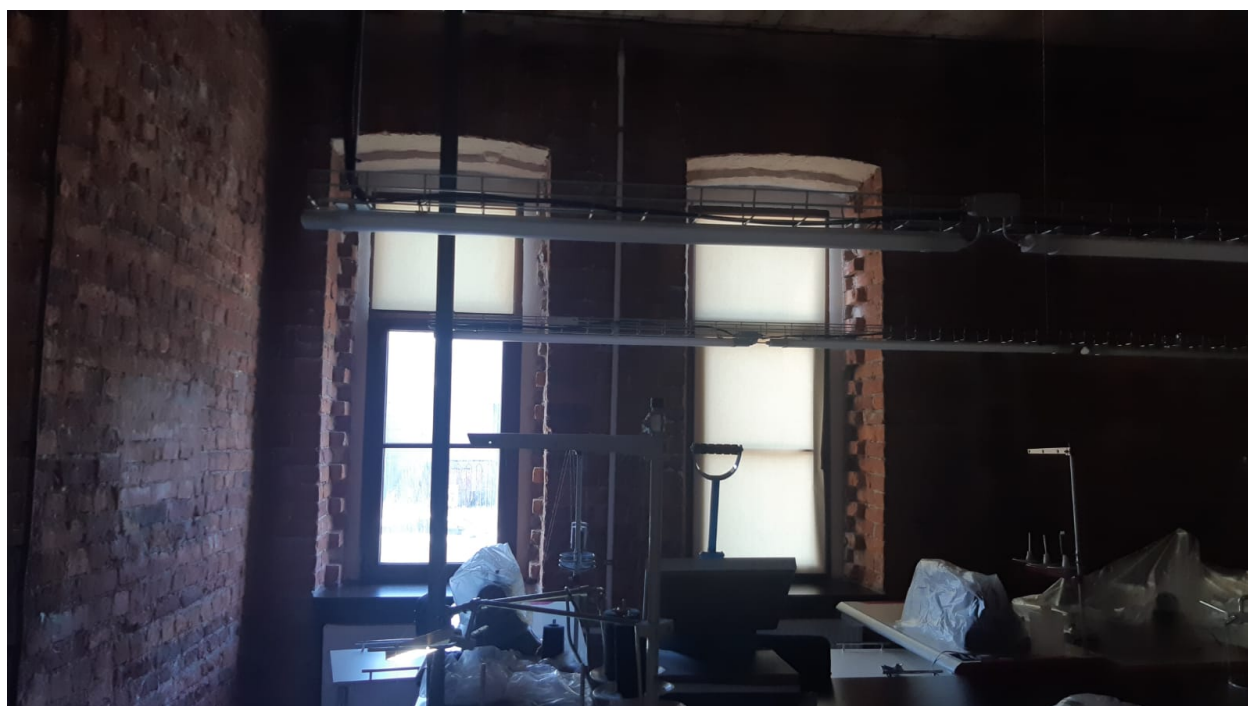
Фото 7. Оконные проемы комнаты 11 в помещении 2-Н. Фото от 02.06.2023 г.
