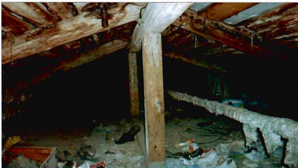
7. Стропильная система. Чердак.
