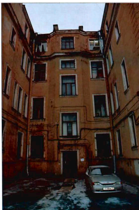
5. Северо-восточный дворовый фасад.
