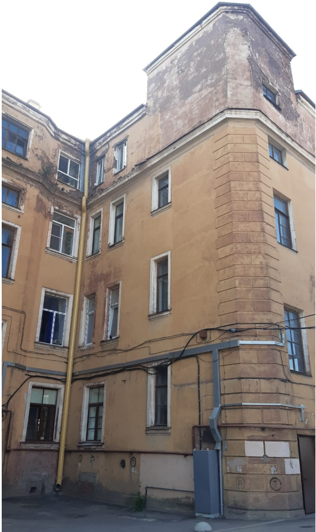
Фото 2. Общій вид дворового юго-восточного фасада здания. Фото от 02.06.2023 г.
