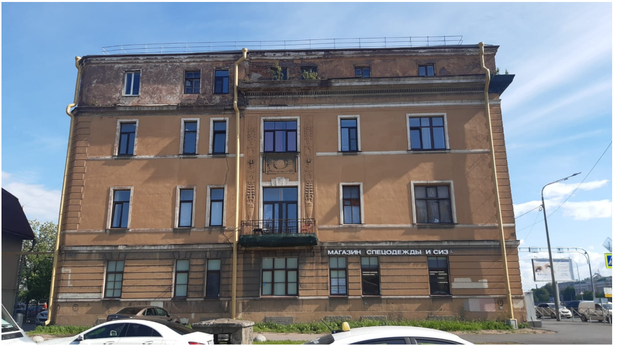
Фото 3. Общій вид бокового северо-западного фасада здания. Фото от 02.06.2023 г.
