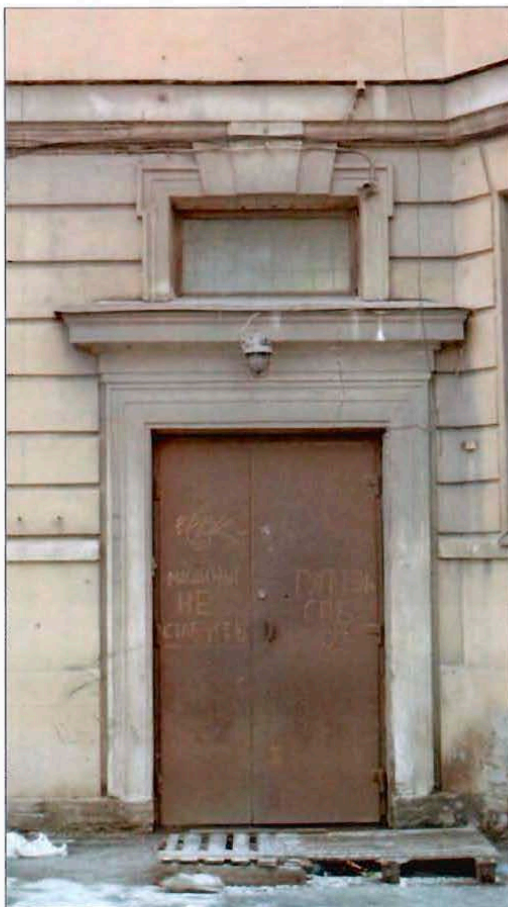
6. Оформление дверного проема. Юго-восточный фасад. Фрагмент.
