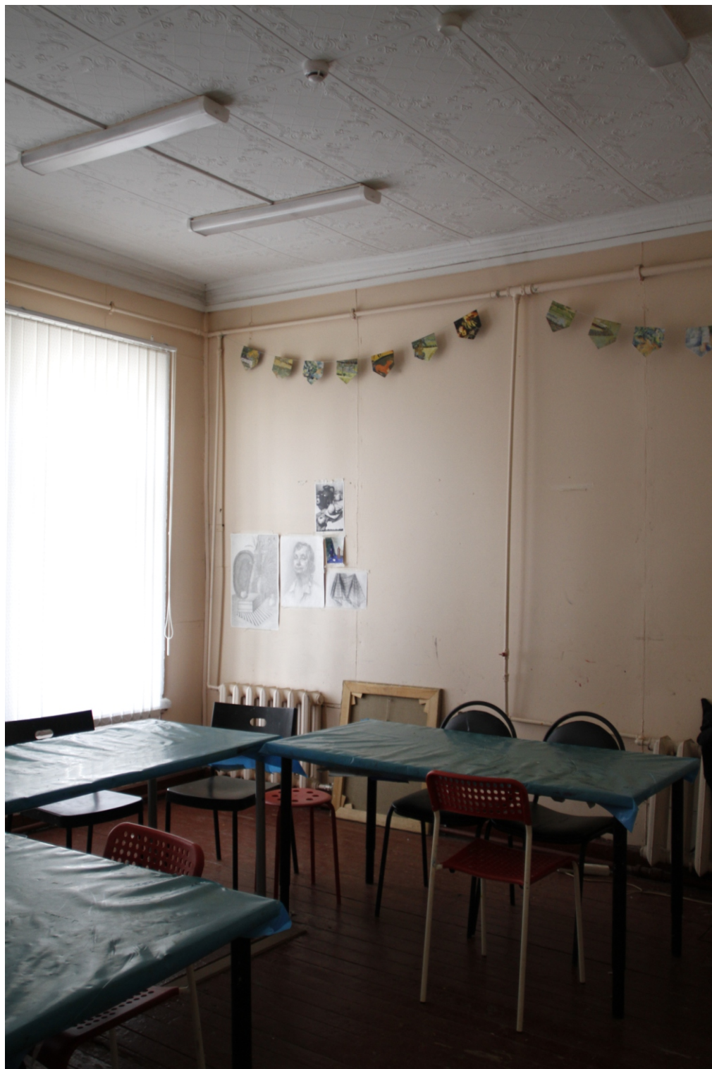
16. «Бывший дворец вел. кн. Михаила Павловича». Санкт-Петербург, г. Красное Село, пр. Ленина, д. 114, литера А. 1 этаж. Фрагмент интерьера пом. 11-Н. Фото: 05.05.2023.
