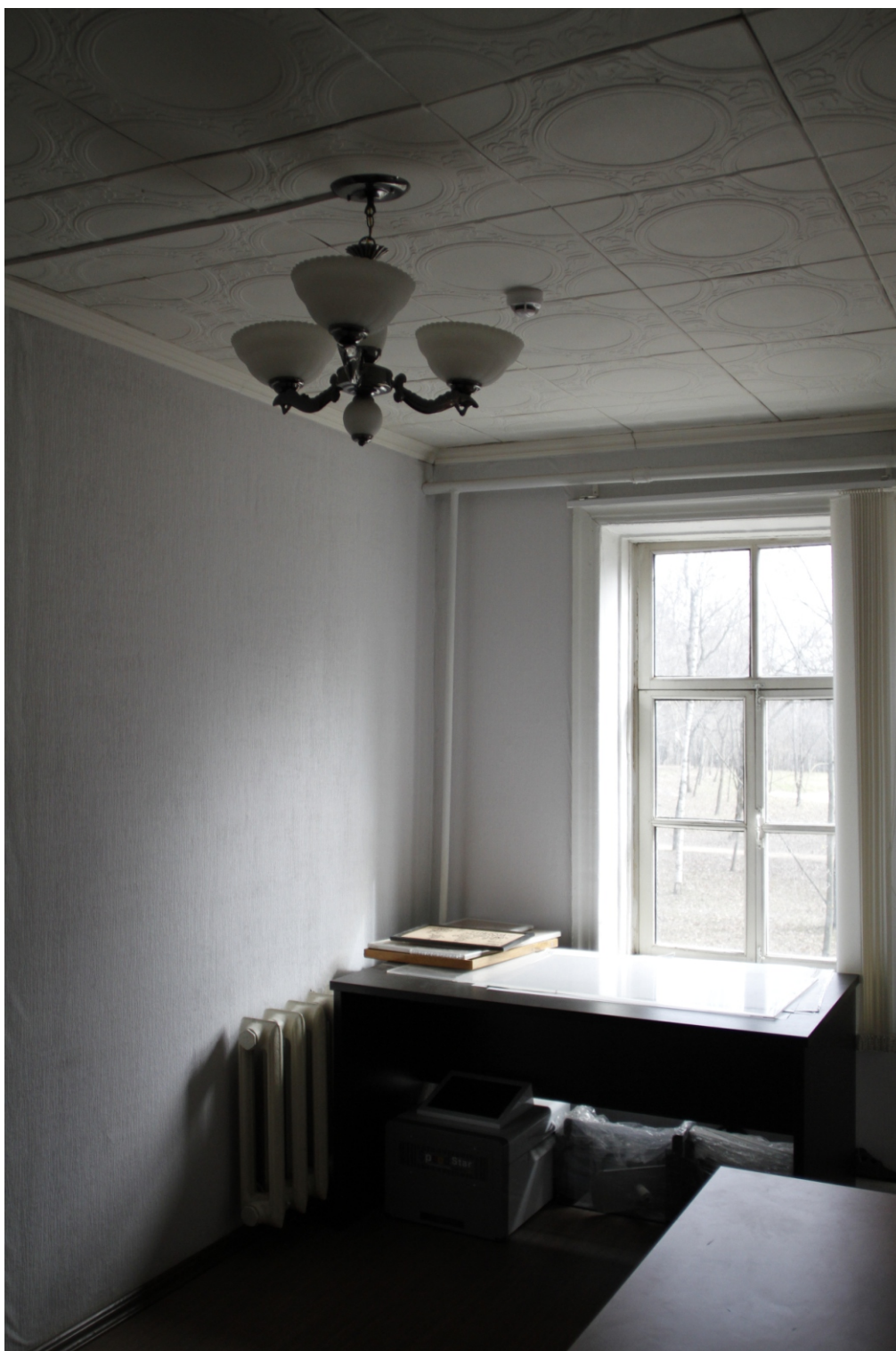
33. «Бывший дворец вел. кн. Михаила Павловича». Санкт-Петербург, г. Красное Село, пр. Ленина, д. 114, литера А. 2 этаж. Фрагмент пом. 3-Н. Фото: 05.05.2023.
