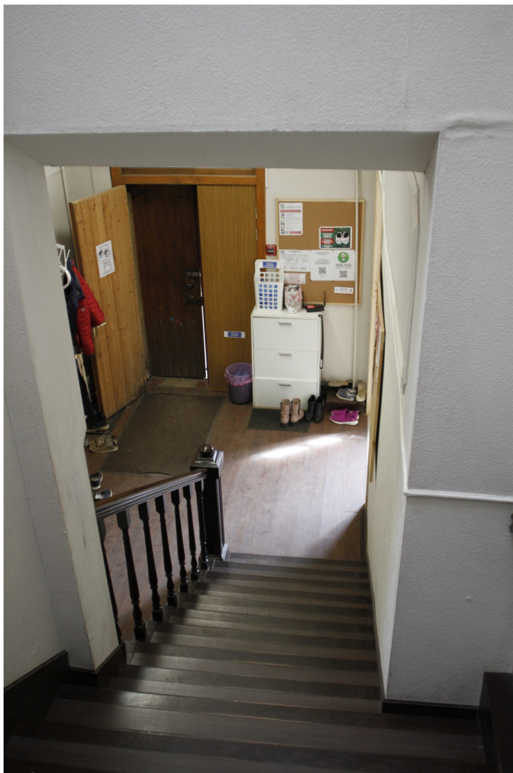
21. «Бывший дворец вел. кн. Михаила Павловича». Санкт-Петербург, г. Красное Село, пр. Ленина, д. 114, литера А. 2 этаж. Лестничный марш в уровне 1-го этажа. Фото: 05.05.2023.
