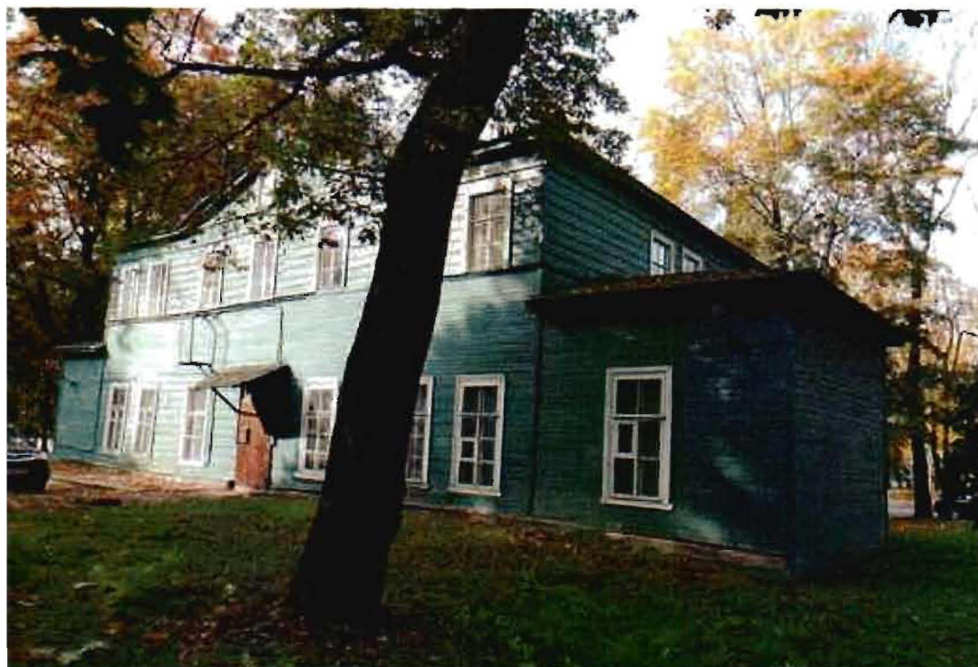
6, 7. Фрагмент террасы с колонным портиком на главном фасаде:
