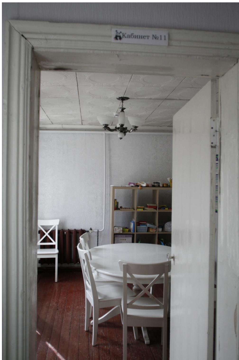
35. «Бывший дворец вел. кн. Михаила Павловича». Санкт-Петербург, г. Красное Село, пр. Ленина, д. 114, литера А. 2 этаж. Фрагмент пом. 16-Н. Фото: 05.05.2023.
