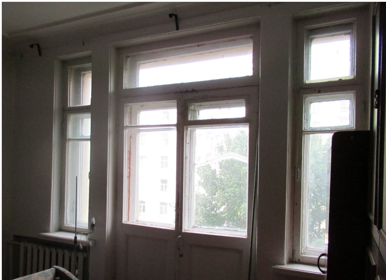
12. Вид на окна и балконную дверь в помещении 2 квартиры №25.
