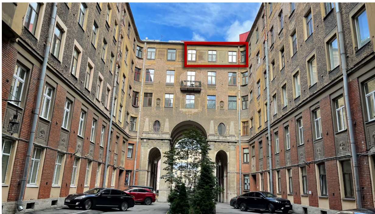
4. Вид на дворовой фасад и окна квартиры №633;
