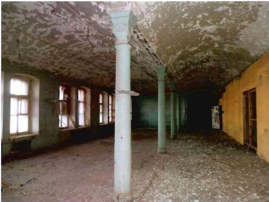
6. Чугунные колонны внутреннего каркаса.
