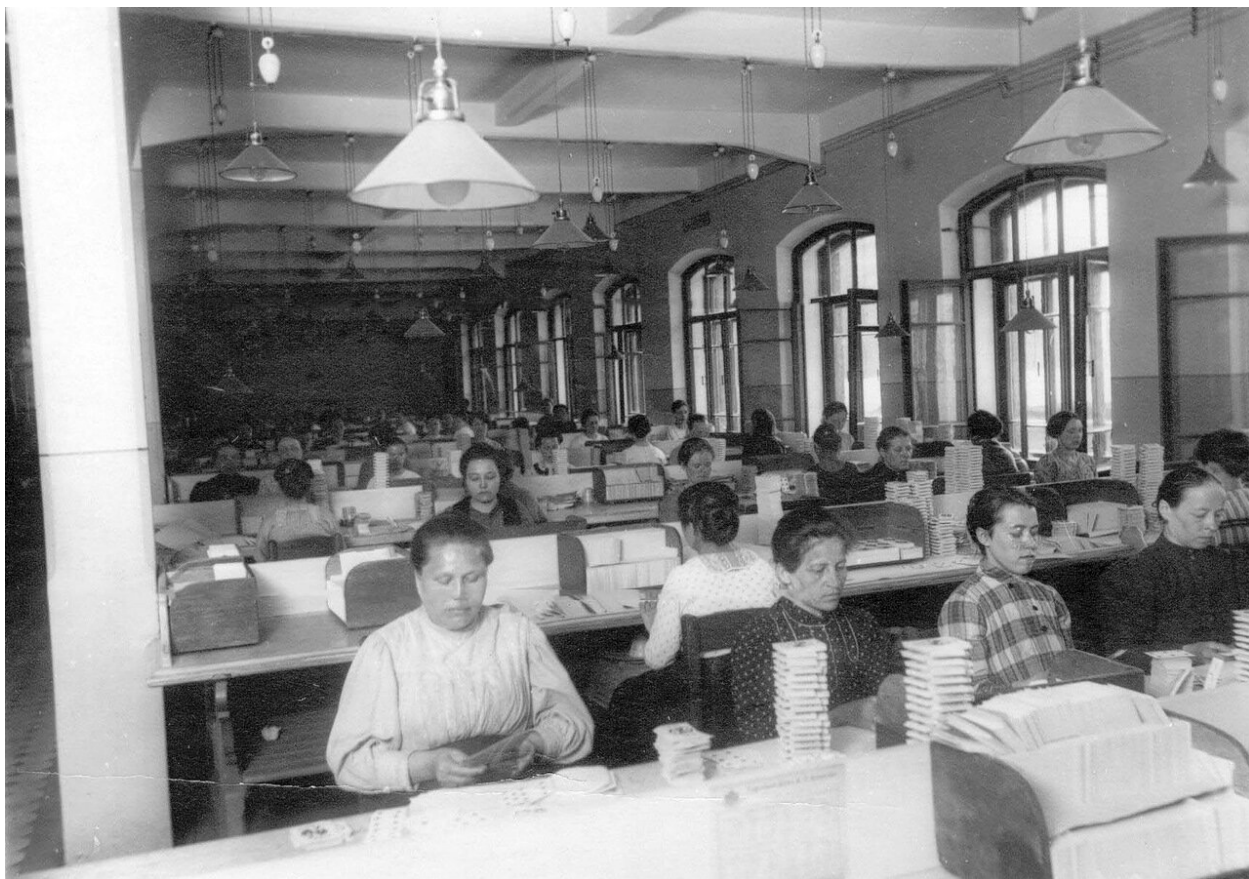
Илл. 9. ЦГАКФФД СПб. Д-17434. 1913 г. Вид части фабричного цеха. Пристройка 1909 г.
