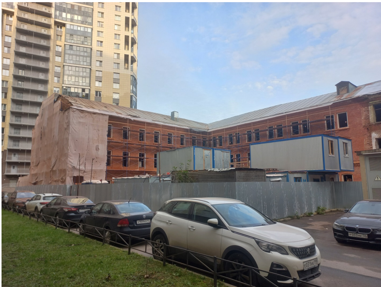
Фото 7. Южный фасад. Западный флигель.
