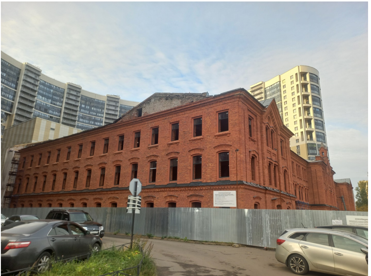
Фото 9. Западный фасад. Западный флигель. Главный фасад.
