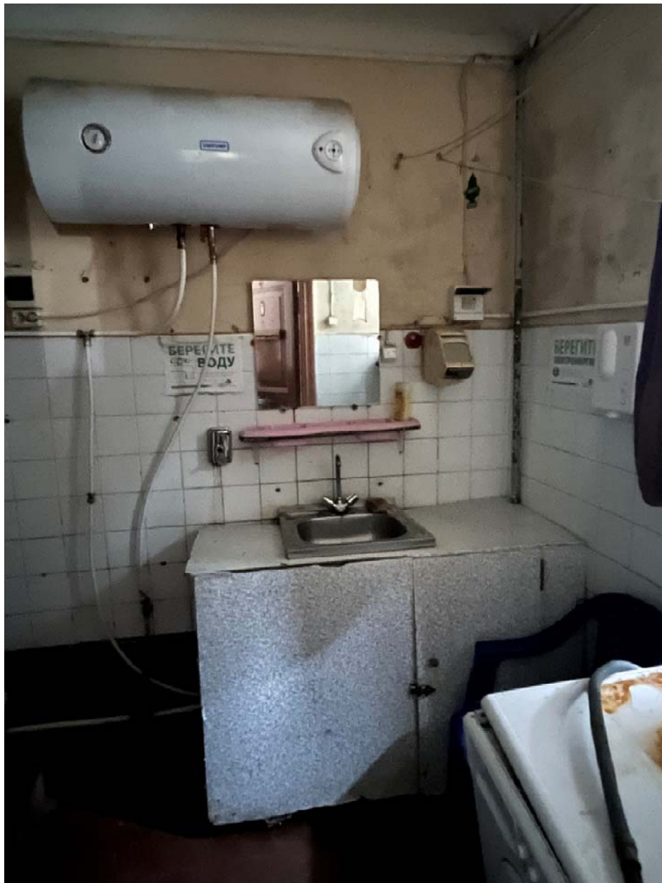
Фото №20. Помещение 1-Н (12), первый этаж.
