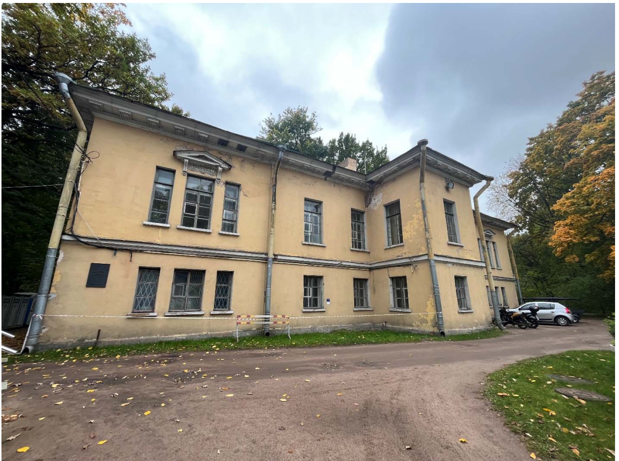
Фото №2. Северный фасад, общий вид.
