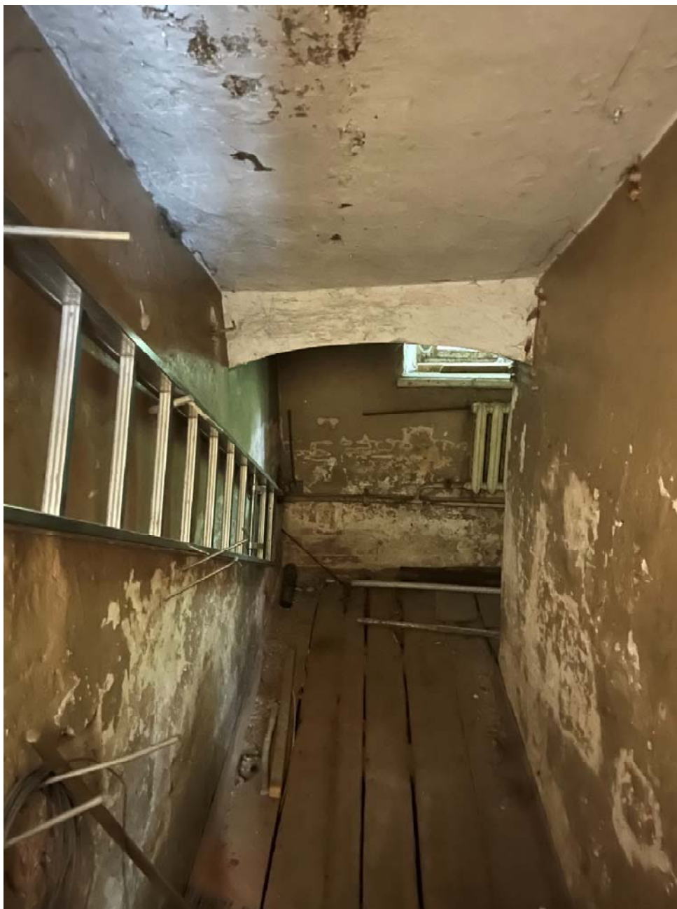
Фото №55. Спуск под лестницу.
