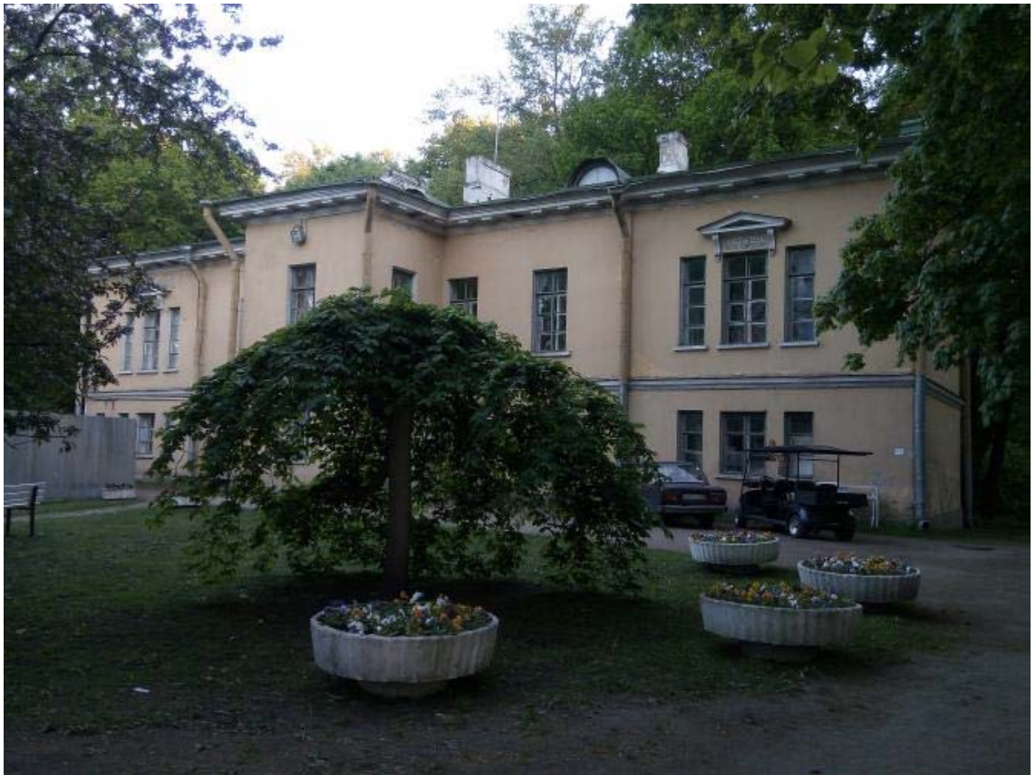
Илл. 23. Кладовые (Дом служителей). 2018 г. Citywalls: Архитектурный сайт Санкт-Петербурга [Электронный ресурс] URL: https://www.citywalls.ru/photo408263.html .
