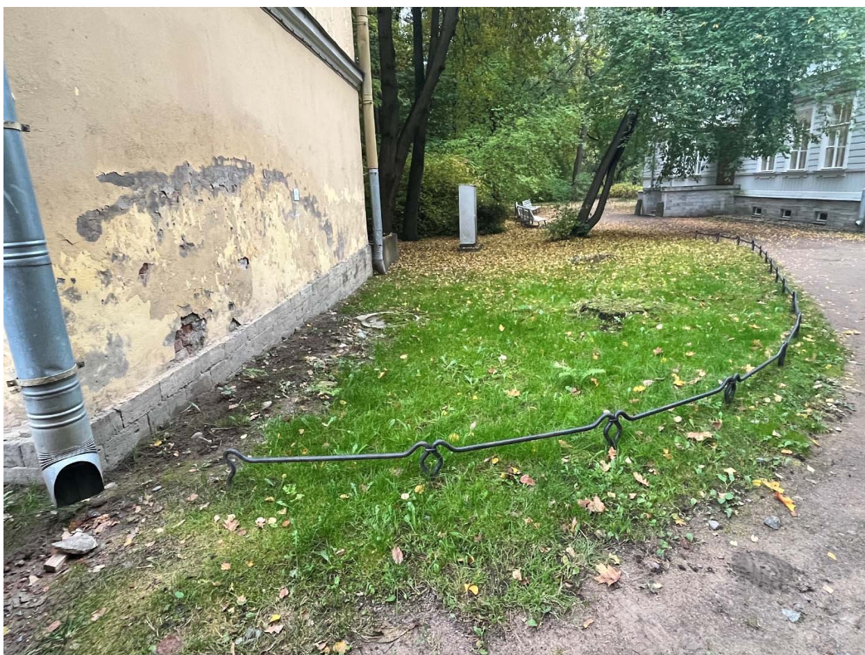
Фото №9. Западный фасад, цокольная часть, прилегающая территория.
