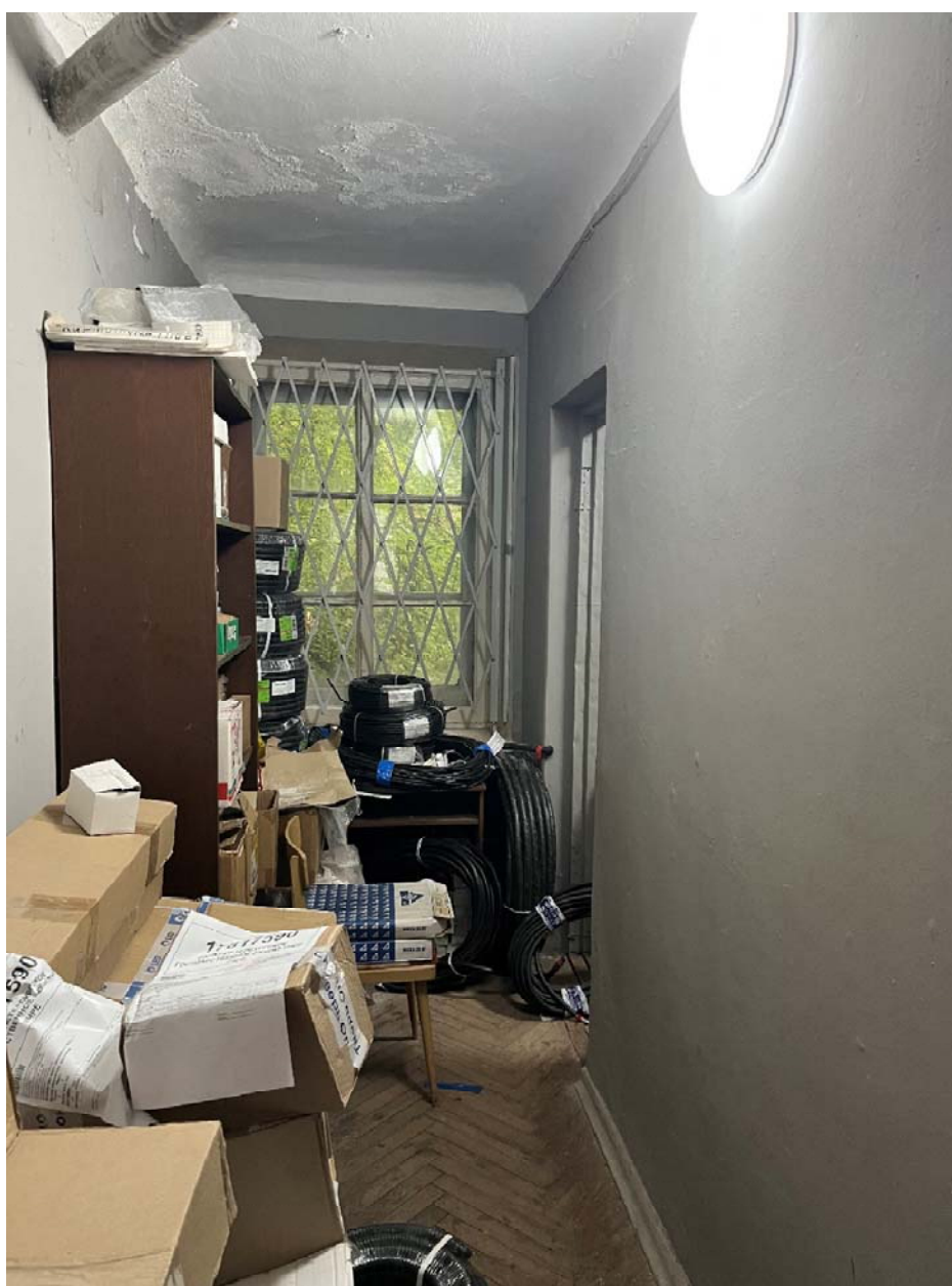
Фото №21. Помещение 1-Н (12), первый этаж.
