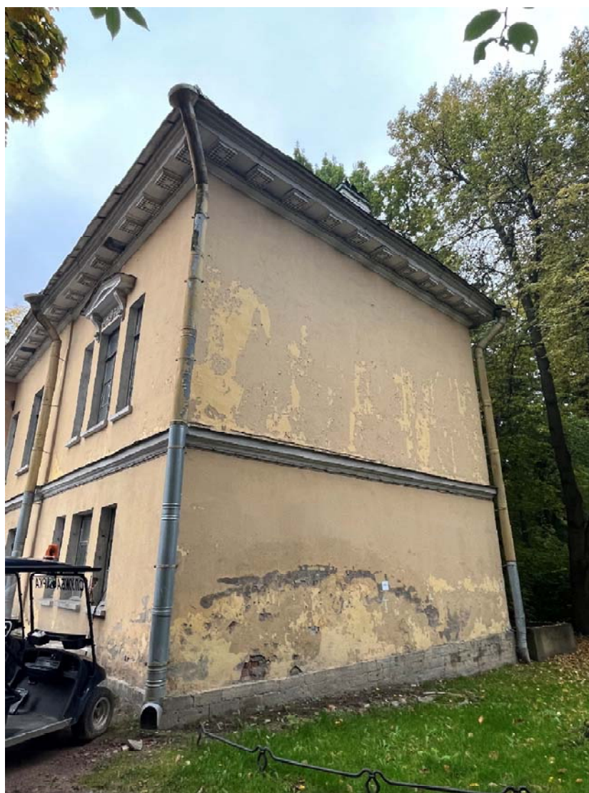
Фото №8. Западный фасад, общий вид.
