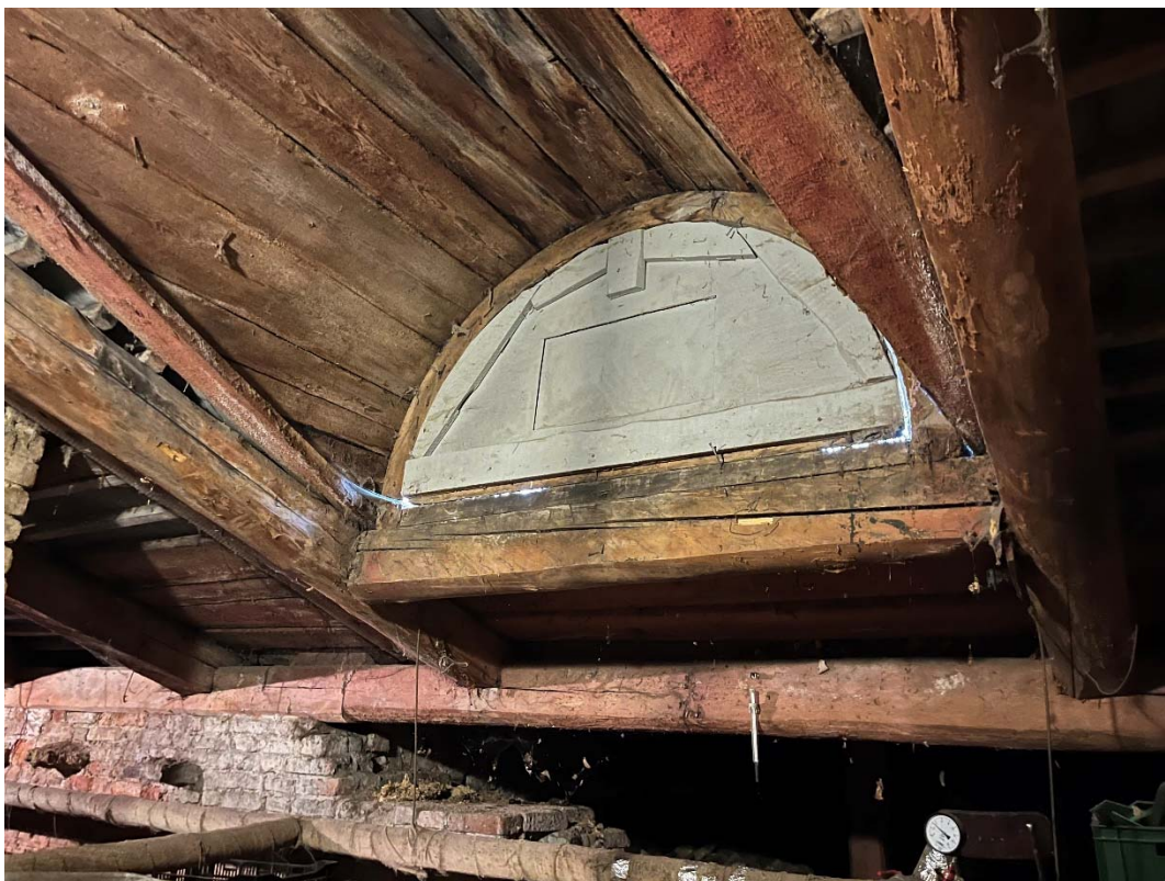
Фото №53. Чердак, стропильные конструкции, слуховое окно.
