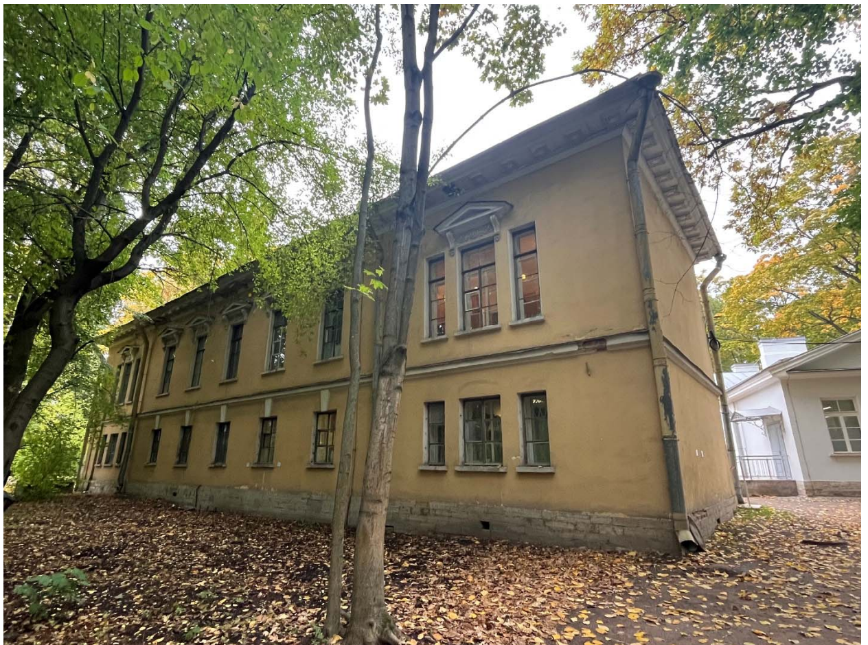
Фото №5. Южный фасад, общий вид.
