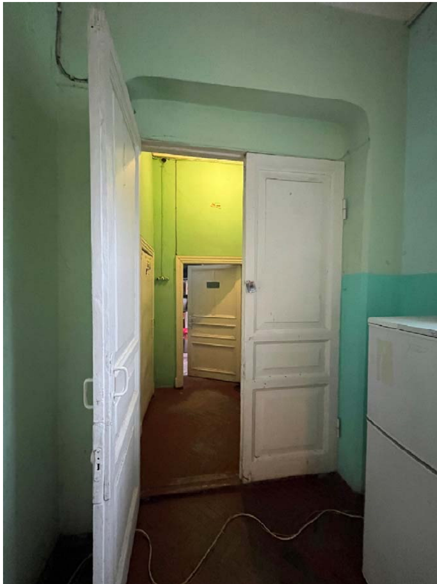
Фото №38. Помещение №1-Н(35).
