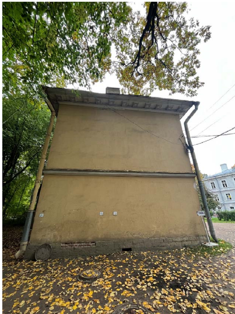
Фото №4. Восточный фасад, общий вид.
