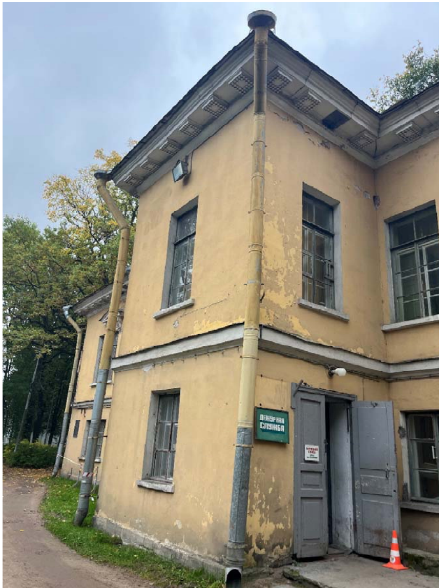
Фото №11. Южный фасад, ризалит, вход в здание.
