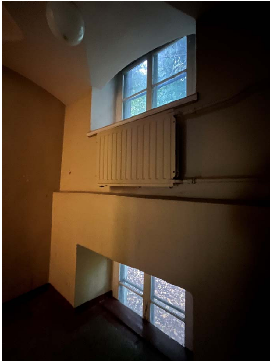
Фото №32. Помещение №1-Н, лестничная клетка.
