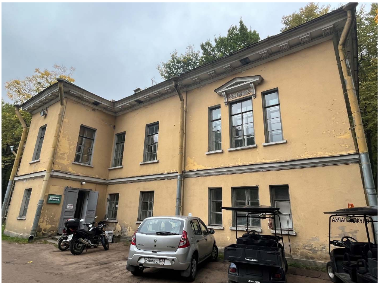
Фото №10. Южный фасад, общий вид.
