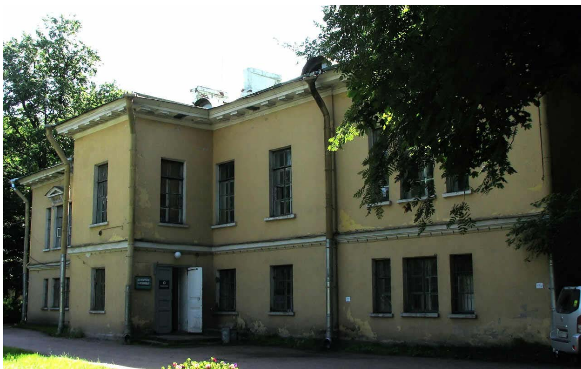
Илл. 20. Кладовые (Дом служителей). 2009 г. Citywalls: Архитектурный сайт Санкт-Петербурга [Электронный ресурс] URL: https://www.citywalls.ru/photo194587.html .
