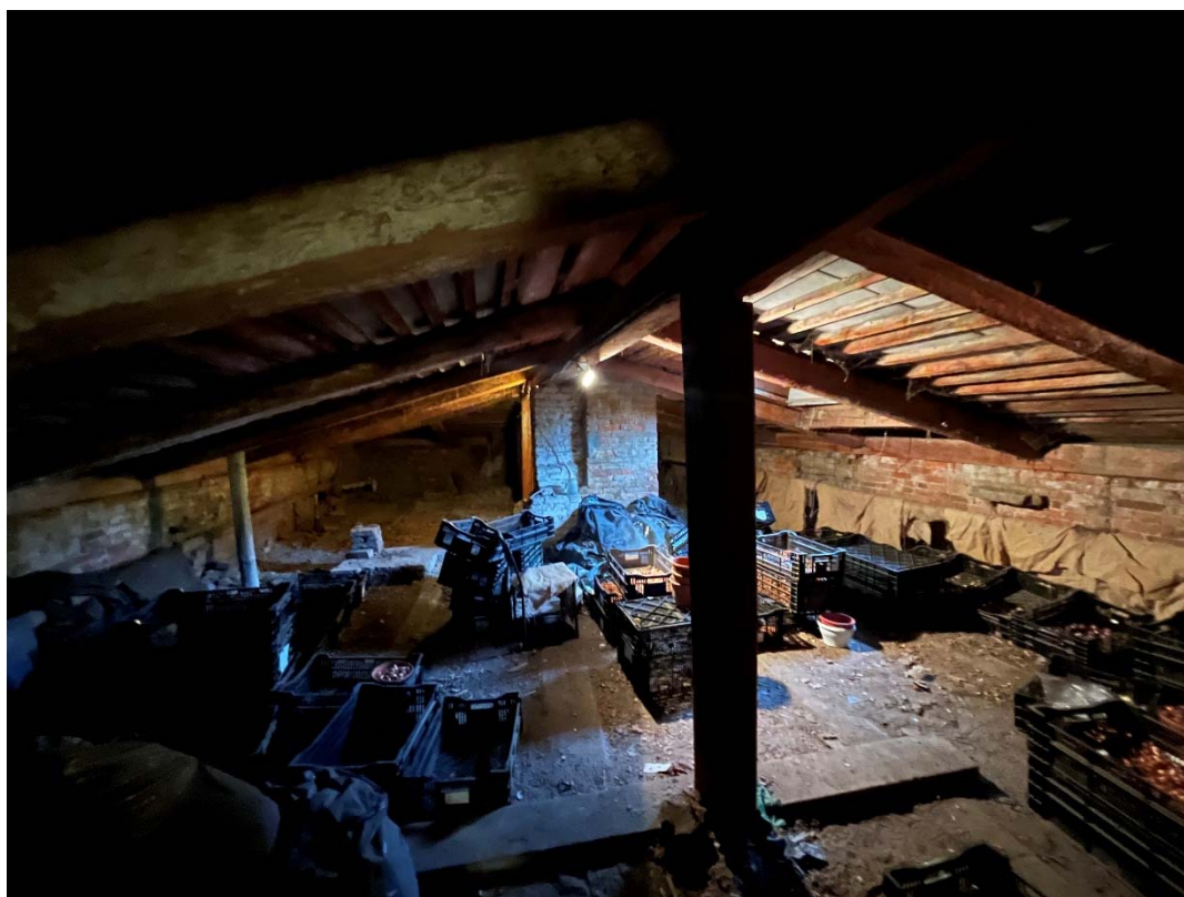
Фото №54. Чердак, стропильные конструкции.
