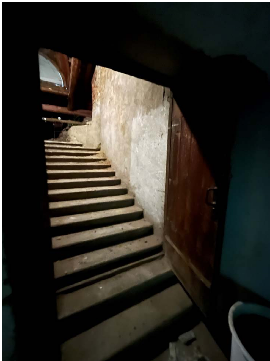
Фото №52. Лестница на чердак.
