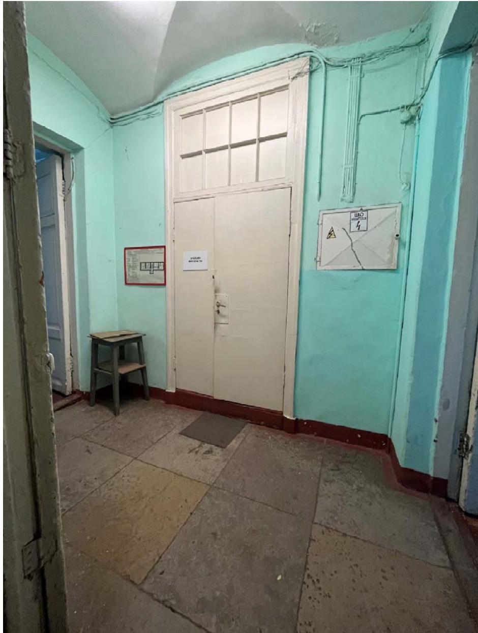
Фото №34. Помещение №1-Н(19).
