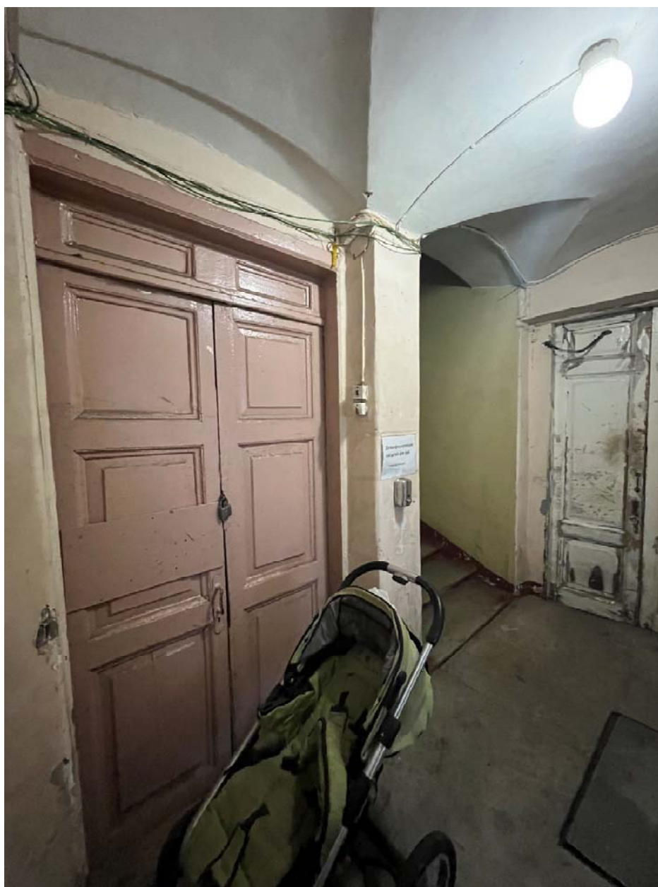
Фото №31. Помещение 1-Н (2), первый этаж.
