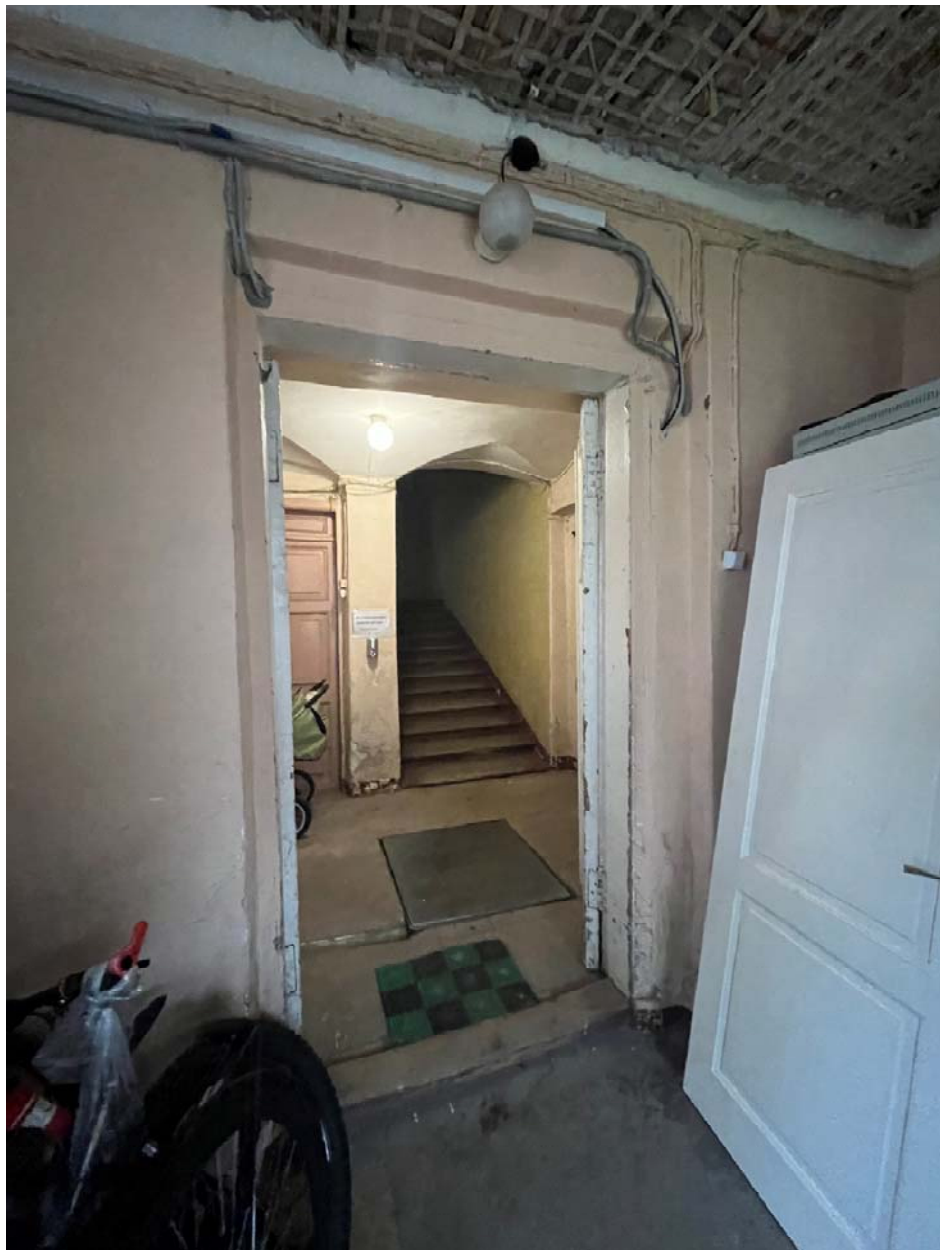
Фото №13. Помещение 1-Н (1), первый этаж.
