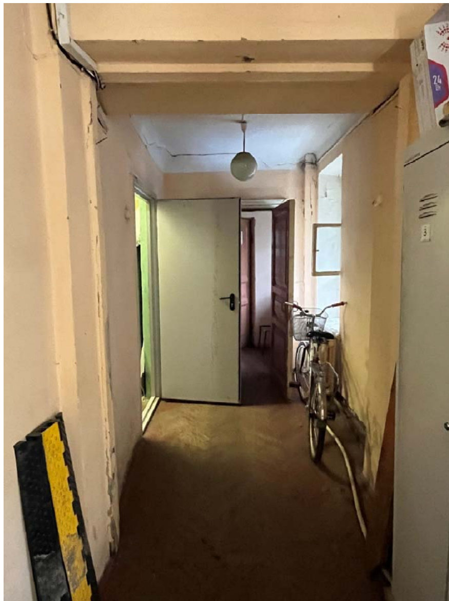
Фото №18. Помещение 1-Н (16), первый этаж.
