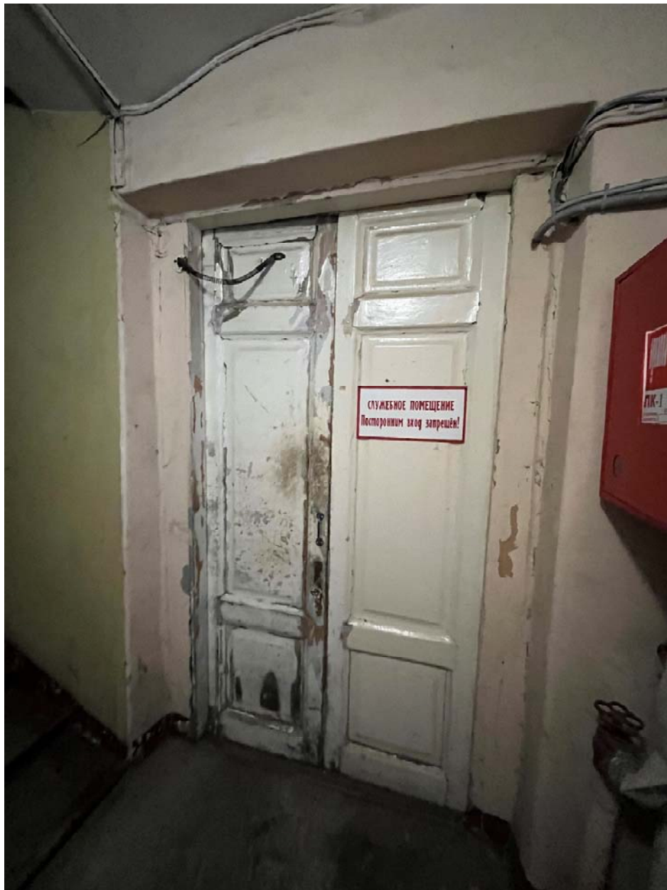
Фото №14. Помещение 1-Н (1), первый этаж.
