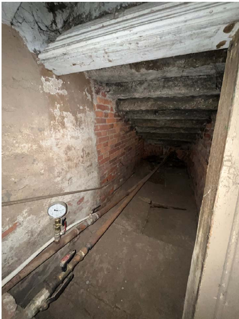
Фото №56. Спуск под лестницу.
