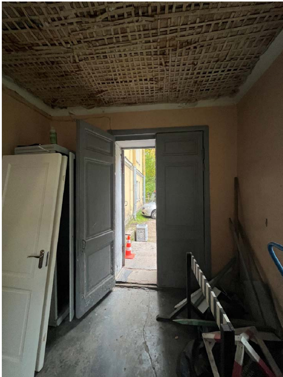
Фото №12. Помещение 1-Н (1), первый этаж.
