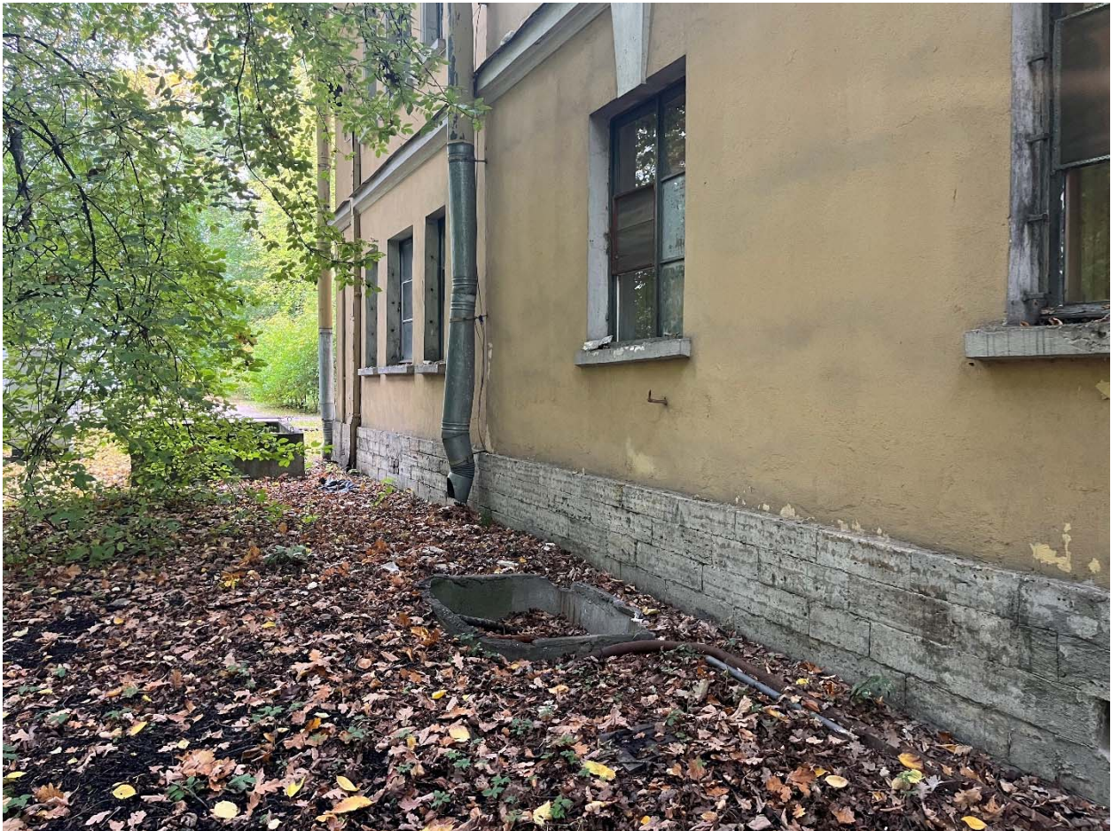
Фото №7. Южный фасад, цокольная часть.
