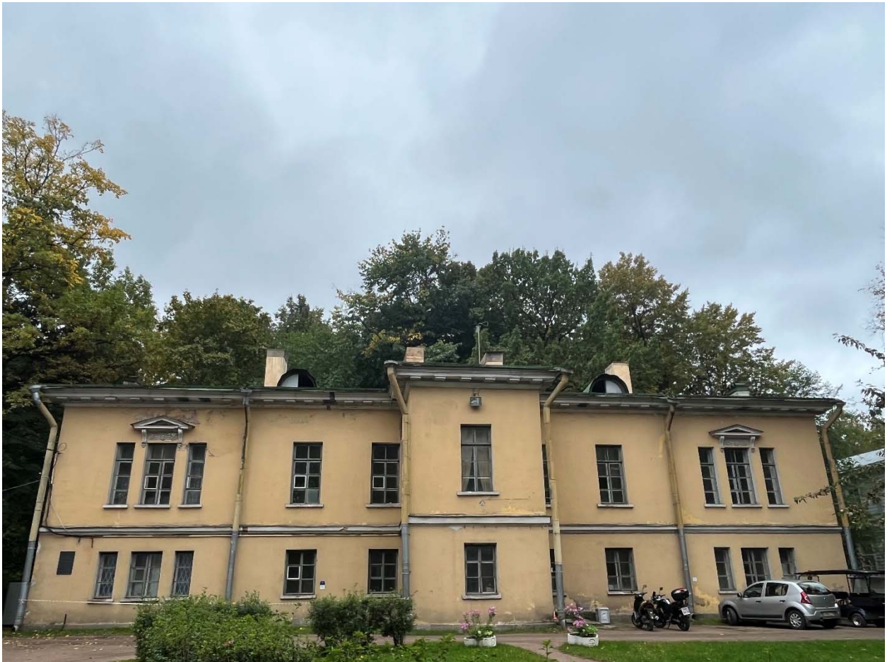
Фото №1. Северный фасад, общий вид.
