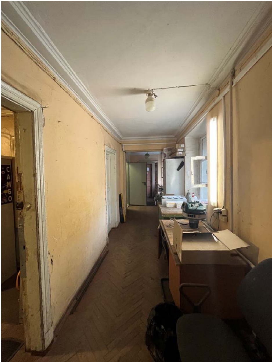
Фото №15. Помещение 1-Н (16), первый этаж.
